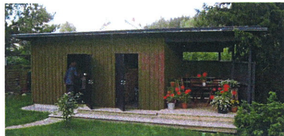
Piharakennuksen muutoin suljettua vaikutelmaa on kevennetty sijoittamalla sen yhteyteen katettu oleskelu- ja työskentelyterassi.
