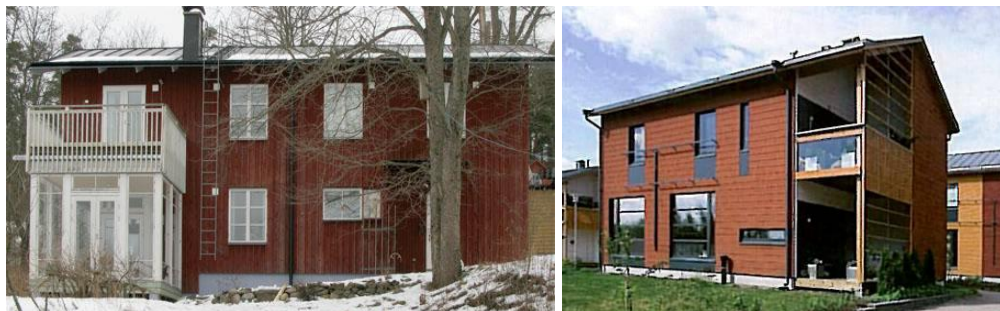
Bilderna 24 och 25. En balkong som har byggts på farstuvisten skuggar inte fönstren under balkongen.
