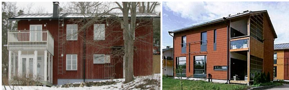
Kuvat 24 ja 25. Kuistin päälle rakennettu parveke ei varjosta alapuolella sijaitsevaa ikkunaa.
