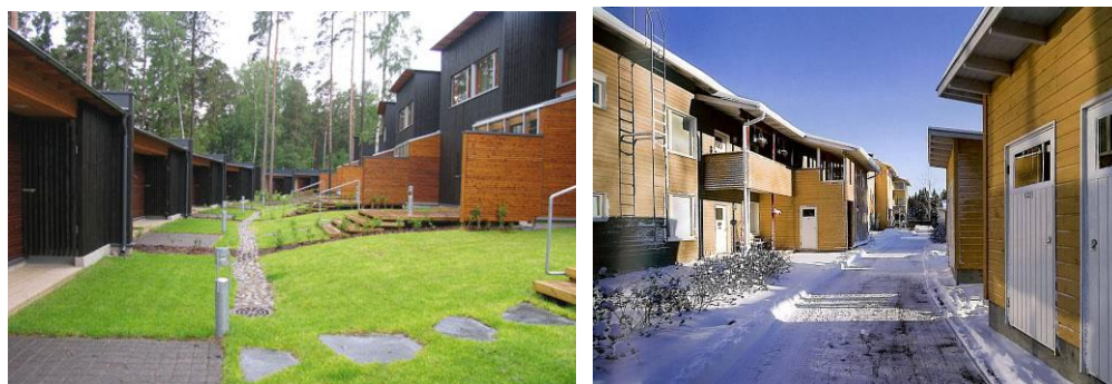
Kuvat 14 ja 15. Esimerkkejä saman pihapiirin päärakennuksista ja talousrakennuksista. Vasemmalla rivitalon sisäpiha, jossa vasemmalla talousrakennus ja oikealla päärakennus. Oikealla katunäkymä Oulun Puu-Linnanmaalta.
