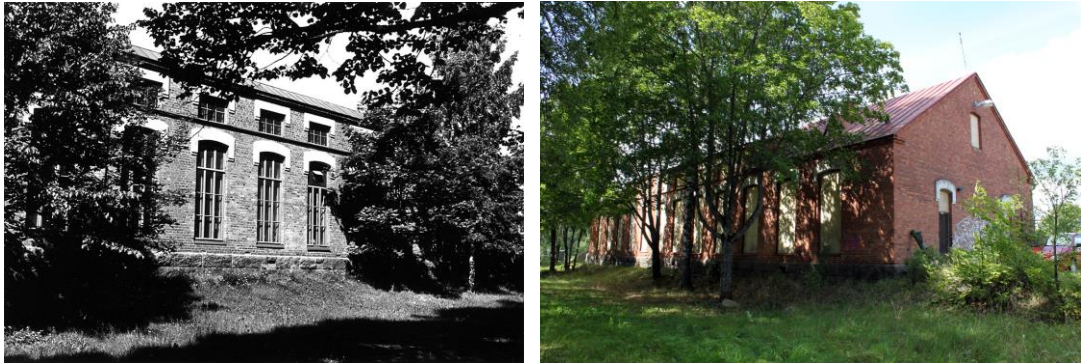
Kartonkitehtaan rakennus etelästä päin kuvattuna vuonna 1986 ja vuonna 2013
