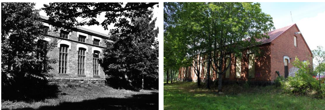
Kartongfabriksbyggnaden fotograferad söderifrån 1986 och 2013.
