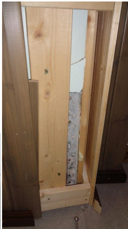
Kuvat 9 ja 10. Kellarikerroksessa tiiliseinien alaosiin on asennettu puinen paneliverhoukset. Paneliverhousta avattiin yhden väliseinän kohdalta. Rakenteessa ei havaittu vaurioita.
