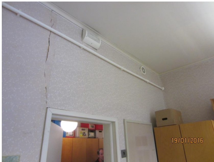
Kuva 12. Kirjaston toimistosiiven huoneiden tyypillinen ilmanjakotapa.
