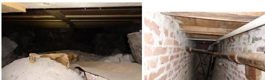
Kuvat 3 ja 4. Uusittua alapohjarakennetta WC-tilojen kohdalla ja alkuperäinen alapohjarakenne rakennuksen keskiosalla.
