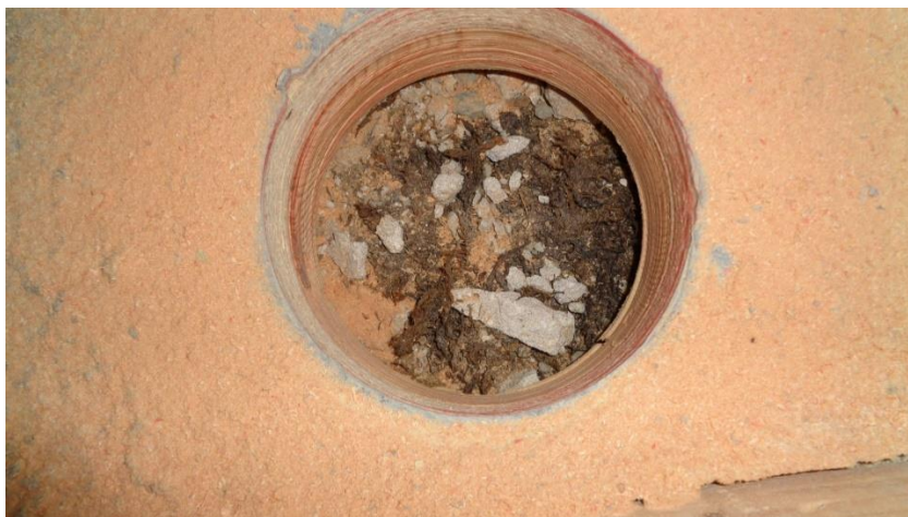
Kuva 2. Puurakenteisen alapohjan täytemateriaalina on käytetty orgaanista ainesta.
