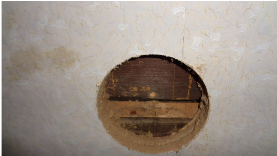
Kuva 7. Ulkoseinän hirsirakenne oli rakenneavauksen kohdalta moitteettomassa kunnossa.
