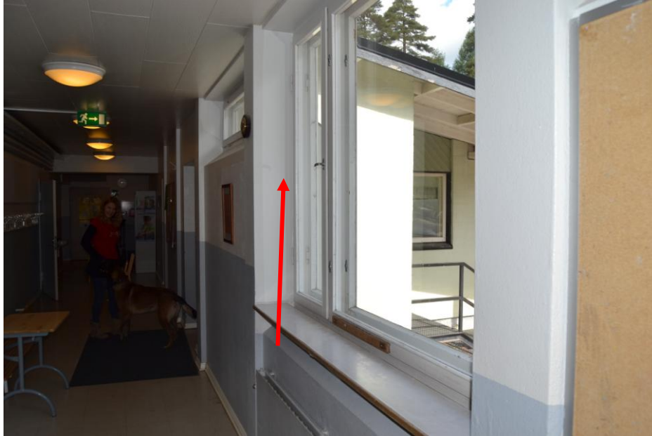
7.Käytävä: Ikkunan luokse ylöspäin.
