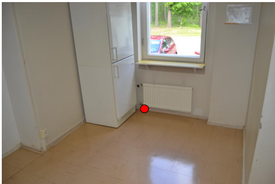
2.Ruoan jakeluhuone: Ikkunan alapuolelta.
