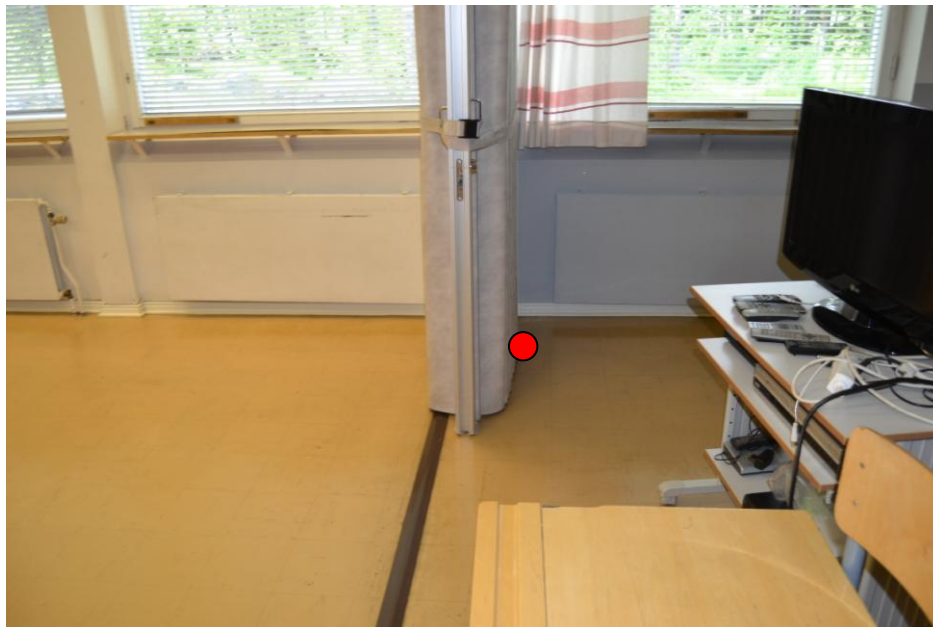
8.Opetustila 4: Ulkoseinän ja haitariseinän nurkkaus (liikuntasauama).
