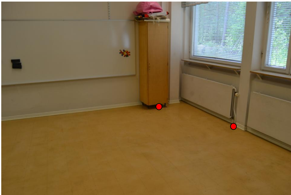
10.Opetustila 5: Ulkoseinustalta patterin läpivienti ja kaapin alapuolinen metallisen luukun kannen kohta.
