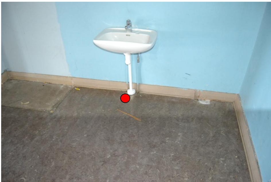
6.Käytävä 3.03: Lavuaarin alapuolelta.
