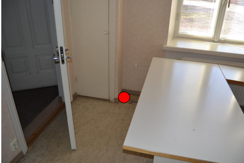
9.Opinto-ohjaajan tila 0.04: Ulkoseinän nurkkaus.
