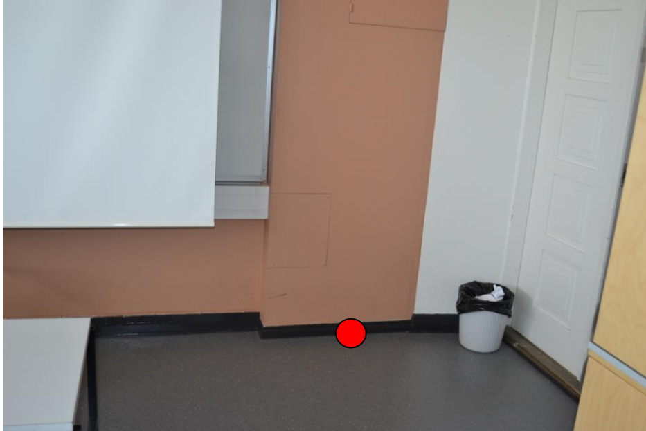
1.Huone 1.07: Vaatehallin oven viereinen nurkkaus (putkinousukuilu).
