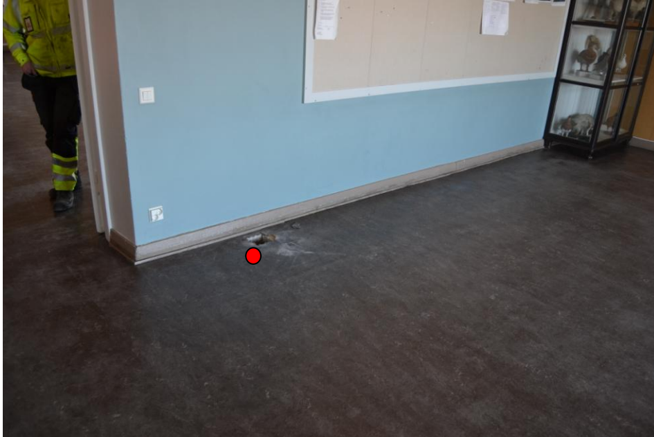
5.Huone 2.08: Lattiassa oleva rakenneavauskohta.
