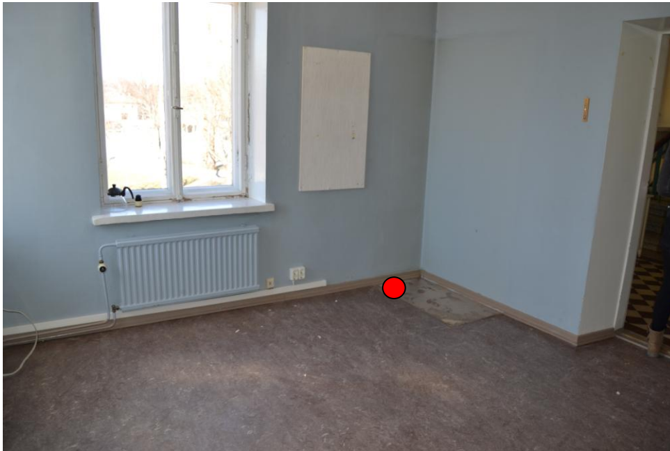
3.Opinto-ohjaushuone 2.02: Ulkoseinän nurkkaus.
