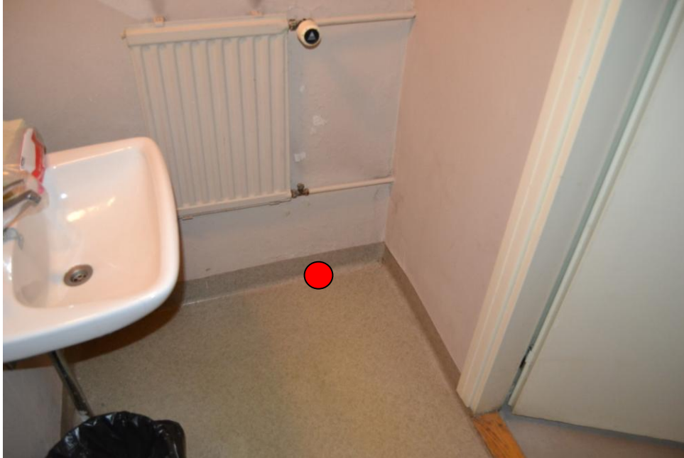
15.WC 0.17: Ulkoseinän luota.
