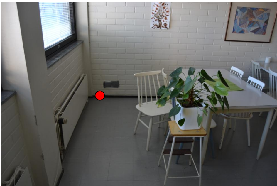
4.Opetuskoti: Ulkoseinän nurkkaus.
