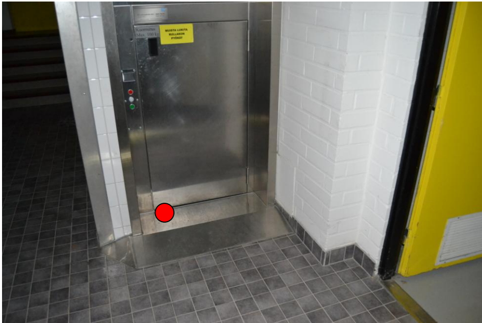
17.Keittiön aputila: Hissikuilun luota.
