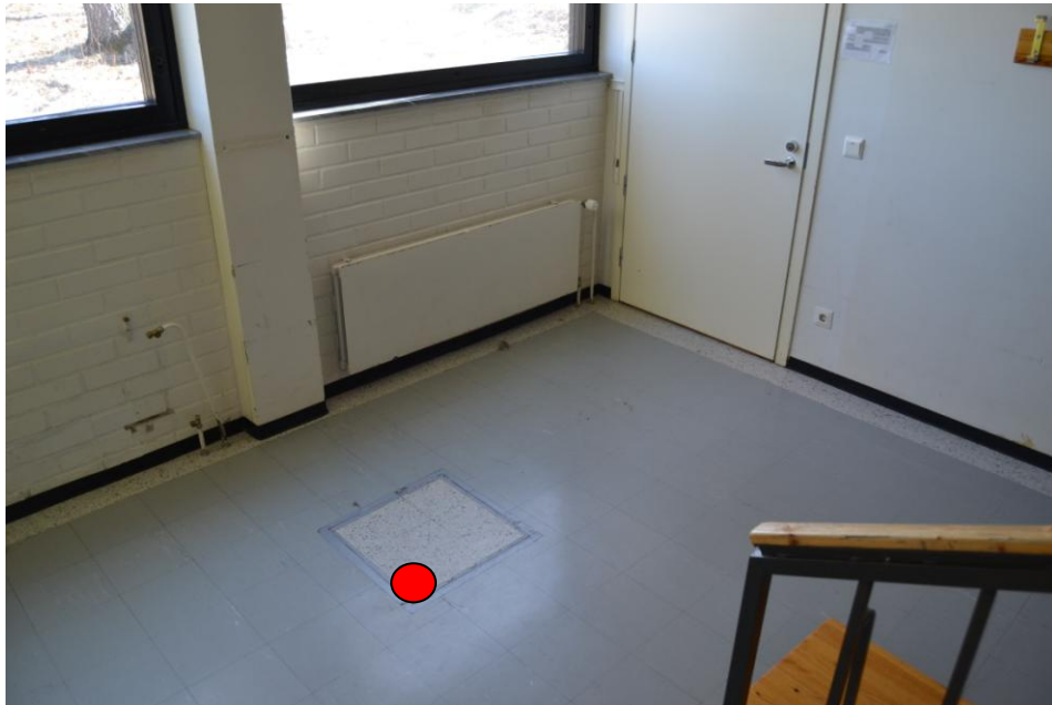
13.Käytävä: Lattian alla kulkevien putkistojen luukku.
