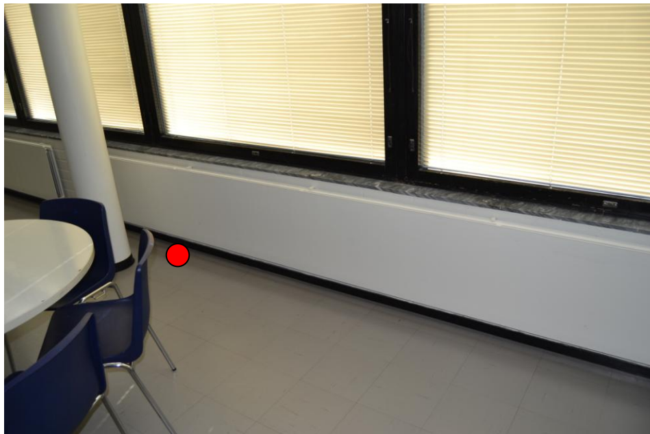
26.Ruokailutila: Ulkoseinän luokse.
