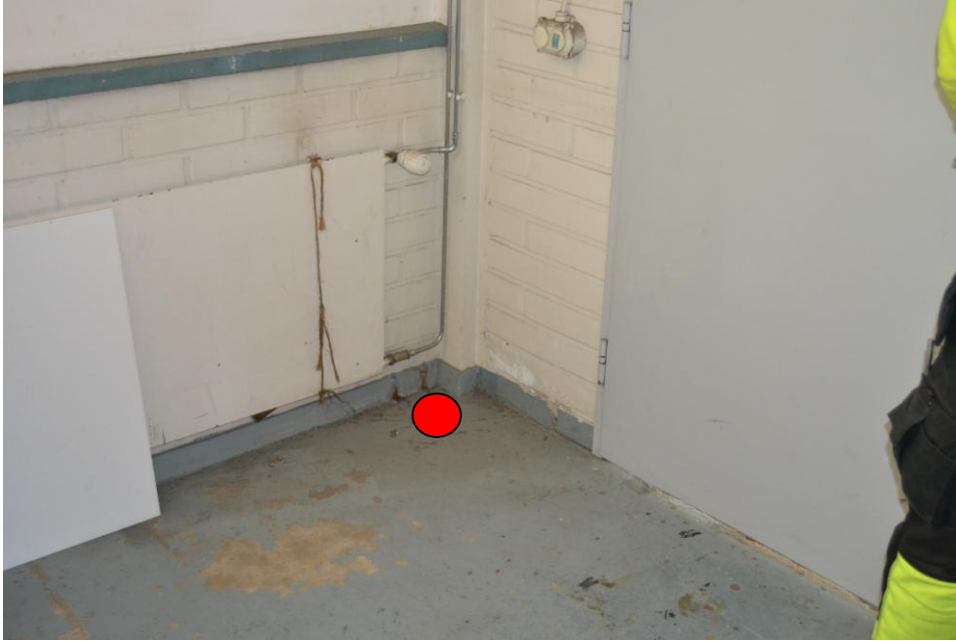
7.Paja: Ulkoseinän ja maalaamon seinän välinen nurkkaus.
