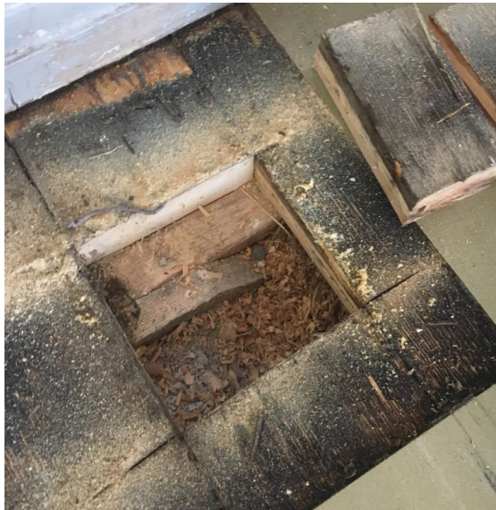
Kuva 7. Rakenneavaus 17 laajennusosan luokan 2.22 lattiaan
