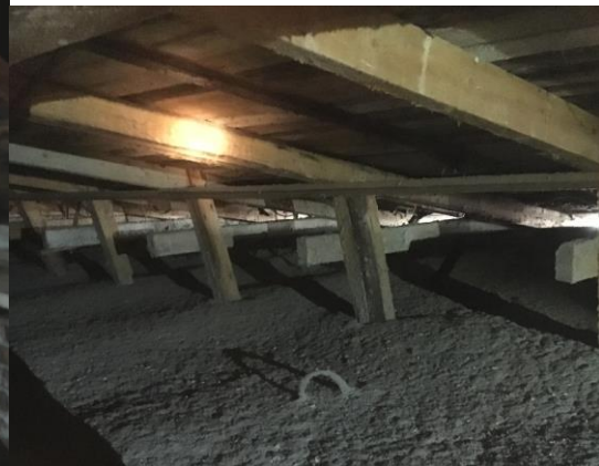
Kuva 12. vanhan osan yläpohja (vasemmalla) ja laajennusosan yläpohja (oikealla). Ruodelaudoituksessa havaittiin paikoin kosteuden aiheuttamia jälkiä.
