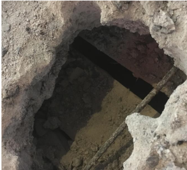
Kuva 11. Rakennevaus 20 ullakon lattiaan. Yläpohjan eristeenä korkki.
