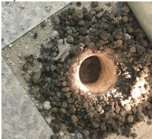
Kuva 3. Rakenneavaus 3 laajennusosan luokan 0.32 lattiaan
