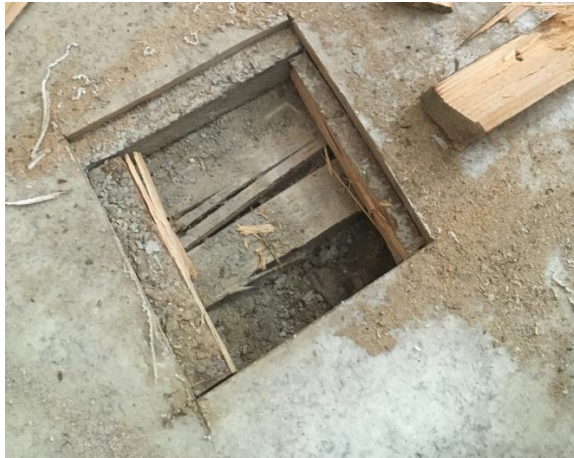
Kuva 2. Rakenneavaus 2 opinto-ohjaajan tilan 0.04 lattiaan
