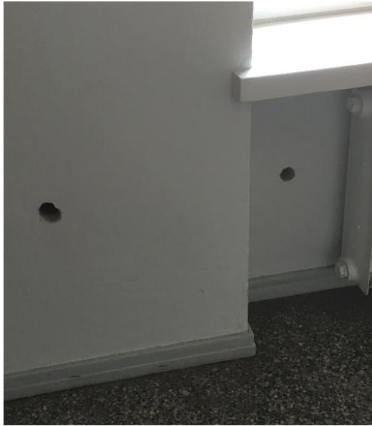
Kuva 4. Laajennusosan ulkoseinän rakenneavaukset 6 ja 7 käytävällä 2.20
