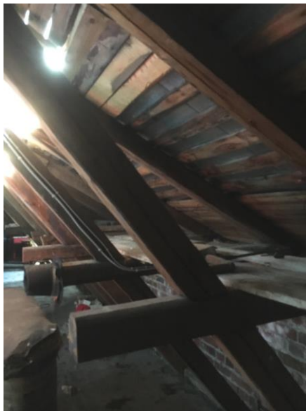
Kuva 12. vanhan osan yläpohja (vasemmalla) ja laajennusosan yläpohja (oikealla). Ruodelaudoituksessa havaittiin paikoin kosteuden aiheuttamia jälkiä.
