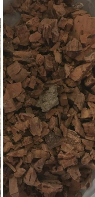
Kuva 11. Rakennevaus 20 ullakon lattiaan. Yläpohjan eristeenä korkki.
