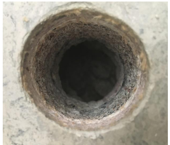
Kuva 1. Rakenneavaus 1 ATK-luokan 0.10 lattiaan
