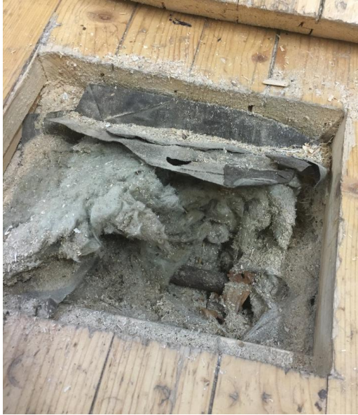
Kuva 11. Rakenneavaus 2 puuverstaan 3.19 lattiaan. Avauskohdassa oli havaittavissa PAH-yhdisteiden hajua.
