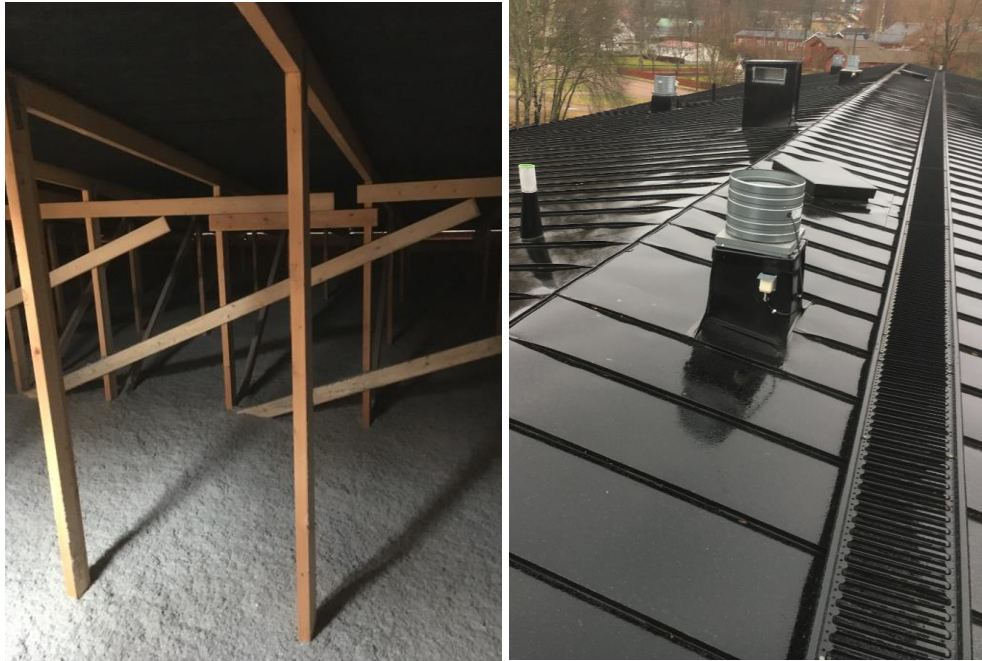
Kuva 19. Rakennuksen yläpohjarakenne on uusittu vuonna 2009-10 ja materiaalit olivat hyvässä kunnossa.
