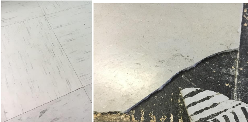
Kuva 15. Luokissa 3.02 ja 3.03 30*30cm vinyylilaatta ei sisällä asbestia (vasemmalla). Käytävällä 3.21 ja 3.22 25*25 cm vinyylilaatta sisältää asbestia (oikealla).
