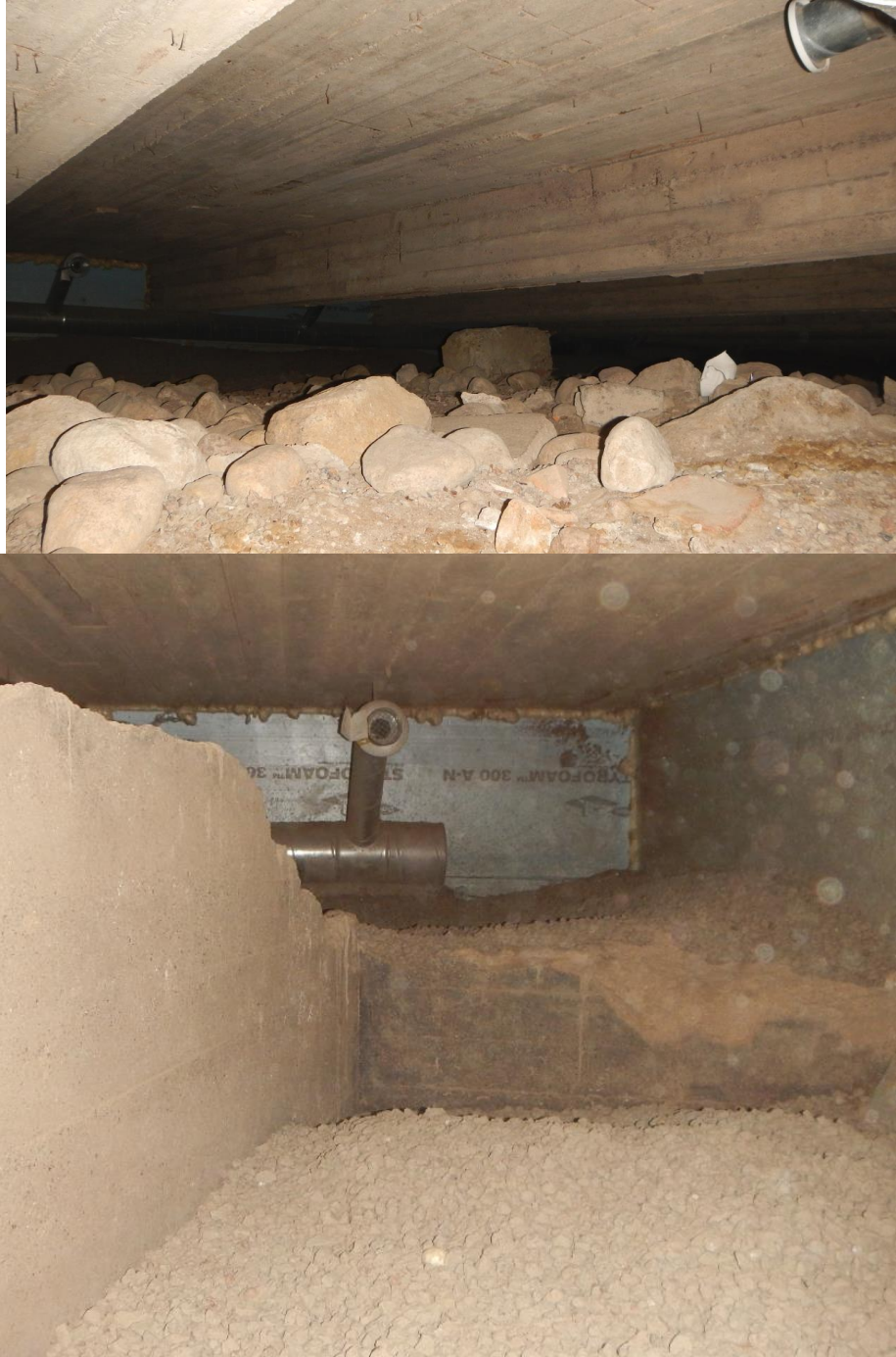
Kuva 13. Ryömintätila oli puhdistettu orgaanisesta aineksesta. Ryömintätila on koneellisesti tuulettu. Tilassa ei havaittu aistinvaraisesti kosteutta.
