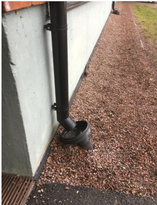
Kuva 20. Rakennuksen sokkelin vierustalle on asennettu vedeneriste ja sorakerros. Sadevedet on ohjattu syöksytorstista sadevesikaivoihin.
