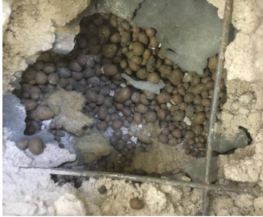
Kuva 2. Rakenneavaus 3 luokassa 1.19. Rakennusmateriaalit olivat viljelytuloksen perusteella kunnossa.
