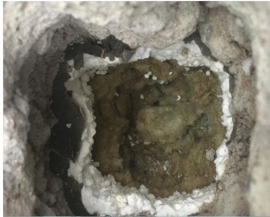
Kuva 3. Rakenneavaus 5 opetuskeittiössä 1.35. Rakennusmateriaalit olivat viljelytuloksen perusteella kunnossa.
