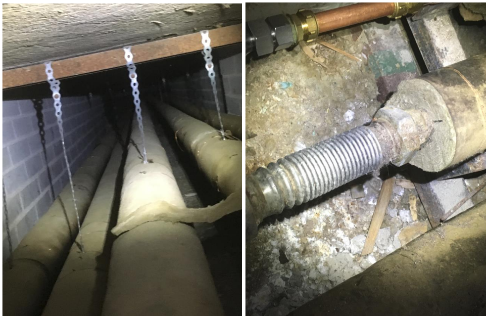
Kuva 10. Putkikanaali opetuskeittiöiden ja hallin alapuolella.
