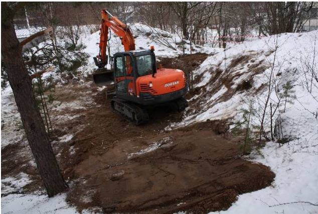
AKDG5145:23 Koeojaa täytetään. Pohjoisesta.
