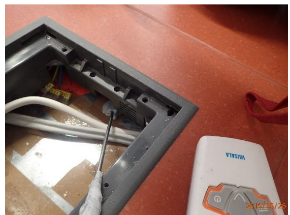
Tila 207 lattiarakenteen "sähkölaatikko"
