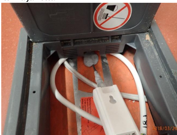
Tila 208 lattiarakenteen "sähkölaatikko"
