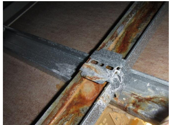
Tila 114 ruosteisia alakattokannatinkiskoja
