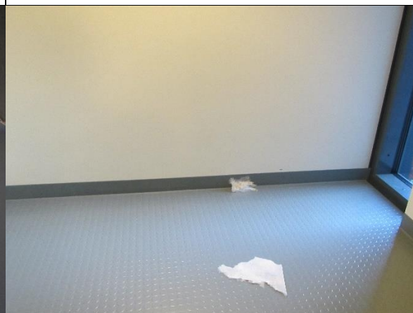
23. Akustiikkalevyistä peräisin olevaa villajätettä
