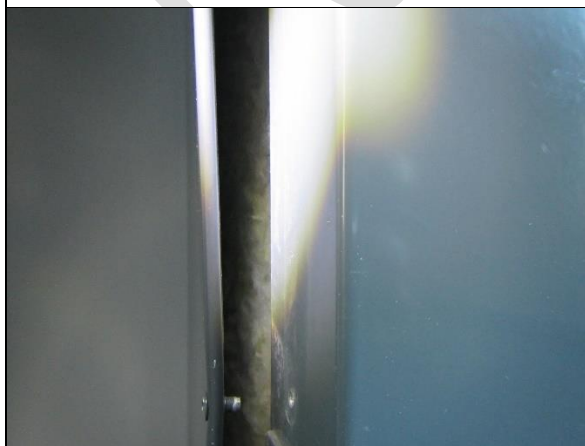
26. Yläkäytävän/silta kulma, jossa epätiivis liitoskohta
