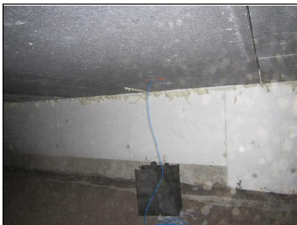
54. Merkkiaineen syöttö alapohjassa
