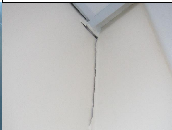
27. Ilmavuotoa sisätiloihin päin kulman listan takaa
