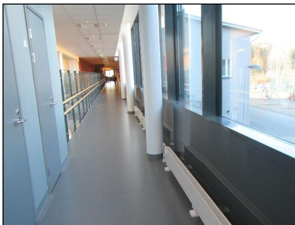
24. Elementti-ikkunaseinää 2. kerroksen sillalla
