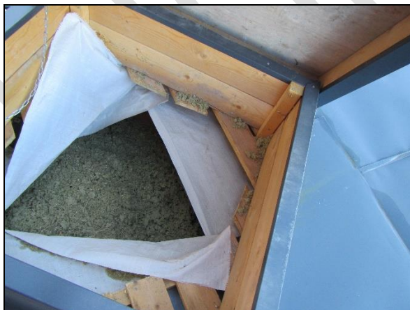
54. Aluskatetta ei ole nostettu koteloinnin reunoille
