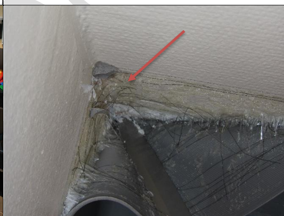
57. Merkkiainetta havaittiin lattialistan epätiivistä nurkasta, tila 114
