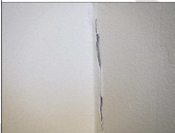
20. Halkeama nurkassa uuden ja vanhan liitoskohdassa
