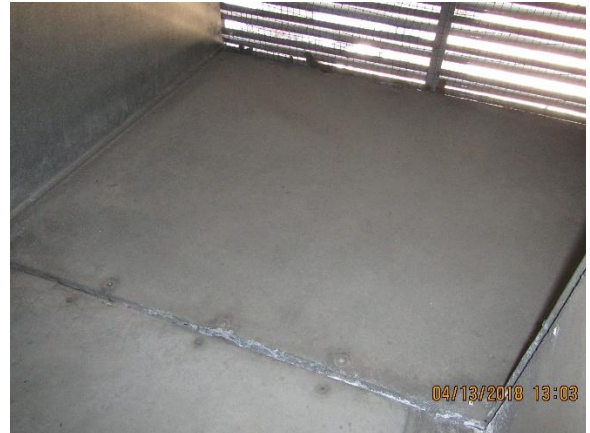
A -osa IV -konehuone, tuloilmakammio sisäpuolelta
