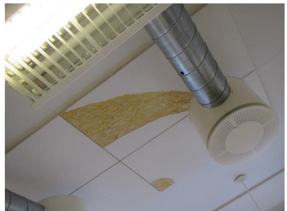
2055, akustiikkalevyjen rikkinäinen pinta
