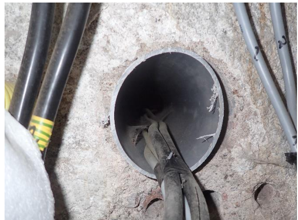
Entinen polttoainevarasto, viereisen kuvan läpivienti perusmuurissa
