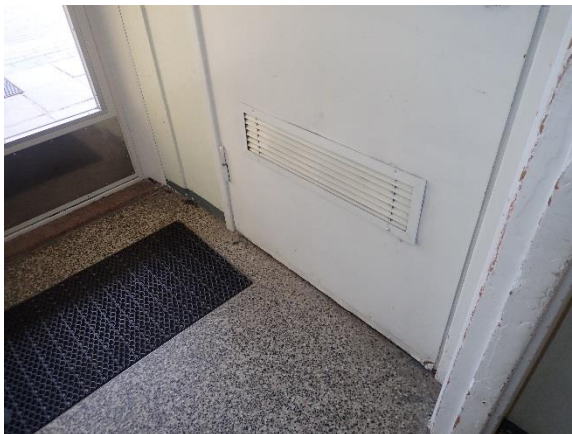
Siirtoilmareitti ja ovi tilasta 1068 kellariin
