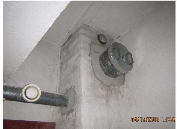
Näyttämön yläpuolinen tila, vanha kanava
