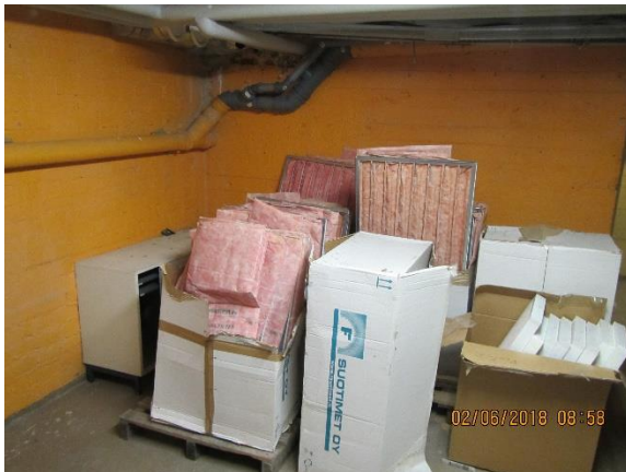
IV-koneen suodattimia säilytettiin kellaritiloissa suojaamattomina
