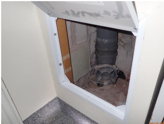
130/1057, viemärikotelointi ulkoseinällä
