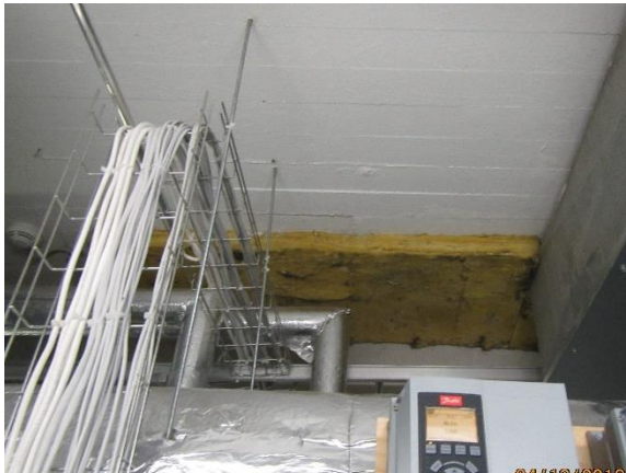
A -osa IV -konehuone, avointa eristepintaa
