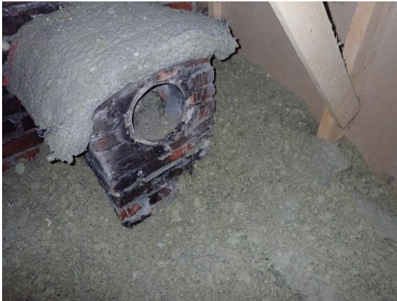
Vanha IV -hormi vinttitilassa, pinnalla savujälkiä
