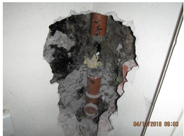
A-osan kellari, avoin seinärakenne
