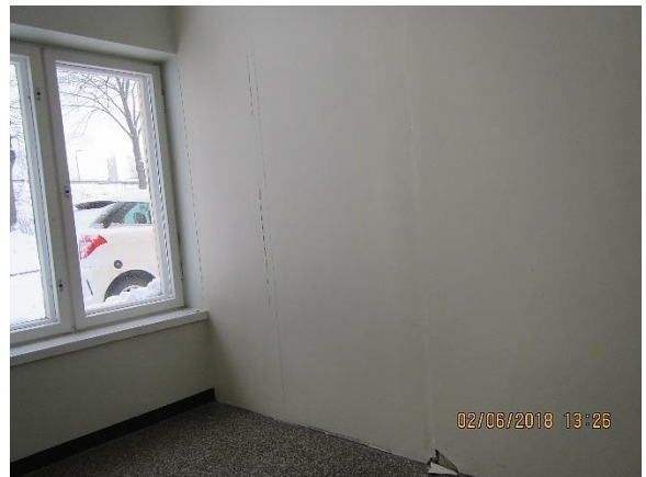
Ummistettu oviaukko sisäpuolelta
