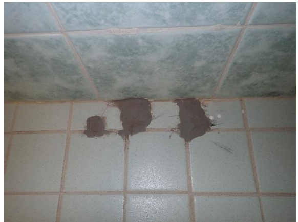
Laastipaikkauksella täytettyjä reikiä
