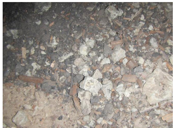
C -osa, ryömintätilassa oli paikoin koksikuonaa
