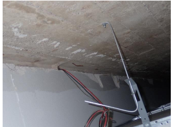
Läpivienti kivirakenteisessa seinässä viereiseen tilaan
