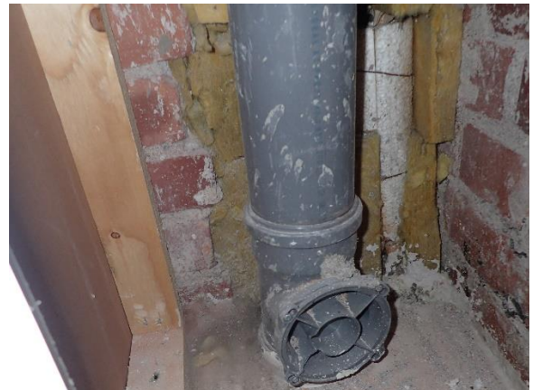
130/1057, ilmayhteys eristetilaan sekä avointa villaeristepintaa
