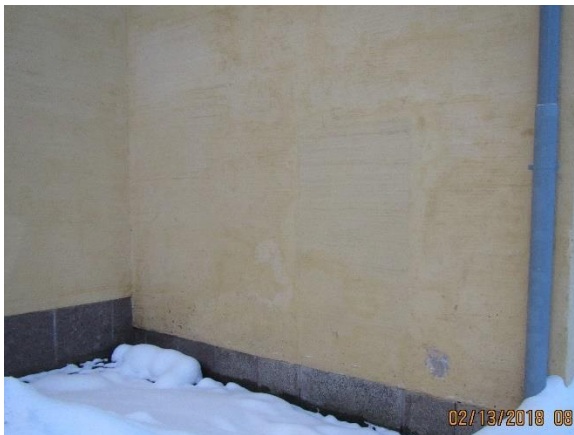
Vanha ummistettu ulko-oven kohta
