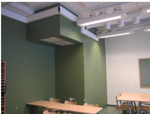
2046, IV -kanavasta oli ilmayhteys sisätilaan
