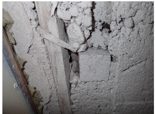
Yläpohjan lävistäviä puurakenteita
