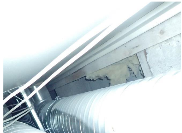
1085, IV-koteloinnin sisäpuolella oli avointa viltäeristepintaa
