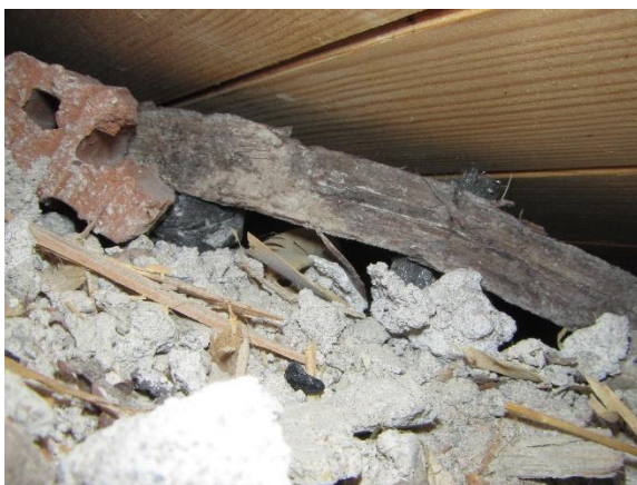
Liikuntasali, alapohjan rakennusjätettä
