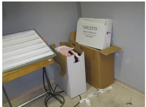
C-osa IV -konehuone, uusia suodattimia säily- tettiin tilassa suojaamattomina
