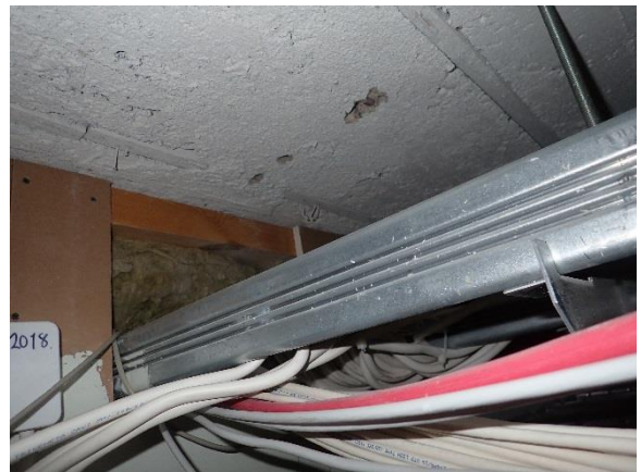
Avoin läpivienti ja eristevillapinta alakattoti- lassa
