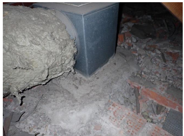
Edellisen kuvan laatikko menee yläpohjan läpi, sulkemisesta sisäpuolelta ei tietoa
