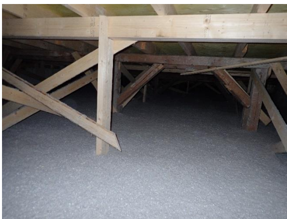
B-osan uusittua vesikattorakennetta
