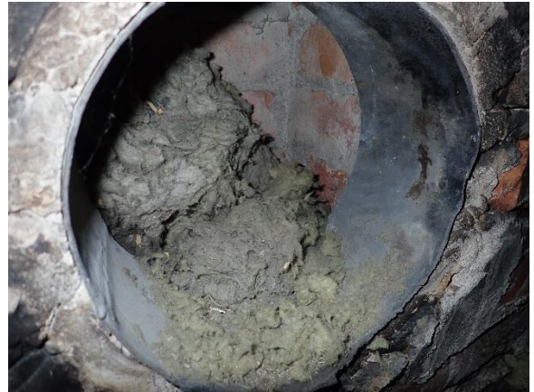
Mineraalivillakappaleilla suljettu IV -hormi lähikuvassa
