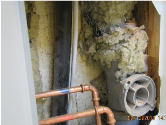
1085, avointa eristevillapintaa putkikoteloinnin sisäpuolella
