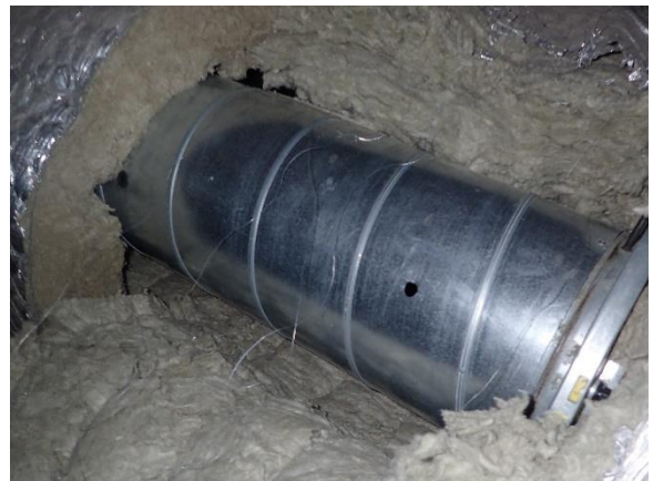
Ummistamaton mittausreikä IV -kanavassa
