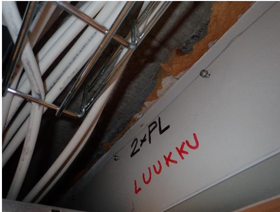
C-osan käytävän IV -kotelon kohdalta vanha si- säkatto on purkamatta
