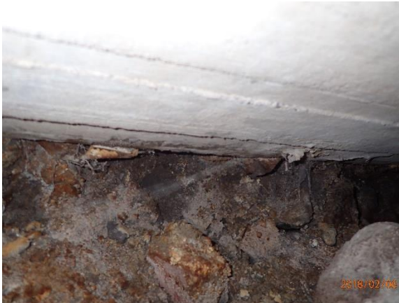
B -osa Kostea maapohjaa
