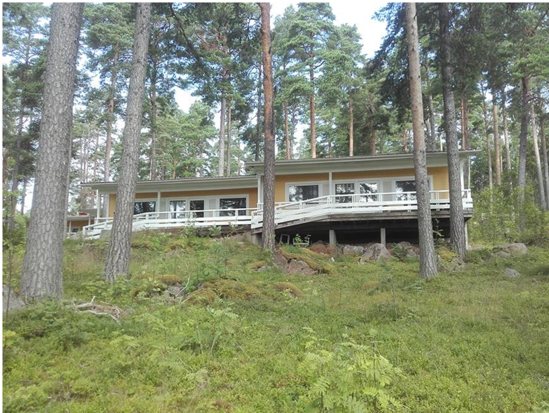
Bild 6. Inkvarteringsbyggnaden som bevaras anvisas med sr-beteckning.
