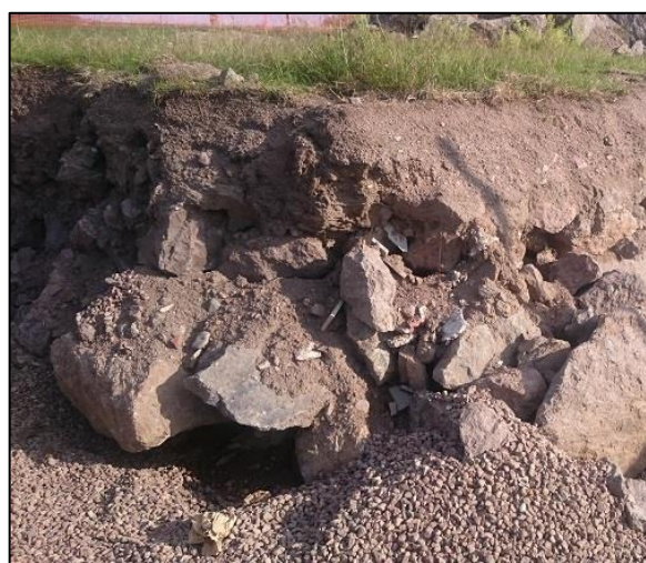
Kuva 11. Louhetta kaivannossa 2c.
