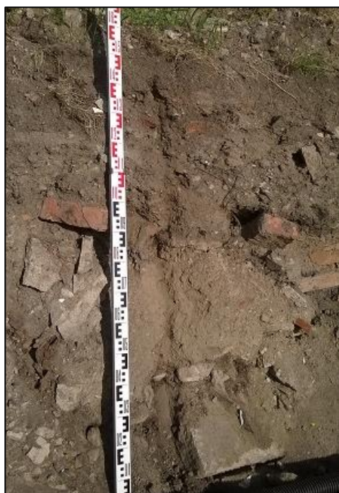
Kuva 8. Rakennusjätettä kaivannossa 1b.
