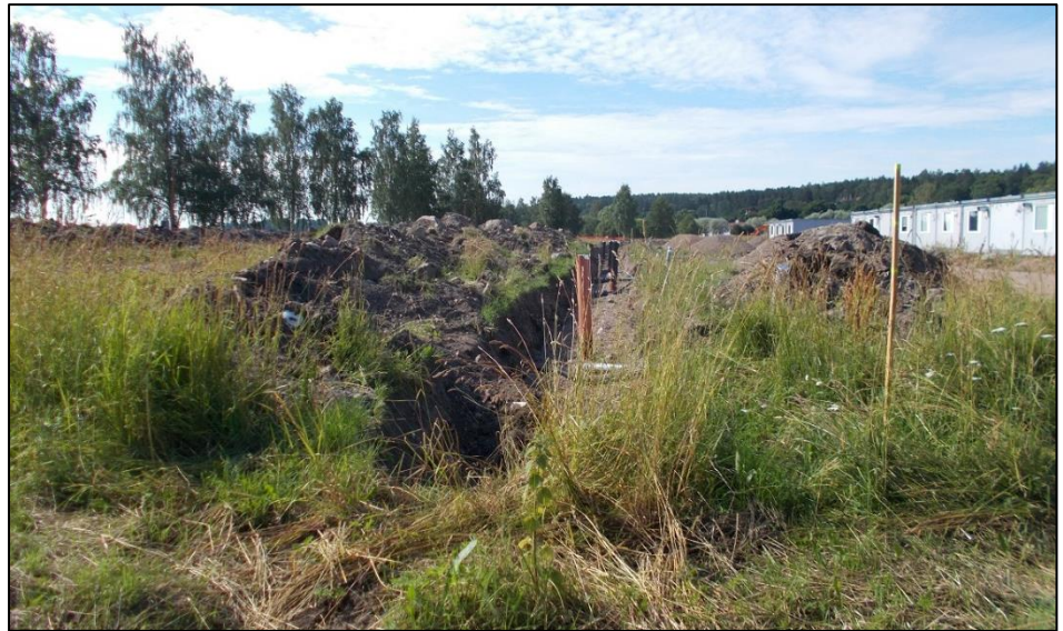
Kuva 3. Putkikaivanto 1.
