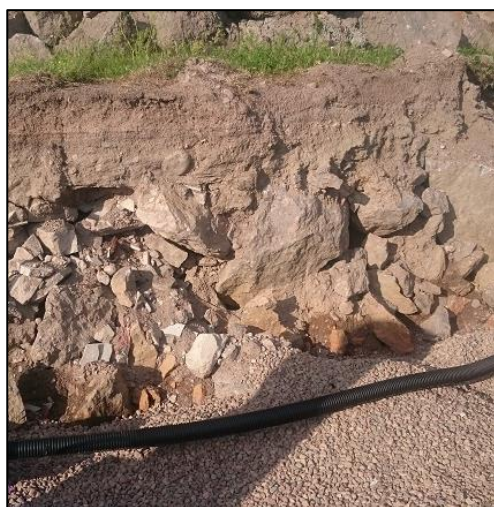
Kuva 10. Louhetta kaivannossa 2c.
