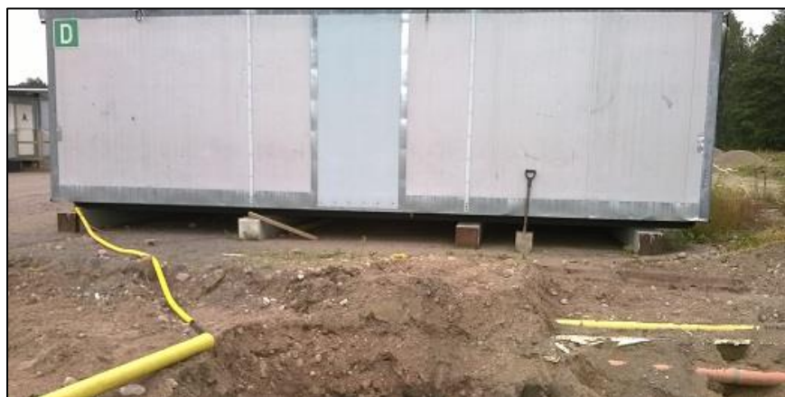
Kuva 17. Tuulettuva tila parakin alapuolella.
