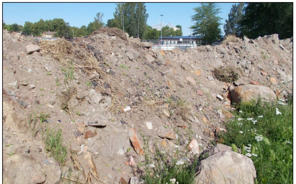
Kuva 4. Kasalle kaivettua maata, jossa on seassa jätettä.
