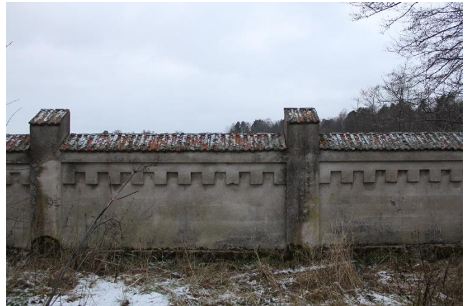
Muren kring fastigheten.
