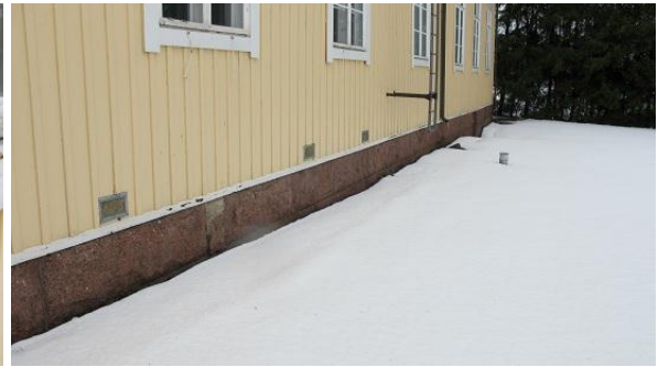
Kuva 2.10.1. Ikkunoiden ulkopuitteet ovat välttävässä kunnossa ja varsinaiset vesipellitykset puuttuu. Kuva 2.10.2. Alapohjan tuuletusaukot on tukittu mineraalivillaeristeellä.
