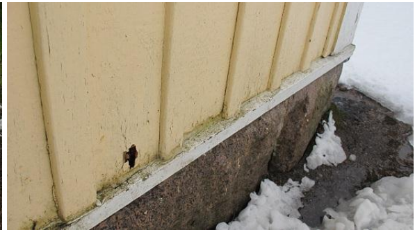
Kuva 2.10.3. Kattovedet ohjautuvat sokkelin viereen ja lammikoituivat. Kuva 2.10.4. Pohjoissivun päädyn julkisivun puuverhous on paikoin huonossa kunnossa ja sokkelin vaakalista tulee kunnostaa koko rakennuksen osalta.
