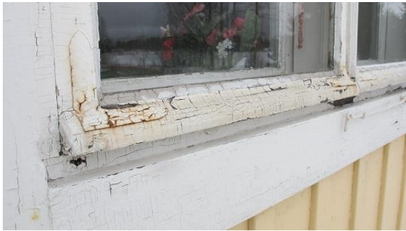
Kuva 2.10.1. Ikkunoiden ulkopuitteet ovat välttävässä kunnossa ja varsinaiset vesipellitykset puuttuu. Kuva 2.10.2. Alapohjan tuuletusaukot on tukittu mineraalivillaeristeellä.
