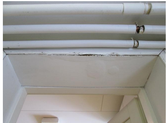
Kuva 2.10.7. Luokkatilan katon vesijäljet. Kuva 2.10.8. Laajennusosan oven yläpuolen kosteusjäljet.
