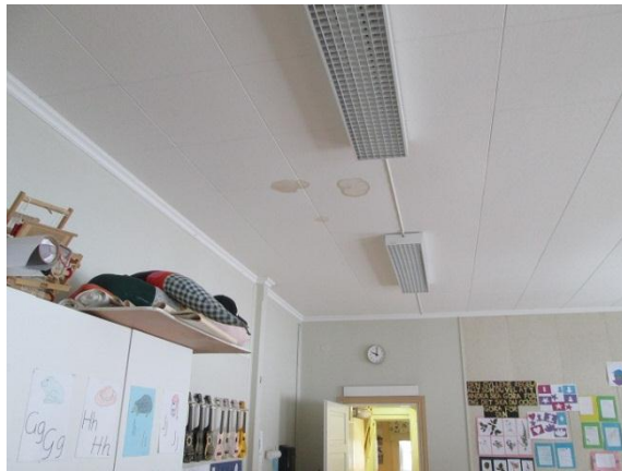
Kuva 2.10.7. Luokkatilan katon vesijäljet. Kuva 2.10.8. Laajennusosan oven yläpuolen kosteusjäljet.
