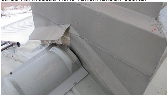
Kuva 2.10.5. Hormin pellitykset ovat paikoin epätiiviitä. Kuva 2.10.6. Pukuhuoneen ja wc:n poistoilmanvaihtokanava päättyy ullakolle.
