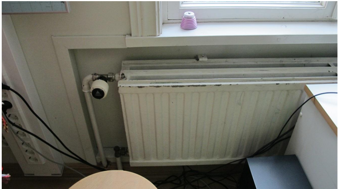
Valokuva 3.8.3. Rakennuksen lämmityspatterit ovat moni levyisiä radiaattoreita.
