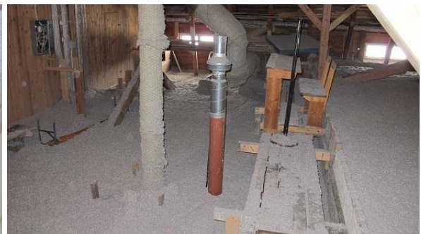
Kuva 2.10.5. Hormin pellitykset ovat paikoin epätiiviitä. Kuva 2.10.6. Pukuhuoneen ja wc:n poistoilmanvaihtokanava päättyy ullakolle.
