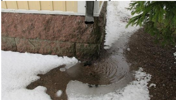
Kuva 2.10.3. Kattovedet ohjautuvat sokkelin viereen ja lammikoituivat. Kuva 2.10.4. Pohjoissivun päädyn julkisivun puuverhous on paikoin huonossa kunnossa ja sokkelin vaakalista tulee kunnostaa koko rakennuksen osalta.
