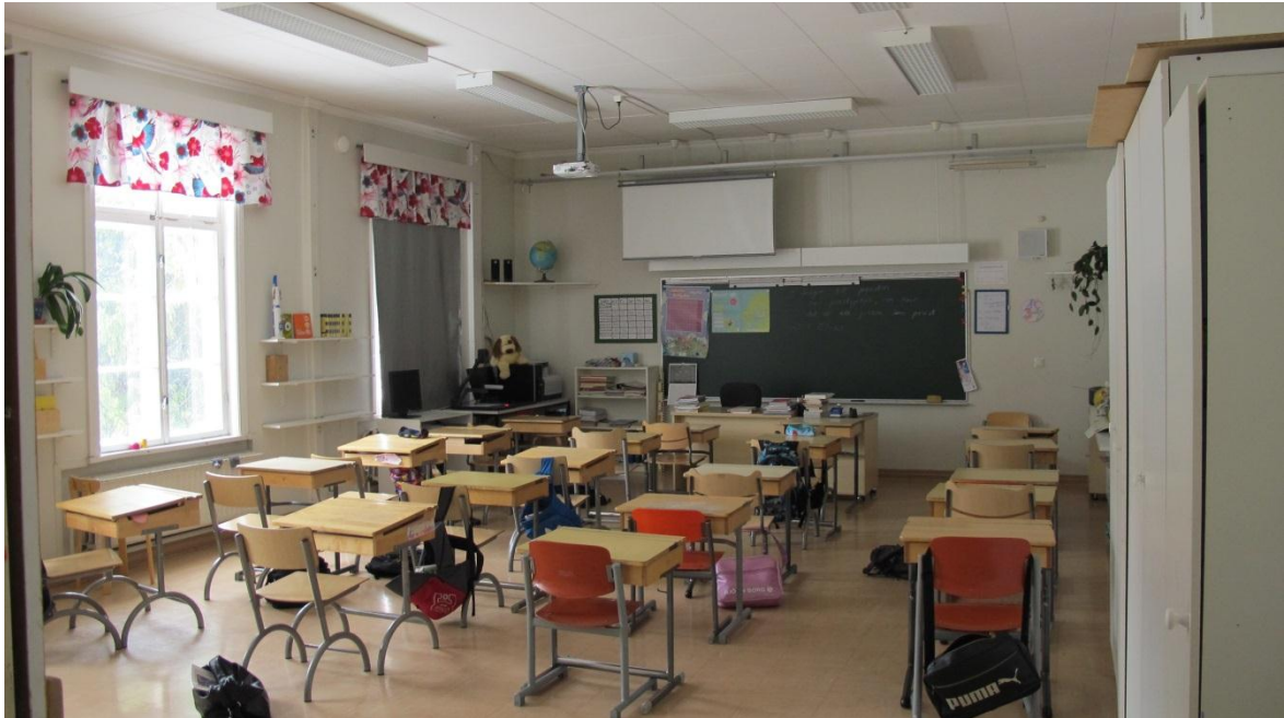
Valokuva 4.11.1. Rakennukseen sähkönjakelussa on käytetty sekä levyhyllyjä että johtokouruja.
