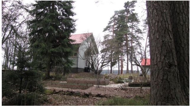
Byggnad 2. Byggnaden har blivit färdig kring 1940-talet.
