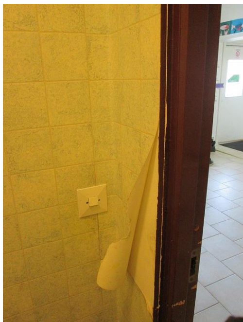
Kuva 2.10.1. WC -tilan vanha muovitapetti on repeillyt. Kuva 2.10.2. Eteistilassa on laattoja rikkoutunut ja irronnut.
