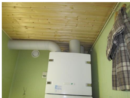
Kuva 3.8.1. Rakennuksen koneellinessa ilmastuvaihdossa on käytetty ns. pakettikoneita. Kuva 3.8.2. Likaisten tilojen poistoa varten on veiskatolla huippuimuri.
