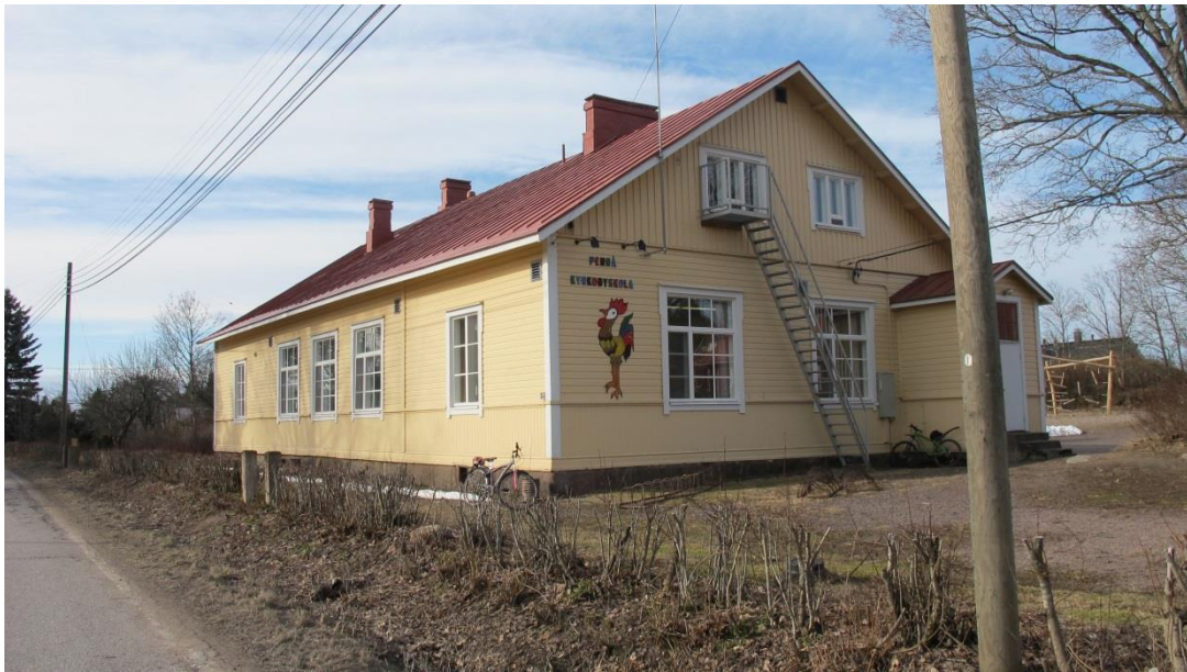
Valokuva 4.11.3. Rakennukseen tulevat käyttämättömät ilmajohdot olisi syytä purkaa, ja käytössä olevien ilmajohtojen yhteyteen asentaa ylijännitesuojat.
