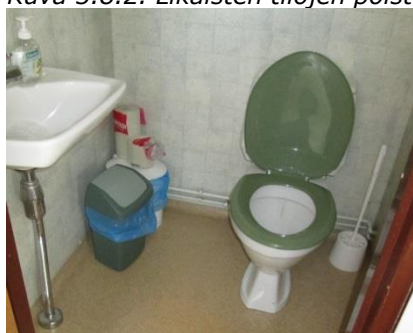
Kuva 3.8.3. Vesikalusteet ovat pääosin 1970 – ja 1980 luvuilta. Kuva 3.8.4. Vesijohto on varustettu saattolämmityksellä.
