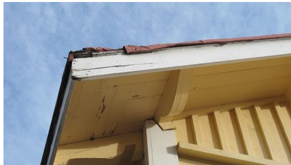
Kuva 2.10.1. Sadevesijärjestelmän täydentäminen räystäskouruilla ja syöksytorvilla. Kuva 2.10.2. Pellitysten korjaus räystäskourujen asennuksen yhteydessä sekä räystäslaudoituksen huoltomaalaus.
