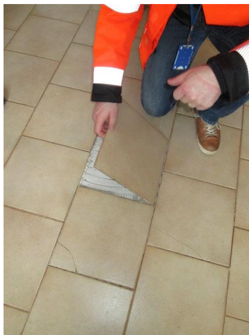
Kuva 2.10.1. WC -tilan vanha muovitapetti on repeillyt. Kuva 2.10.2. Eteistilassa on laattoja rikkoutunut ja irronnut.
