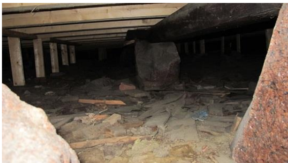
Kuva 2.10.3. Orgaanisen materiaalin poistamista suositellaan alapohjatilasta. Kuva 2.10.4. Vasemmanpuoleisen kuistin kohdalla julkisivun puuverhous on huonossa kunnossa, uusimisen yhteydessä runkorakenteiden tarkastus.
