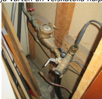
Kuva 3.8.3. Vesikalusteet ovat pääosin 1970 – ja 1980 luvuilta. Kuva 3.8.4. Vesijohto on varustettu saattolämmityksellä.
