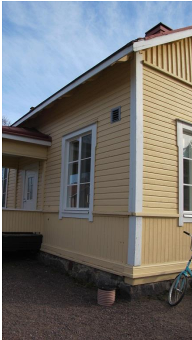
Kuva 2.10.1. Sadevesijärjestelmän täydentäminen räystäskouruilla ja syöksytorvilla. Kuva 2.10.2. Pellitysten korjaus räystäskourujen asennuksen yhteydessä sekä räystäslaudoituksen huoltomaalaus.
