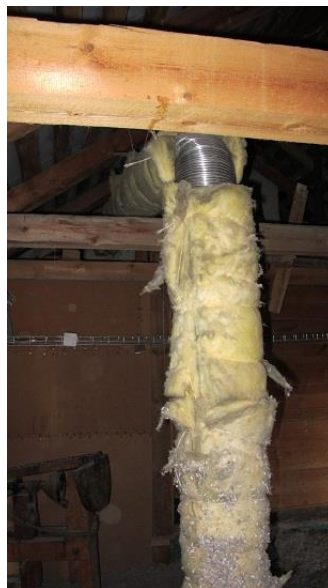
Kuva 2.10.4. Vesikatteen pellitysten ja liittymien tiiveyden tarkastusta/korjaamista suositellaan. Kuva 2.10.5. Ullakolla olevien putkien palo- ja lämmöneristys tulee korjata määräysten määräyksien ja ohjeiden mukaisiksi.
