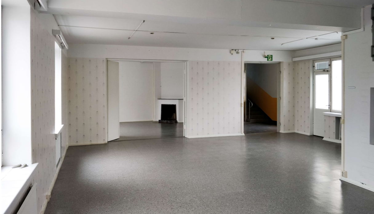
Kuva 12. Kuva ruokasalista nykyisessä asussaan. Kuva on otettu entisen keittiön kohdalta. Takana näkyy oleskeluhuone tulisijoineen. Näiden väliin jäi alun perin ruokasali. Oikealla on sisäpihalle aukeava ikkuna ja ovi, joka johtaa sisääntulokatoksen päälle.
