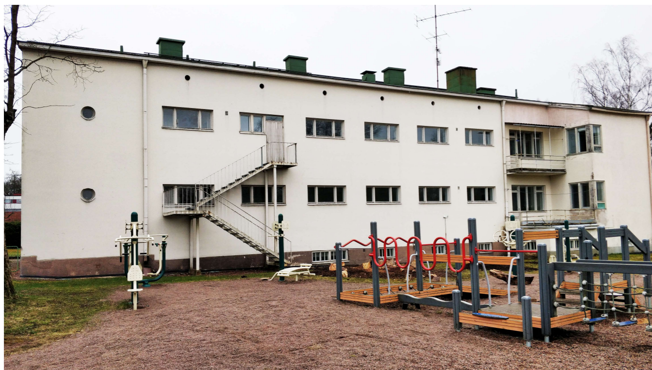
Kuva 20. Rakennuksen Garnisoniin päin antava julkisivu. Käytävän nauhamaiset yläikkunat muistuttavat muun muassa S-yhtymän rakennusten saman aikakauden funktionalistisesta tyylistä. Poistumisporras on rakennettu myöhemmin, samoin oikealla olevan parvekkeen katos.
