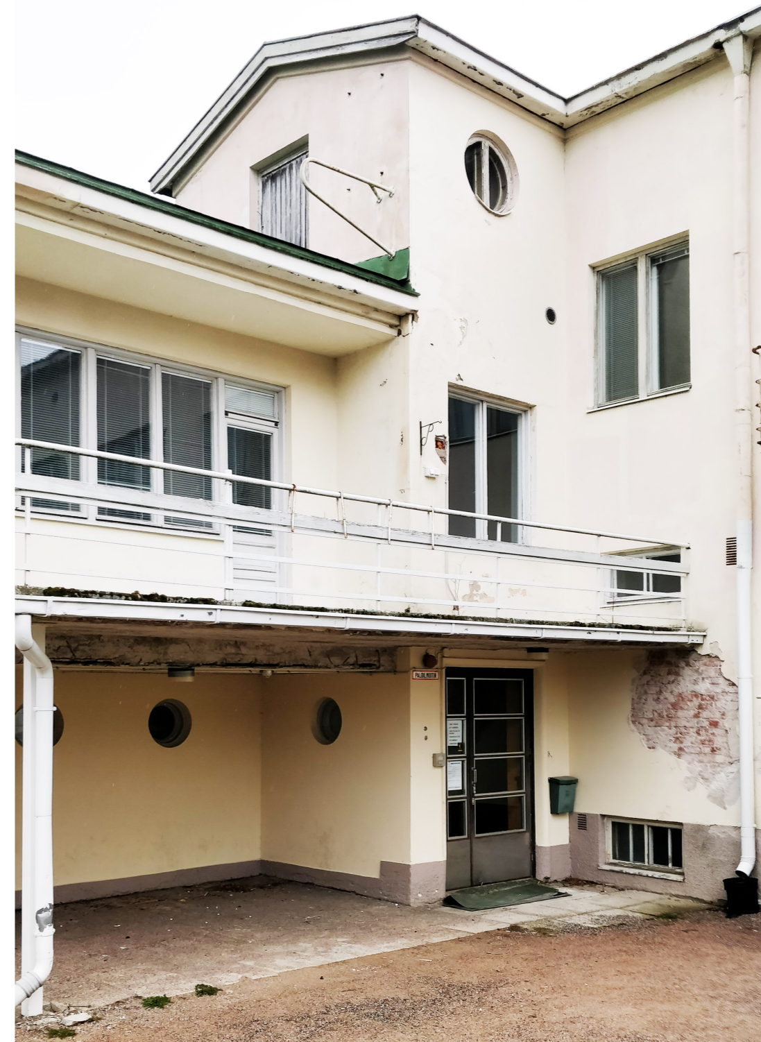
Kuva 18. Kuva pääsisäänkäynnistä. Vasemmalla oleva katto toimi alun perin kattoterassina, kulkuovi sinne näkyy ylhäällä. Terassikaiteet on purettu ja kattomuotoa ilmeisesti muutettu. Edessä vasemmalla olevan syvennyksen takana on nykyisellään keittiö. Alun perin syvennyksen perällä oli ilmeisesti varastotilat ja näitä varten kaksi ovea ja yläikkunat.
