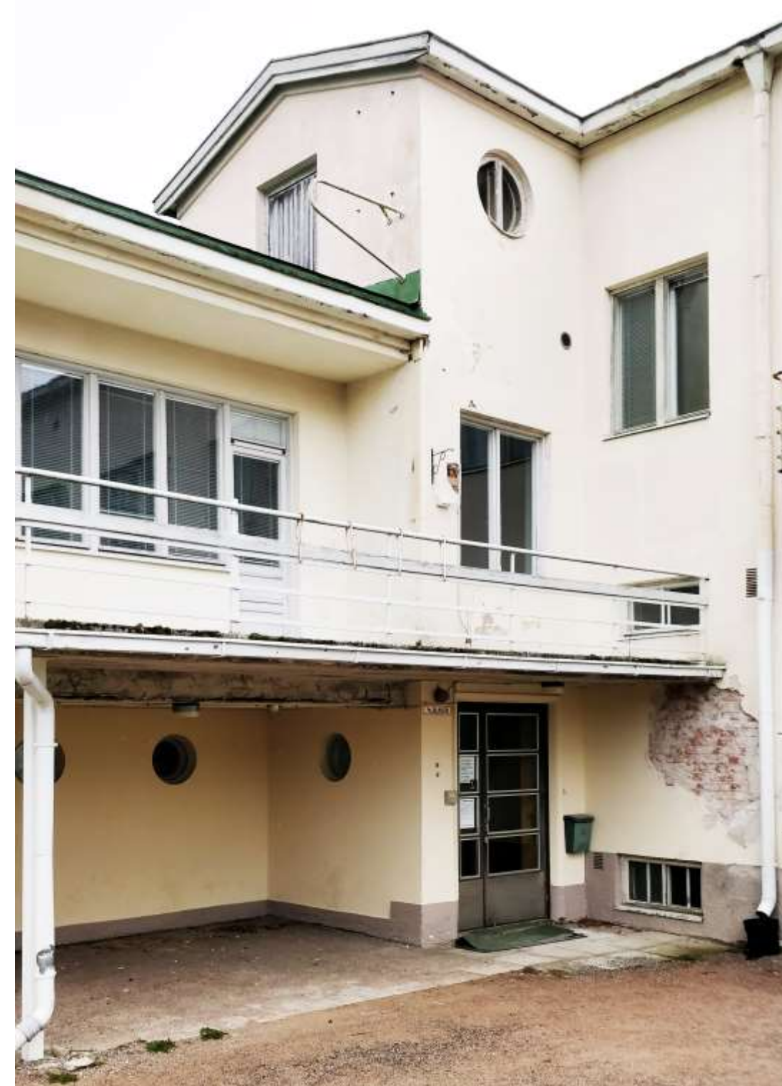
Kuva 18. Kuva pääsisäänkäynnistä. Vasemmalla oleva katto toimi alun perin kattoterassina, kulkuovi sinne näkyy ylhäällä. Terassikaiteet on purettu ja kattomuotoa ilmeisesti muutettu. Edessä vasemmalla olevan syvennyksen takana on nykyisellään keittiö. Alun perin syvennyksen perällä oli ilmeisesti varastotilat ja näitä varten kaksi ovea ja yläikkunat.
