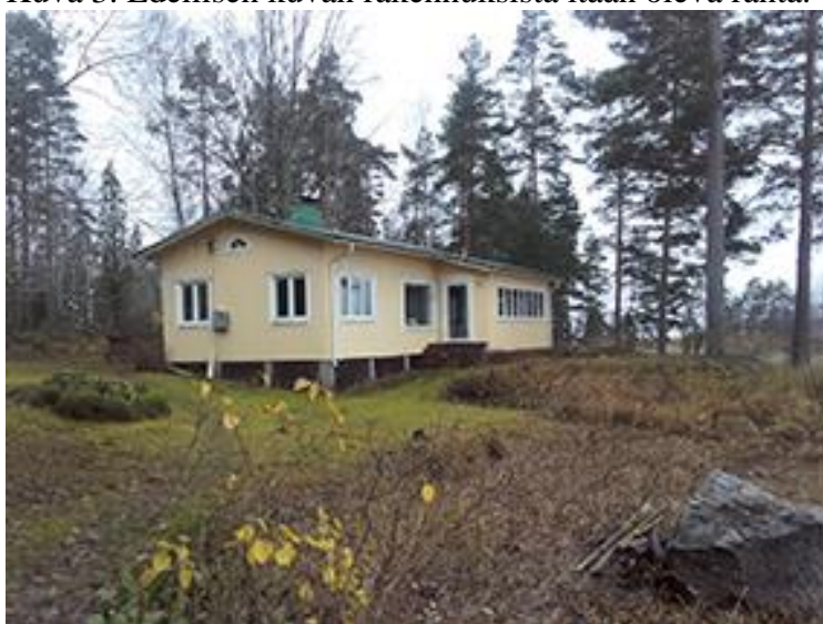
Kuva 4. Rakennuspaikan 2. 1950-luvulla rakennettu lomamökki.
