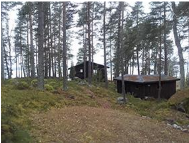
Kuva 2. Rakennuspaikan 1. mökki ja liiteri rantaan päin kuvattuina.
