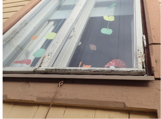
Kuva 11. Huonokuntoinen ikkuna
