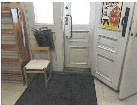
Kuva 30. Eteisaulan 112 sisempi ulko-ovi on kohdekäyntien aikaan ollut auki
