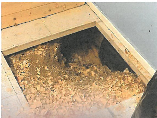
Kuva 10. Rakenneavaus 2, ryhmähuoneen 105 alapohja
