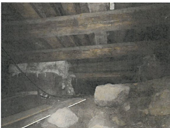
Kuva 18. Alapohjan aluslaudoitus ja maapohja eteisaulan 112 alapuolella
