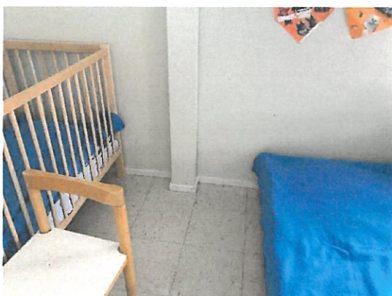
Kuva 4. Ryhmätila 101, ulkoseinän ja alapohjan liittymä
