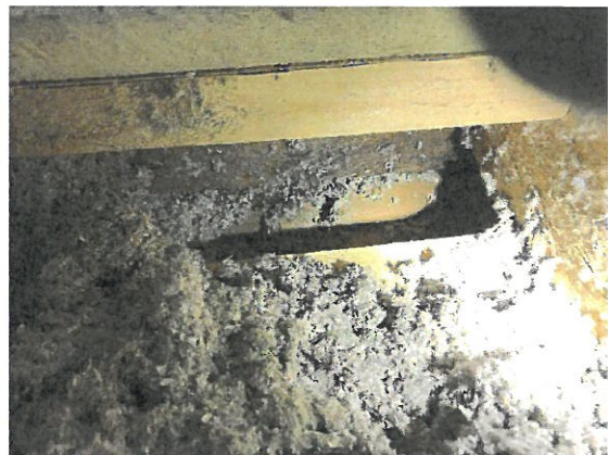
Kuva 23. Rakenneavaus 5, alapohjan eristeenä sellupuhallusvillaa, kohdassa ei havaittu vaurioita
