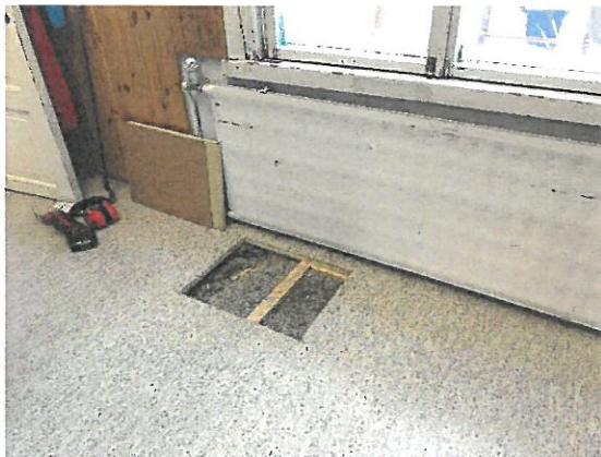
Kuva 22. Rakenneavaus 5, eteisaula 116a, uusittu alapohja
