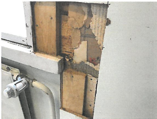
Kuva 26. Rakenneavaus 4, ryhmätilan 101 ikkunaliittymä
