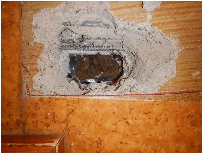
Lattiarakenteen tarkistus piikkaamalla.
