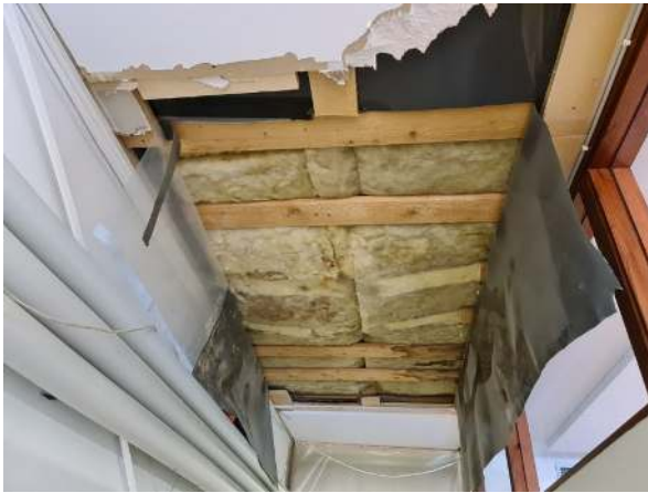
40. Kattoa avattu sisäpuolelta.
