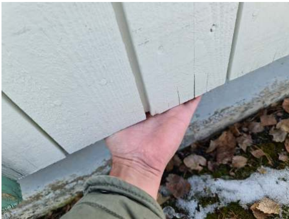
24. Lautaverhouksen takana on tuuletusrako.
