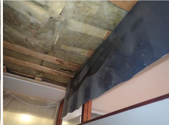
Kuva 4 Rakenneavaus yläpohjasta
