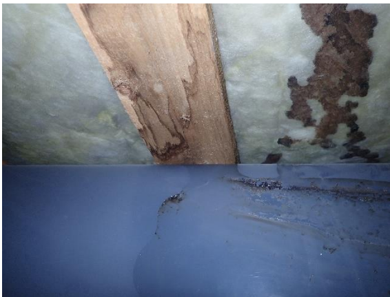
Kuva 5 Kosteusvaurioita rakenteissa
