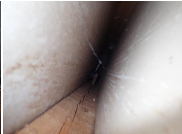
Kuva 13 Lämmöneristämätön seinätila
