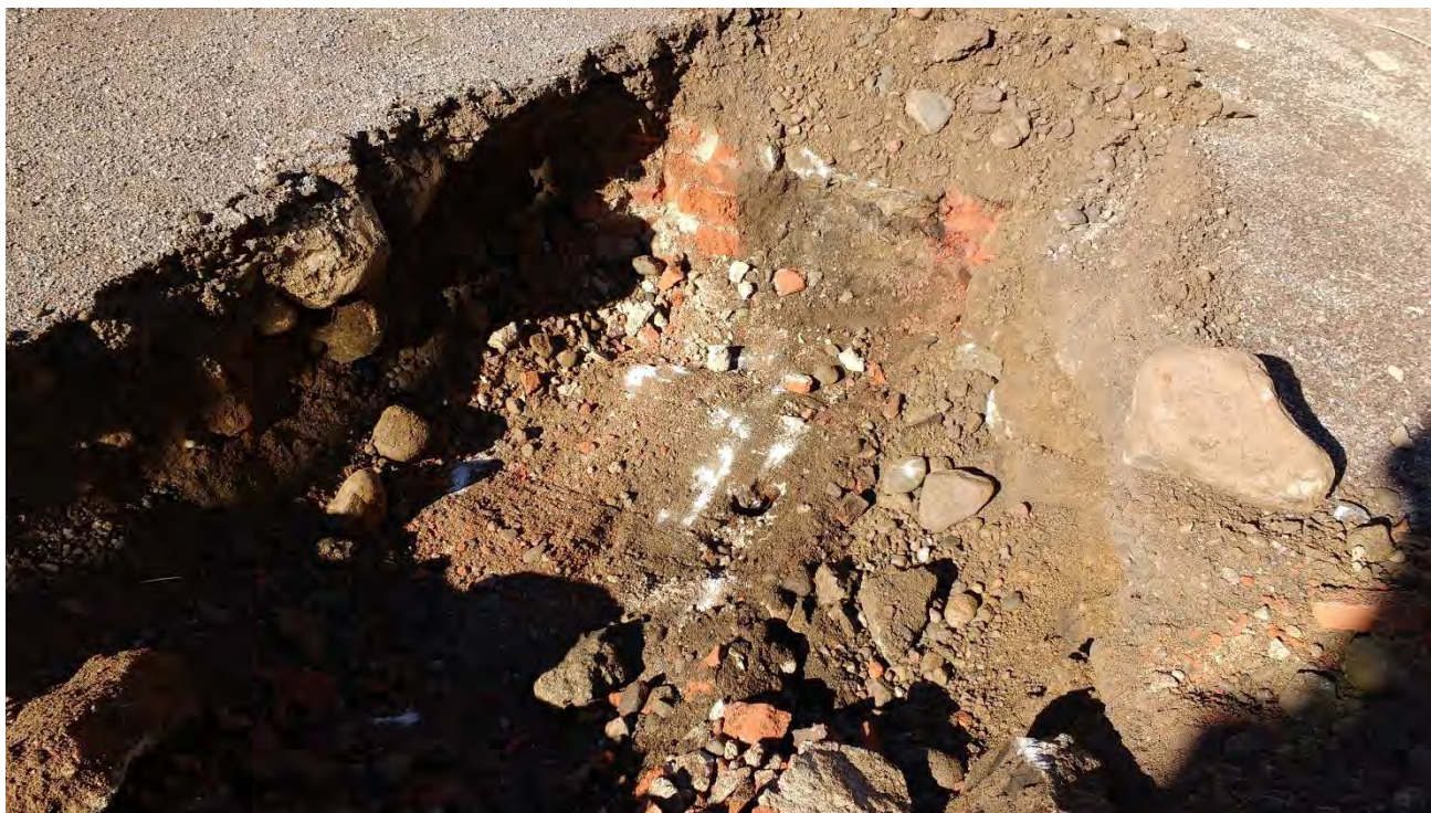
Kuva 3. Koekuopan KK3 pohjoisreunassa todettiin tiilirakenne ja pohjalla betonia.
