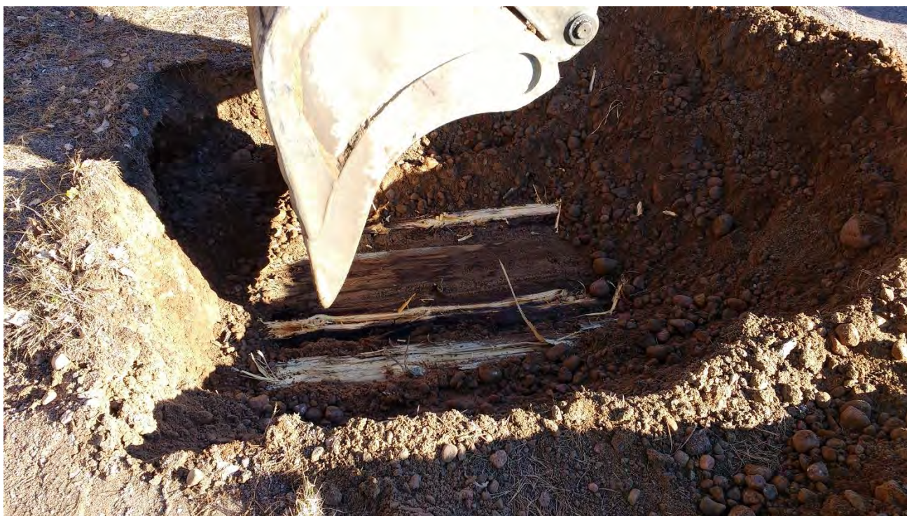
Kuva 5. Koekuopassa KK17 todettiin puuarina.
