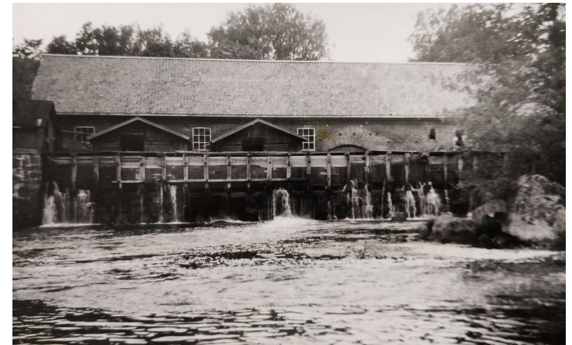
Kuva 20. Alapajan itäjulkisivua kosken toiselta puolelta kuvattuna n. 1930-luvulla. Kaksi vesipyörä-huonetta on jäljellä, kolmas on purettu. Vesipyörähuoneiden välissä olevat 9-ruutuiset ikkunapuitteet ovat vaaleat. Neljäs, purettu vesipyörähuoneen oikealla puolella nykyisin oleva ikkuna puuttuu kuvasta. )
