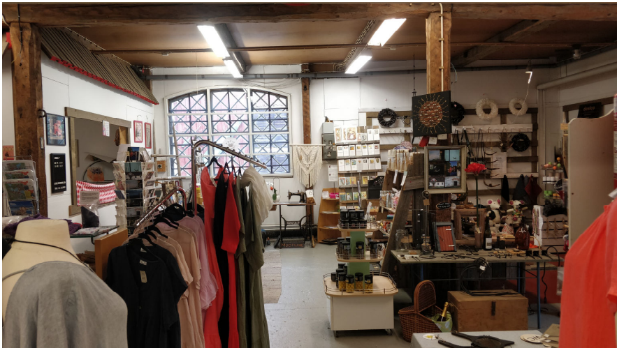
Kuva 76. Myymälätila rakennuksen eteläpäätyyn päin kuvattuna. Alkuperäinen pilaristo ja palkisto on näkyvissä. Katto on levytetty kovalevyin, seinät lastulevyin.
