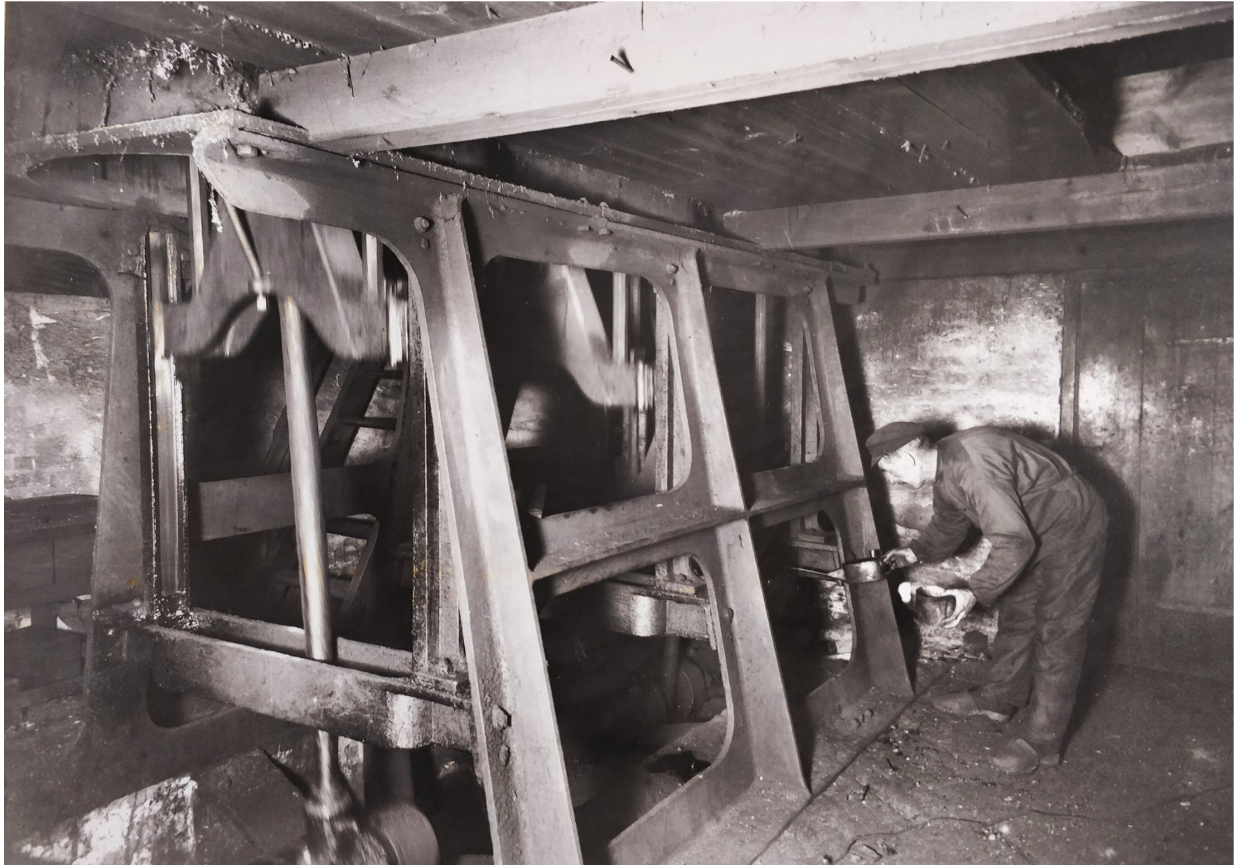
Kuva 28. Vesipyörähuoneiden eteläpuolella sijainneen muuratun puhallinhuoneen kojeisto. Siipeen asennettiin kolmisylinterinen yksitoiminen puhallinkone, joka korvasi palkeet. Kuvassa sitä on rasvaamassa seppä Kalle Lihr.
