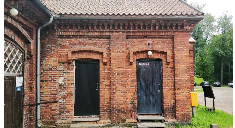
Kuva 46. Ahjosiiven pohjoisjulkisivu. Ovien kohdalla on alun perin ollut umpimuuraus, sitten vasemmanpuoleisen oven vieressä vasemmalla puolella nurkassa ovi. Oikeanpuoleinen oviaukko on 1950-luvulta, siinä olevassa tilassa on toiminut viimeksi turisti-info. Vasemmanpuoleinen oviaukko on 2010-luvulta.
