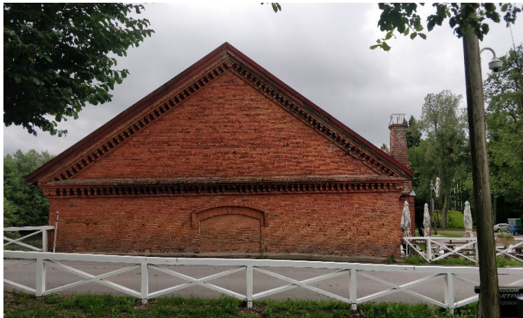
Kuva 45. Alapajan pohjoispääty. Padon muututtua maapenkereeksi tie täytettiin rakennusta vasten. Tällöin päädyn ikkuna poistettiin ja muurattiin umpeen.
