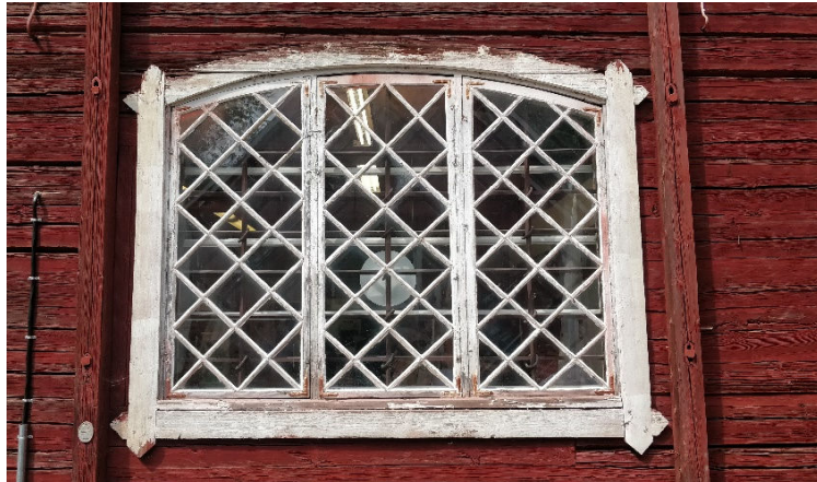
Kuva 56. Eteläpäädyn ikkuna. Aitan ikkuna on malliltaan samanlainen kuin länsijulkisivun muuratun julkisivun ikkunat. Ikkunalistojen nurkissa on koristeaihe. Ulkolasin takana näkyy suoraruutuinen sisäpuite. Välissä on teräksinen kalteri murtosuojana. Ikkunan molemmin puolin näkyy hirsiseinän jäljät
