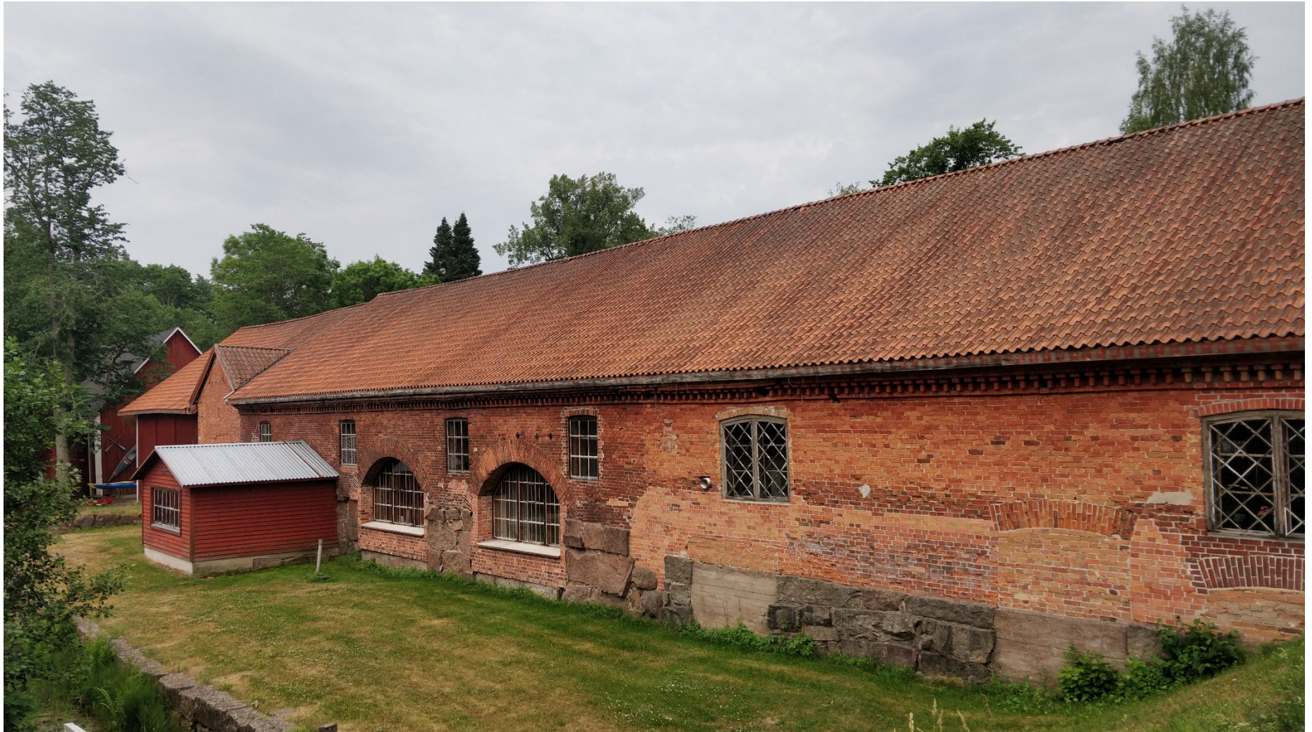
Kuva 40. Alapajan monikerroksinen itäjulkisivu sillalta kuvattuna. Oikealle jää kevyt paja, keskellä kankipaja, jonka perustus on tehty kookkaammin luonnonkivin. Tiilimuuraus on myös hieman tummempi. Kevyt pajan puolella näkyy julkisivussa umpeen muurattuja holvikaaria, näiden kautta vesiuoma on kulkenut sisällä olevalle vesipyörälle. Ikkunoiden ympärillä näkyy 1990-luvulla korjattuja muurauksia. Oikealta ensimmäinen suoraruutuinen yläikkuna on puhkottu seinään myöhemmin, ilmeisesti 1950-luvulla.. Vesipyöriä varten tehtyjen kahden holvikaaren paikalle on asennettu ruutuikkunat 1950-luvulla. Kolmannen, olemassa olevan vesipyörän päälle on 1990-luvulla rakennettu uusi vesipyörähuone. Sen takana näkyy puretun puhallinhuoneen pääty. Taaimmaisena on hirsirakenteinen aitta, jonka koskenpuoleinen julkisivu on verhottu pystylaudoin, muualla hirsi on näkyvissä. Tiilikate on 1990-luvun korjaustöiden aikainen.
