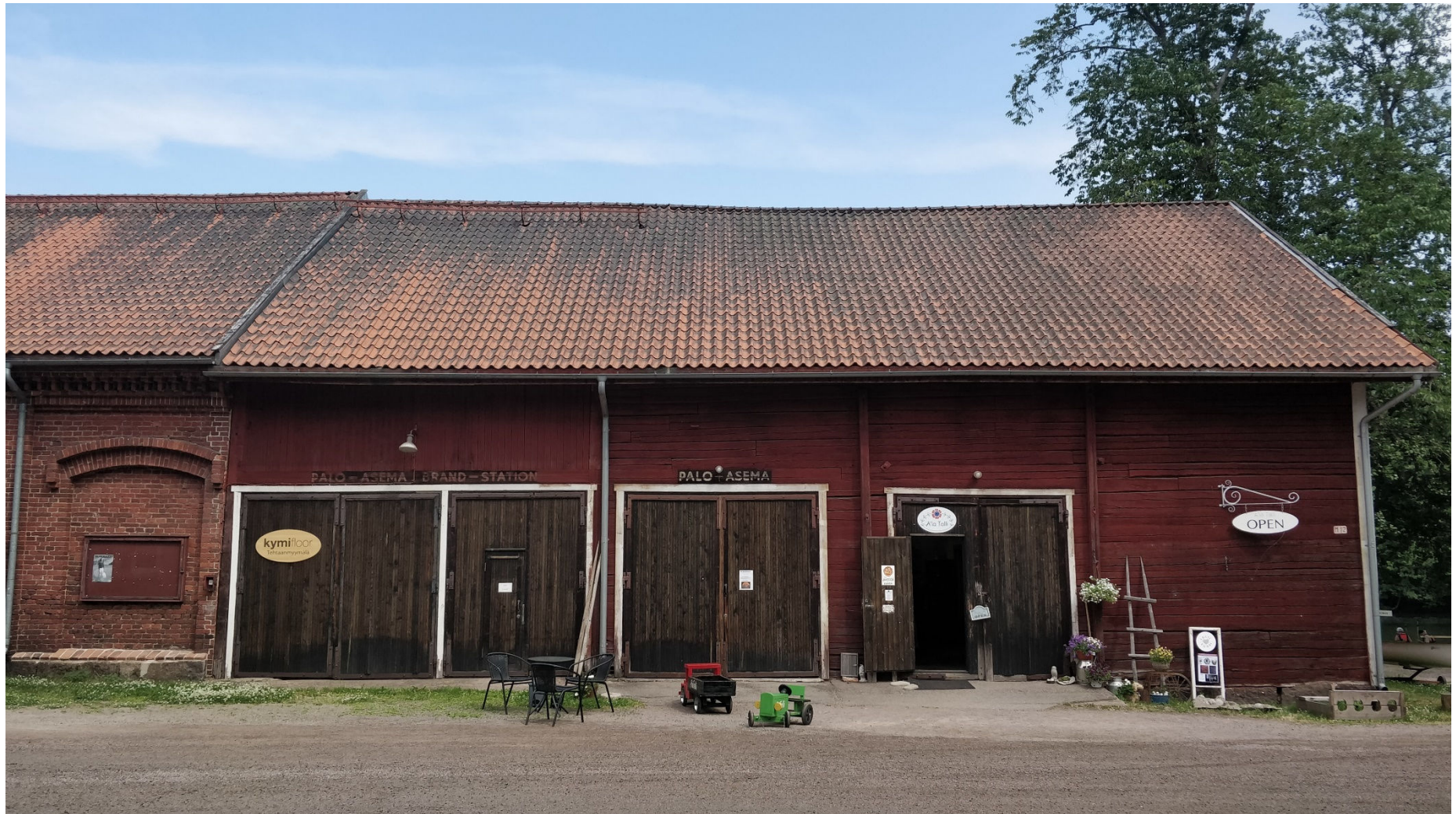
Kuva 43. Aitan länsijulkisivu. Kaksi vasemmanpuoleista pariovea sijoittuvan entiseen lastausvälikköön. Puurakenteinen seinä rakennettiin tiili- ja hirsijulkisivujen välille 1950-luvulla tilan muuttuessa paloaseman käyttöön. Hirsiseen aitan julkisivuun on puhkottu samassa yhteydessä kaksi pariovea, oikeanpuoleisen kohdalla oli alun perin ikkuna, vasemmanpuoleinen on tehty muita myöhemmin paloaseman autoarsenaalin kasvettua. Oviaukkojen eteen on valettu teräsbetoninen ramppi, niiden yläpuolella näkyy edelleen paloasema-tekstit. Alun perin vesikatto on ollut samassa tasossa. Kun tiilisen osan kattotuolisto muutettiin 1940-luvulla, se korotti hieman vesikatetta. Tässä saumakohdassa havaittiin vakavimmat vesikaton vauriot 1990-luvun kartoituksessa ja rakenteita jouduttiin uusimaan.
