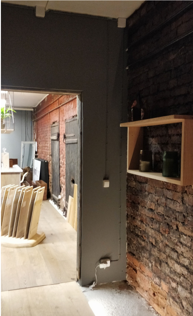
Kuva 72. Kankipajan eteläseinä. Tila on alun perin ollut lastauskatoksena, ruukin lopettamisen jälkeen paloasema paloautoineen käytti tiloja. Pajaan johtaneet kaksi ovea ovat todennäköisesti alkuperäisiä eli 1870-luvulta. Tila on toiminut viimeksi esittelytilana.
