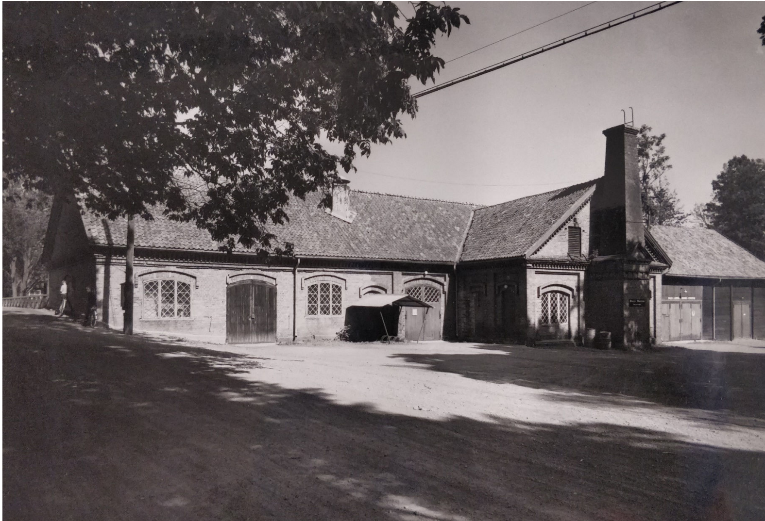
Kuva 35. Alapaja uusien toimintojen jälkeen vuonna 1965. Vasemmanpuoleisin ovi on levennetty, jotta kuorma-autot mahtuvat sisään. Keskellä oleva pariovi on sekin uusittu. Oviaukkoa on korotettu ja ovi aukeaa ylös asti (vrt. kuva s. 20). Matala teräsrakenteinen katos on rakennettu kahden parioven väliin. Tässä kohdin olevalle julkisivun holvikaariaiheeseen kohdalle ei ilmeisesti tässä vaiheessa ole tehty oviaukkoa; se sijaitsee kenkätörmän ja kankipöydän väliseinän kohdalla. Sisäpuolella näkyy vaaleampaa muurausta, kun ahjosiiven vanha oviaukko on muurattu umpeen ja uusi ovi on asennettu ulkonurkan lähelle, sen yläpuolella ilmeisesti pallovalaisin. Oikealla ahjosiiven takana näkyy aitan entisen lastausyhteyden kohdalle tehty seinä ja pariovet, kun paloasema asettui rakennukseen. Oikealla verstaan puuvarastoon johtanut pariovi. Näiden väliin tehtiin vielä yksi pariovi paloaseman käyttöön.
