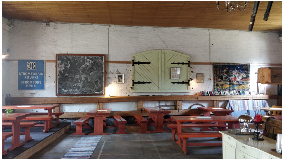
Kuva 61. Kenkäpajan sisätilaa pohjoispäätä kohti. Umpeen muuratun ikkunan kohdalle on asennettu puurakenteinen luukku.
