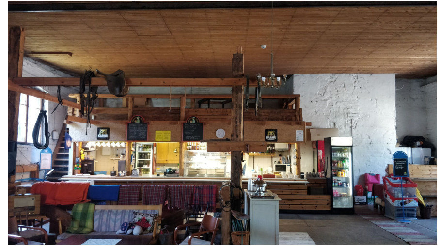
Kuva 62. Kenkäpaja kankipajan suuntaan. Kookas ulkonema on kankipajan tyskahjo, jota vasten kenkäpajan puolelle oli muurattu hehku-uuni.
