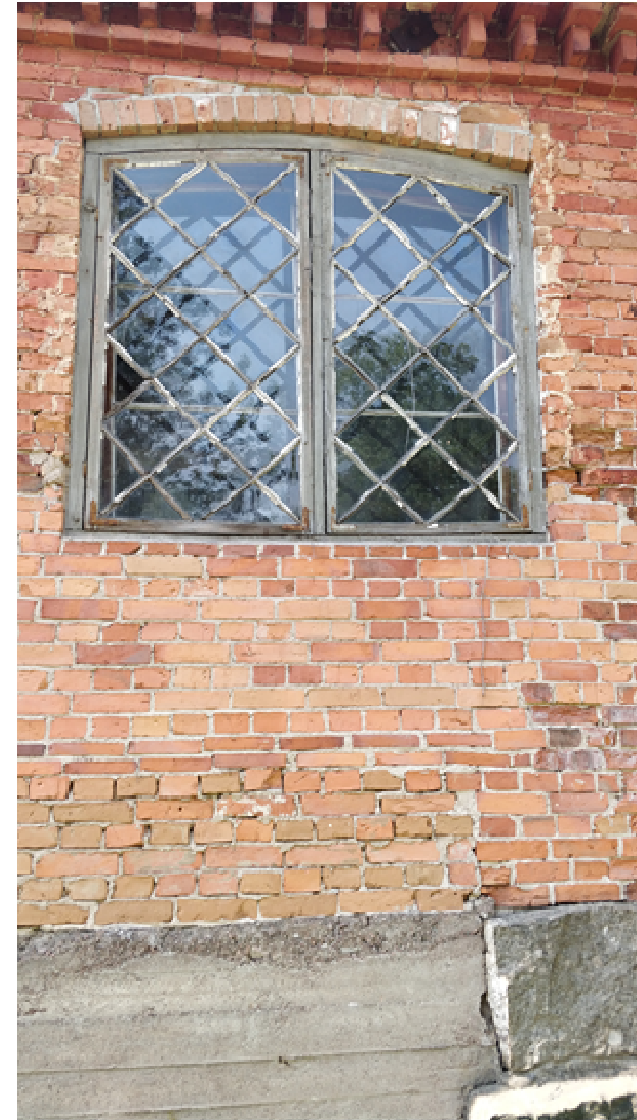
Kuva 55. Kenkäpajan itäjulkisivua. Vinoruudutetun ikkunan sisäpuolella näkyy myöhemmin asennettu suorilla lasiruuduilla jaettu sisäikkunapuitte. Kuvassa näkyy myös tiilimuuraukseen tehtyjä korjausmuurauksia sekä teräsbetonilla valettu sokkeli luonnonkiven vieressä
