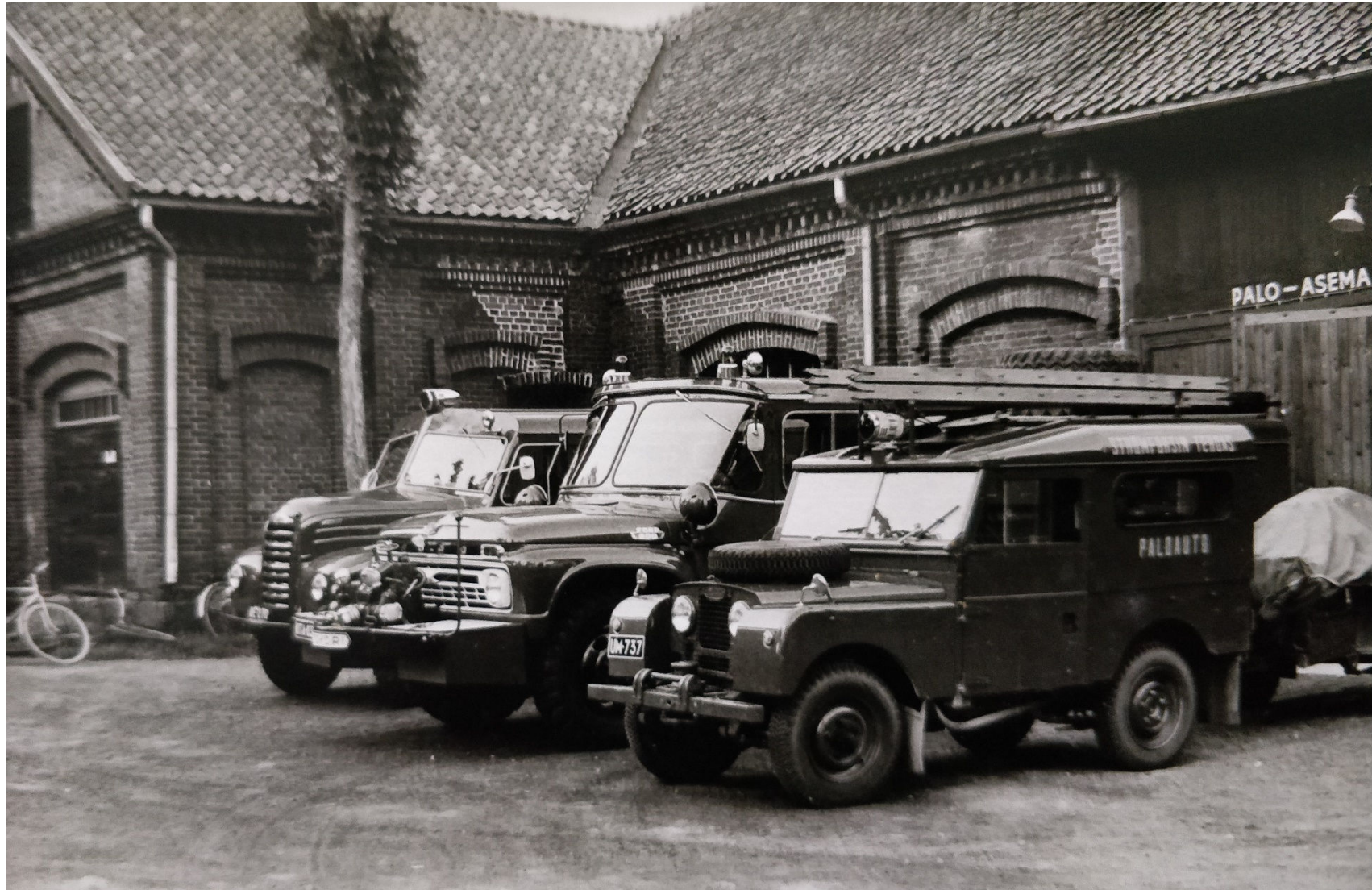
Kuva 37. Paloaseman edusta ahjosiipeen päin kuvattua. Muurauksesta erottuu uudelleenmuurattua julkisivua mm. museon oven yläpuolelta ja ahjosiiven eteläjulkisivulta oviaukon yläpuolelta.
