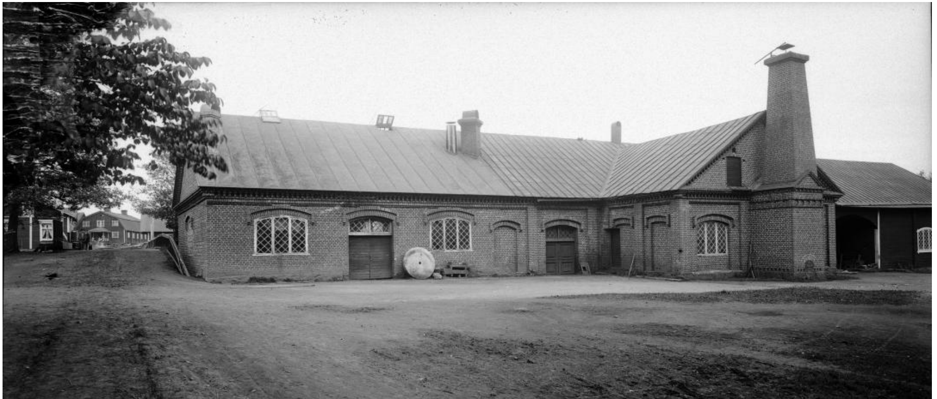
Kuva 21. Kankipajan julkisivua lännen suunnalta. Keskellä olevan kankipajan arkkitehtuuri on pilastereineen koristeellisempi kuin vasemmalla olevan 25 vuotta myöhemmin muuratun kenkápajan, jossa julkisivun reliefit ovat astetta niukemmat. Peltikatevuota on eri osilla eri levyinen. Kornisi kiertää rakennuksen räystäään korkeudella. Ikkunoiden yläpuolen holvikaari muodostaa myös koristeaiheen. Matalahko massiivinen piippu sijoittuu symmetrisesti ahjosiiven päähän. Oikealla näkyy puurakenteinen aitta ja lastausvälikkö, joka jäi aitan ja kankipajan väliin. Aitan julkisivussa näkyy ikkuna, joka on malliltaan samanlainen kuin aitan päädyssä nykyisellään oleva. Sama malli toistuu myös muuratussa pajaosassa.
