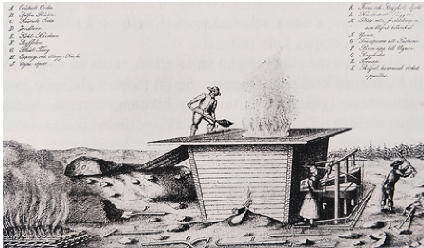
Kuva 2. Harkkohytti Taalainmaalla Ruotsissa 1730-luvulla. Hirsisiä harkkohyttejä tehtiin myös Suomessa jo ennen ruukkien syntyä.
