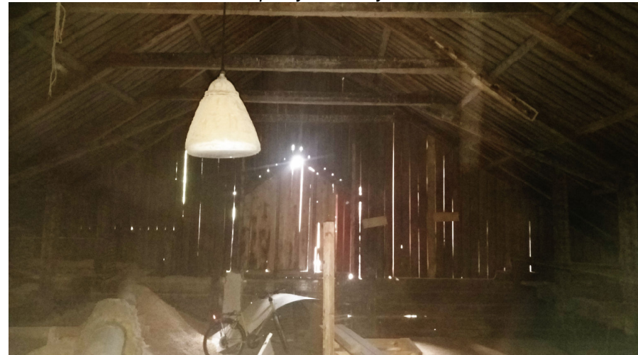
Kuva 80. Aitan kattorakenne on täysin puurakenteinen toisin kuin tiiliosan myöhemmin tehdyt kattotuolit. Reunoilla on hirsiset jalaspuut, joihin kattotuolia kantavat konttipuut tukeutuvat. Päädyn umpeen laudoitettu vanha ikkuna-aukko erottuu valoa vasten.
