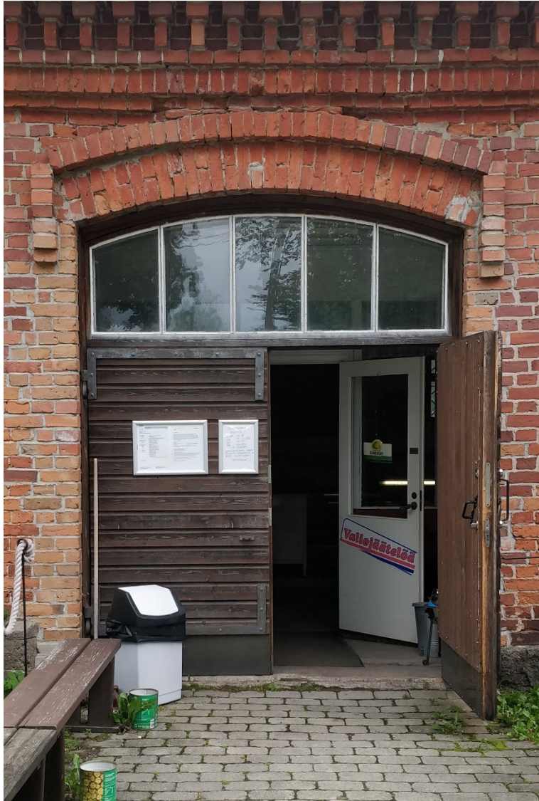
Kuva 49. Pohjoispään kahvilan 1990-luvulla uusittu ovi ja yläikkuna. Ulkopinta on verhoiltu keilapontilla. Oven kahva on edellisestä ovesta.
