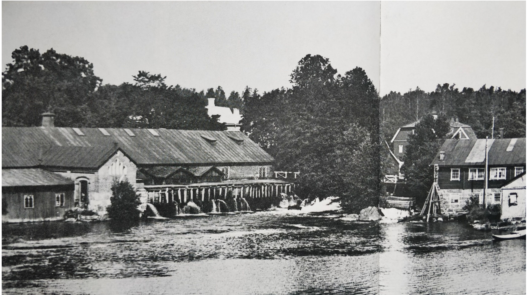
Kuva 18. Alapaja vastarannalta katsottuna. Oikealla olevan pohjoisosan lappeella erottuvat kaksi kattolyhtyä. Tiilisen puhallinhuoneen vasemmalla puolella on puurakenteinen luumylly. Kuva on 1900-luvun alusta.
