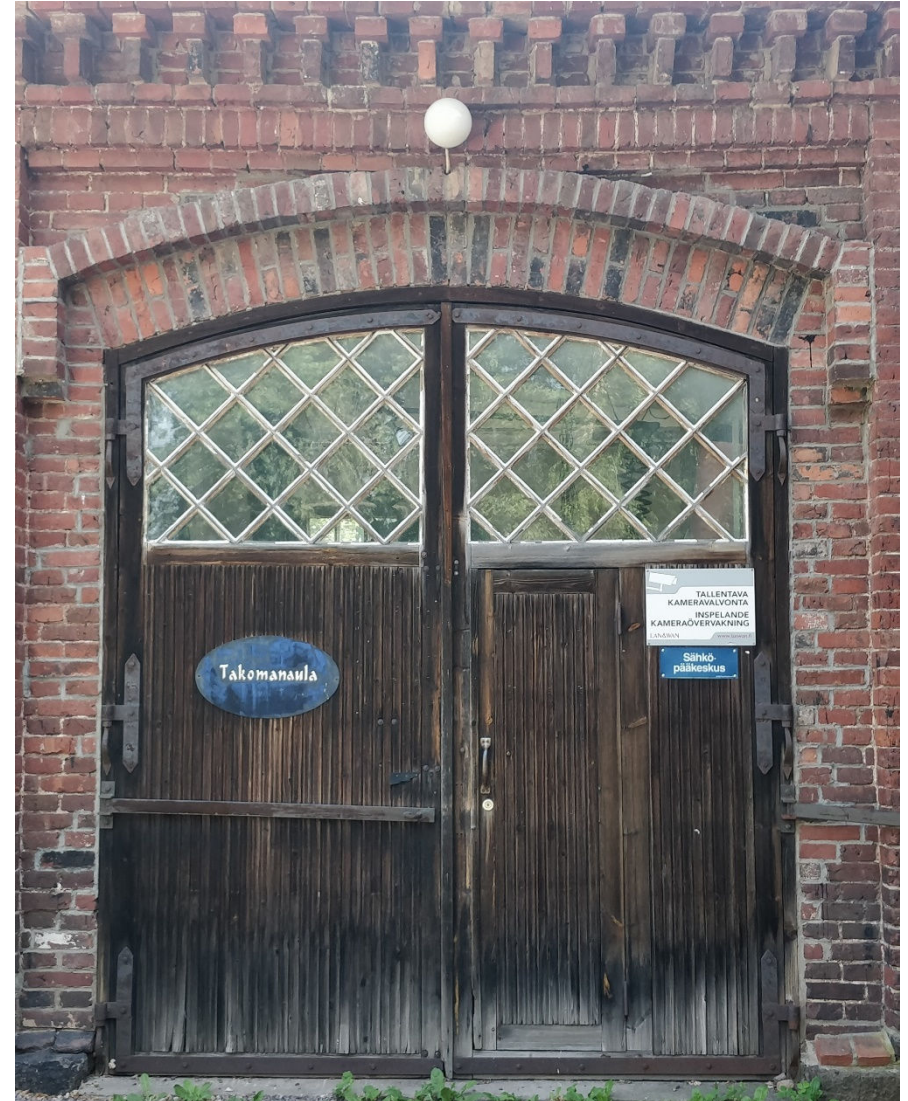
Kuva 50. Kahvilan eteläpuolella olevan vuokratilan ulko-ovi, josta on kuljettu alun perin kankipajaan. Ovi oli alun perin peiliovirakenteinen kuten todennäköisesti muutkin ovet. Aukkoa korotettiin 1950-luvulla ja ovi uusittiin ylös asti aukeavaksi. Muutos liittyi pajatilan käytettä-vyyteen kuorma-autohallina. Ovi on verhoiltu kapein keilapaneelien 1950-luvun henkeen.
