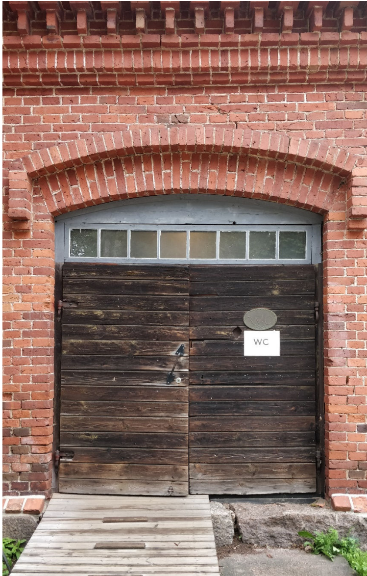
Kuva 51. Länsisiiven pariovi, piippu jää vasemmalle. Vaakapanelointi on muista ovista poikkeava. Karmien yläosa ja ikkuna on maalattu harmaalla.
