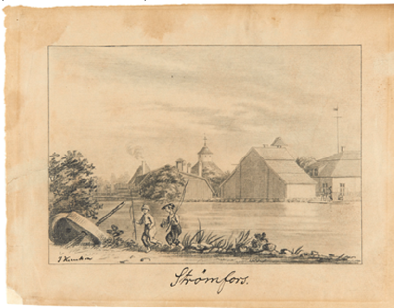
Kuva 13. Johan Knutsson'in lyijypiirros ruukista n. vuodelta 1840 on ilmeisesti vanhin kuva ruukista. Ylisuurena piirretyn letkuvajan takana näkyy mansardipäätyinen nippupaja, sen jatkeena hieman korkeampi mansardikattoinen kankipaja ja puhallinhuone. Piirustuksesta erottuu myös ahjojen piippuja. Korkea harjakattoinen varasto, "Verkhus" näkyy pajan takana.
