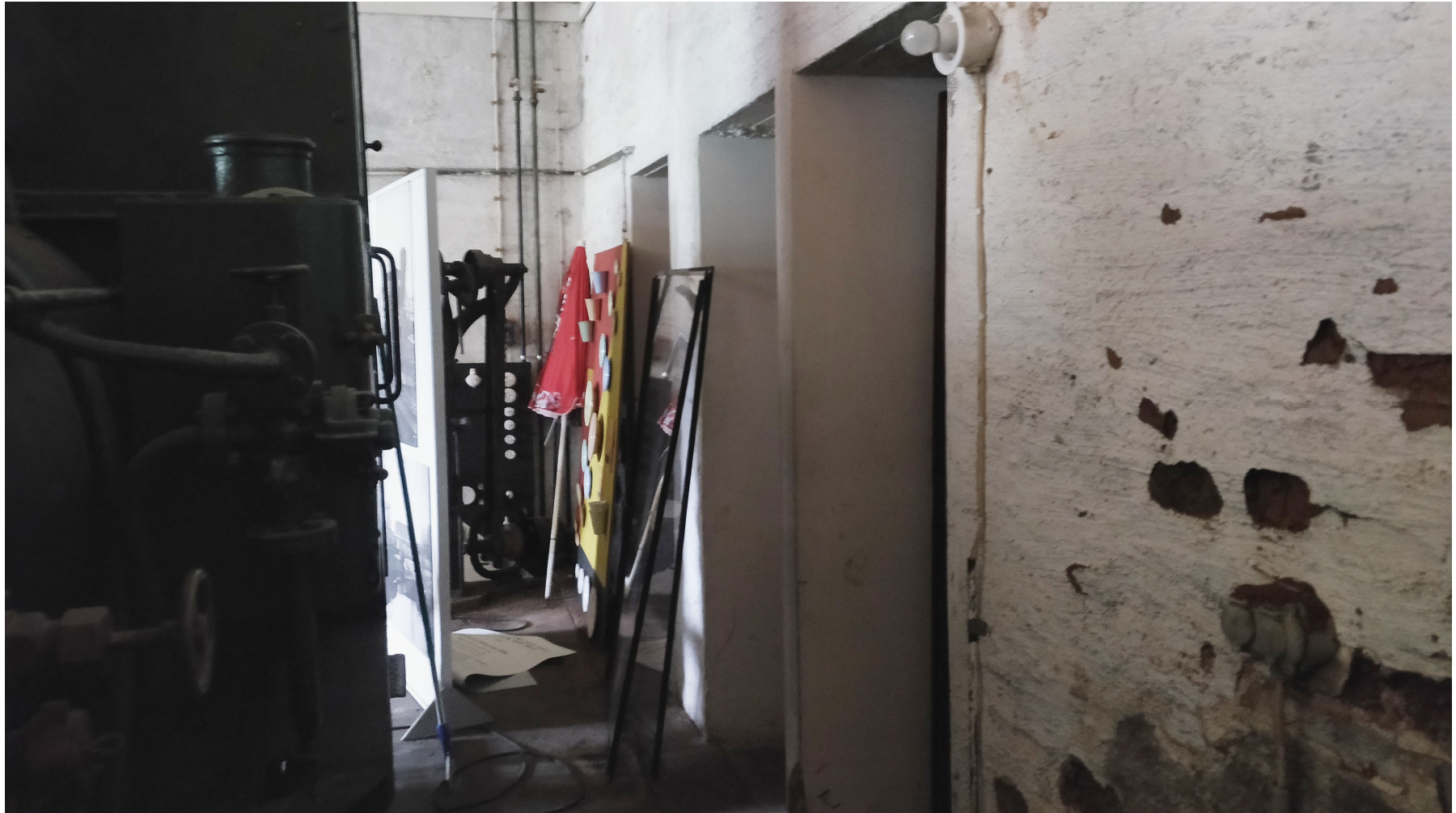
Kuva 68. Veturin takana olevassa seinässä on kolme oviaukkoa varasto- ja wc-tiloihin. Aluperin seinän läpi on johdettu tässä kohtaa ahjon savukanava ja ilmeisesti poistoilmakanava piipulle.
