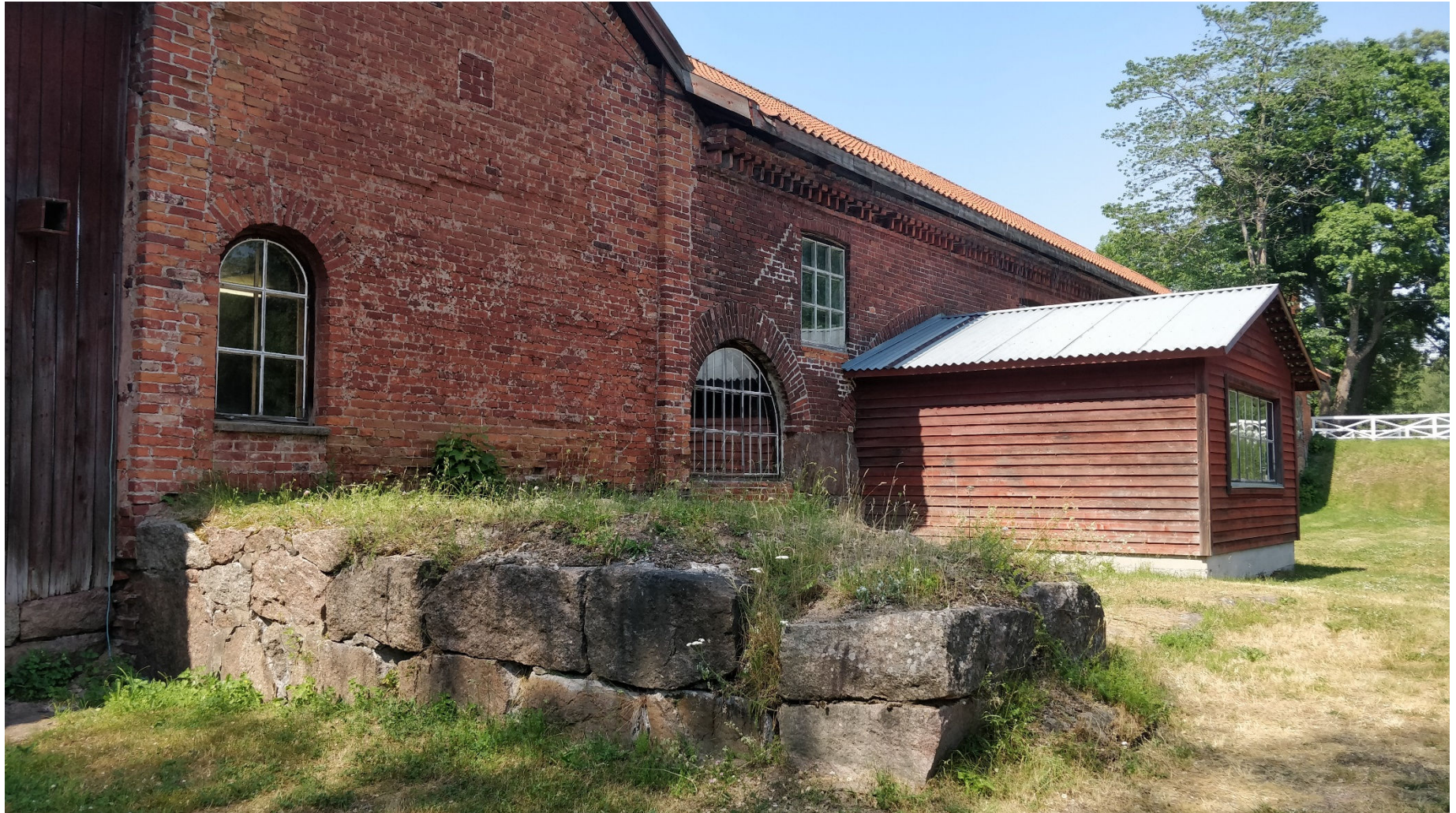
Kuva 48. Puretun puhallinhuoneen pääty. Vanhaan kulkuaukkoon on asennettu 6-ruutuinen puuikkuna 1950-luvulla, alaosa on muurattu umpeen. Oikealla on 1990-luvulla uusittu vesipyörähuone, jonka eteläseinällä oli alun perin oviaukko. Sen vasemmalla puolella on muita kaari-ikkunoita pienempikokoisempi lasitettu aukko, jossa on sijainnut muita pienempi, hiomakiveä pyörittänyt vesipyörä. Etualalla oleva kivijalka jatkui alun perin mittansa verran pidemmälle puhallinhuonesiiven päädyn ulottuessa kosken reunalle. Vasemmalle jää aitan julkisivu, sen kosken puolen julkisivu on pystylaudoitettu, muissa julkisivuissa hirsi on näkyvissä.
