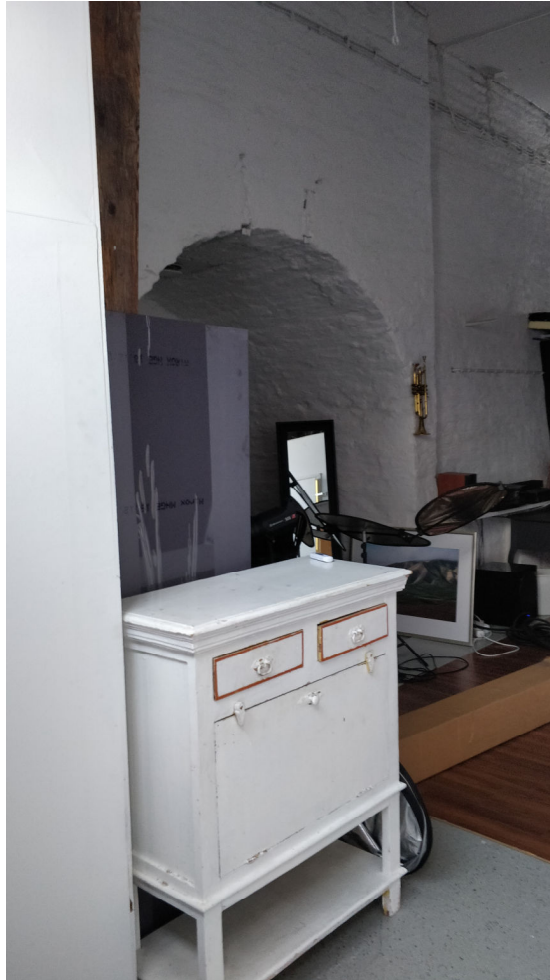
Kuva 64. Kenkäjän ja kankipajan väliseinä kankipajan puolelta kuvattuna. Kookas holvattu aukko on saksalaisahjo. Sen oikealla puolella on ollut oviaukko kenkäjään. Tilassa on toiminut mm. maalaamo ja valokuvastudio. 1990-luvun remontin yhteydessä tilaan tehtiin pieni keittiö tilan toimiessa kokoontumishuoneena.
