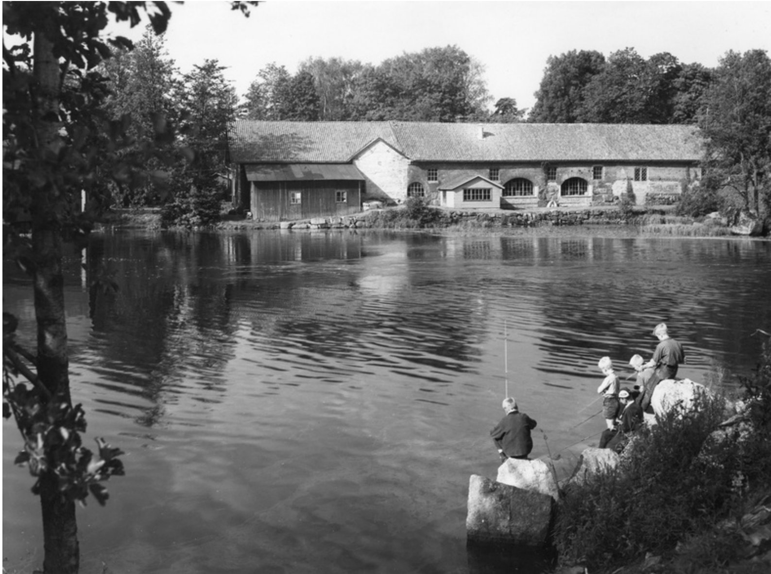
Kuva 34. Ruukin kosken puoleinen julkisivu toiminnan päätyttyä. Vesiränni on purettu, yksi vesipyörähuone on uudelleenrakennettuna paikallaan. Muihin holvattuihin aukkoihin on asennettu ikkunat ja seinän alaosan aukot on rakennettu umpeen. Puhallinsiipi on purettu, vain pääty on jäljellä. Sen eteläpuolella kosken partaalla on luumylly. Pajan kate on muuttunut peltikatteesta betonitiilikatteeksi tai tiilikatoksi.
