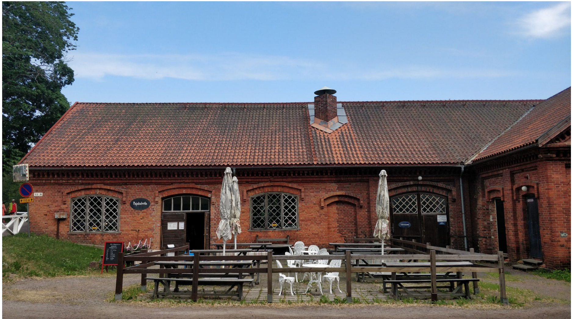
Kuva 41. Kenkämpäjän länsijulkisivu. Kankipäjän ja kenkämpäjän raja erottuu selvästi julkisivussa, jossa tiilen väri vaihtuu. Vasemmanpuoleinen pariovi ja ovenpielet korjattiin 1990-luvun lopussa. Ovi oli välillä leveämpi, muurauksesta erottuu uudelleenmuurattuja kohtia. Oikeanpuoleinen ovi on alun perin ollut matalampi ja yläikkuna ei ole ollut osana ovea vaan erillinen yläikkuna. Katolla olleista ahjojen piipuista on jäljellä vain pajojen välissä olevaan väliseinään sijoittuva tyskahjo. Oikealla näkyy ahjosiiven julkisivua.
