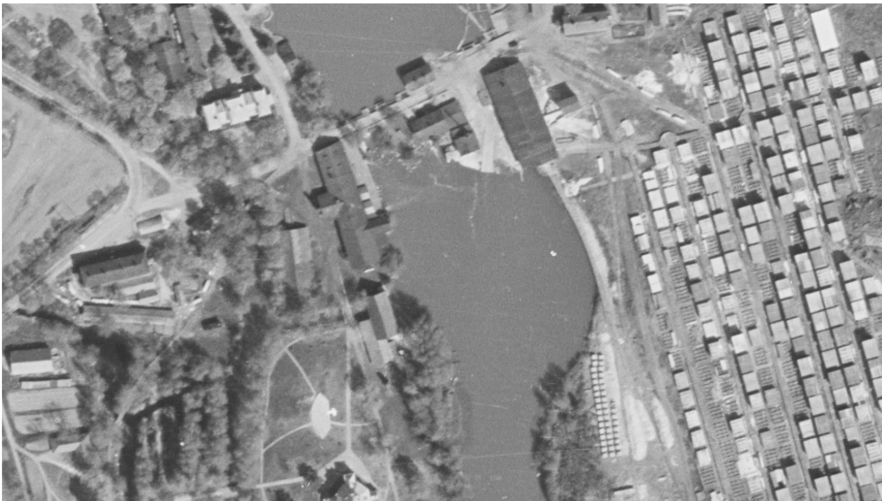
Kuva 30. Ilmakuva vuodelta 1941. Rakennuksen länsipuolella on edelleen vinottain iso hiilivarastorakennus. Kolmas vesipyörähuone on purettu.
