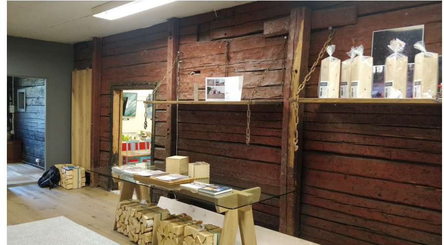
Kuva 73. Aitan pohjoisseinää. Tila rajoittuu vasemmalla paja-rakennuksen muurattuun päätyyn (edellinen kuva). Tilaan on tehty kevyitä väliseiniä, katto on levytetty lastulevyllä.
