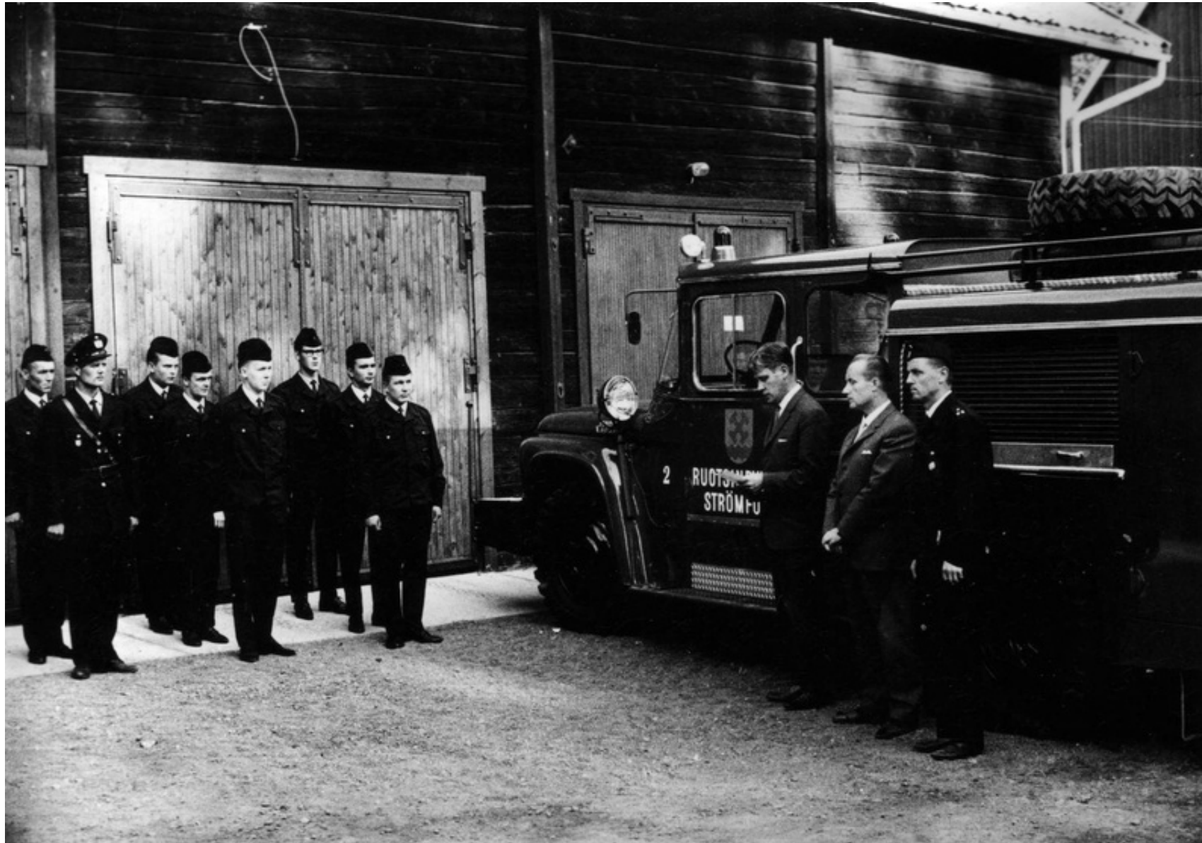
Kuva 36. Alapajan eteläpää. Palokuknta siirtyi Alapajaan Letkuvarastorakennuksesta tien toiselta puolelta. Julkisivuun on tehty kookkaat oviaukot paloautojen säilytystä varten. Hirsiseinään on puhkaistu kaksi parioviaukkoa. Ovien eteen on valettu ramppi.
