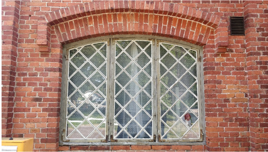
Kuva 53. Länsisiiven ikkuna länsijulkisivulla, piippu jää kuvan oikealle puolelle. Ikkuna on maalattu vihertäväharmaalla. Lasikittaukset on uusittu äskettäin.
