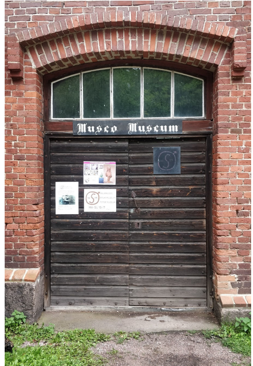
Kuva 52. Museon ovi on toinen kankipajaan johtanut pariovi. Se aukeaa muista poiketen sisäänpäin. Oven holvikaari ja sen yläpuolinen muuraus on uusittu todennäköisesti museon perustamisen yhteydessä.
