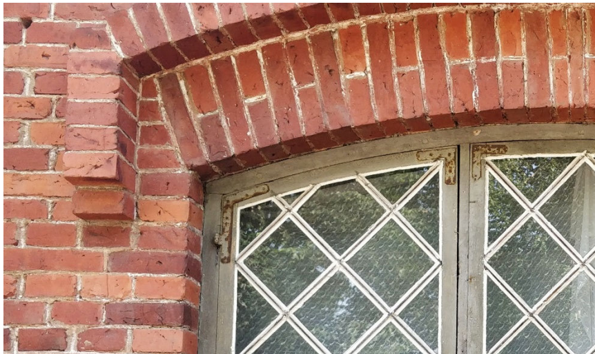
Kuva 54. Saman ikkunan ylänurkka. Teräksinen kulmahela, johon on yhdistetty sarana ajoittaa ikkunan 1800-luvun loppupuolelle. Ikkuna on siten todennäköisesti alkuperäinen.
