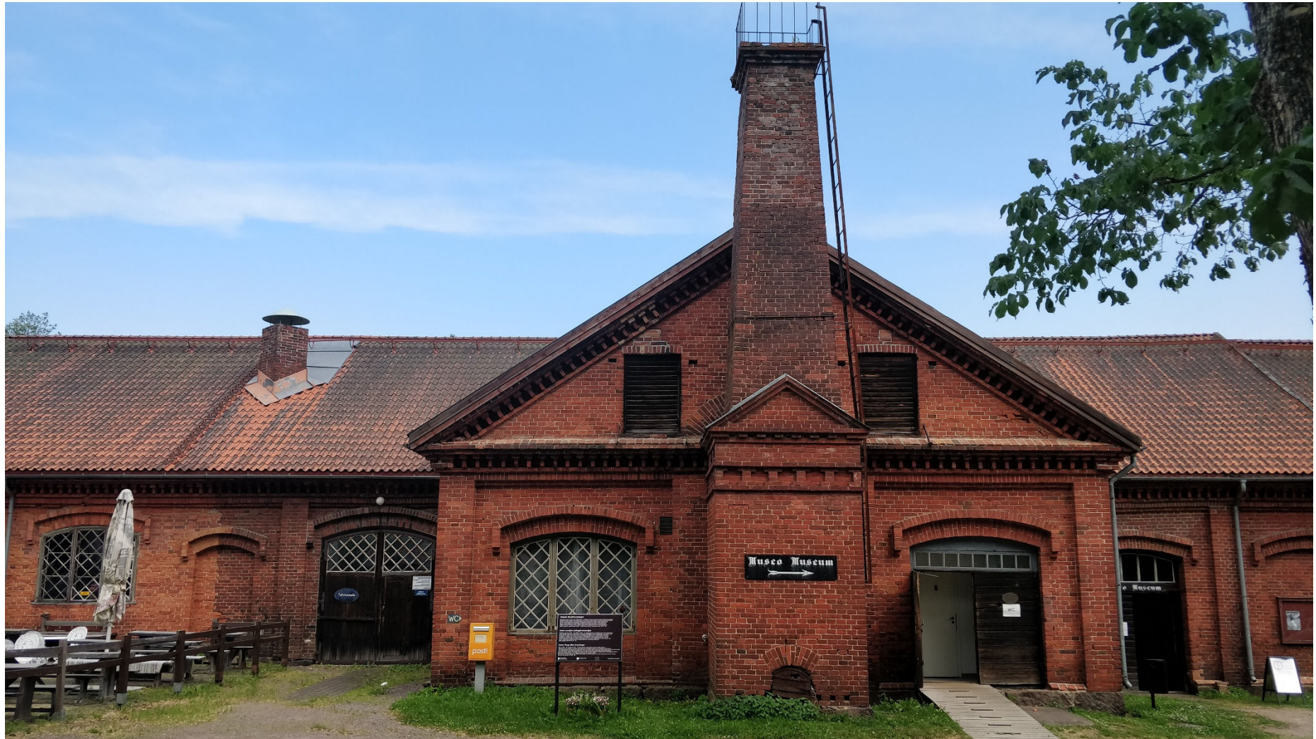
Kuva 42. Länsijulkisivun ahjosiipi. Piipun molemmin puolin olevia luokkuja on käytetty tuuletukseen. Piipun alaosassa on julkisivussa luukku, jota on käytetty ainakin nuohouksessa. Piipun vasemmalla puolella olevassa tilassa on toiminut 2000-luvulla turisti-info, oikealla on yleisö-wc. 1990-luvun lopun kunnostustöissä piipun yläosa muurattiin uudelleen. Rakennuksen edustan maastoa leikattiin länsijulkisivun osalta siten, että se viettää pois rakennuksesta. Oikealla näkyy museotilaan johtava pariovi.
