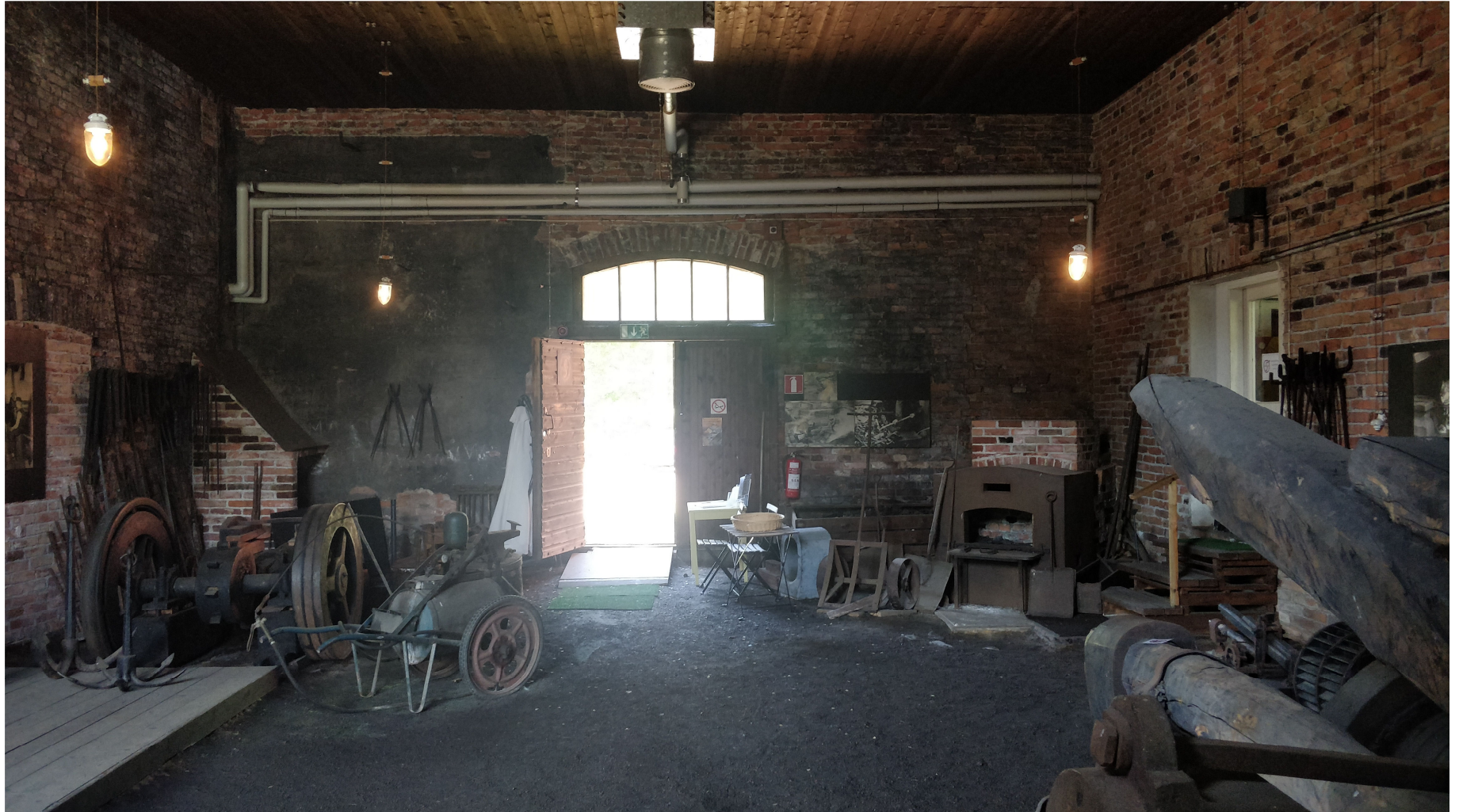
Kuva 70. Pajamuseo länteen päin kuvattuna. Oikealle jää vasara vesipyörineen. Oikealla oleva muita vaaleampi väliseinä on muurattu museota perustettaessa. Tilan takanurkkiin on rekonstruoitu kaksi ahjoa. Vasemmalla on tilaan Yläpajasta siirretty pieni vasara. Autenttisen oloisen lattian alle on kaivettu salaojat 1990-luvulla.
