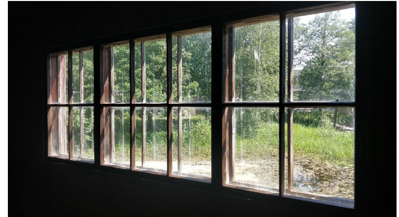
Kuva 58. Vesipyörähuoneen 2-puitteinen puuikkuna sisältä päin. Vesipyörähuone uusittiin 1990-luvulla, mutta ikkuna on puretusta vesipyörähuoneesta.
