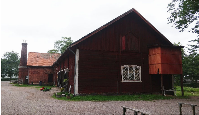
Kuva 44. Rakennuksen eteläpääty. Puuverstastoiminnasta muistuttaa purusiilo. Hirsirungon päällä olevan ullakon seinä on rankarakenteinen. Päädyn ikkuna on samanlainen, kuin paloaseman eteläisimmän oven kohdalla ollut. Ullakon kookas ikkuna on poistettu ja rakennettu laudoituksella umpeen.
