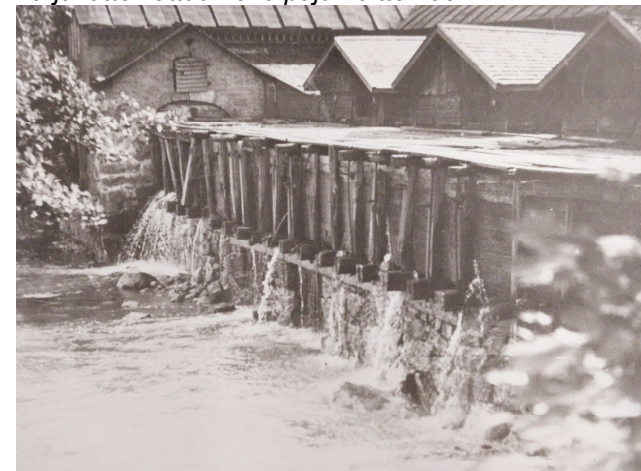
Kuva 17. Vesipyörähuoneiden vesikate on päreestä. Takana näkyy tiilinen ja peltikattoinen puhallinhuone.
