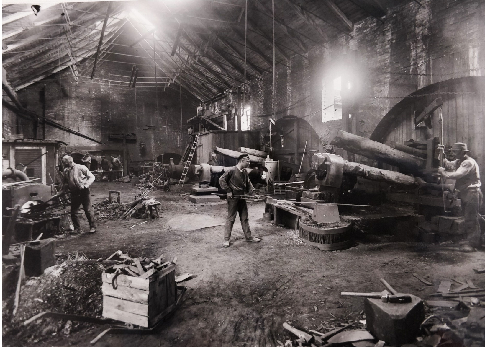
Kuva 27. Kankipajan miljöötä pohjoiseen eli kenkäpajan suuntaan 1920-30-luvulta. Etualalla vasemmalla france comté- ahjo, johon johtava paksu putki on johdettu puhallinhuoneesta. Sen takana oleva seppiä lepohuone "Aamurusko". Takaseinällä on työntekijöitä tynkähjon äärellä. Paja käytti loppuaikoinaan raaka-aineena paljon romurautaa.
