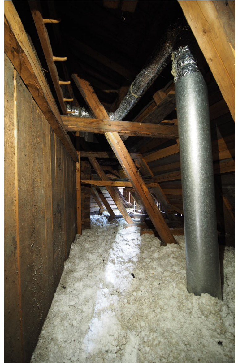
Kuva 38. Itäinen ullakkotila. Osa kattotuolien konteista on vajaita. Tilassa on seinällä vanha naulakko 1800-luvulta.
