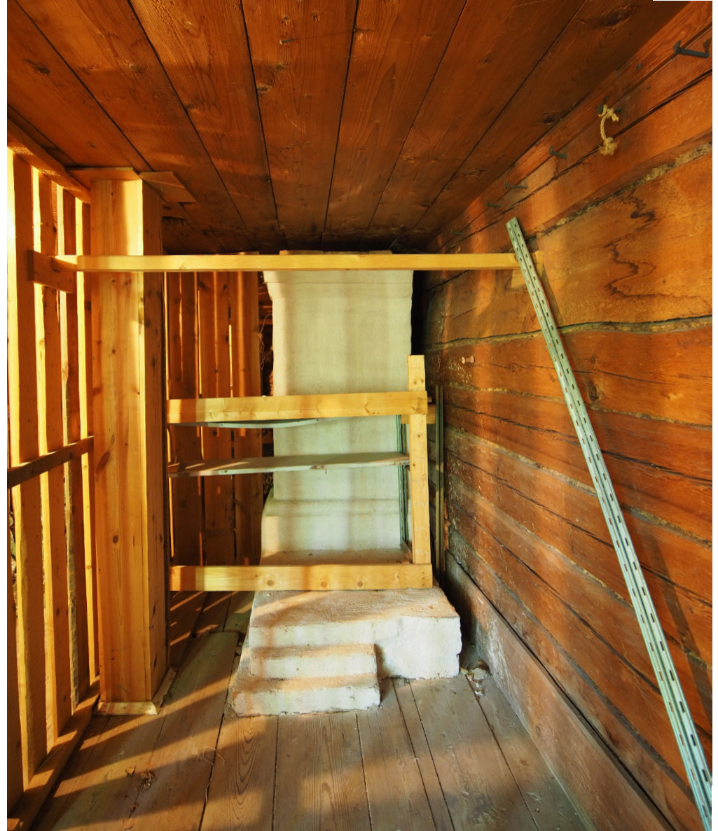
Kuva 94. Yhdessä varastossa on jäljellä osittain purettu tulisija, johon liittyy pieni tasanne.
