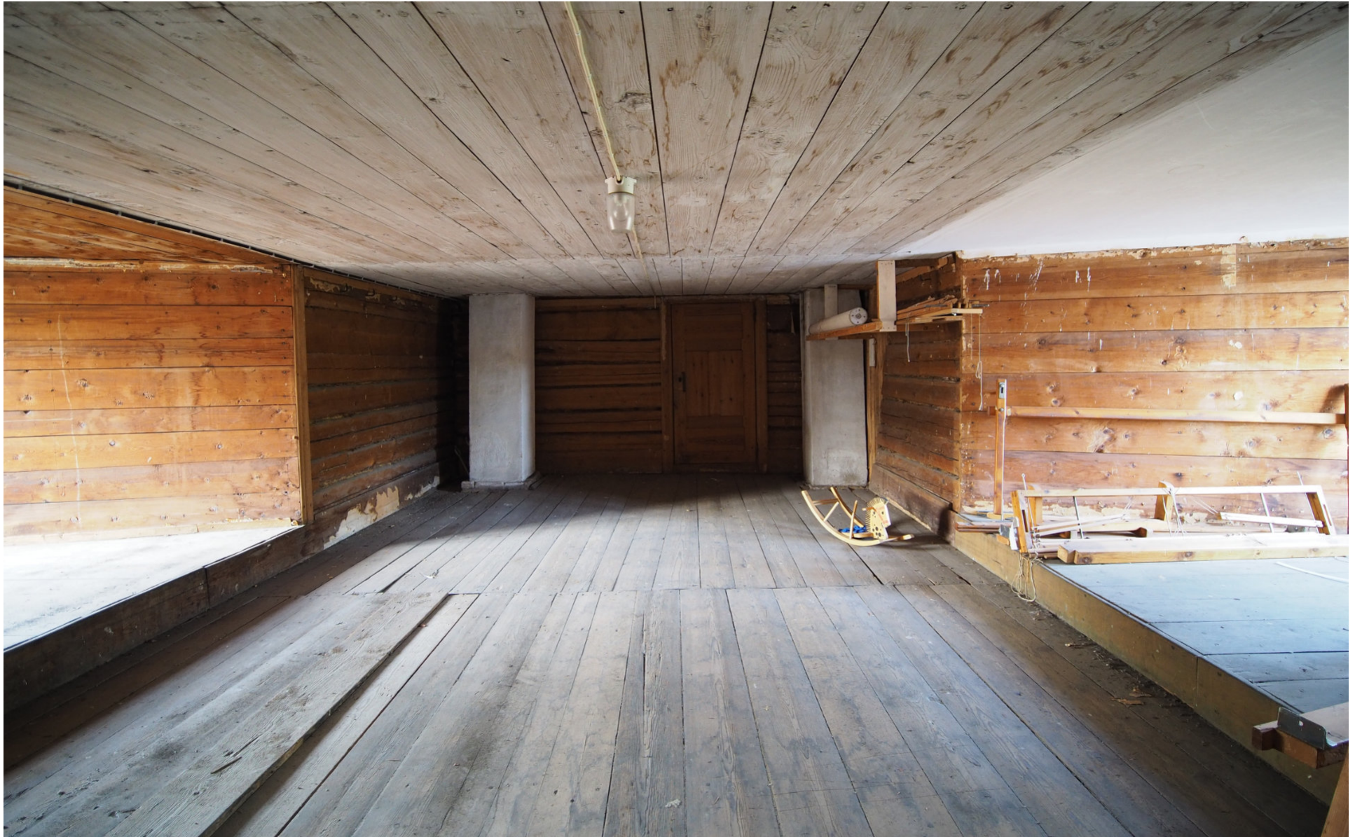
Kuva 97. Ullakon keskikammari kohti pohjoista. Myös katto on ollut maalattu ja/tai tapetoitu. Toisessa poikkipäädystä valkoinen pinta on vielä jäljellä.
