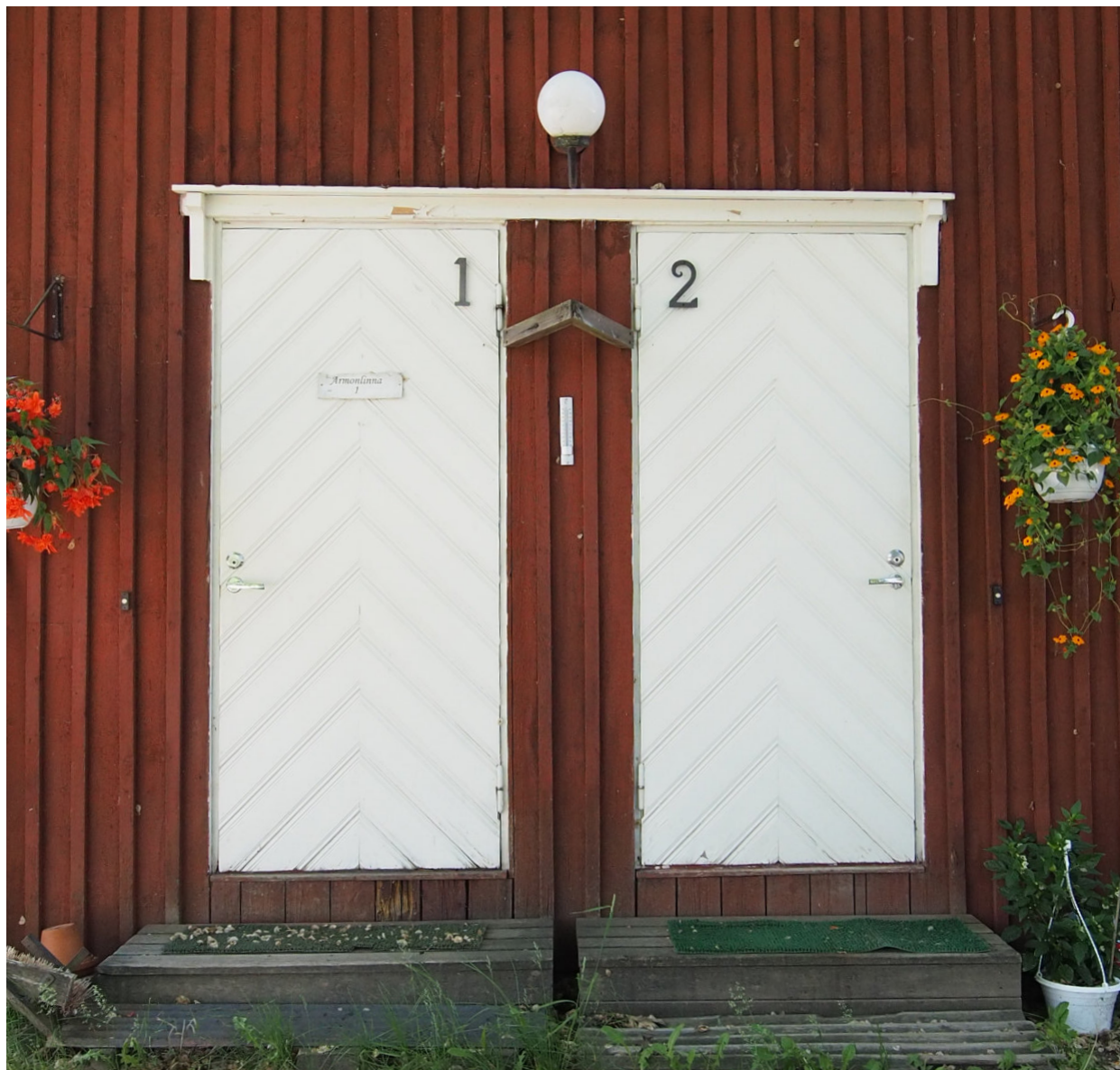
Kuva 46. Vuonna 1985 lisätyt vinopanelointiovet pohjoispäädyssä. Ovilla on yhteinen vesilauta.
