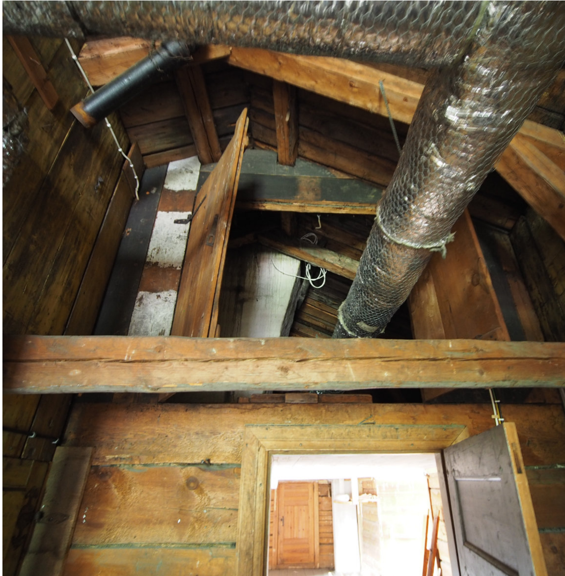
Kuva 37. Ullakon keskikammarin ylle muodostuu yläpohja, jonne johtaa puiset luukut.
