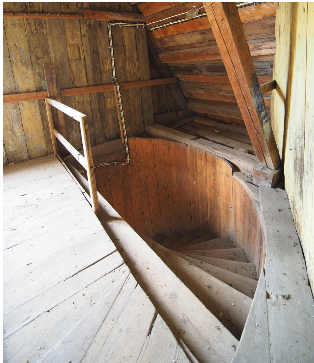
Kuva 86. Ullakolle johtavat kierreportaat ullakolta katsottuna.
