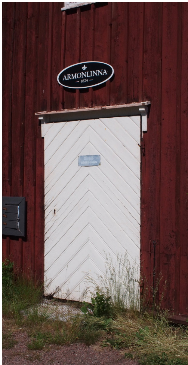
Kuva 42. Eteläjulkisivun läntisin ovi sähköpääkeskukseen.
