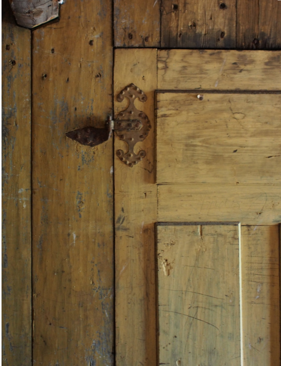
Kuva 50. Ullakkokerroksen ovesa on koristeelliset saranat 1800-luvulta.
