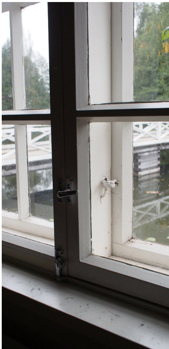
Kuva 57. Ikkunoilla nivelsäpit ja sormihaat.
