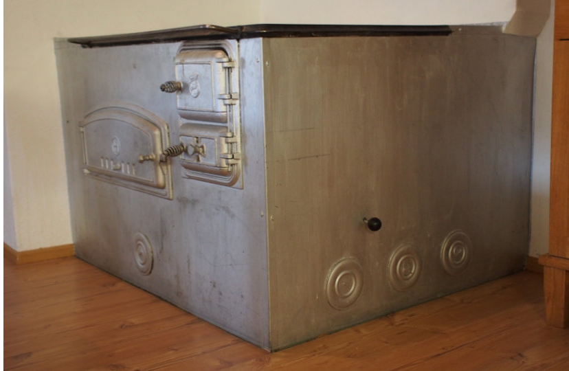
Kuva 69. Vanhan tulisijan tilalle lisätty puuhella 1920-30-luvulta. (as 3)
