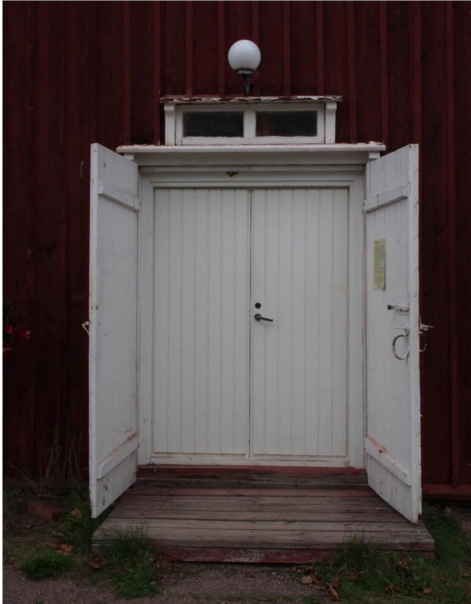
Kuva 44. Eteläpään keskimmäiseen sisäänkäyntiin on kaksoisovirakenne.
