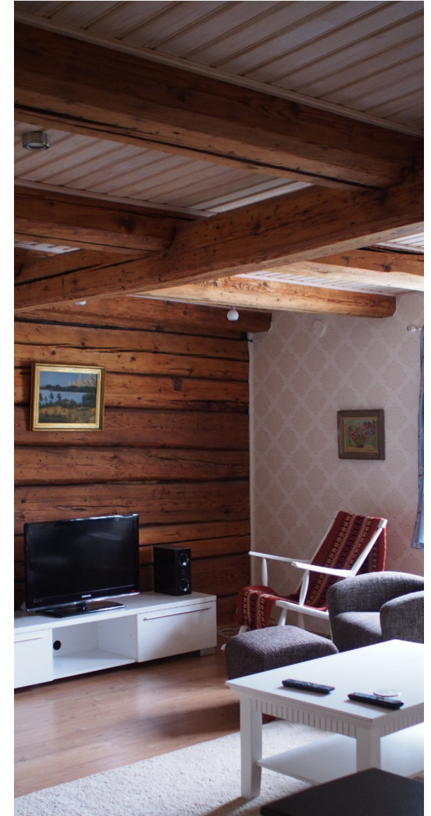
Kuva 76. Alakattovasojen risteävät rakenteet näkyvät hyvin entisen leipomon itäpuolella.
