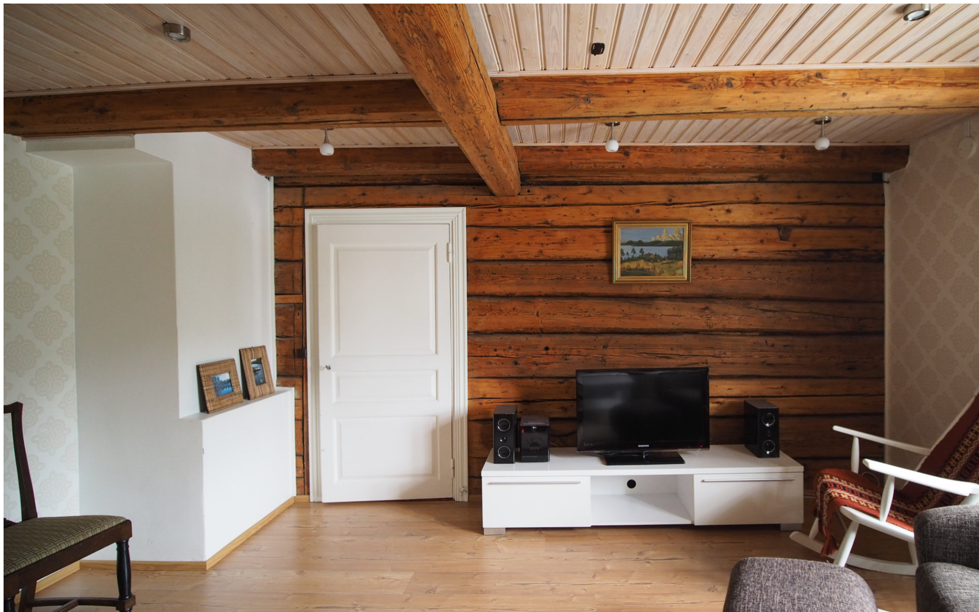
Kuva 79. Olohuoneessa on esillä rakennuksen ainoa pinnoittamaton hirsiseinä. Kuvassa vasemmalla näkyy puretun tulisijan jäänteet.
