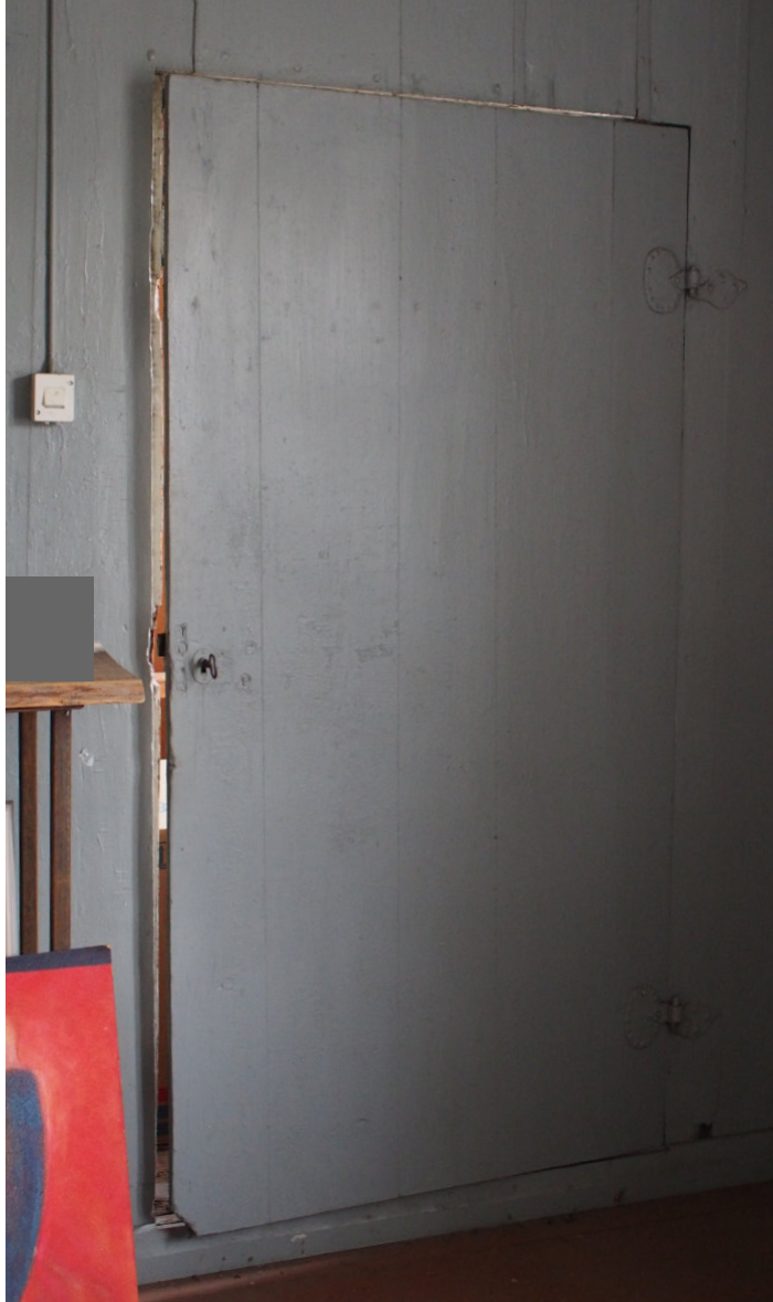
Kuva 52. Eteläisen porrasaulan lautaovi piiloportaille. Ovi on todennäköisesti 1800-luvulta saranoiden perusteella.
