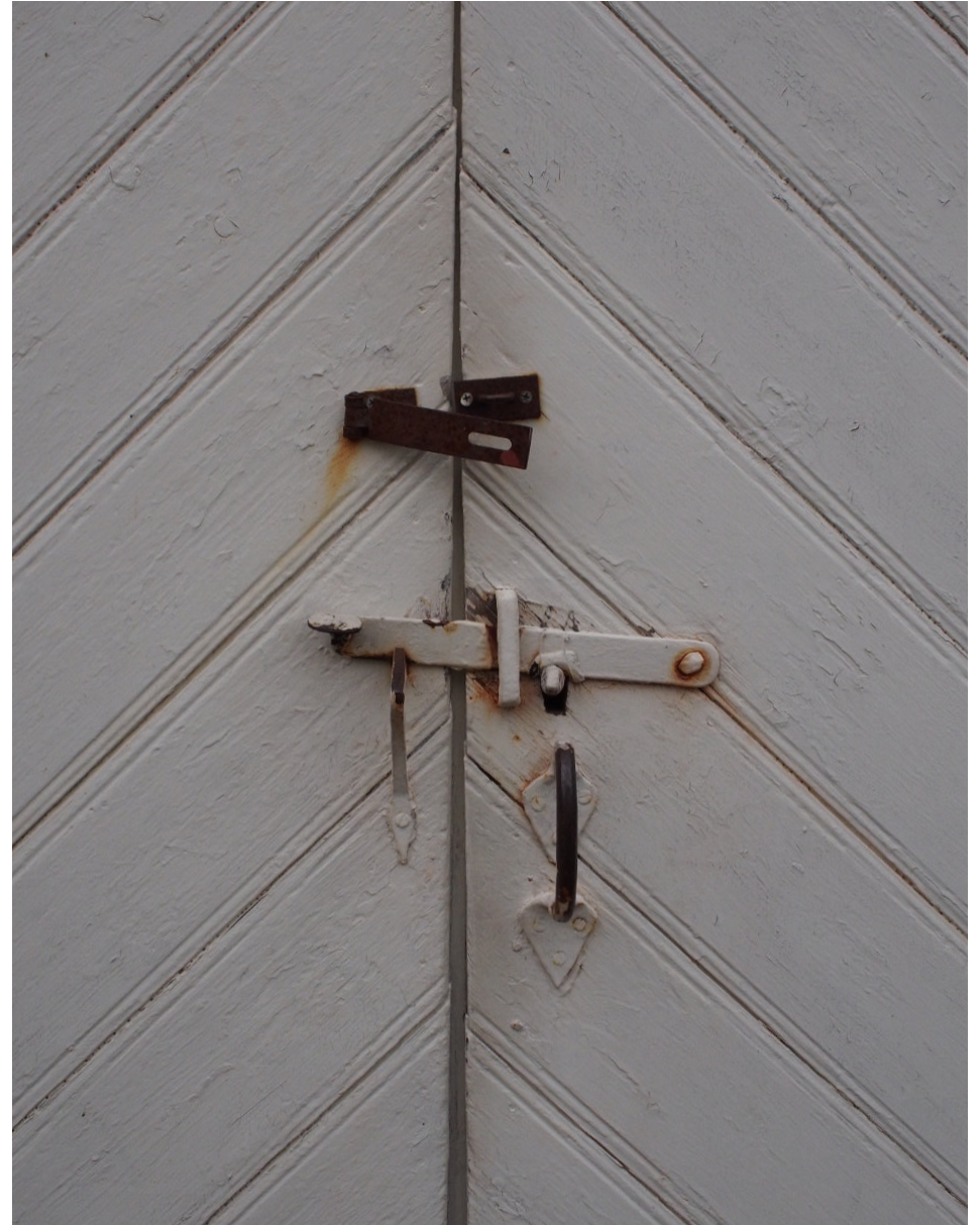
Kuva 45. Eteläjulkisivun keskimmäisten ovien salvat ja vetimet.
