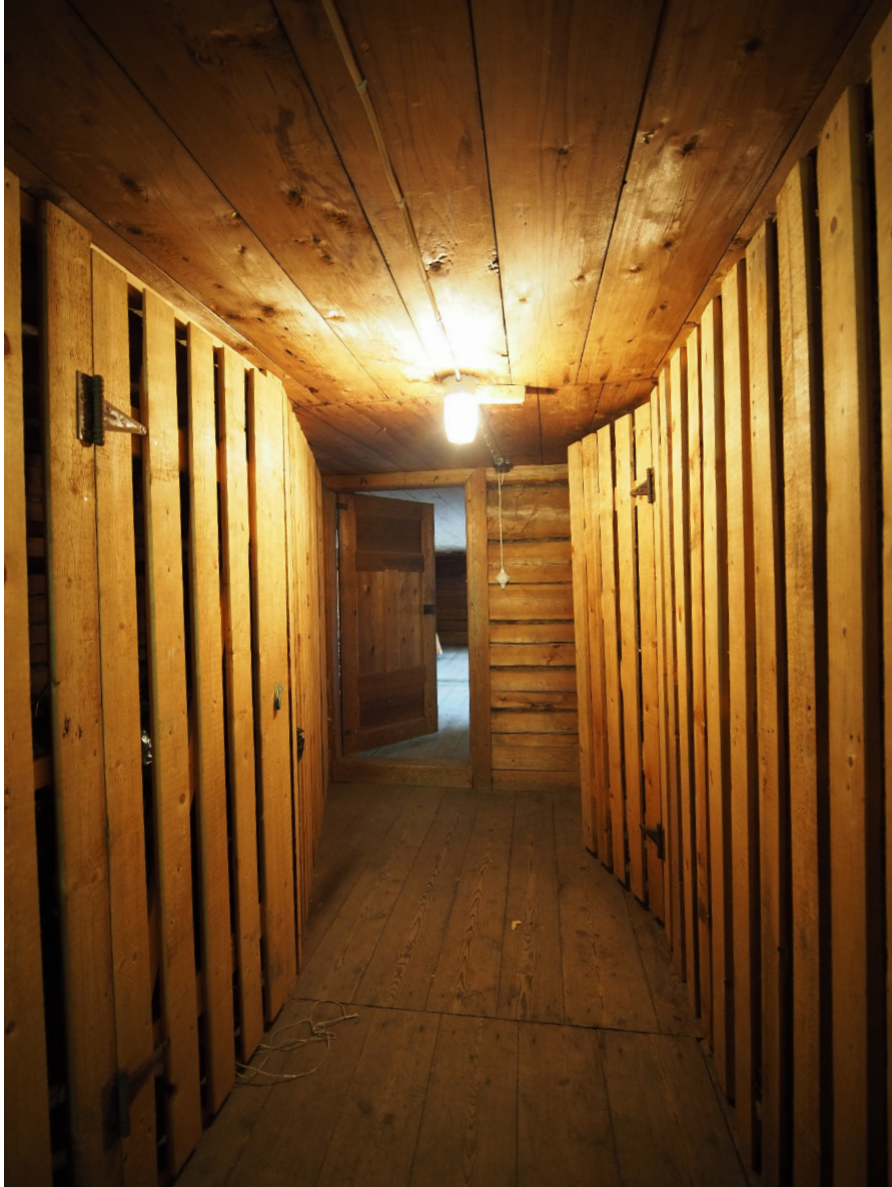
Kuva 93. Ullakon pohjoispäädyssä on lautaseinäiset varastot.
