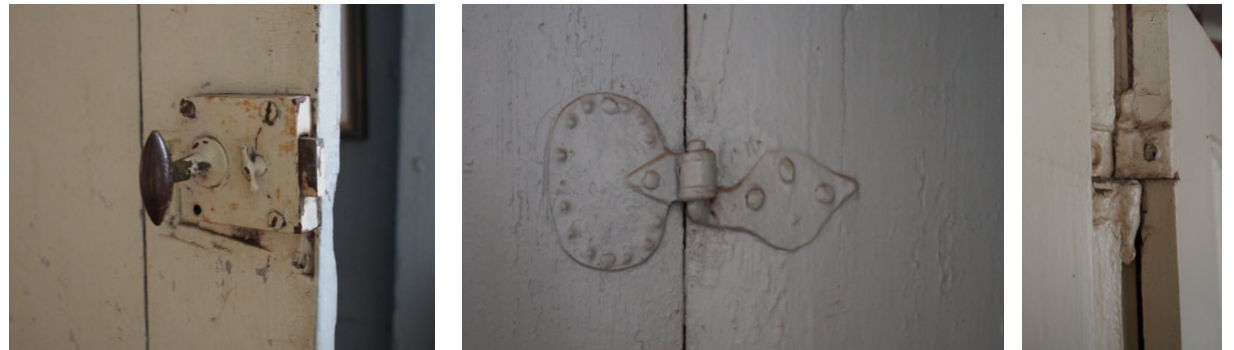
Kuva 49a-c. Rakennuksen vetimissä ja heloissa on kerrostumia 1800-luvulta 1900-luvulle.
