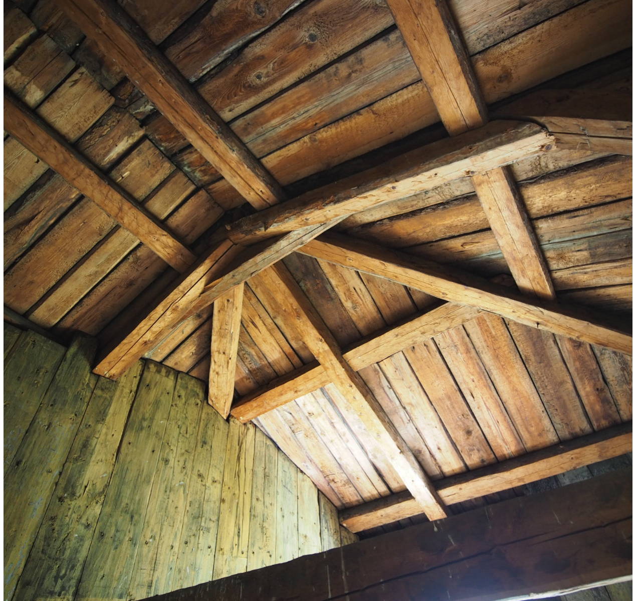
Kuva 36. Vesikattorakenne eteläpäädyssä. Rakenteessa ei ole keskeistä kurkihirttä. Liitokset puutapein.
