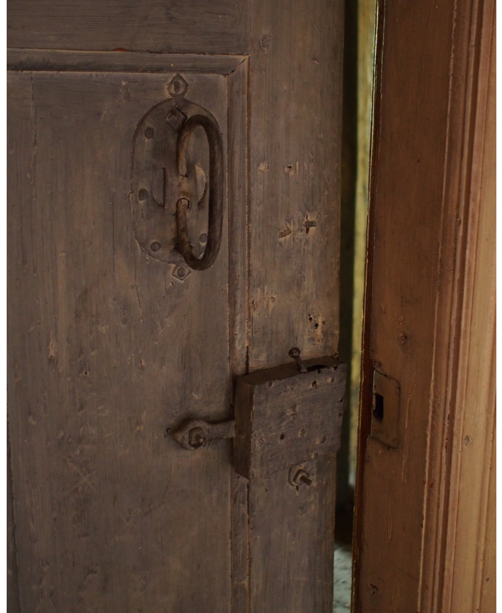
Kuva 51. Ullakon tupaan johtavassa ovesa on 1800-luvun vetimiä ja lukkopesä.
