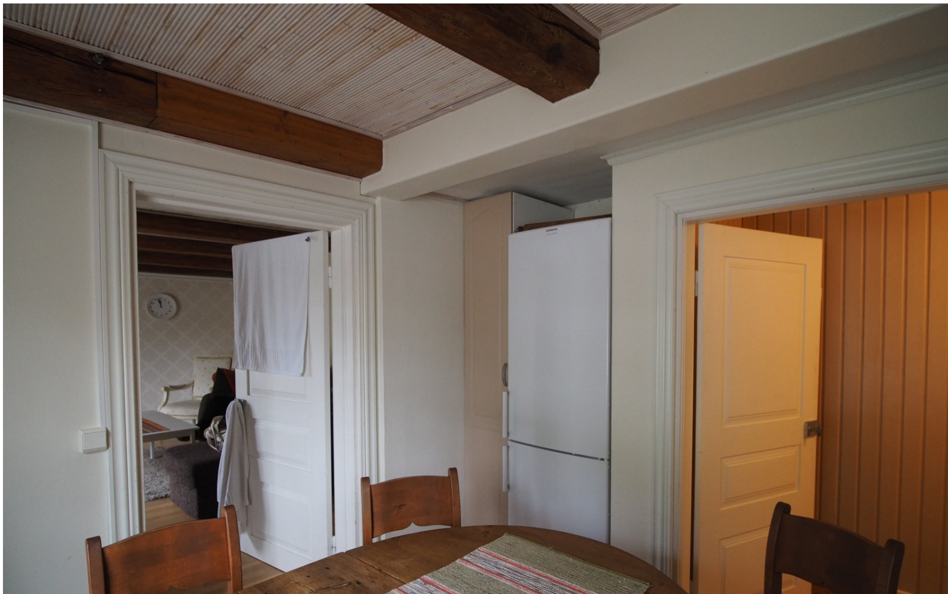
Kuva 75. Keittiön alakatossa aikaisemman seinän sijainti näkyy poikittaisen alakattovasan muodossa. Alakattoverhous purettiin 2010-2013 ja verhous muutettiin sormipaneeli.
