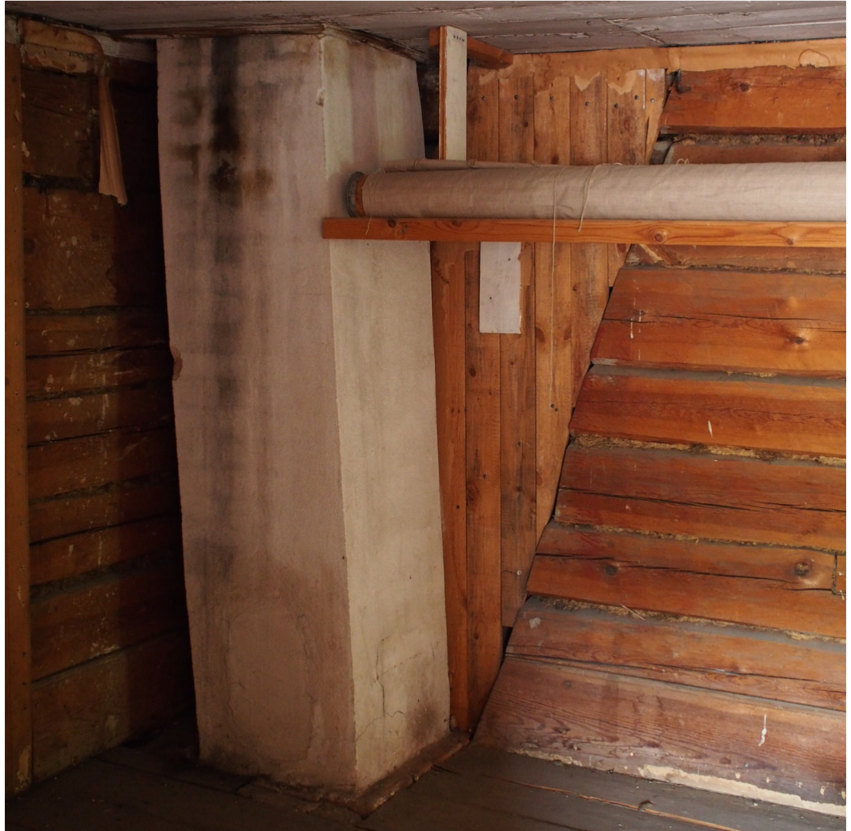
Kuva 39. Ullakolla hirsiseinässä on selkeä kerrostuma, joka liittyy mahdollisesti purettuun piippuun.
