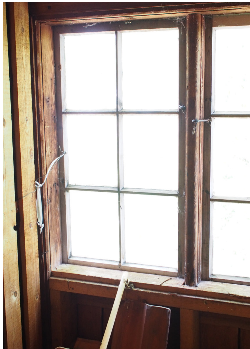
Kuva 62. Ullakon ikkuna pohjoiseen. Ikkuna on auki kuvassa 18 (sivu 26)
