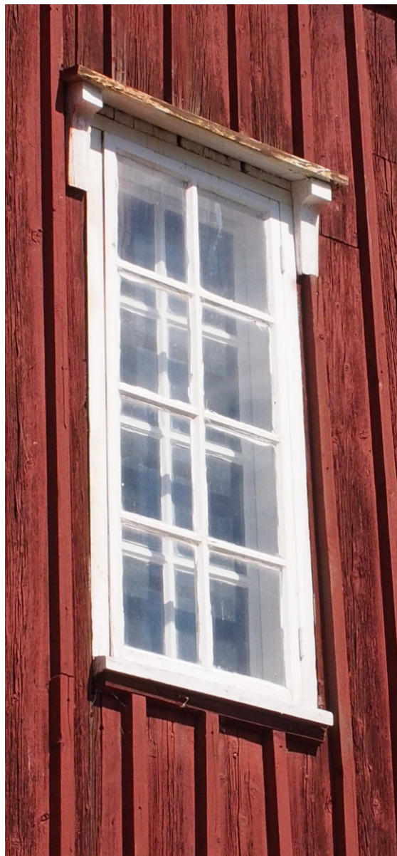
Kuva 60. Eteläpäädyn itäisempi ikkuna.
