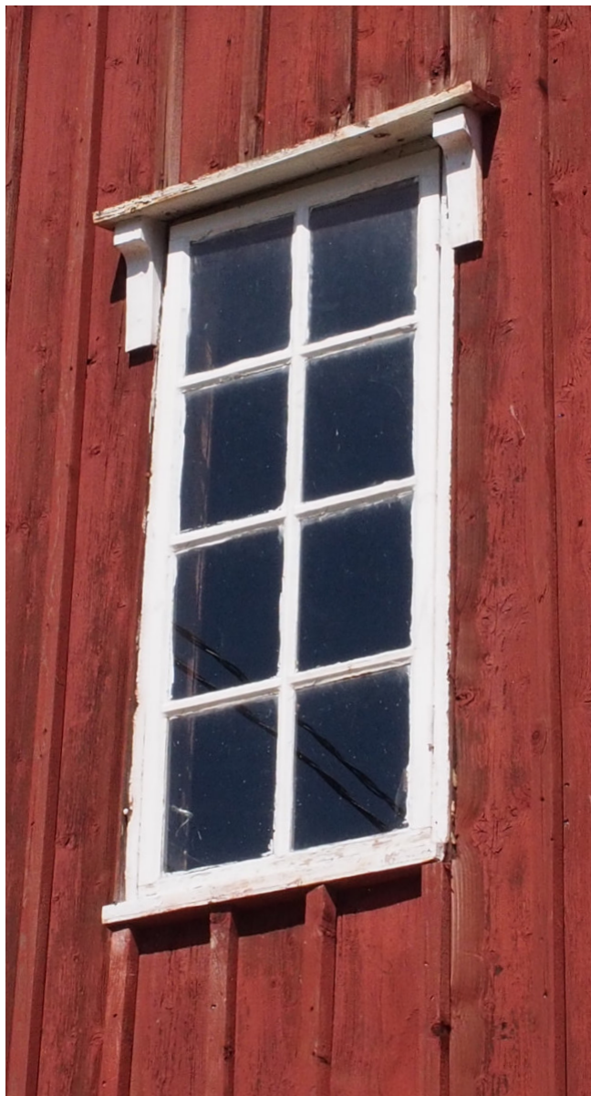
Kuva 59. Eteläpäädyn läntisempi ikkuna.
