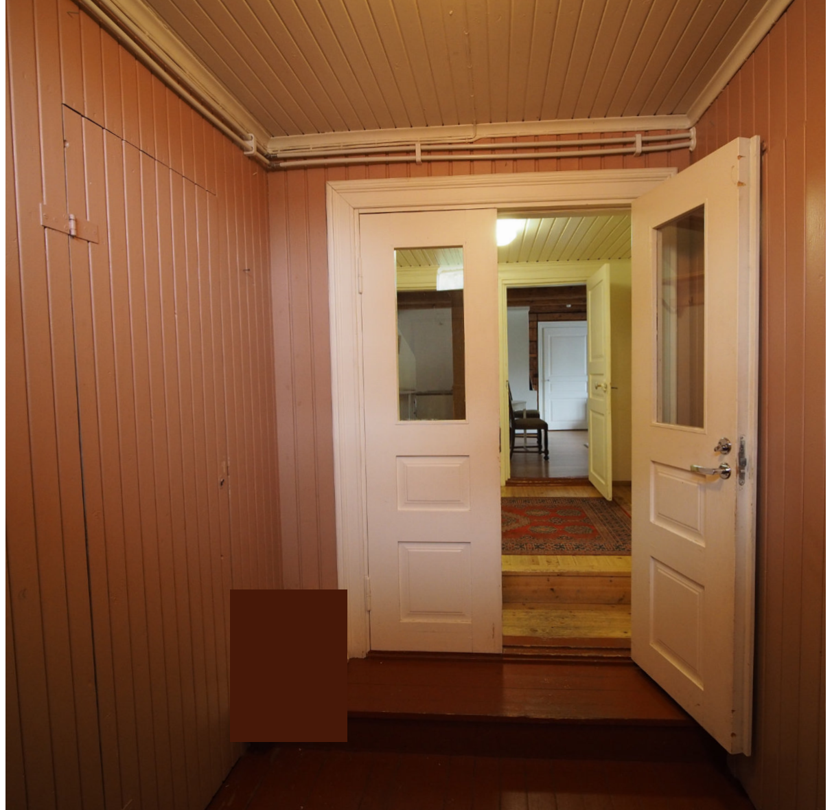
Kuva 53. Eteläpäädyssä entiseen leipomoon johtavaan asuntoon on lisätty uudet kaksoisvet vuonna 1985.
