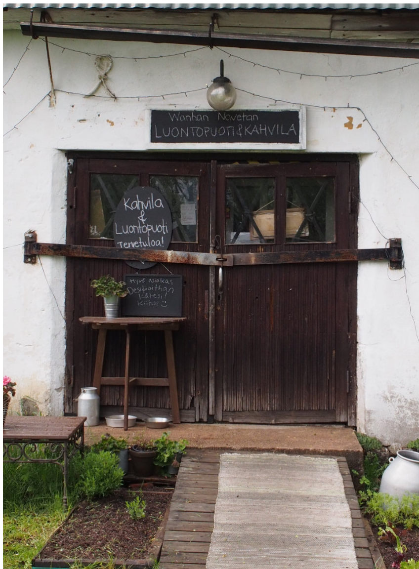
Kuva 51, Eteläjulkisivulla, entinen puusepänverstaan ovi. Oviaukko on tehty 1800-1900-luvun vaihteessa. Alkuperäisessä ovessa ei ole ollut ikkunoita tai sormipanelointia. Tämä ovi on mahdollisesti 1950-luvun tienoilta. Oven sisäpuolelle tehdyt x:n muotoiset rautakaltrit ovat mahdollisesti lisäys mahdollisesti 2000-luvun puolella.
