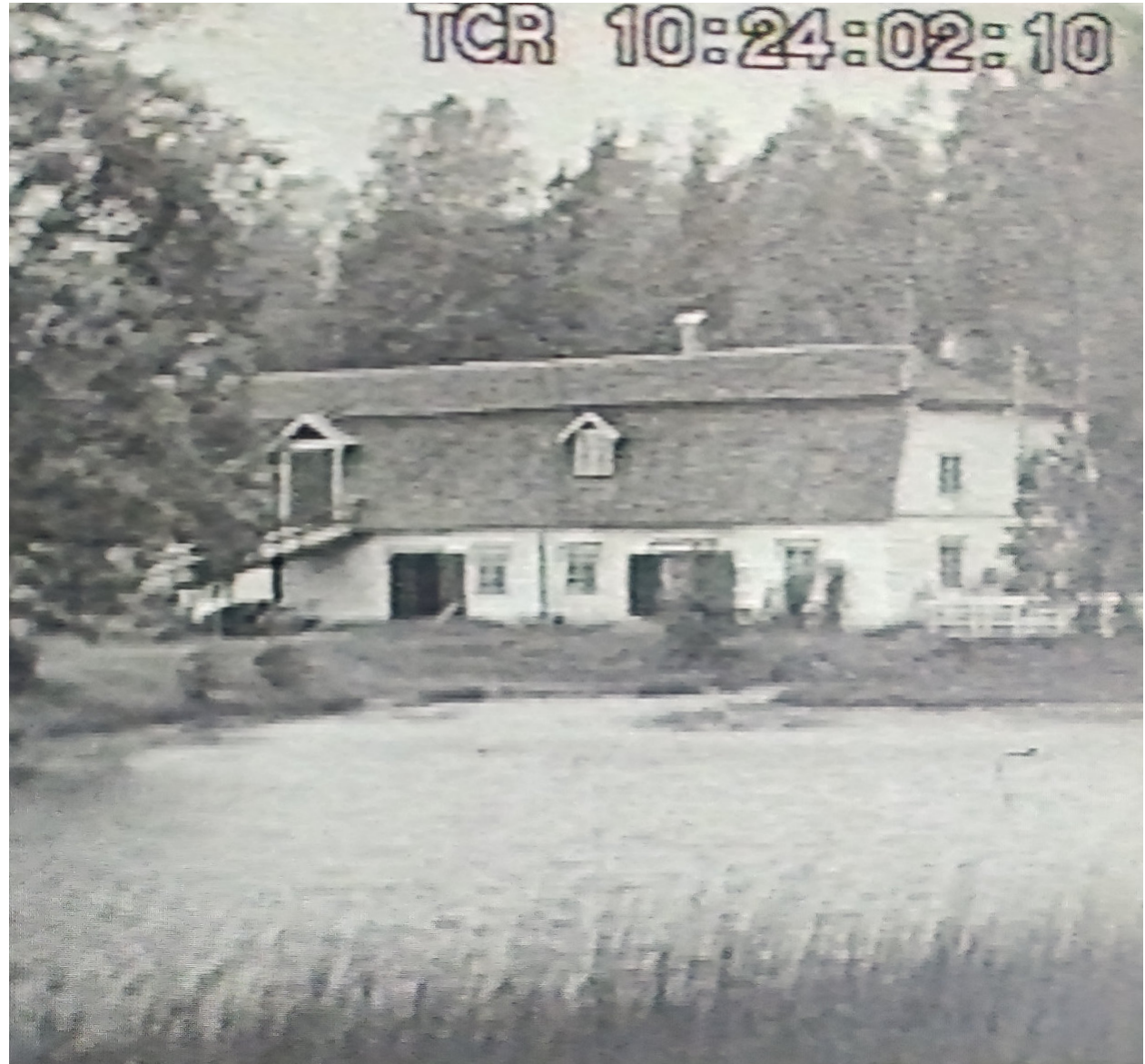
Kuva 21, Ote vuonna 1939 kuvatusta Trifonoffin dokumenttielokuvasta. Navetan aukotus on kuten tänä päivänä. Katto on vaikuttaisi olevan päreistä. Puusepänverstaan kohdalta kohoaa piippu, jota ei vuonna 2021 enää ole.
