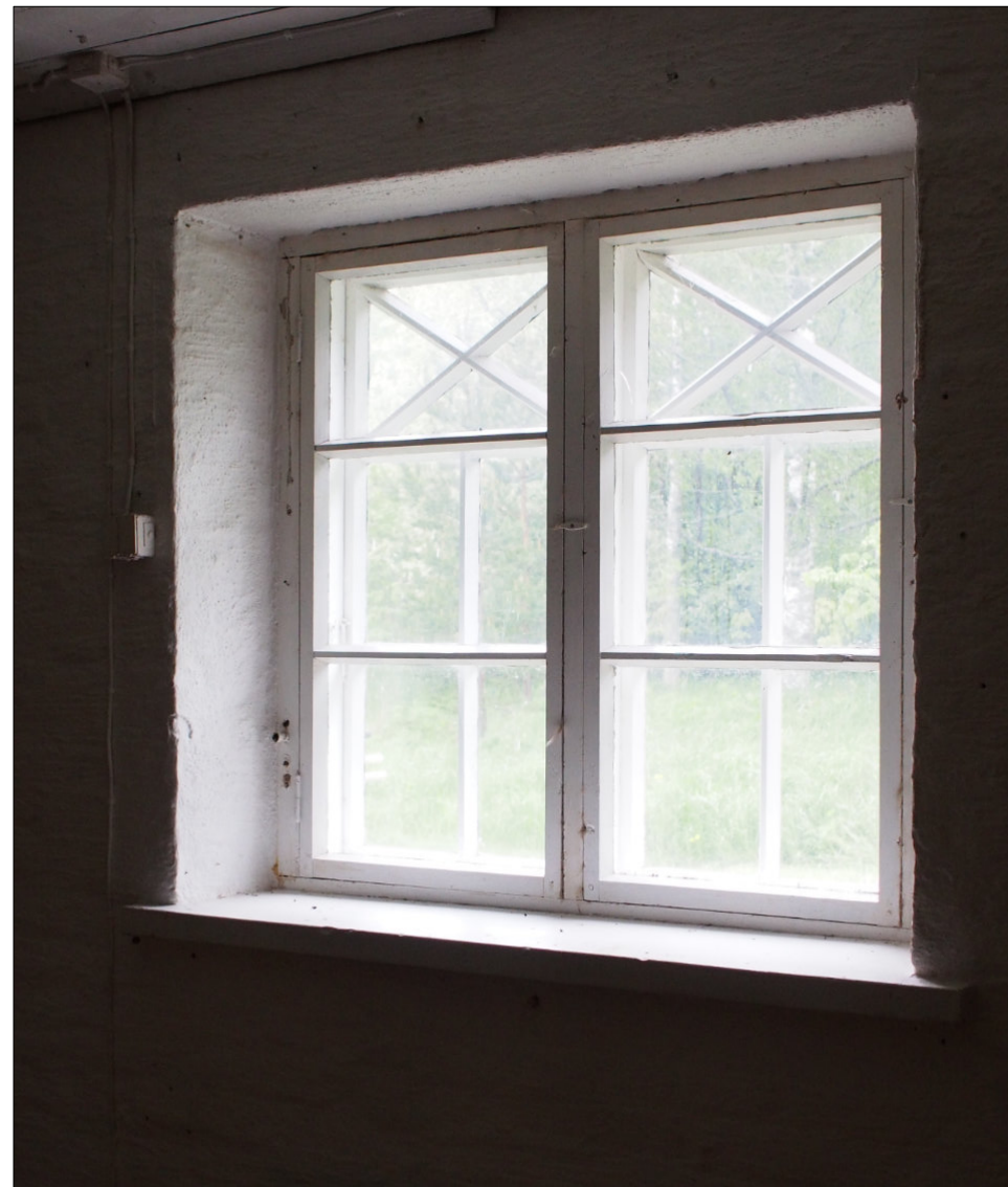
Kuva 67, Pohjoisjulkisivu, läntisin ikkuna, siirretty tälle paikalle 1950-60-luvulla. Ulkoa päin ikkuna on hyvin samanlainen kuin muut, mutta sisällä on kolmijakoiset puitteet. Mahdollisesti alkuperäisen ikkunan sisäpuitteet eivät olleet ehjät ja ne korvattiin näillä.
