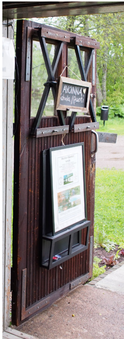
Kuva 51, Eteläjulkisivulla, entinen puusepänverstaan ovi. Oviaukko on tehty 1800-1900-luvun vaihteessa. Alkuperäisessä ovessa ei ole ollut ikkunoita tai sormipanelointia. Tämä ovi on mahdollisesti 1950-luvun tienoilta. Oven sisäpuolelle tehdyt x:n muotoiset rautakaltrit ovat mahdollisesti lisäys mahdollisesti 2000-luvun puolella.
