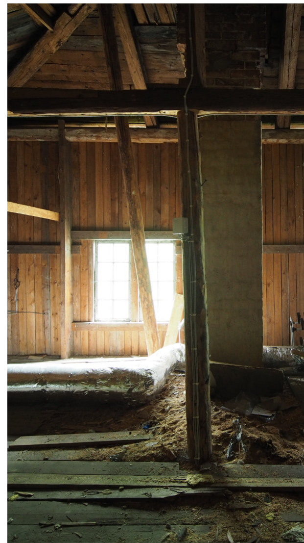
Kuva 41, Heinäullakon lautarakenteinen itäpäätty.
