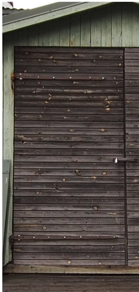
Kuva 53, Ullakon ovi on uusittu vuonna 2000 vanhan oven saranoihin sen aiempaa kokoa noudatellen. Oven vaakaponttilauta on samaa leveyttä, kuin maantasokerroksen itäisen vajan ovissa ja myös runko on ratkaistu samalla tavalla.
