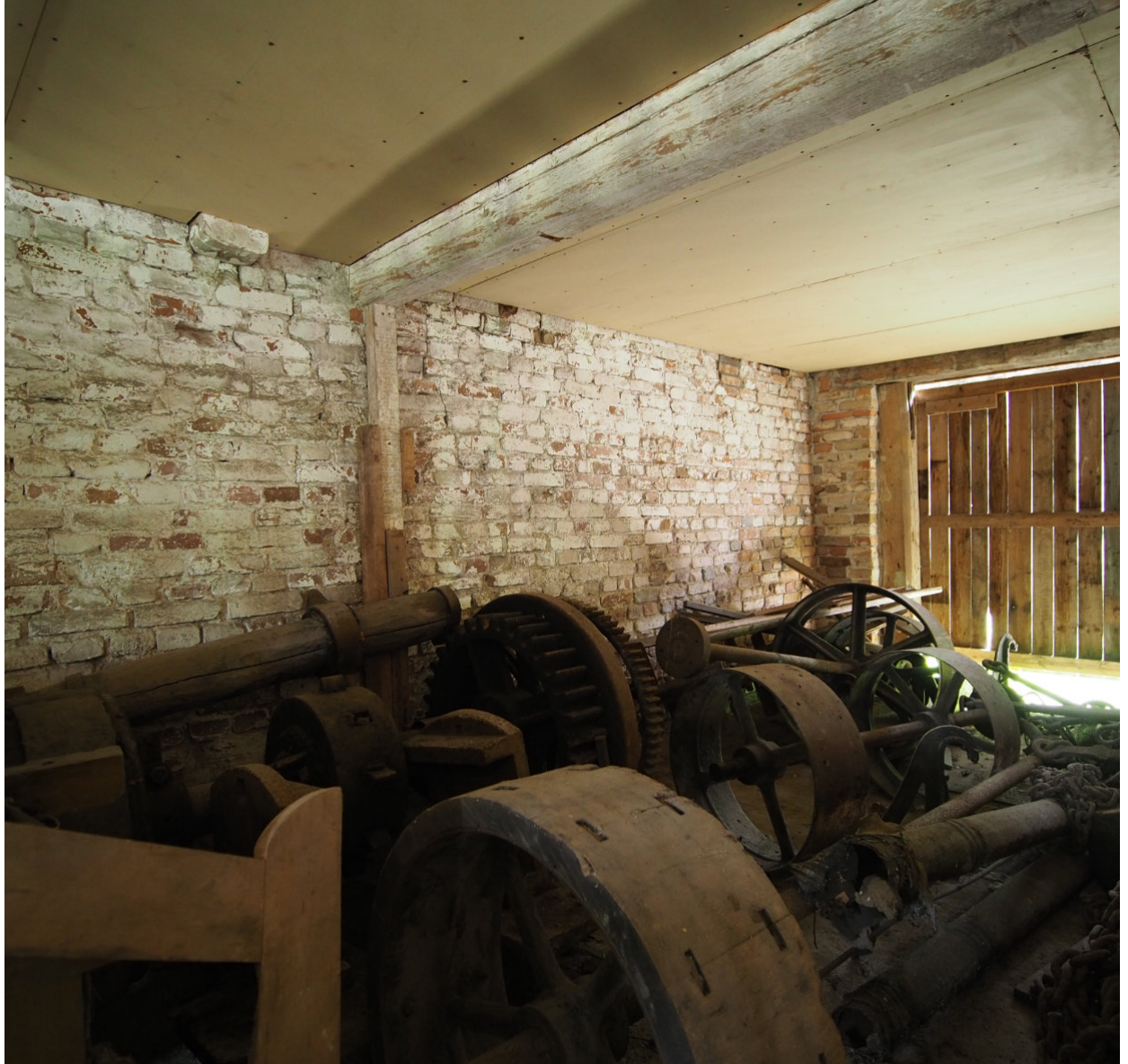
Kuva 75. Vajan ja myymälän (ent. talli) välinen seinä. Muuraus on ristilimitystä kuten vanhimmissa seinissä, mutta tutkimuksen mukaan sen rakentaminen ajoittuu 1800-1900-luvun taitteeseen.
