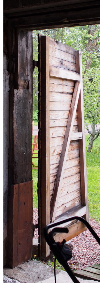
Kuva 48, Toiseksi vanhimpana ovena pidetään eteläfasadin kaksoisovea, joka johtaa itäiseen vajaan. Se on ulkoa verhoiltu vaakasuuntaisella ponttilaudalla, mutta siitä puuttuu pystysuuntainen lautaranka. Kokonaisuus on kasassa lautaoven tavoin sovelletulla pienarangalla. Puumateriaali vaikuttaa uudemmalta ja ponttilauta kapeammalta. Myös saranoissa on eroja ja ne vaikuttavat olevan kahden eri sepän tekemät. Kuvassa yläoikea sarana on samanlainen kuin läntisen vajan oven saranat. Muut edustavat sulakampaa tyyliä, mitä on nähtävillä mm. Letkumakasiinin ovissa. Sisäovesta on jäänteinä ruostuneet saranatapid. Ovenpieltä on korjattu uudella puuosalla.
