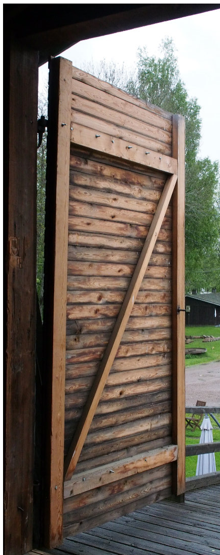
Kuva 53, Ullakon ovi on uusittu vuonna 2000 vanhan oven saranoihin sen aiempaa kokoa noudatellen. Oven vaakaponttilauta on samaa leveyttä, kuin maantasokerroksen itäisen vajan ovissa ja myös runko on ratkaistu samalla tavalla.
