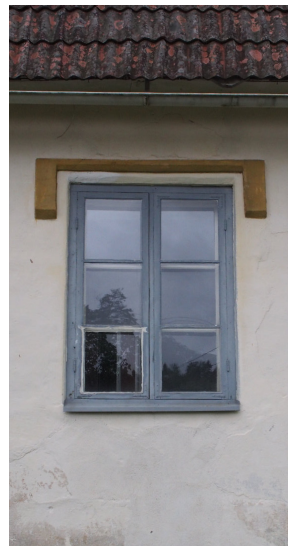
Kuva 57, Krouvinmäen savitalon ikkunaa kehystää koristeaihe, joka muistuttaa Navetan ikkunoiden yllä olevan muodon jäänteitä. Ikkuna on kuusiruutuinen, kuten Navetan ikkunat ovat saattaneet olla.
