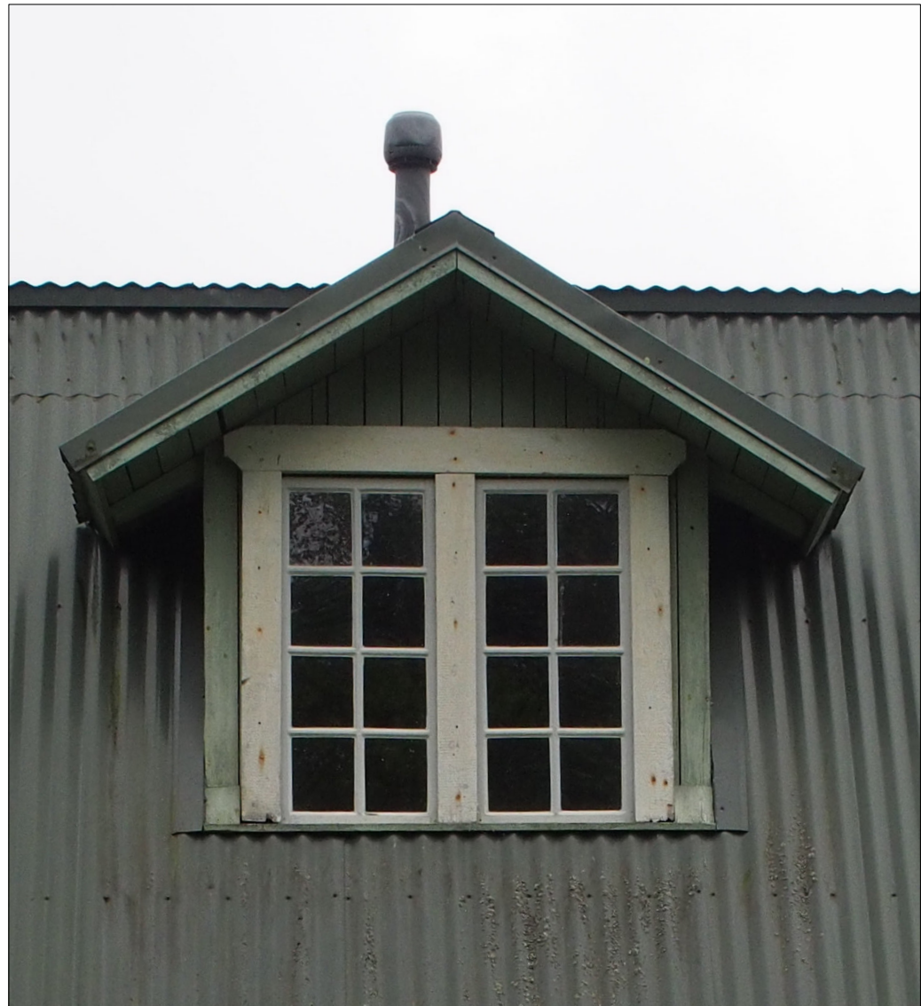
Kuva 61, Pohjoisjulkisivu, ullakon kattoikkuna. Ikkuna on puitejaoltaan ja tyyliltään hyvin samankaltainen kuin ullakon päätyikkunat. Vihreä väri on todennäköisesti peräisin vuoden 2000 kattokunnostuksesta.
