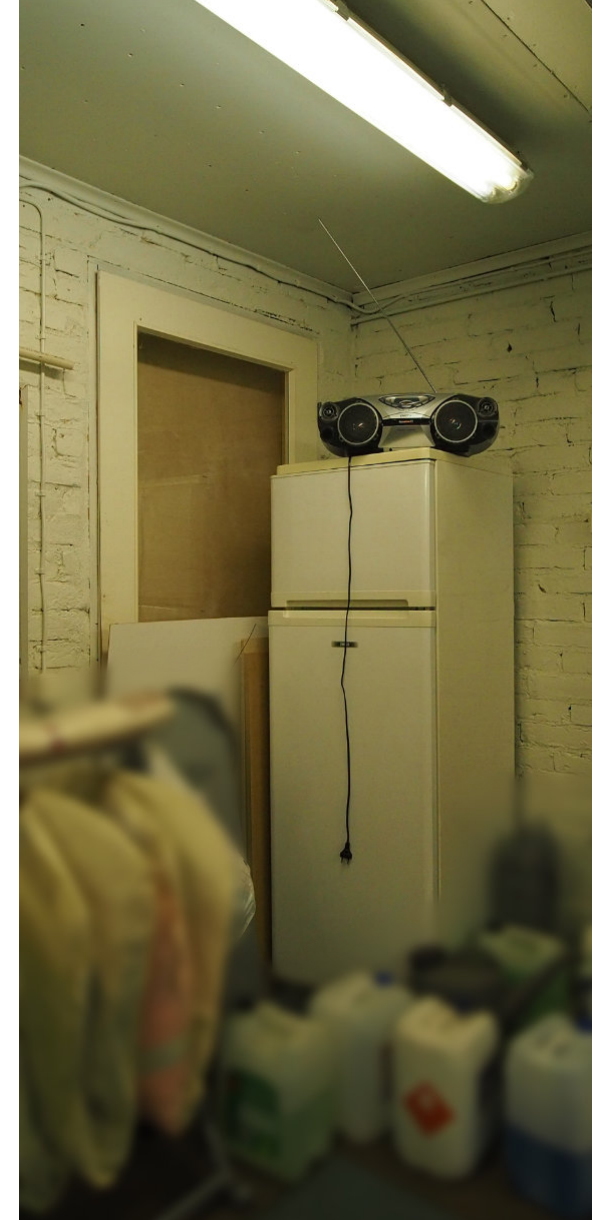
Kuva 72, Käytöstä poistettu ovi keittotilaan.
