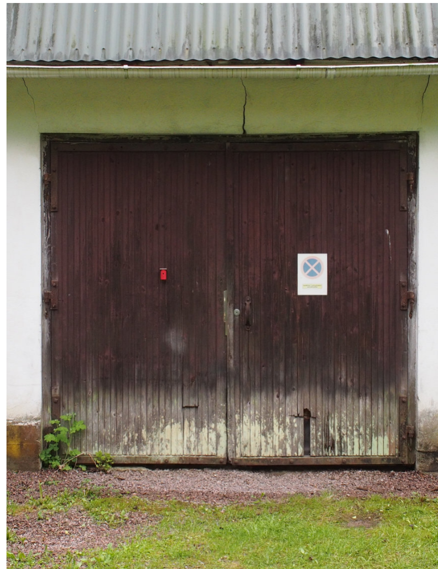
Kuva 54, Pohjoisjulkisivun entisen traktoritallin ovi on kaksoisovi, joka on verhottu pystysuuntaisella sormipanelilla. Ovi on lisätty 1960-luvulla.
