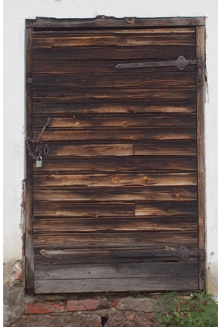
Kuva 47, Läntiseen vajaan, entiseen läävään johtanut ovi. Ovi on oletettavasti rakennuksen vanhin. Sillä on lautaovimainen runko pystysuuntaisella lautarangalla, joka on koottu poikkipienoilla ja vinotuella. Ulkoa ovi on verhottu vaakasuuntaisella ponttilaudalla ja muotoillut takorautasarانات on jätetty näyttävästi oven ulkopuolelle. Sisäpuolella ovesa on jäljellä vanha lukkopesä, joka muistuttaa vakuutusasiakirjoissa kuvatun taittopuomilukon pesää. Sisäpuolella ovenpielessä on vielä jäljellä sisemmän oven saranatpit.
