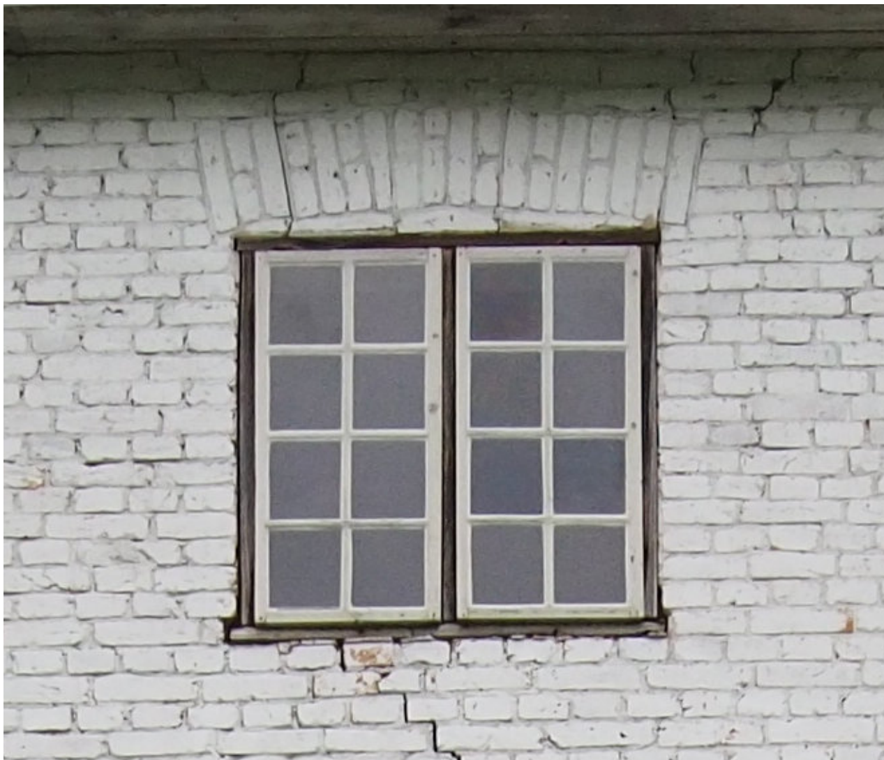
Kuva 58, Länsijulkisivun ullakon ikkuna. Ikkuna poikkeaa maantasokerroksen ikkunoista yksinkertaisuudellaan. Palovakuutusasiakirjojen mukaan ullakonkin ikkunat olivat kuuteen ruutuun jaettuja, mutta tämän ikkunan heloja ja rakennetta tarkastellessa voi olla, että ullakon ikkunat olivat kahdeksanjakoisia alunperinkin. Toisin kuin itäpäädyn puurungossa istuvilla ikkunoilla, länsipäädyn ikkunalla ei ole vuorilautoja.
