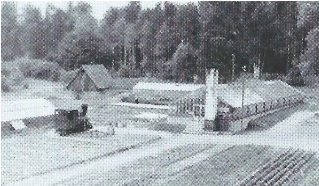
Kuva 9, Ruukin puutarha mahdollisesti Tallin vellikellosta kuvattuna 1960-luvun alussa. Keskellä 1940-41 rakennettu iso kasvihuone, taustalla kellari ja vanha kasvihuone. Etualalla vasemmalla lämmityslaitteena käytetty pässi.
