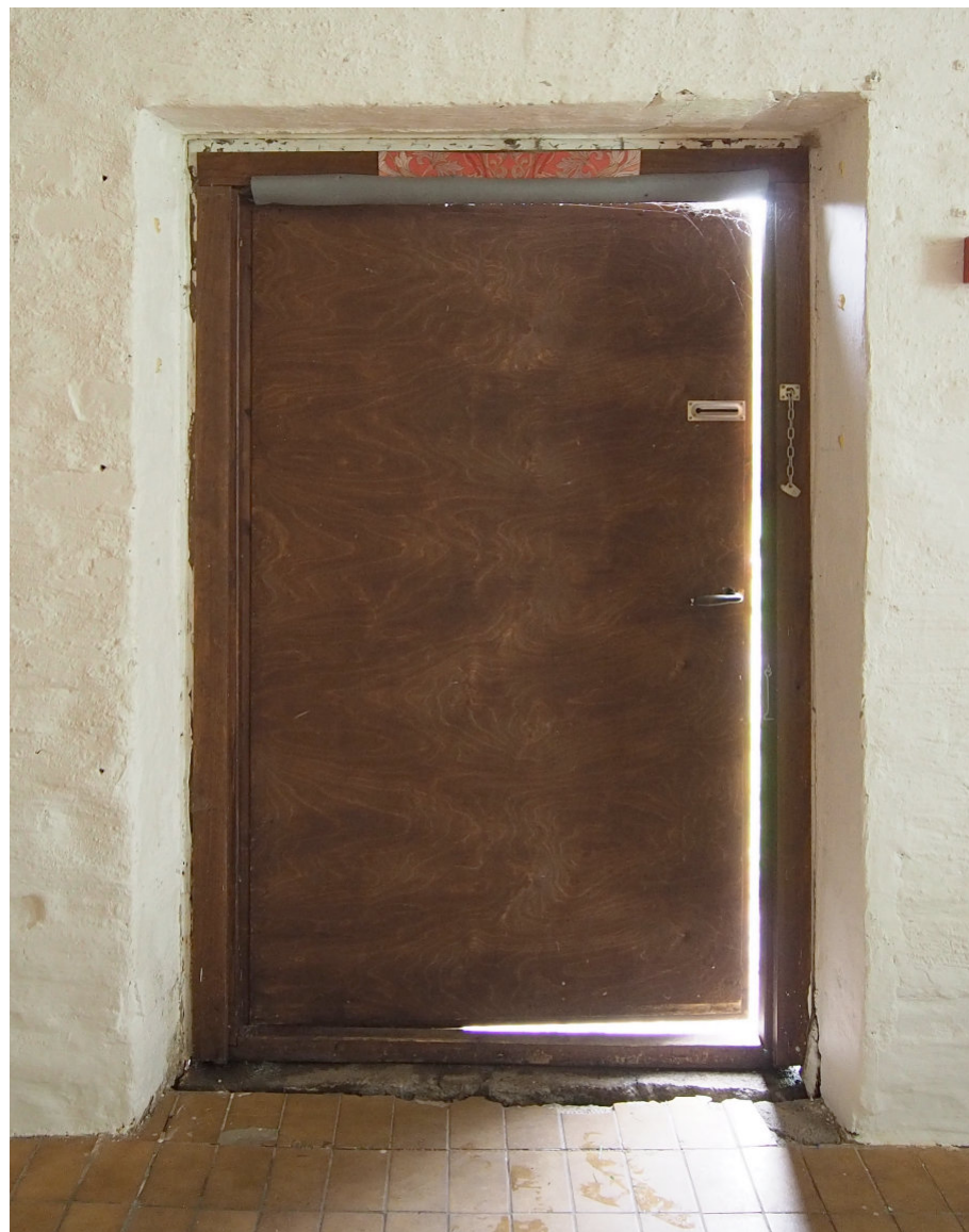
Kuva 50, Länsijulkisivun ulko-ovi on mahdollisesti siirretty pohjoisjulkisivulta. Mikäli se on siirretty, ovi saattaa olla osittain 1800-luvun alusta. Sen tarkkaa rakennetta ei päästy tarkastelemaan, mutta ulkoa ovi on verhottu muiden vanhojen ovien tapaan vaakaponttilaudalla. Sen sijaan sisällä on vaneri ja saranat sekä painikkeet ovat modernit.
