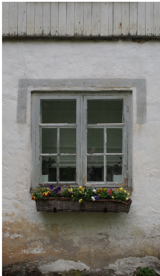
Kuva 56, Navetan itäpääty. Ikkunan koriste ei ole kolmiulotteinen vaan maalattu paikalleen. Maalin reunassa on keltaista väriä. Ikkuna on 1800-luvulta. Tässä ikkunassa ei ole kolmioaiheita ylimmissä ruuduissa.
