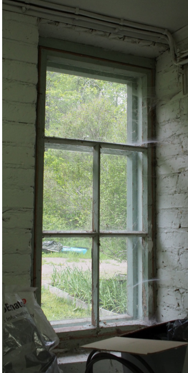
Kuva 71, Autotallin puoli seinän jakamasta ikkunasta.
