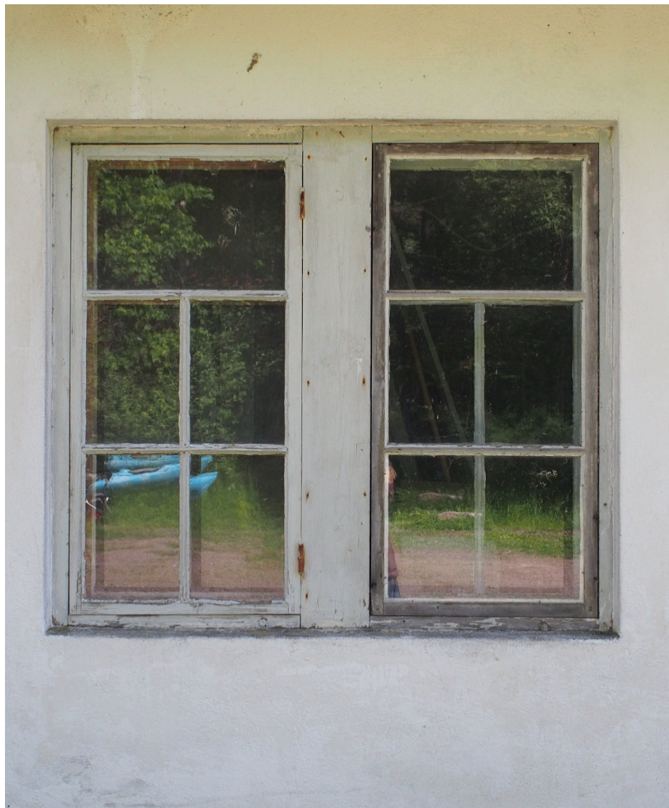
Kuva 66, Traktoritallin ja puusepänverstaan väliin jäänyt ikkuna-aukko. Muista ikkunoista poiketen itäpuolella on kolmiruutuinen puite ja sisäpuolella taas yleisempi viisiruutuinen puite (kuva s. 68). Länsipuoli on jäänyt sisältä eristekerroksen taakse.
