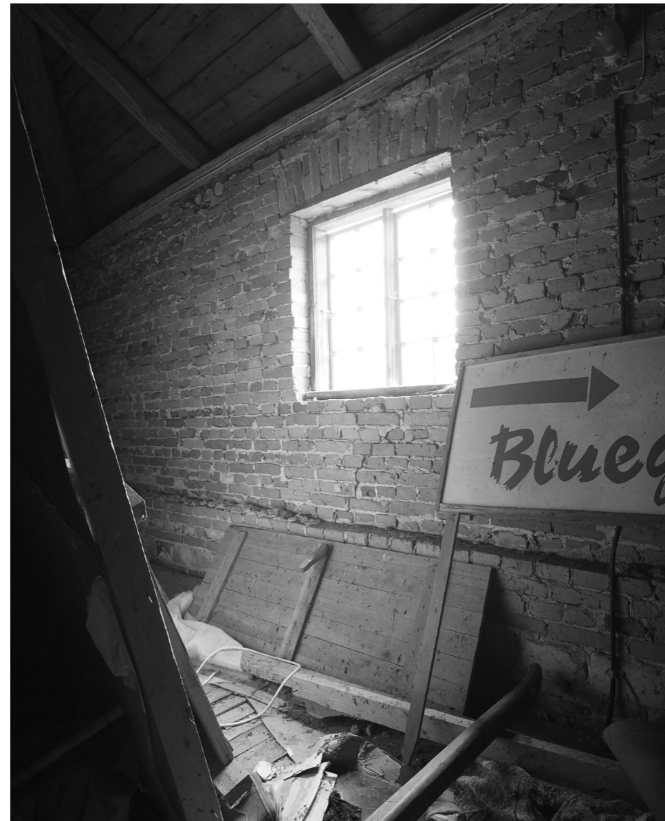
Kuva 45, Länsipäädyn tiilimuuraus ullakolla. Muurauksen paksuus vaihtuu noin metrin korkeudella lattiasta.
