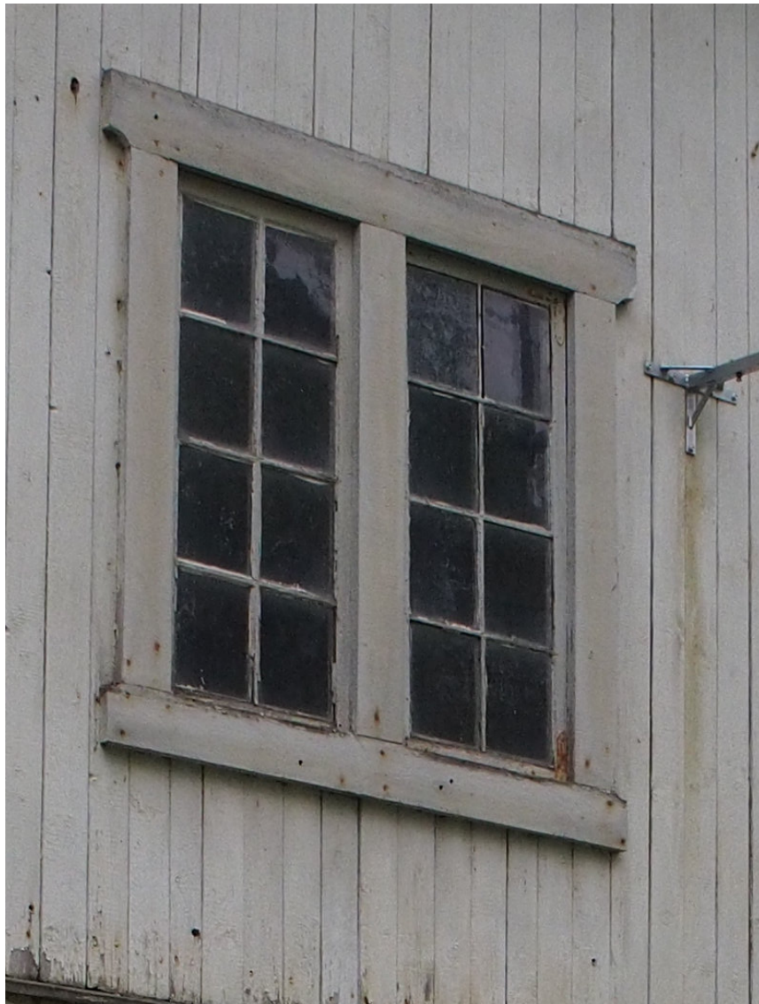
Kuva 60, Itäjulkisivun ullakon ikkuna on jaoltaan samanlainen kuin länsipäädyn, mutta sillä on vuorilaudat ja puitteet on koottu siroin kulmaraudoin. Puitteet on maalattu valkoiseksi.
