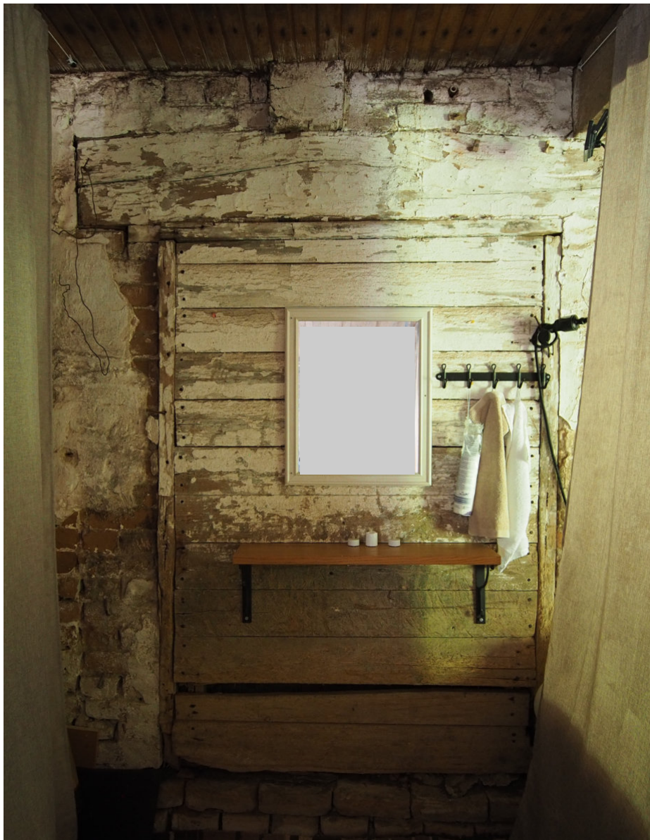
Kuva 44, Vanha oviaukko 1800-luvulta on tukittu 1900-luvun alussa.
