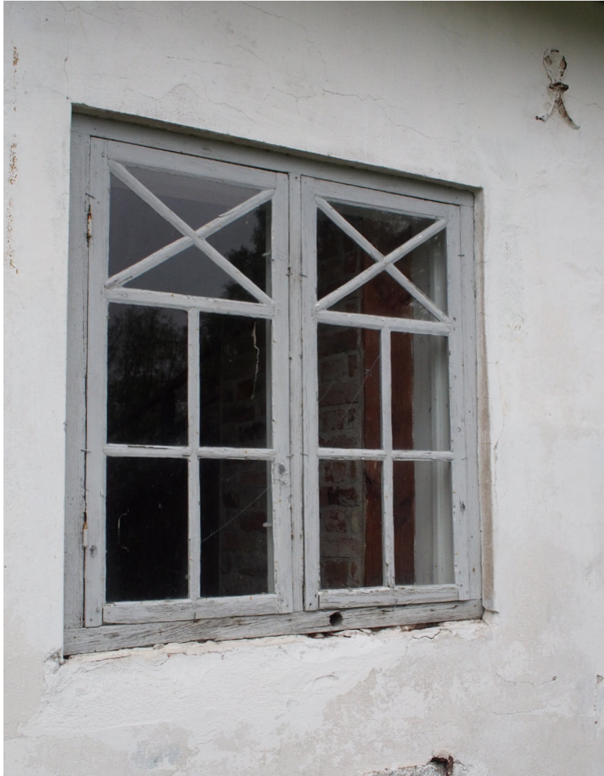
Kuva 62, Eteläjulkisivu, läntisen vajan itäinen ikkuna. Tässä ikkunassa ei ole sisäpuitteita. Ikkunan ylimmät ruudut on jaettu vertikaalisin jakopuittein kolmioiksi ja koko puite on koottu puunauloin. Läntisessä puitteessa on saranat.
