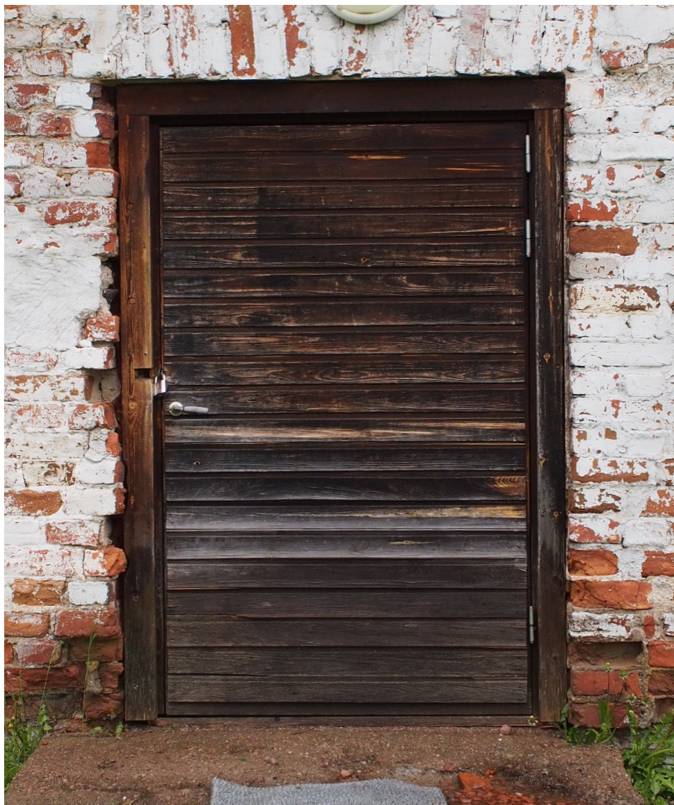
Kuva 50, Länsijulkisivun ulko-ovi on mahdollisesti siirretty pohjoisjulkisivulta. Mikäli se on siirretty, ovi saattaa olla osittain 1800-luvun alusta. Sen tarkkaa rakennetta ei päästy tarkastelemaan, mutta ulkoa ovi on verhottu muiden vanhojen ovien tapaan vaakaponttilaudalla. Sen sijaan sisällä on vaneri ja saranat sekä painikkeet ovat modernit.
