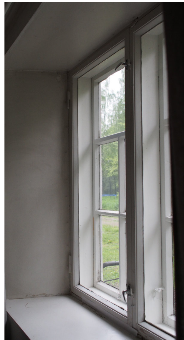
Kuva 65, Kolmiosaisen ikkunan sisäpuitteet ovat yksiruutuiset ja mahdollisesti 1970-luvun kunnostuksesta.
