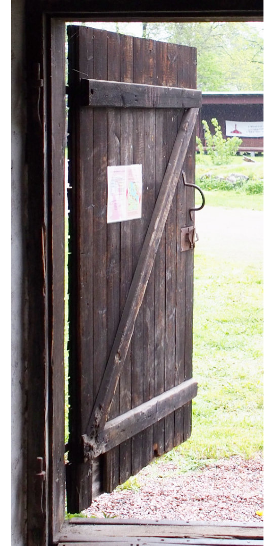
Kuva 47, Läntiseen vajaan, entiseen läävään johtanut ovi. Ovi on oletettavasti rakennuksen vanhin. Sillä on lautaovimainen runko pystysuuntaisella lautarangalla, joka on koottu poikkipienoilla ja vinotuella. Ulkoa ovi on verhottu vaakasuuntaisella ponttilaudalla ja muotoillut takorautasarانات on jätetty näyttävästi oven ulkopuolelle. Sisäpuolella ovesa on jäljellä vanha lukkopesä, joka muistuttaa vakuutusasiakirjoissa kuvatun taittopuomilukon pesää. Sisäpuolella ovenpielessä on vielä jäljellä sisemmän oven saranatpit.
