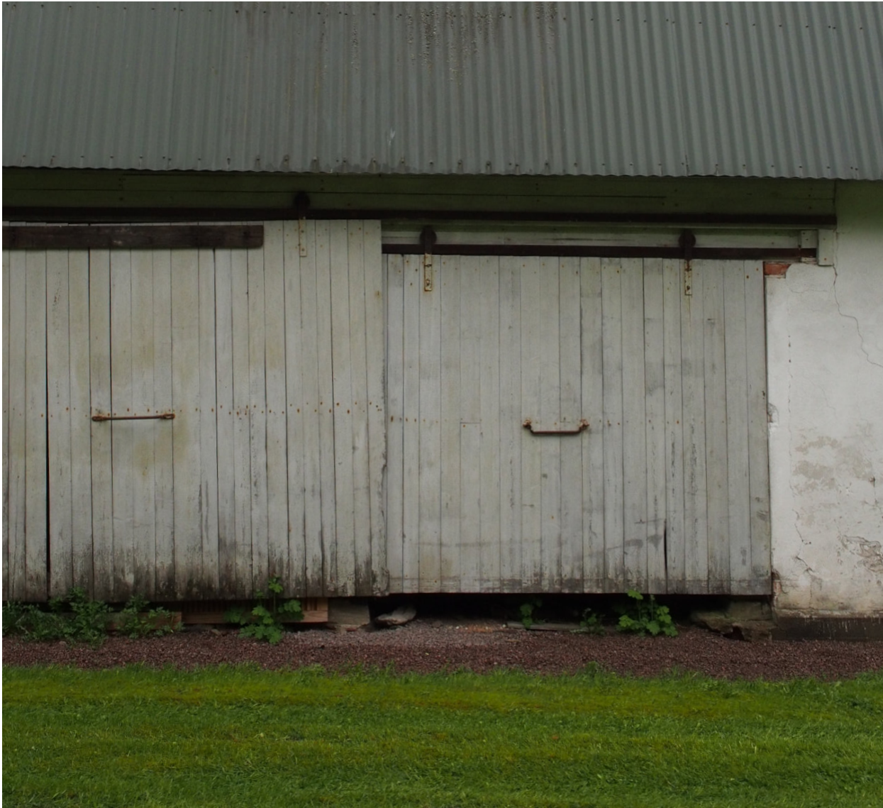
Kuva 55, Osa pohjoisjulkisivun liukuovista. Pystysuuntaisesta laudat on sidottu yhteen yksinkertaisin pienamaisin ottein. Ovien kiskot on tuettu seinämuuriin molemmista päistä. Nykytilassa ovet liikkuvat enää heikosti ja ovat enemmän osa staattista julkisivua. Ovet on lisätty 1950-luvulla.
