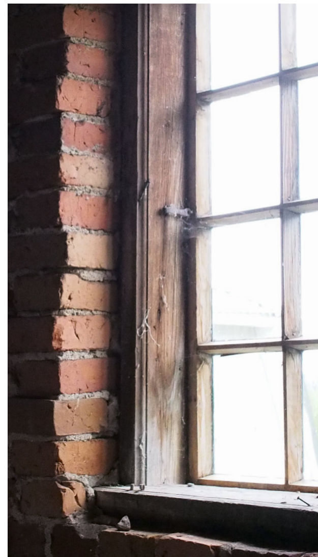
Kuva 59, Ullakon ikkunankin yksityiskohtiin on kiinnitetty huomiota. Ikkunan pieni hela on muotoiltu täysin eri tavalla, kuin muiden ikkunoiden, mikä voisi viitata sen vanhempaan ikään.
