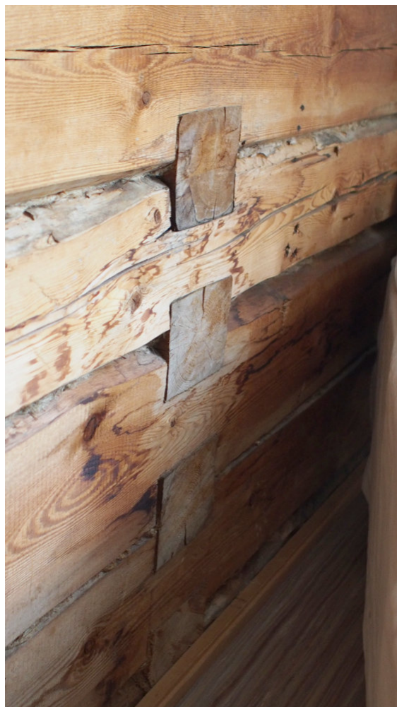
Kuva 50, Seinässä näkyy itä-länsisuuntaisen matalamman ulkoseinärakenteen hirsien päät. Eristeenä vaikuttaisi olevan jonkinlaista rivettä.
