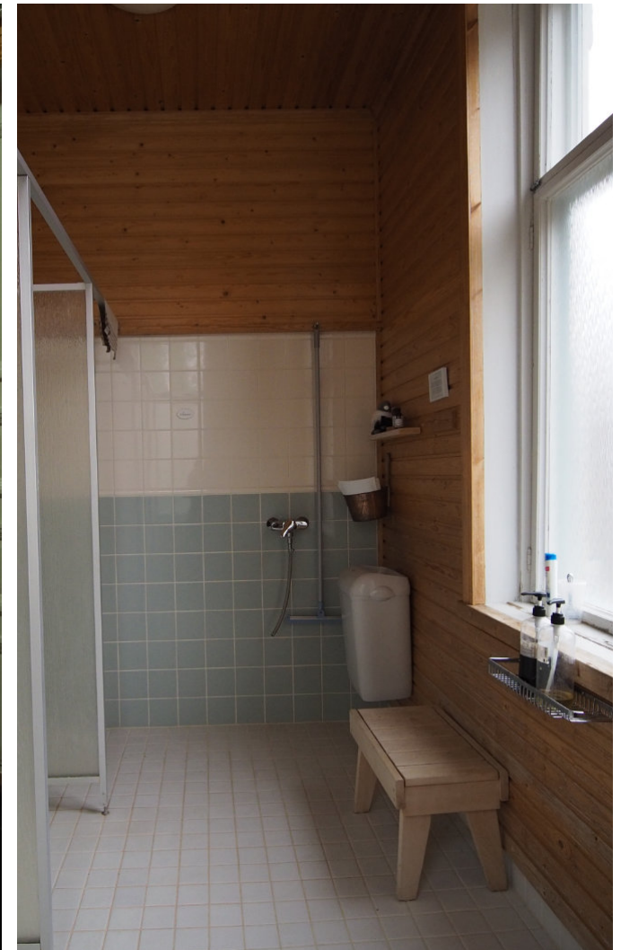
Kuva 85. Näkymä suihkutiloista kohti länttä. Vanhojen rakenteiden päälle tullut lisäkerros erottuu ikkunan kohdalla.
