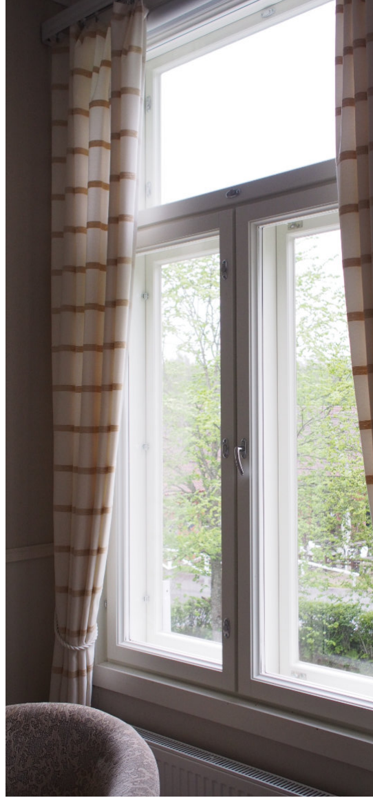
Kuva 60. Eteläjulkisivu, 2010-luvulla lisätty uusi ikkuna.
