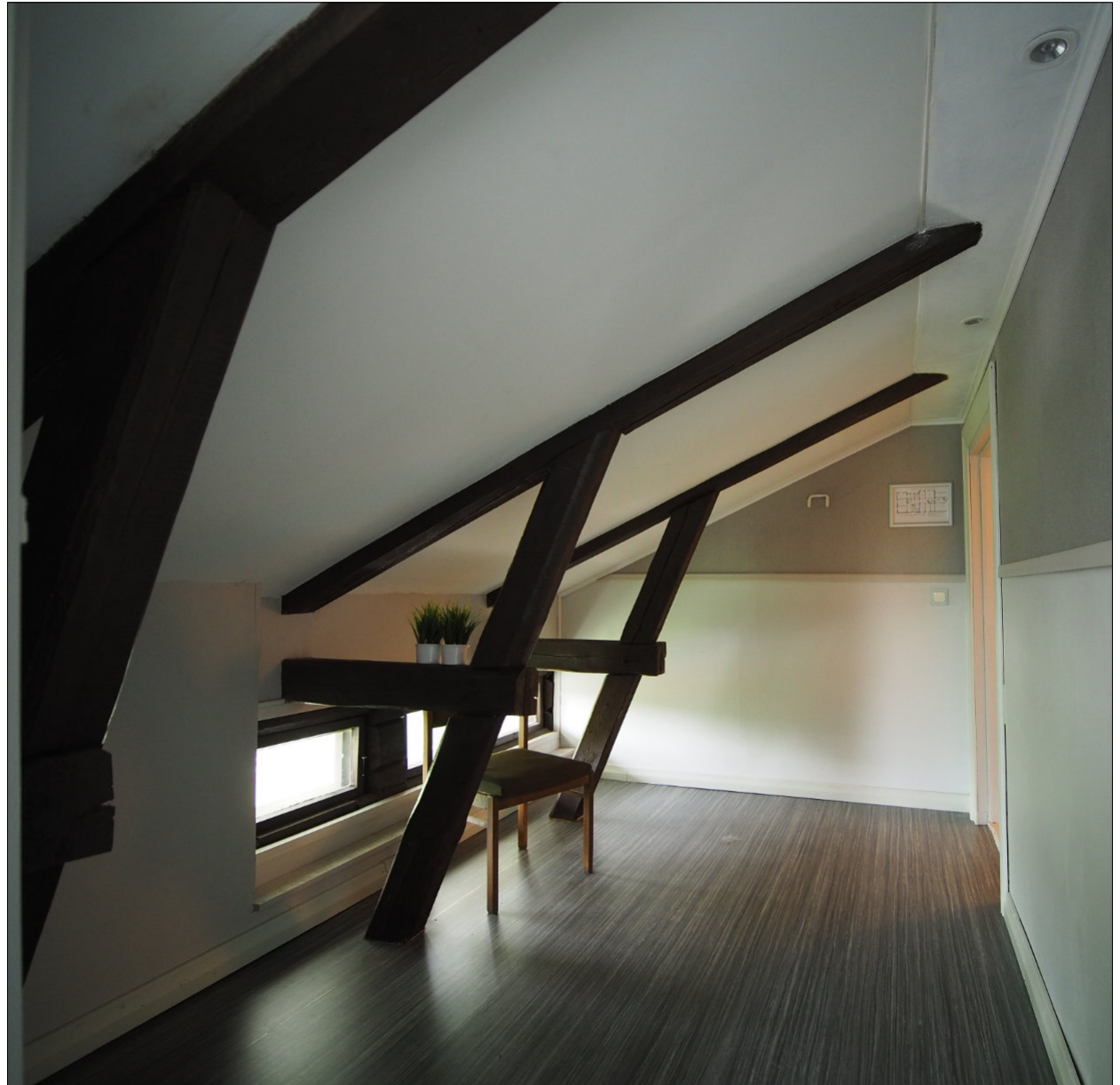
Kuva 101. Majoitushuoneen etuhuoneeksi muutettu osa kylmää ullakkoa tuo osan kattotuoleista näkyville.
