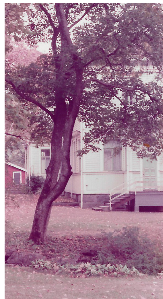
Kuva 26. Kuva Yläpajan poistovesirännin länsipuolelta kohti itää. Verannan ovi on vihreä.
