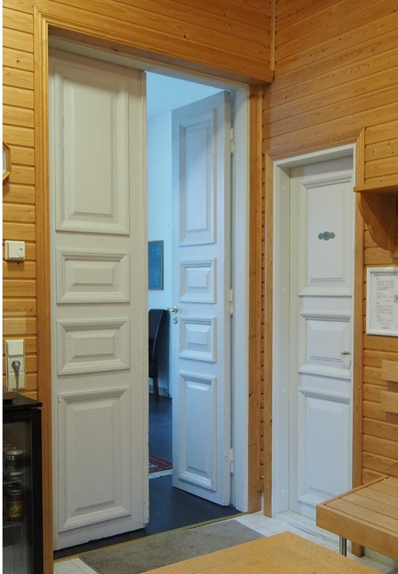
Kuva 68. Kaksiosainen korkea ovi kaakon kulmasaliin sekä tavallisen korkuinen yksilehtinen ovi pukeutumistilojen vessaan.
