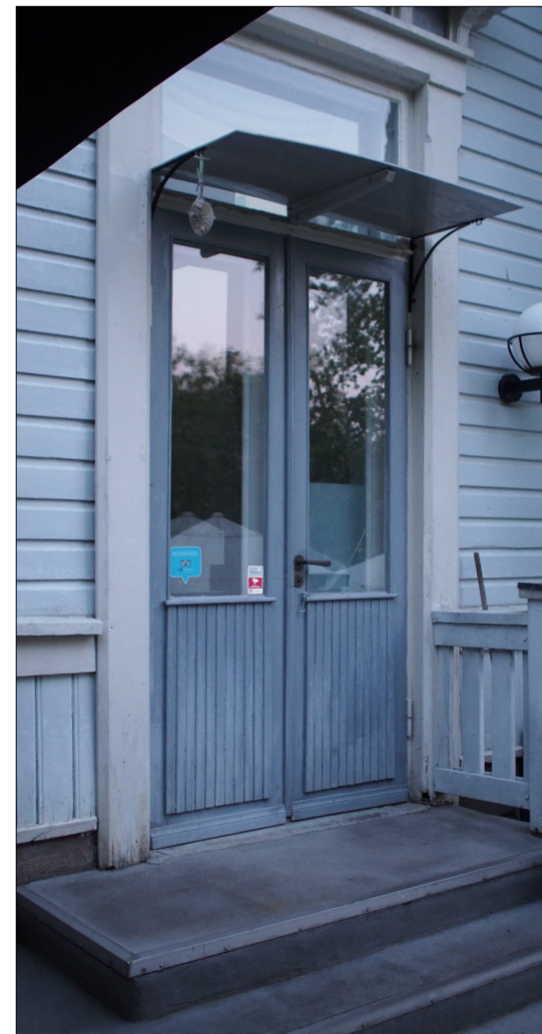
Kuva 65. Eteläisen terassitasanteen ovi poikkeaa tyylliltään muista ulko-ovista. Se on lisätty 1960-luvulla.
