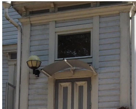
Kuva 55. Länsijulkisivu, länsiveranta. Oven päällä on siro katos, joka on tehty 2010-luvulla. Katos on suurempi kuin pohjois- ja itäverannan sekä muodoltaan kaareva.
