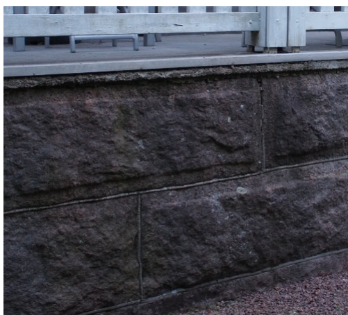
Kuva 75. Betonoitua sokkeliä terassitasanteella ja tasannetta kiertävä luonnonkiviverhou.
