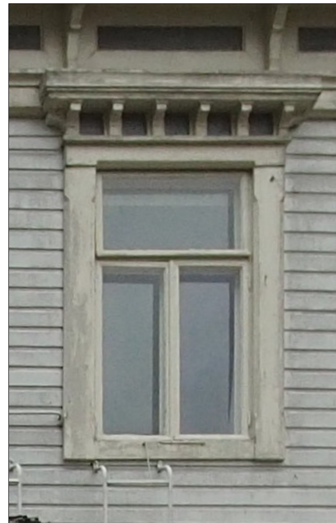
Kuva 58. Itäpäädyn pohjoisin ikkuna edustaa rakennuksen yleisintä ikkunatyyppeä. Se on kolmeen jaettu T-puitteinen ikkuna, jonka kaikki ruudut ovat sisään-ulos aukeavia.
