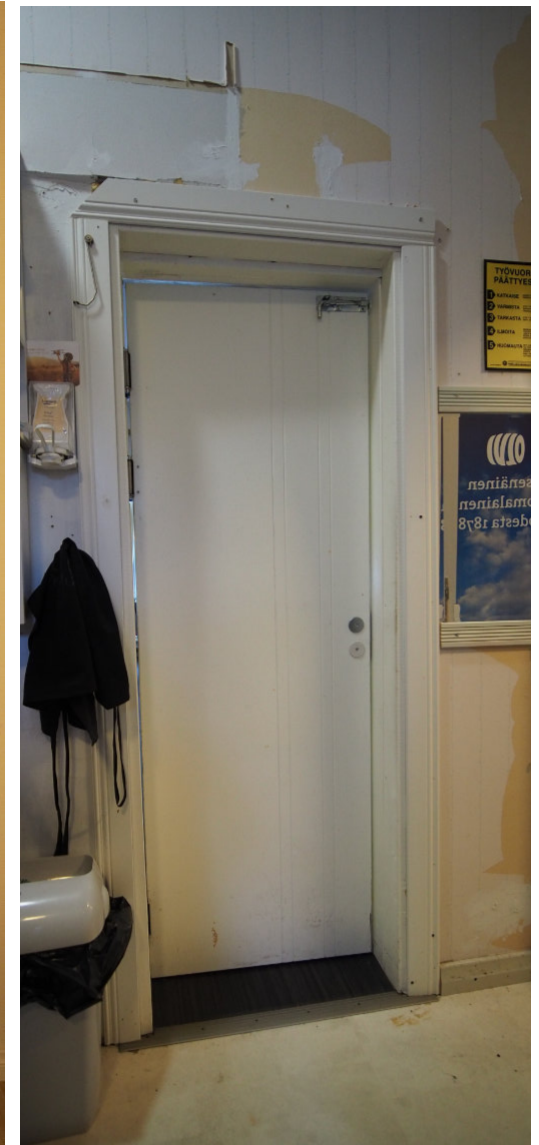
Kuva 70. Laakarakenteinen heiluri-ovi on lisätty keittiötilojen ja suuren salin välille 2010-luvulla.
