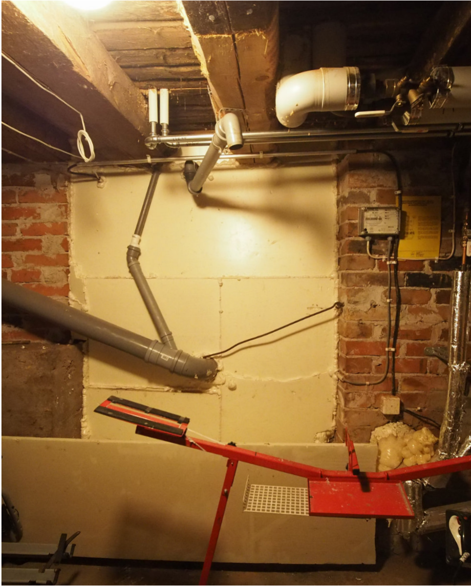
Kuva 48. Kellarin pohjoisimmassa seinässä on alkujaankin ollut aukko. Maanpinnalta on tätä kautta pudotettu Päärakennuksen hiilet varastoon. Nykyään eristeiden takana on rasvanerotuskaivo.
