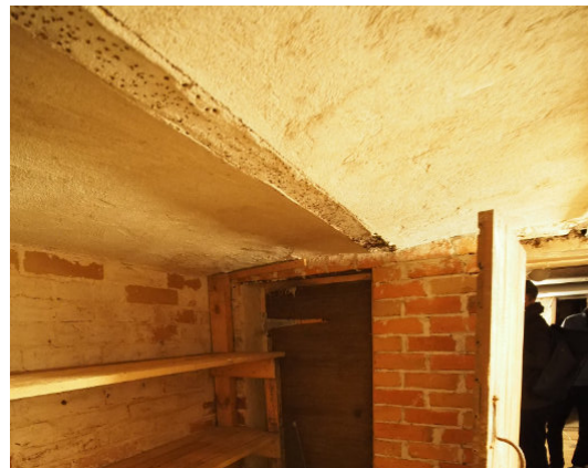
Kuva 46. Eteläisessä perunakellarissa katto muodostaa kevyitä holvikaaria.
