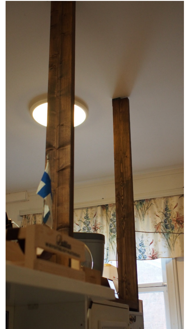
Kuva 81. Vastaanotto-/toimistotila on jaettu 2010-luvulla kevyellä rakenteella, joka koostuu kaapistoista sekä kolmesta pystylaudasta.
