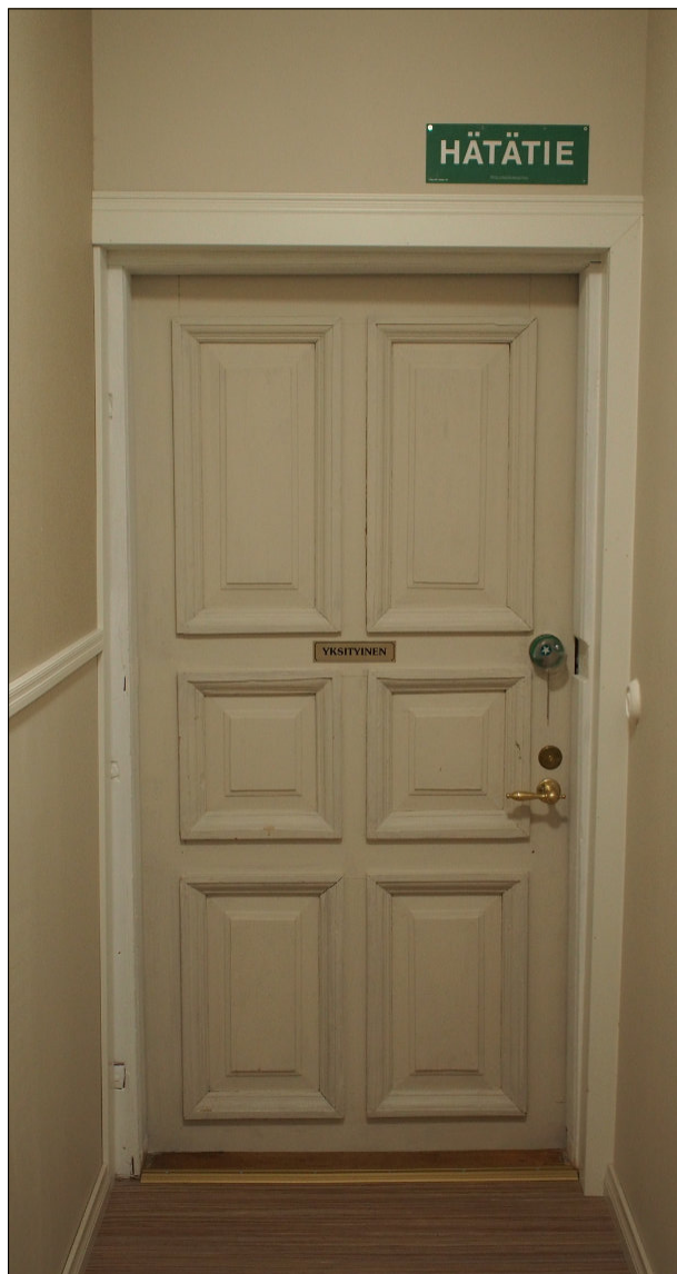
Kuva 66. Toinen kerros, ovi työntekijöiden tiloihin. Kuusipeilinen ovi joka on mahdollisesti ollut täällä paikalla 1980-luvusta lähtien.
