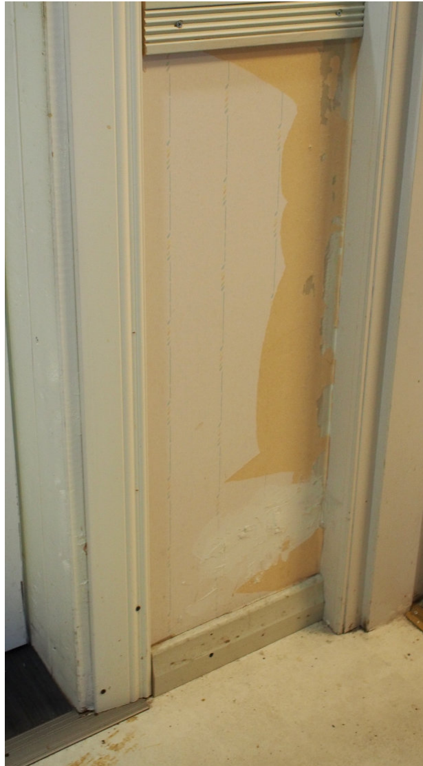
Kuva 80. Toimistotilan eteläseinässä on jäänteitä vuoden 1985 peruskorjauksessa käytetystä tapetista.
