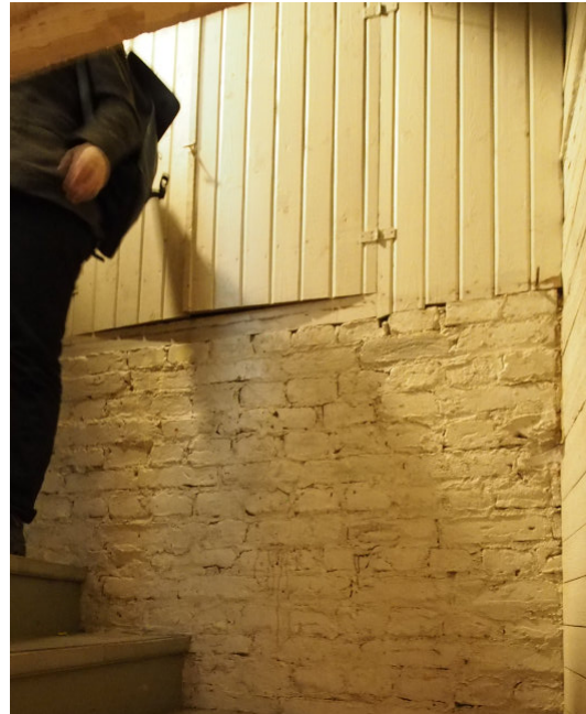
Kuva 45. Tiilimuurauksen päälle on tehty rankarakenteinen kaappi.
