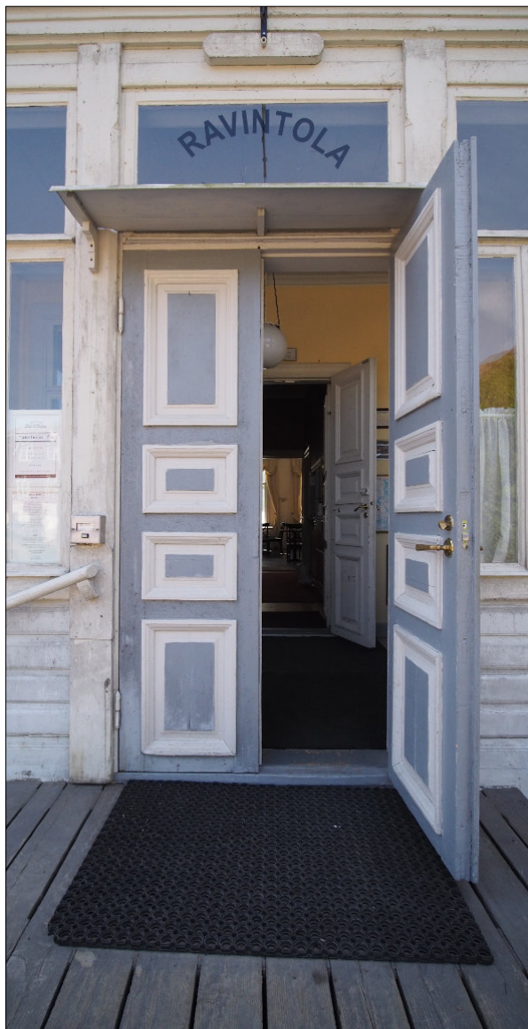
Kuva 64. Pohjoisen verannan ulko-ovi. Uloin ovi on maalattu sekä sisältä että ulkoa samoin värein.
