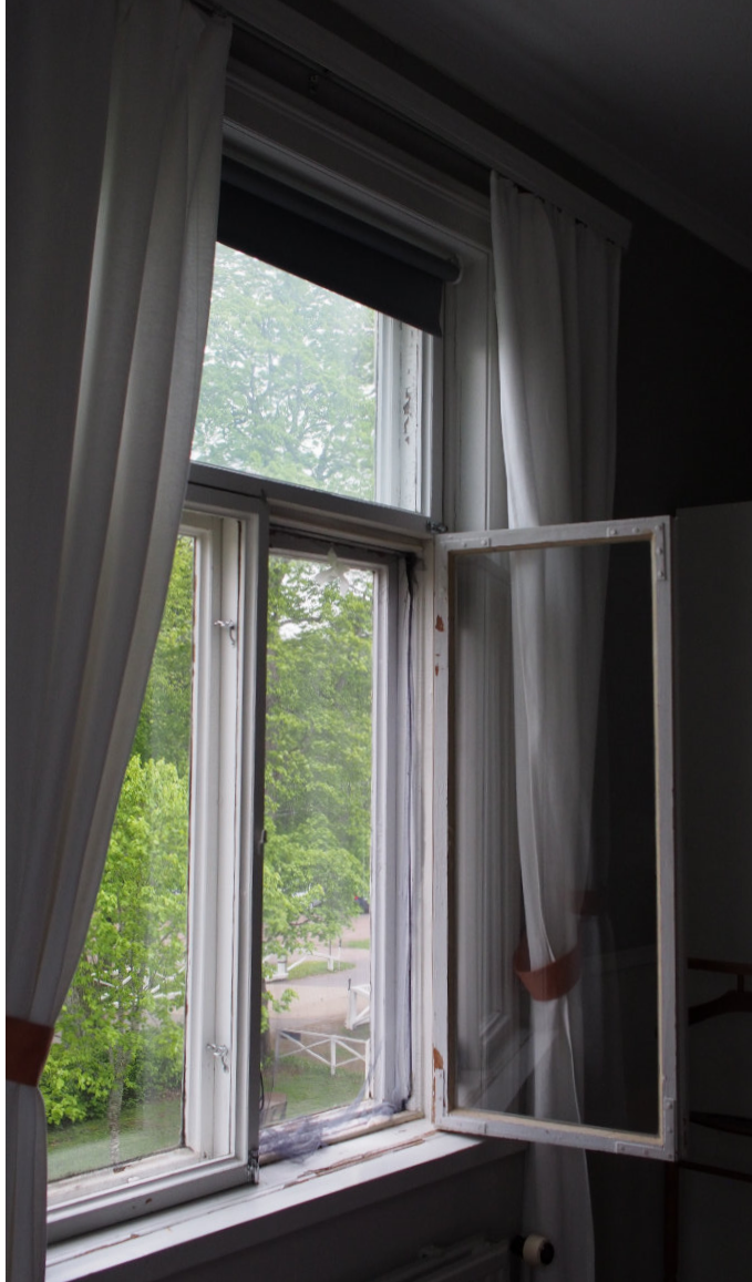
Kuva 59. Eteläjulkisivun itäisin ikkuna. Puitetta on vahvistettu kulmaraudoin ulkopuolelta, jolloin lisäys ei näy sisällepäin.
