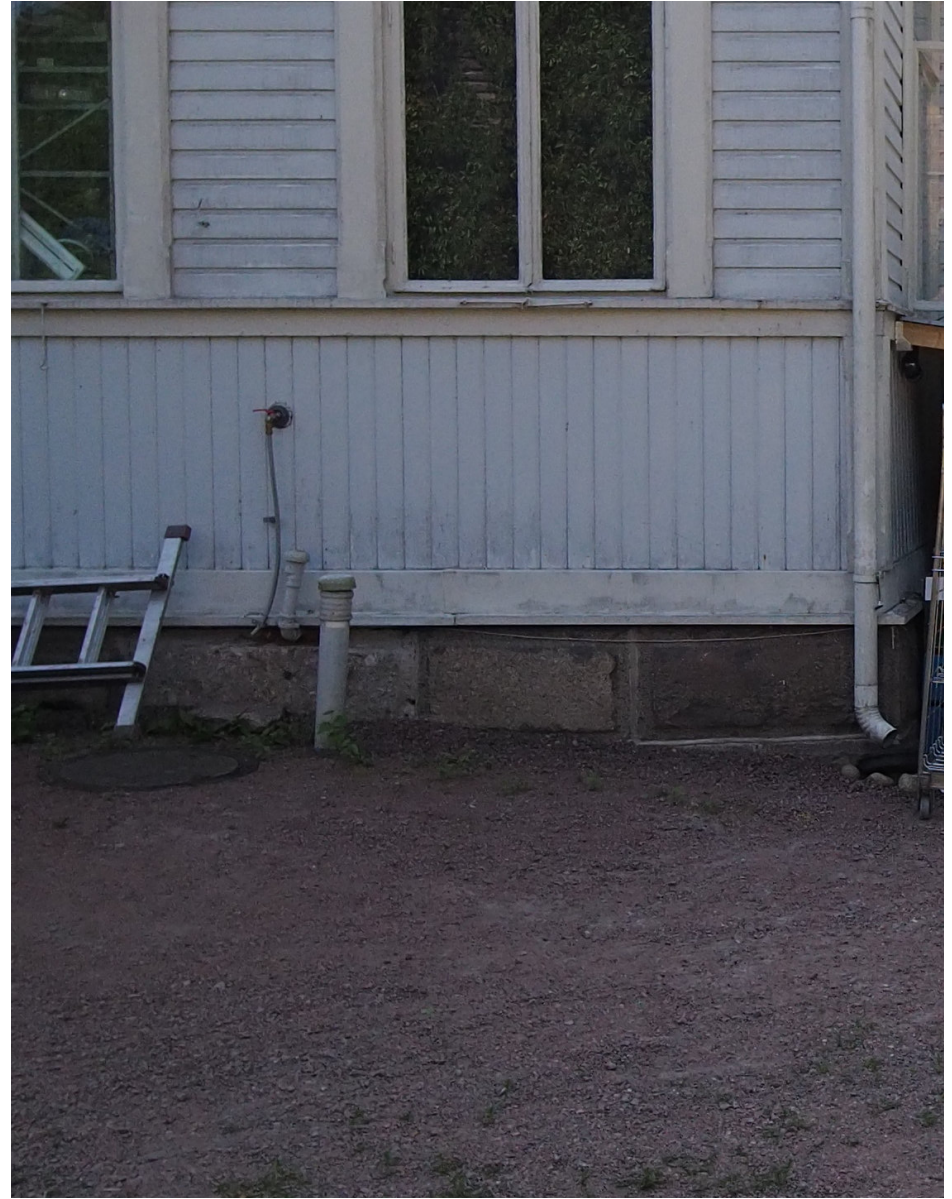
Kuva 49. Sama pohjoisseinämä ulkoa päin. Rakenteen muutos erottuu perustuskivissä.
