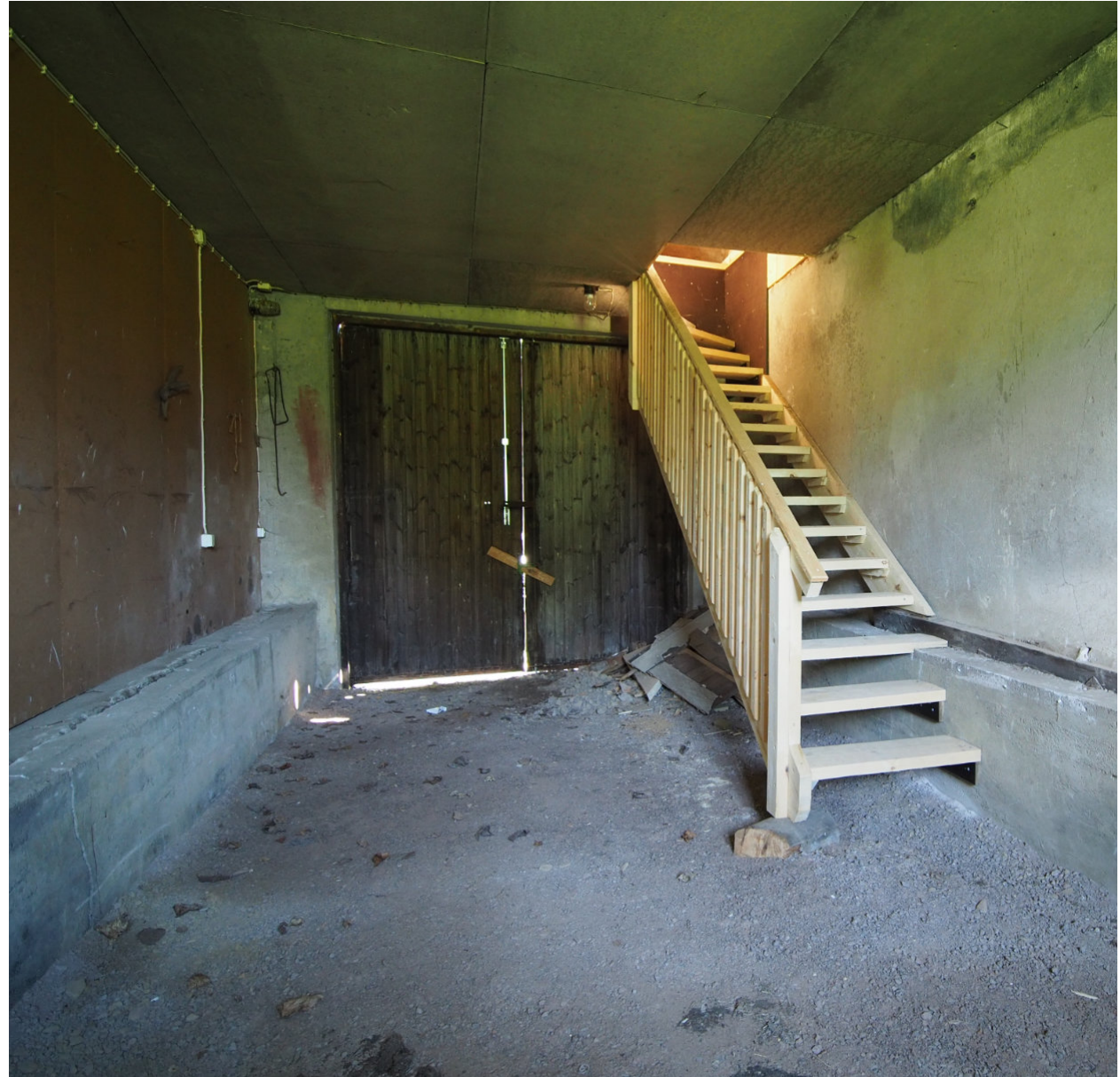
Kuva 80. Eteläpäädyn autotalli länteen. Palopoistumisportaat on lisätty todennäköisesti vuonna 2015.
