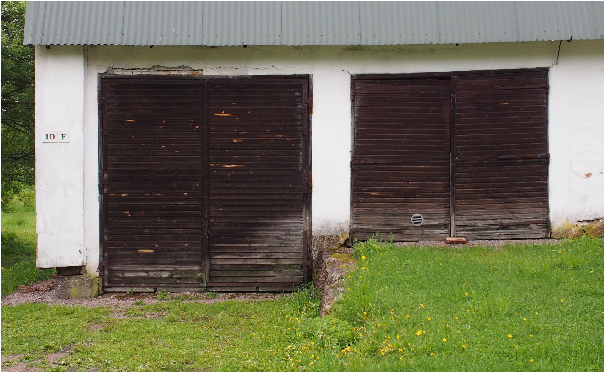
Kuva 53. Itäjulkisivun pohjoispääty. Kuvassa vasemmalla 1950-60-luvulla tehty uusi autotallin ovi, joka johtaa suurelle kuorma-autolle laskettuun suojaan. Oikealla vanha vaunuvajan ovi, joka palveli käytössä ilmeisesti 1990-luvun alkuun. Oikean puoleisessa ovesa on ruukin 1800-luvun oville tyypilliset pitkät saranat. Näissä vanhimpien saranoiden sydämenpäämuotoa ei ole.
