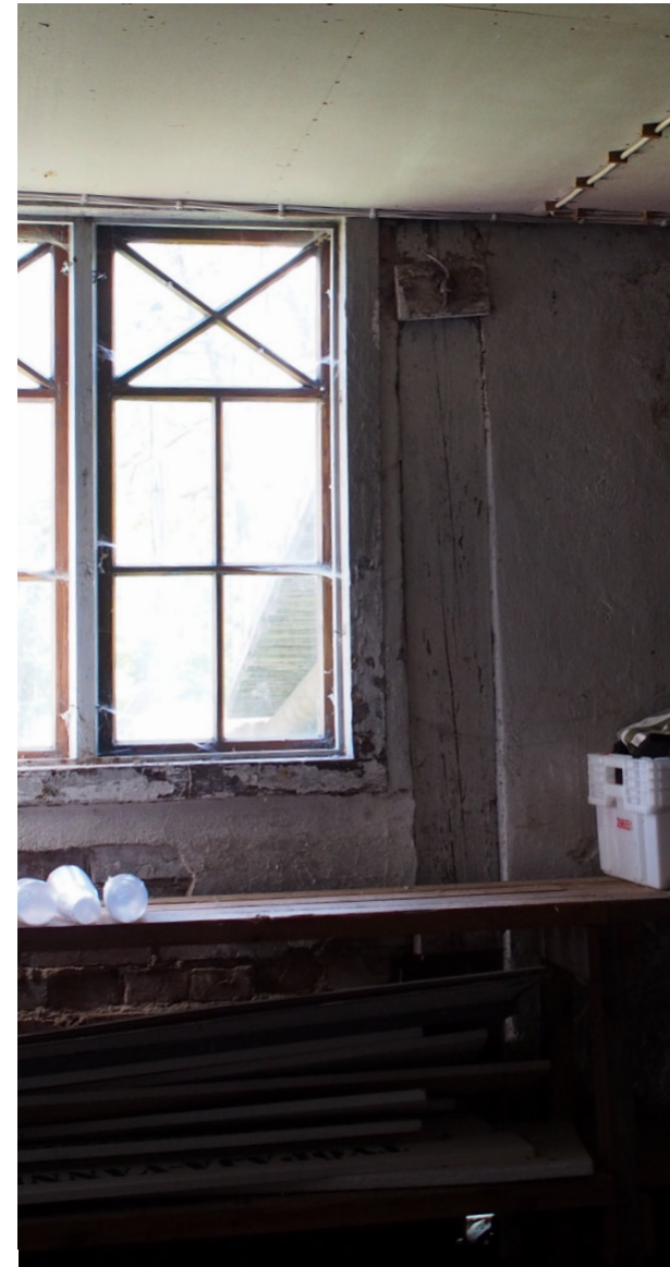
Kuva 43. Itäseinässä kantavaa hirsipilaria ei ole tällä kohtaa rapattu piiloon.
