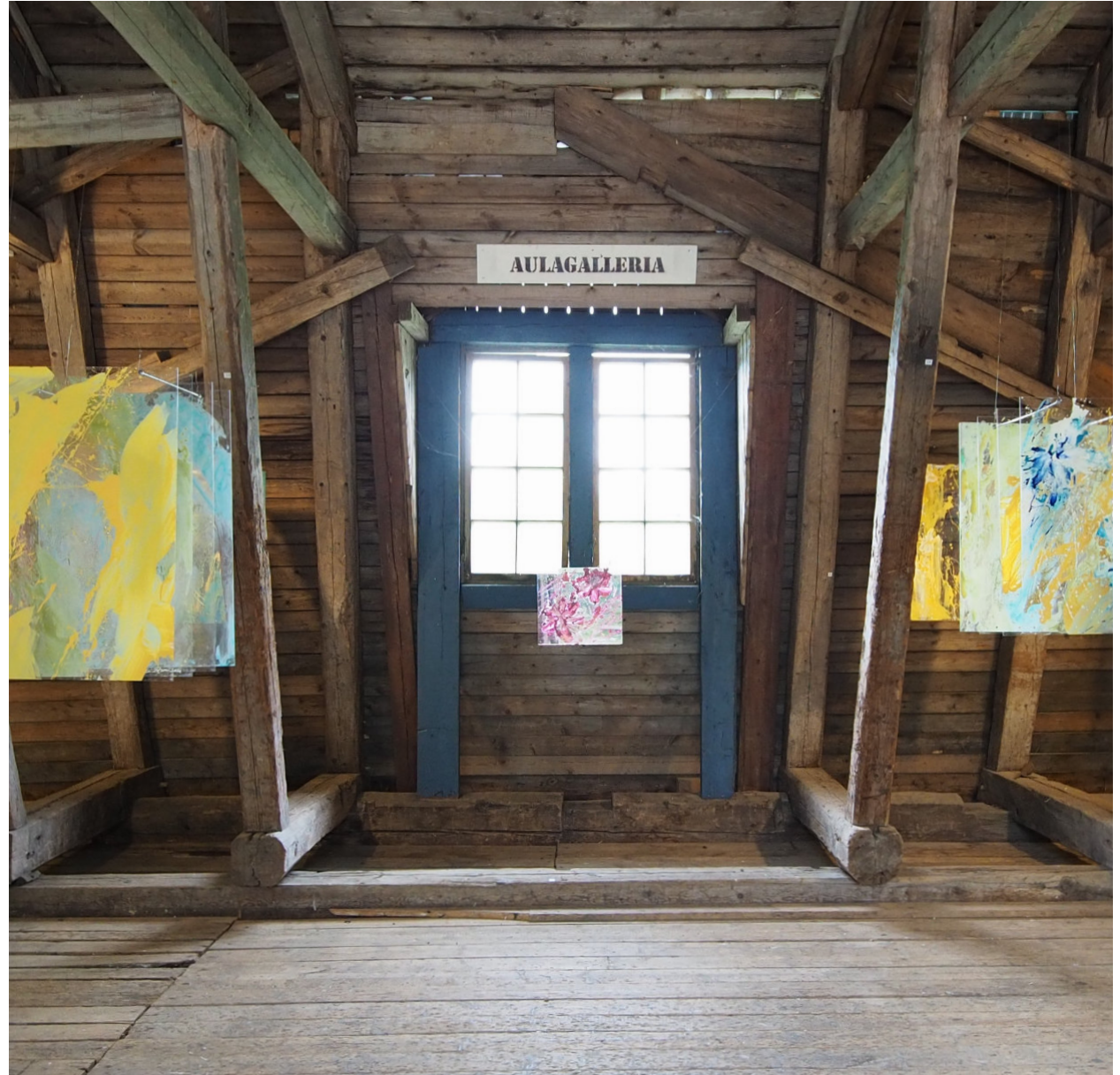
Kuva 83. Aulagallerian länsiseinä. Ikkunan vuorilaudat on maalattu sinisiksi.
