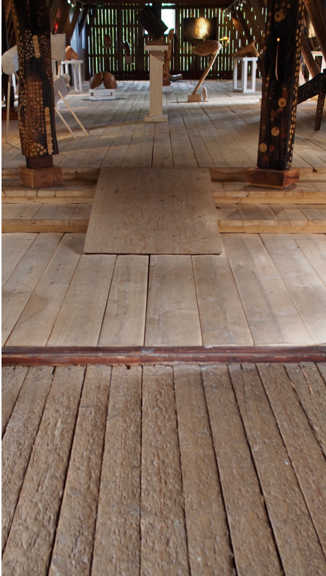
Kuva 44. Lattia Aulagalleriasta etelägalleriaan. Etelägallerian lattia on vuodelta 2015.
