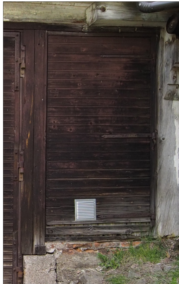
Kuva 57. Pariovien viereen jäävä ovilevy, jossa ei ole vedintä. Tätä ovea ei esiinny 1930-luvun dokumentissa. Sisäpuolelta kohta on levytetty.
