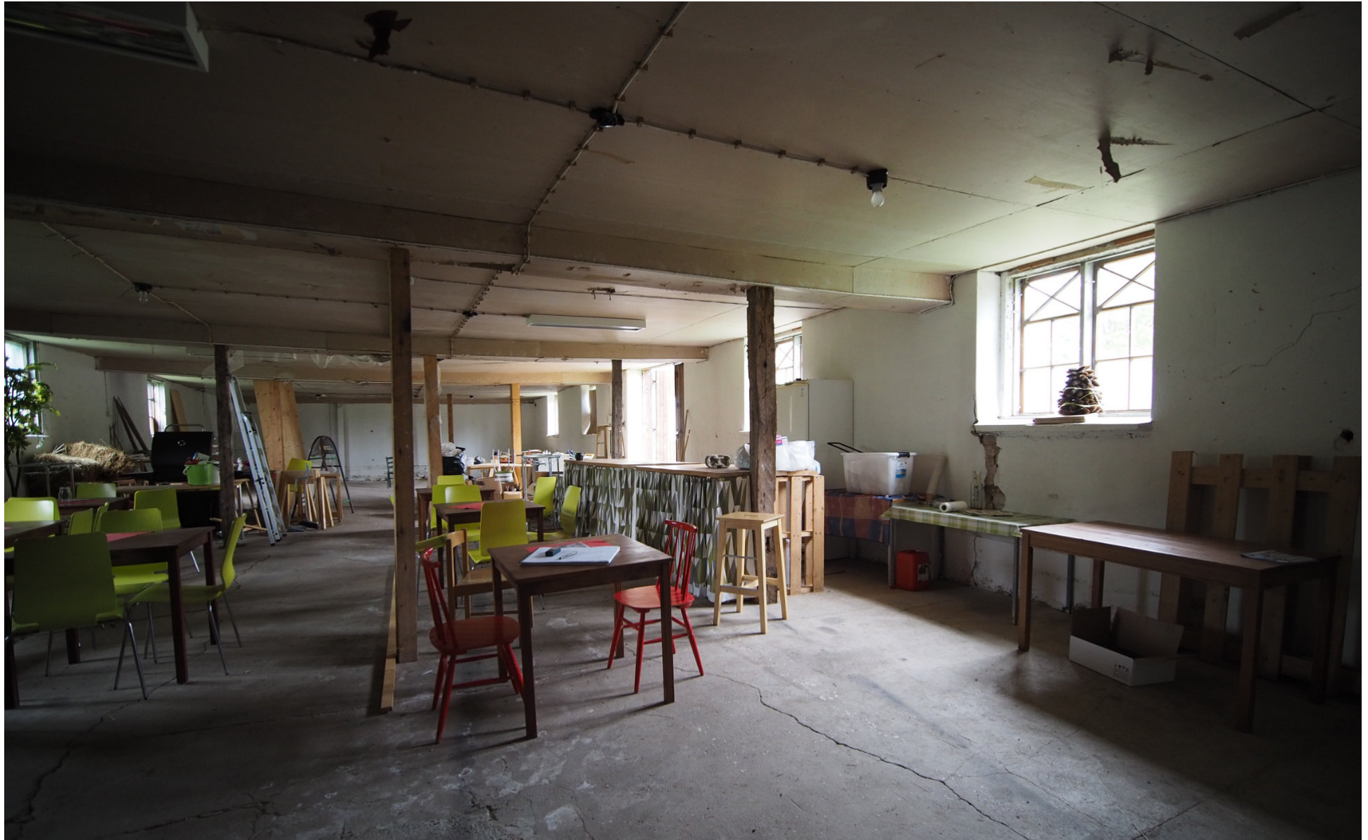
Kuva 70. Varastotila koilliseen. Lyhyet alakttovasat on koteloitu kuitulevyllä alakattoverhouksen tavoin. Vasoja kannattelee hirsipalkkeja, joiden ikä vaihtelee. Itäseinä on varaston kohdalla merkittävästi muita seinärakenteita paksumpi.
