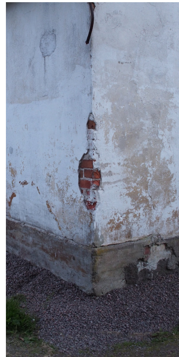
Kuva 47. Koilliskulma. Perustuksen betonivalu näkyy ulkopuolella.
