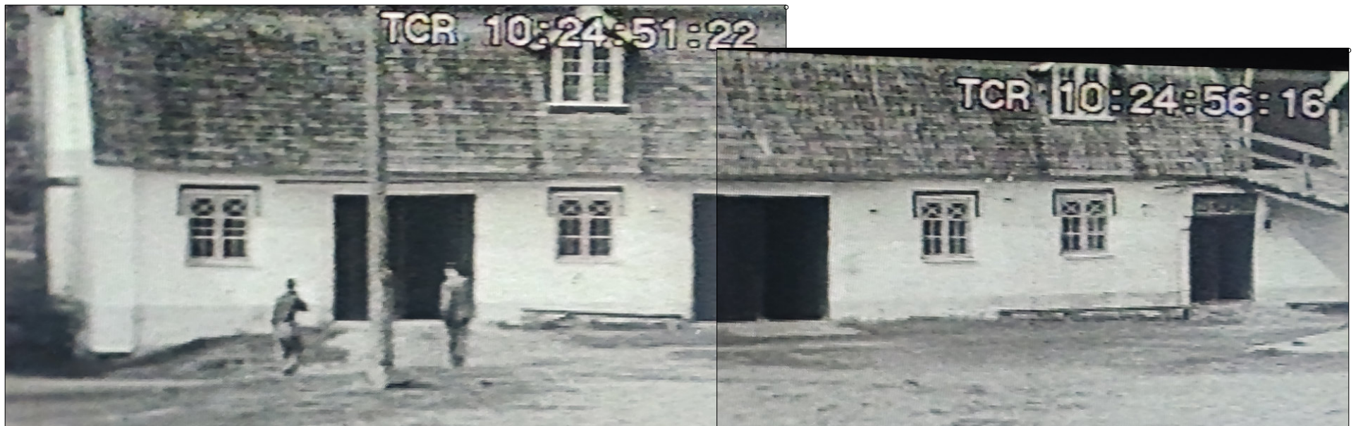
Kuva 16. Hetki Trifonoffin dokumentista. Tallin julkisivu itään. Ikkunoiden päällä on koristeaiheet ja kaikki ovet ovat vielä samassa tasossa. Sillan alle jäävällä ovella on ikkunallinen yläosa. Oven ympärillä on valkoiseksi maalatusta hirrestä tehty kehysaihe.
