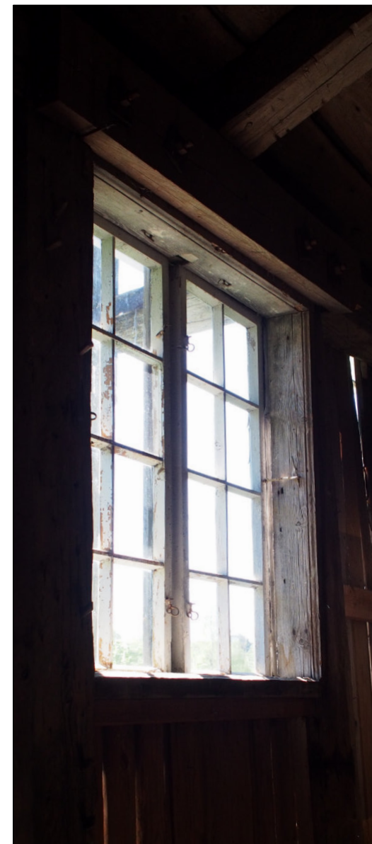
Kuva 66. Ullakon eteläpäädyn ikkuna on kiinnitetty karmeihin sormihaoin.
