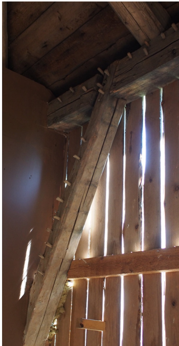
Kuva 42. Eteläpäädyn hirsiosissa on jäljellä tikutusta, joka voi olla jäänteitä rappauksesta. Kulmassa vaikuttaisi olevan jäljellä villaeristettä.
