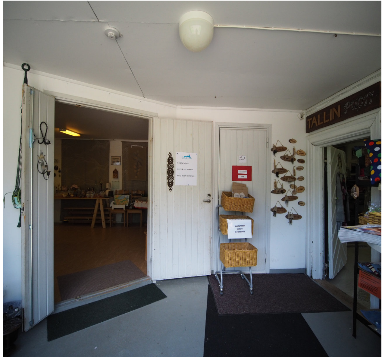
Kuva 76. Eteistila entisen keramiikkapajan (vas) ja valjashuoneen (oik) välillä. Tilasta on kulkua myös puodinpitäjien vessatilaan (keskellä). Tila on luotu todennäköisesti vuoden 1992 korjauksessa, jossa keramiikkapaja on rakennettu.
