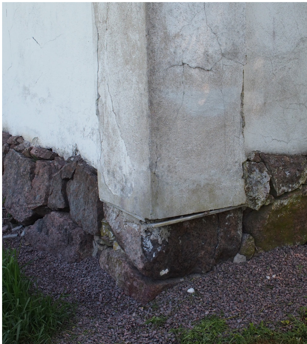
Kuva 49. Tallin lounaiskulma. Perustus on ulkopuolelta tällä kohtaa luonnonkivilatomusta. Sisällä samalla kohtaa näkyy ainoastaan 1950-luvulla lisätty betonivalu (kuvat 80 ja 81, sivut 75 ja 76)
