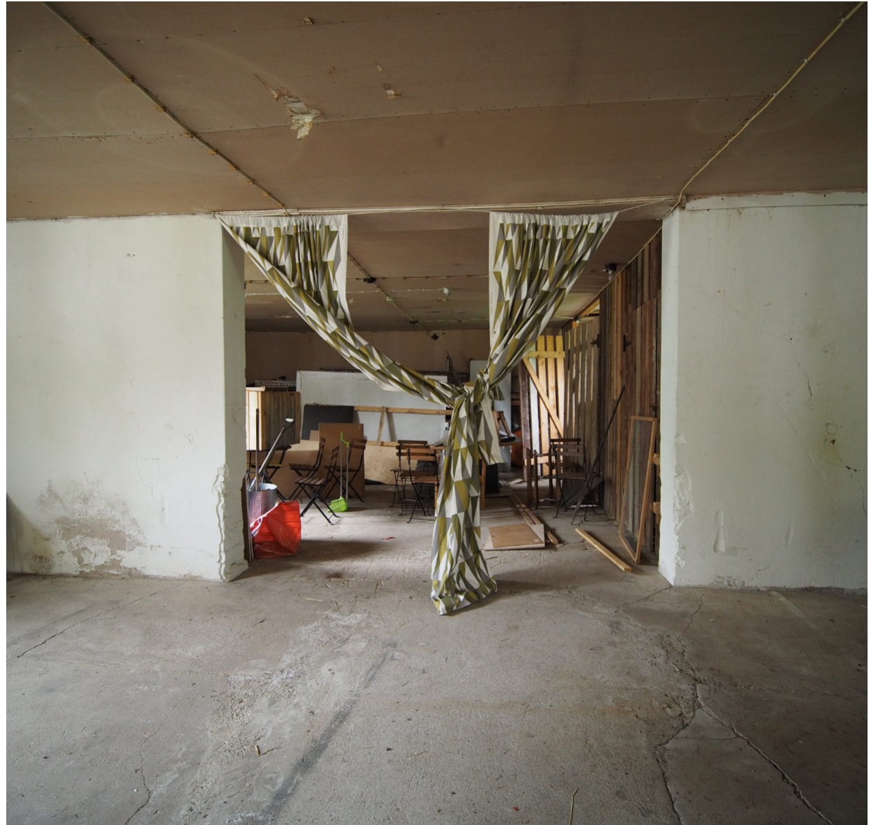
Kuva 71. Entinen talliosaa ja vierastallia erottanut muurattu seinä. Aukko on avattu 1950-luvulla. Oikealla näkyvät taaempaan tilaan tehdyt lautaseinäiset varastohäkit.
