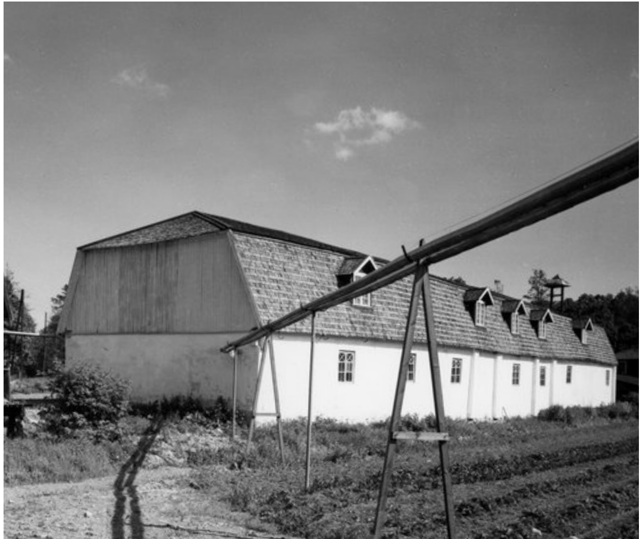
Kuva 23. Vuonna 1965 otettu kuva Tallin pohjoispäädystä. Päätty on jo laudoitettu ja ikkunat ja ovi purettu. Tallille johtaa rakennelma, joka liittyy puutarhan kasvihuoneen toimintaan. Sen tarkempaa käyttöä ei saatu selville.
