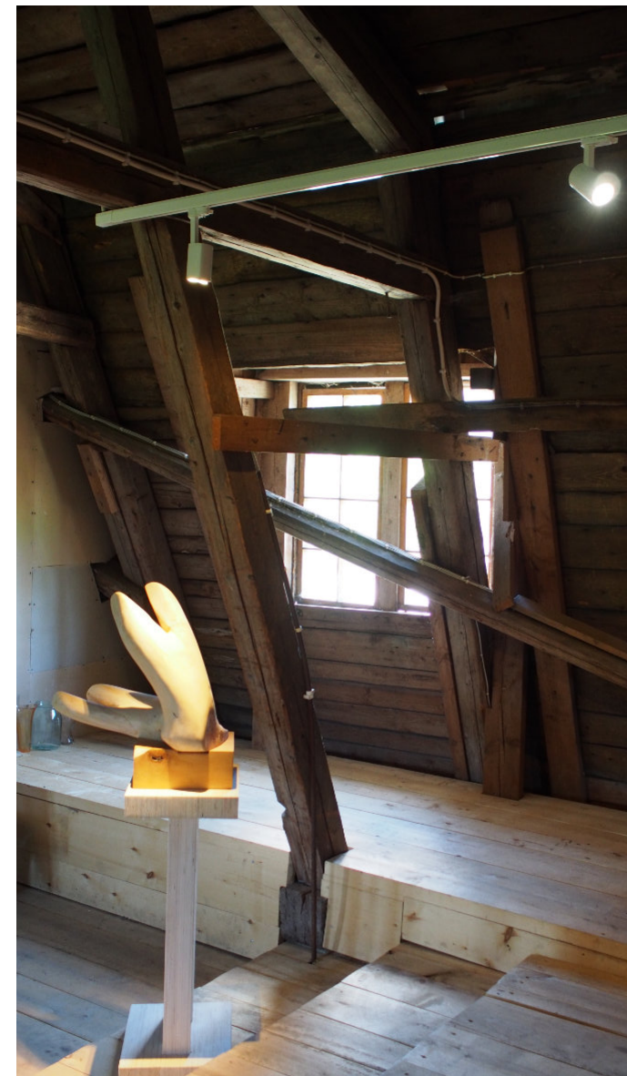
Kuva 41. Etelägallerian koilliskulma. Kattotuoleissa on polveilevasti ratkaistuja vahvistuksia eri aikakausilta.
