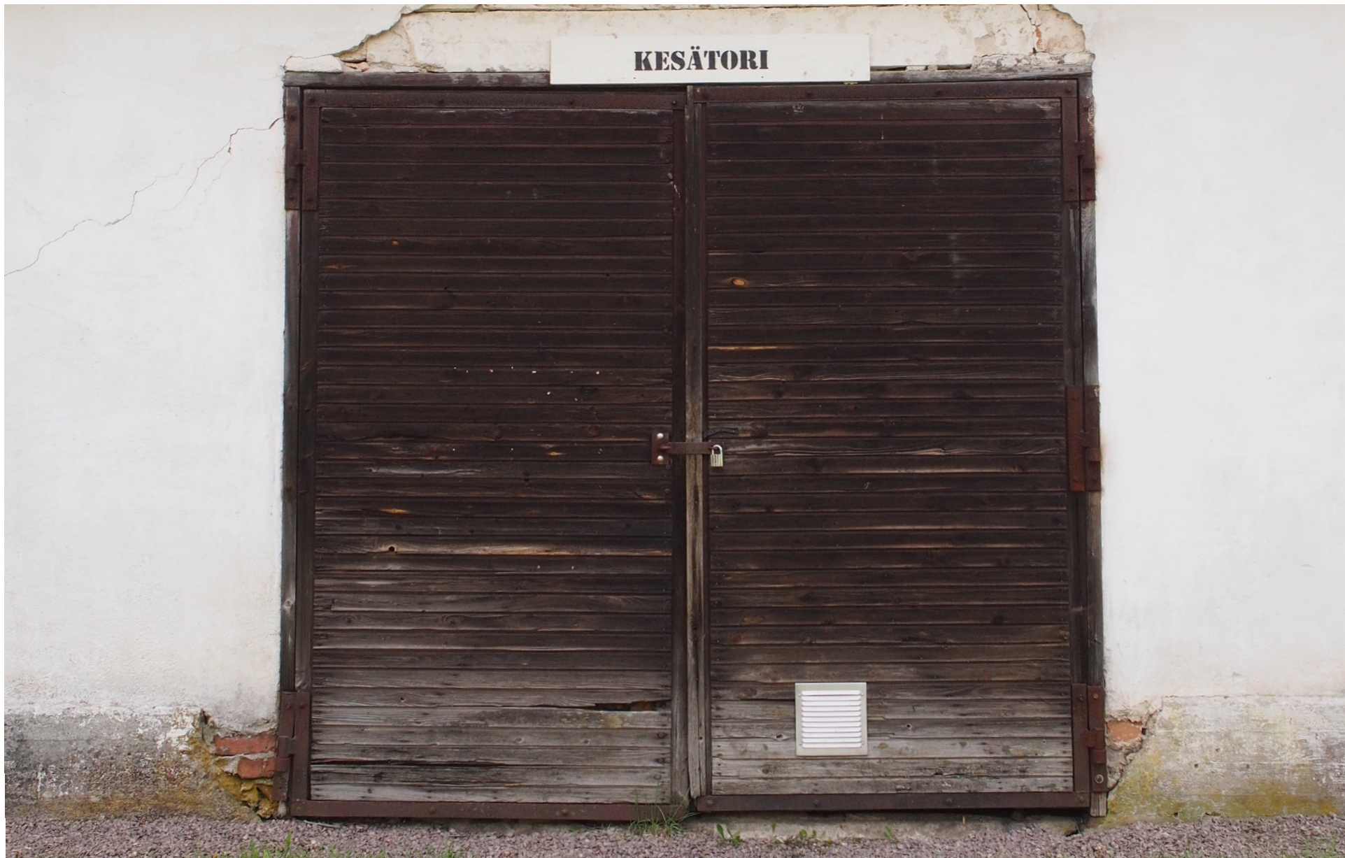
Kuva 58. Entisen tallin, tutkimushetkellä pohjoisvaraston pariövet. Alkuperäistä aukkoa on suurennettu 1950-luvulla, jolloin nämä ovet on asennettu. Seinärakenne on 1900-luvun alusta.
