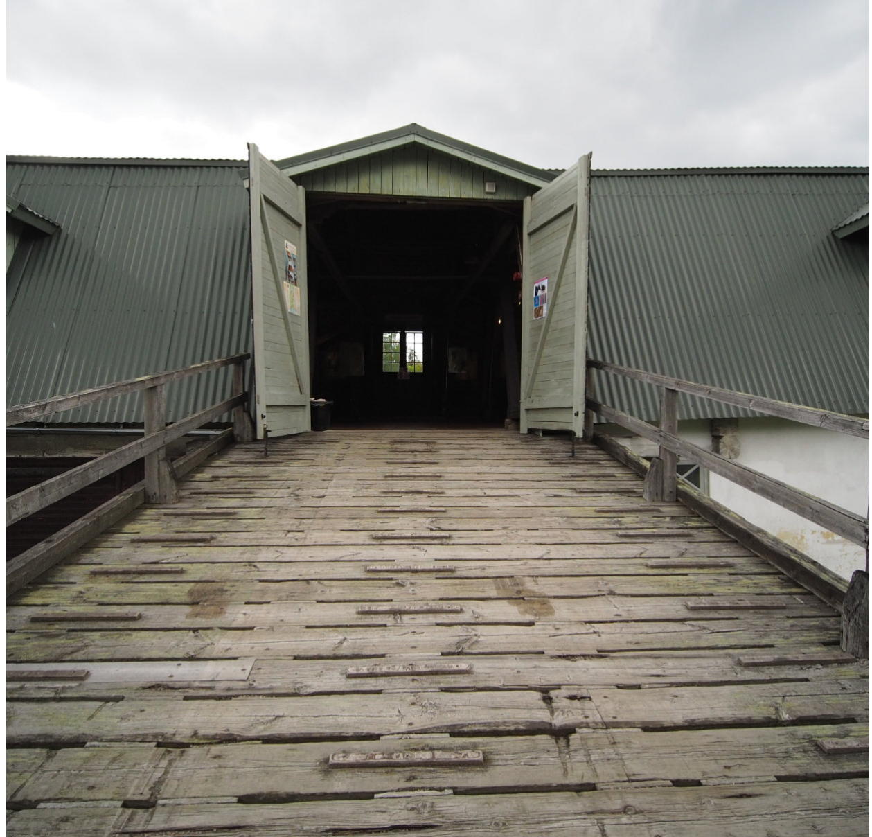
Kuva 50. Ullakolle johtava silta. Kaksoisovet on vuonna 2000 uusittu vanhoihin saranoihin.
