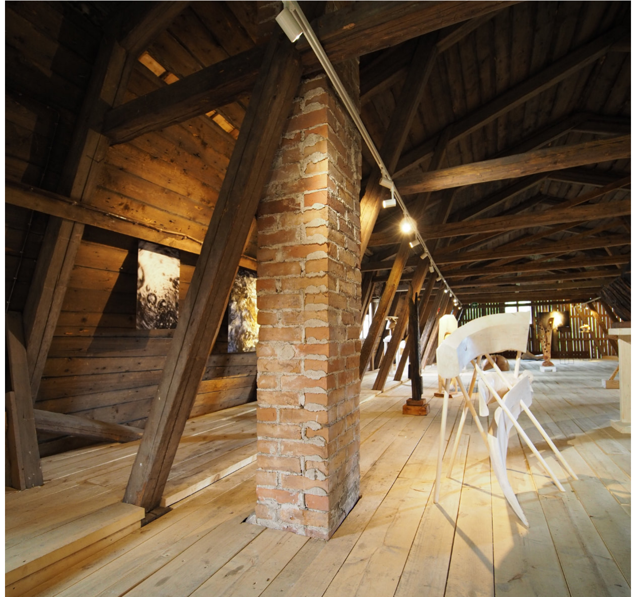
Kuva 87. Eteläinen näyttelytila kaakkoon. Käytöstä poistetun tulisijan piipun jäänteet. Uusi lattiarakenne kiertää vanhoja rakenneosia.
