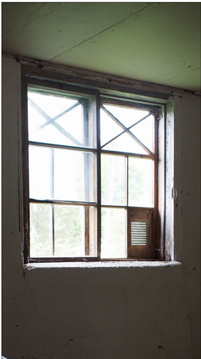
Kuva 64. Tässä länsiseinän ikkunassa on toinen sisätupla jäljellä. Toisen ikkunan alin ruutu on korvattu ilmanvaihtoaukolla.
