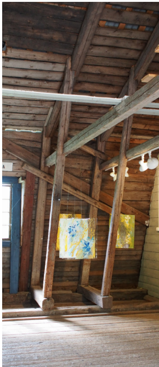
Kuva 40. Aulagallerian länsiseinä. Rakenteessa kulkee satunnaisia diagonaalitukia.
