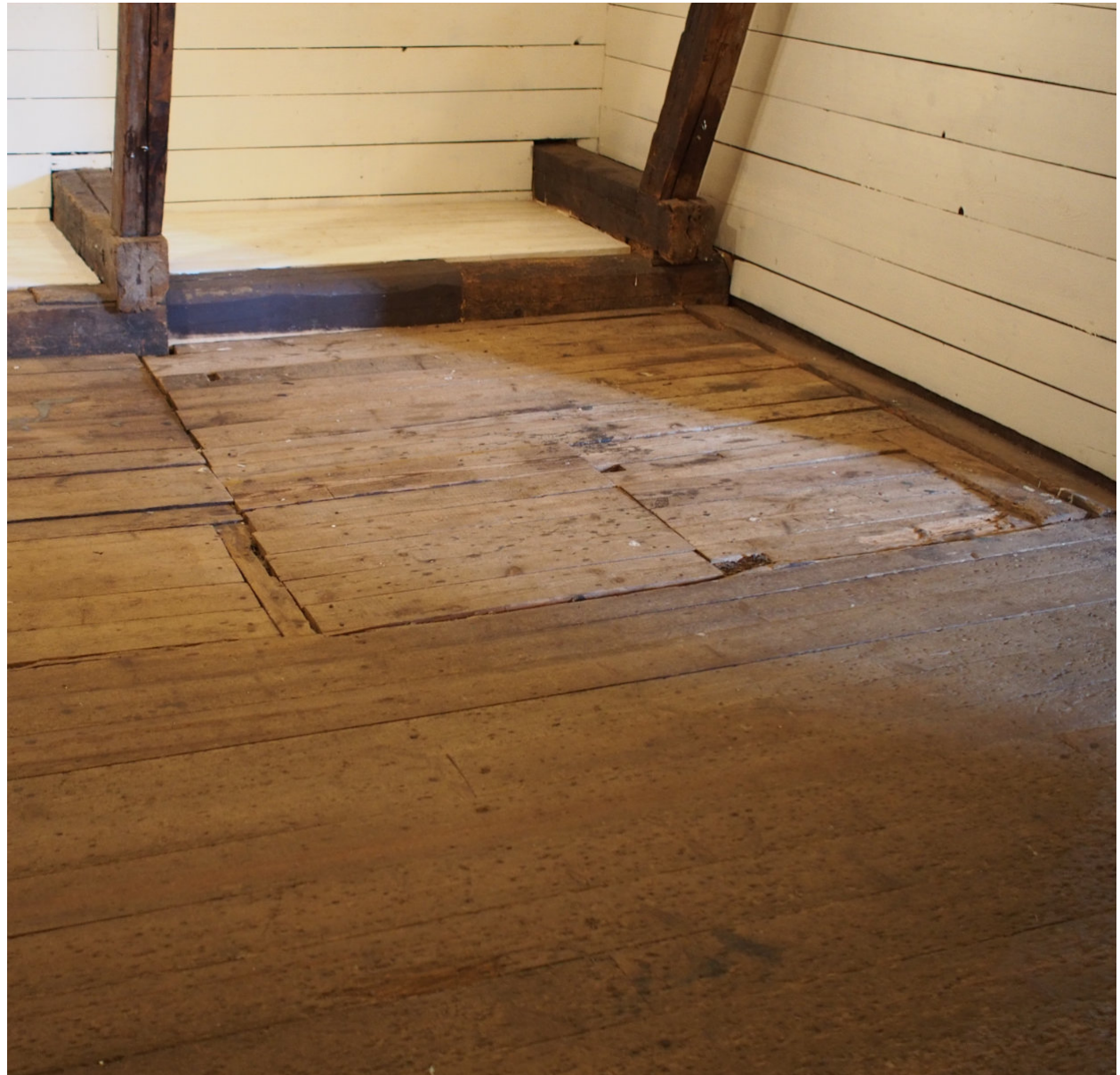
Kuva 84. Pohjoisgallerian kaakkoiskulma. Lattiassa on jäljet kohdasta, josta portaat ovat aikaisemmin nousseet.
