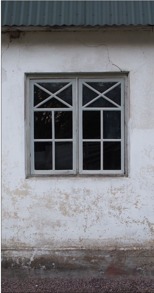
Kuva 60. Itäjulkisivun ikkuna pohjoisreunalta. Tämä ikkuna on korjattu todennäköisesti 1980-2020.
