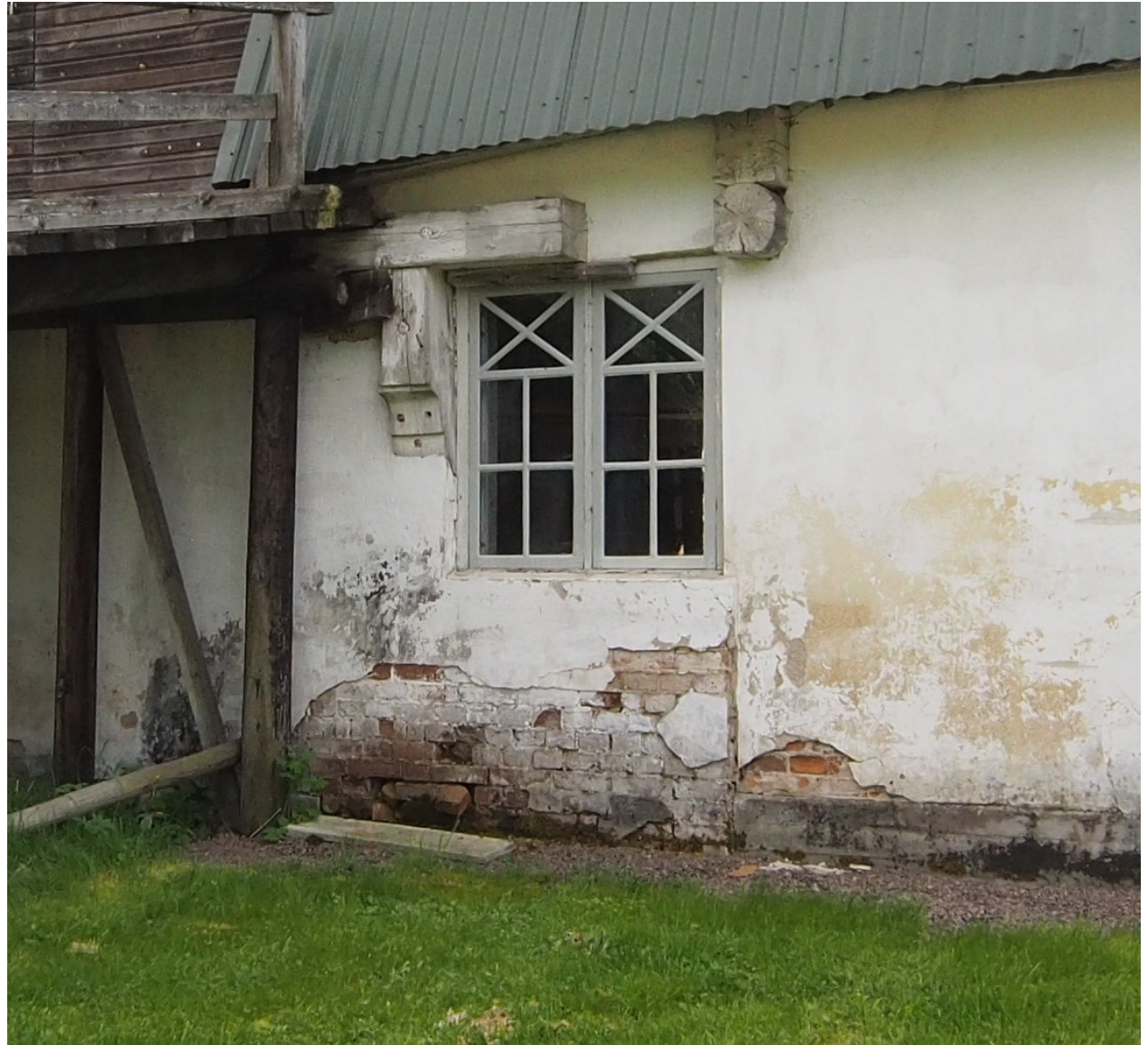
Kuva 45. Itäjulkisivu, kohta jossa uudempi tiiliseinä ja betonisokkeli kohtaa aikaisemman korsvirkerakenteen.
