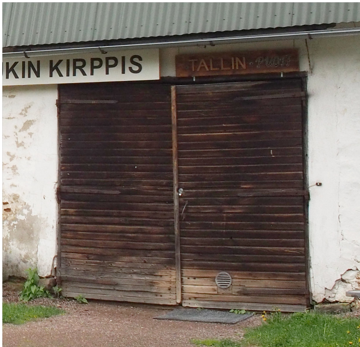
Kuva 54. Entinen valjashuoneen pohjoisempi ovi. Nyt ovi johtaa valjashuoneen ja entisen keramiikkapajan eteiseen. Aiemmin 1900-luvulla se oli tehtaan johtajan autotallin ovi. Oveen on tehty tuuletusaukko.
