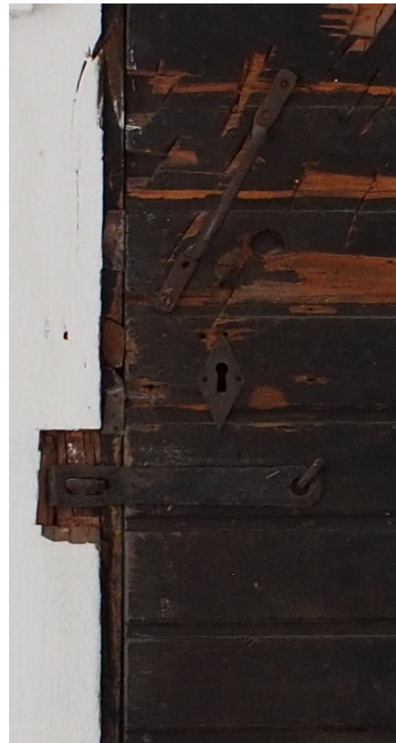
Kuva 73. Yksityiskohta entiseen valjashuoneeseen johtaneen oven vetimistä ja heloista
