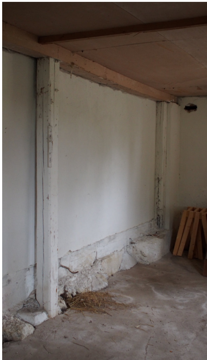
Kuva 46. Pohjoispääty sisältä. Betoni on valettu osittain luonnonkivilatomuksen päälle. Tila on nyt todennäköisesti syvempi kuin se oli tallina toimiessaan.
