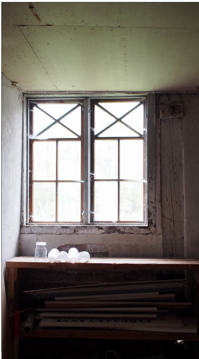
Kuva 65. Entinen tehtaan johtajan autotallin ikkuna. Rappaus ulottuu vain karmiin ja myös hirsipilari on jätetty esiin.
