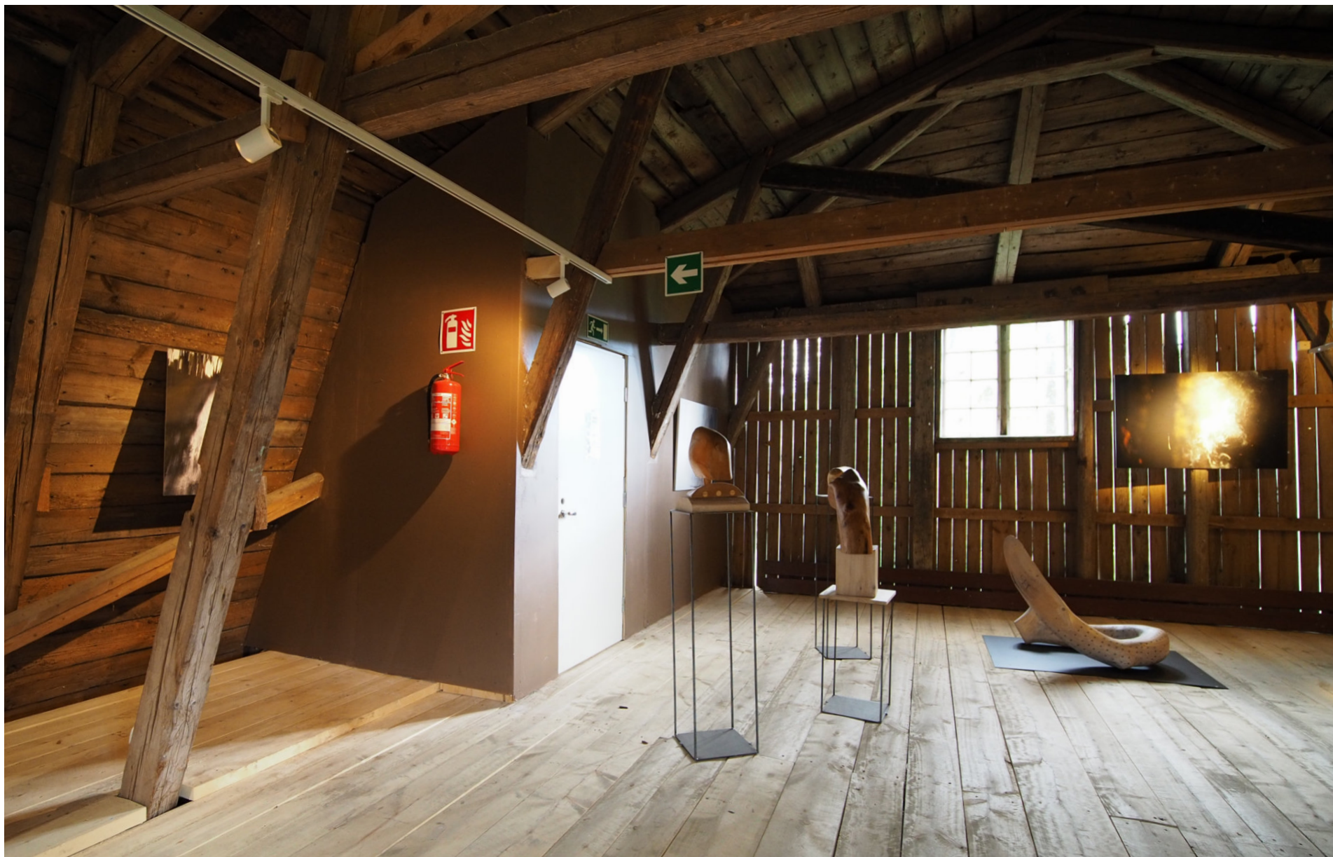
Kuva 88. Eteläinen näyttelytila etelään. Kaakkoiskulmassa on hätäpoistumistieportaille rakennettu erillistila.
