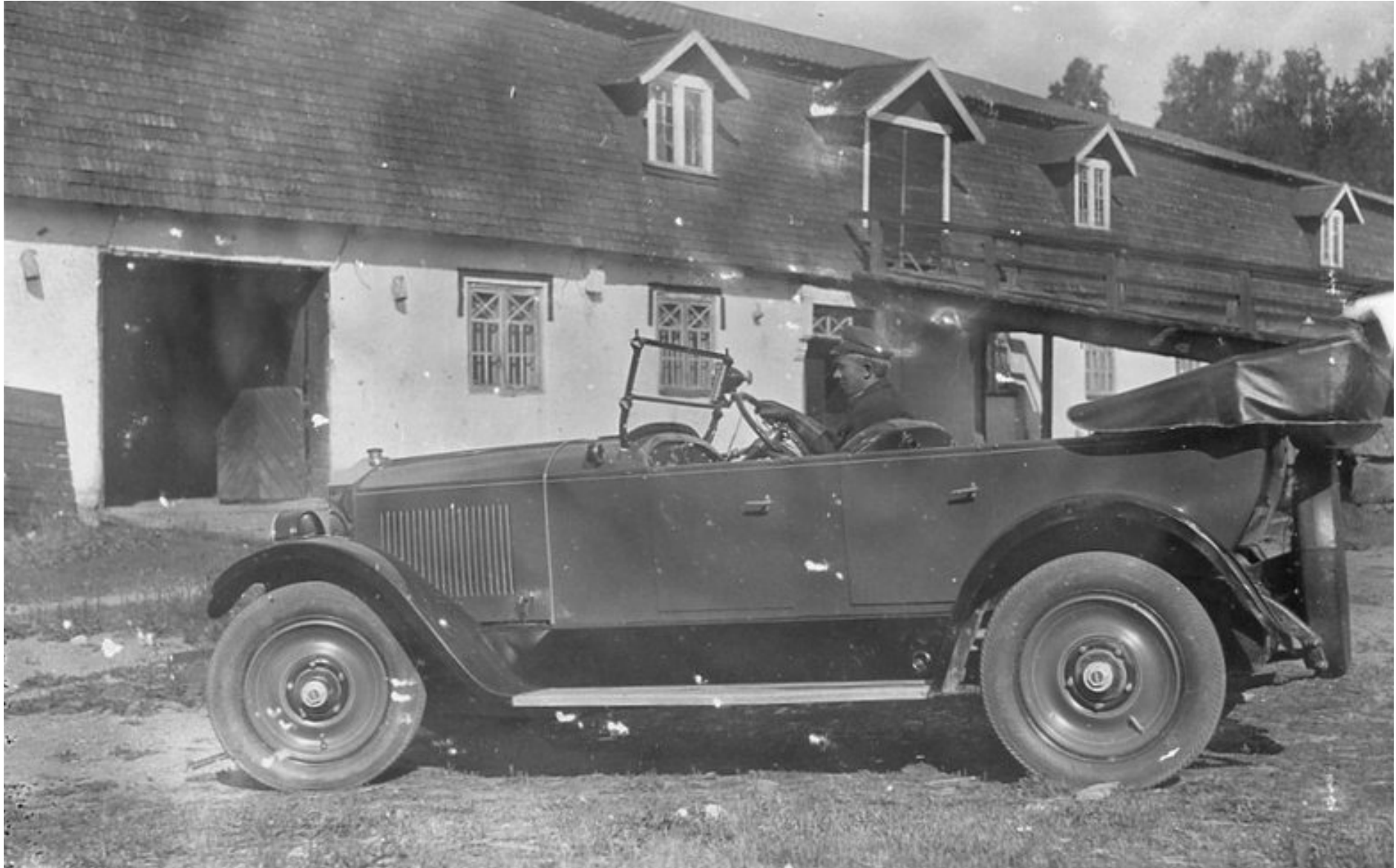
Kuva 21. Valokuva tehtaan johtajan autosta ja kuljettajasta Tallin edessä. Kuva otettu 1900-1930-luvulla. Julkisivun ikkunakoristeet näkyvät kuvassa hyvin, samoin vesikateon pärekate ja entiseen vaunuvarastoon johtavien ovien vinopanelointi. Julkisivussa on myös tuloilmaputkia, joita ei enää nykytilassa ole jäljellä.
