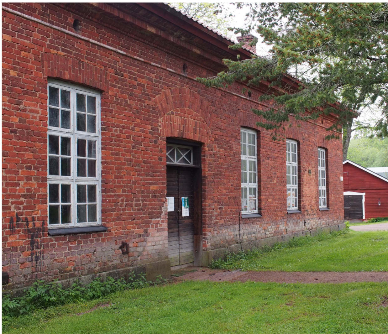
Kuva 19. Yläpajan itäjulkisivu. Koristelu on niukkaa ja rajoittuu räystäskonsoliin.
