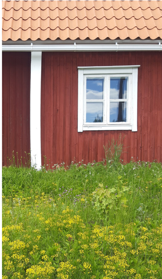
Kuva 12. Sahanmäen työväenasunnon julkisivu.
