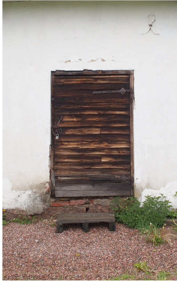
Kuva 17. Navetan ovesa on 1800-luvulle tyypilliset saranat.
