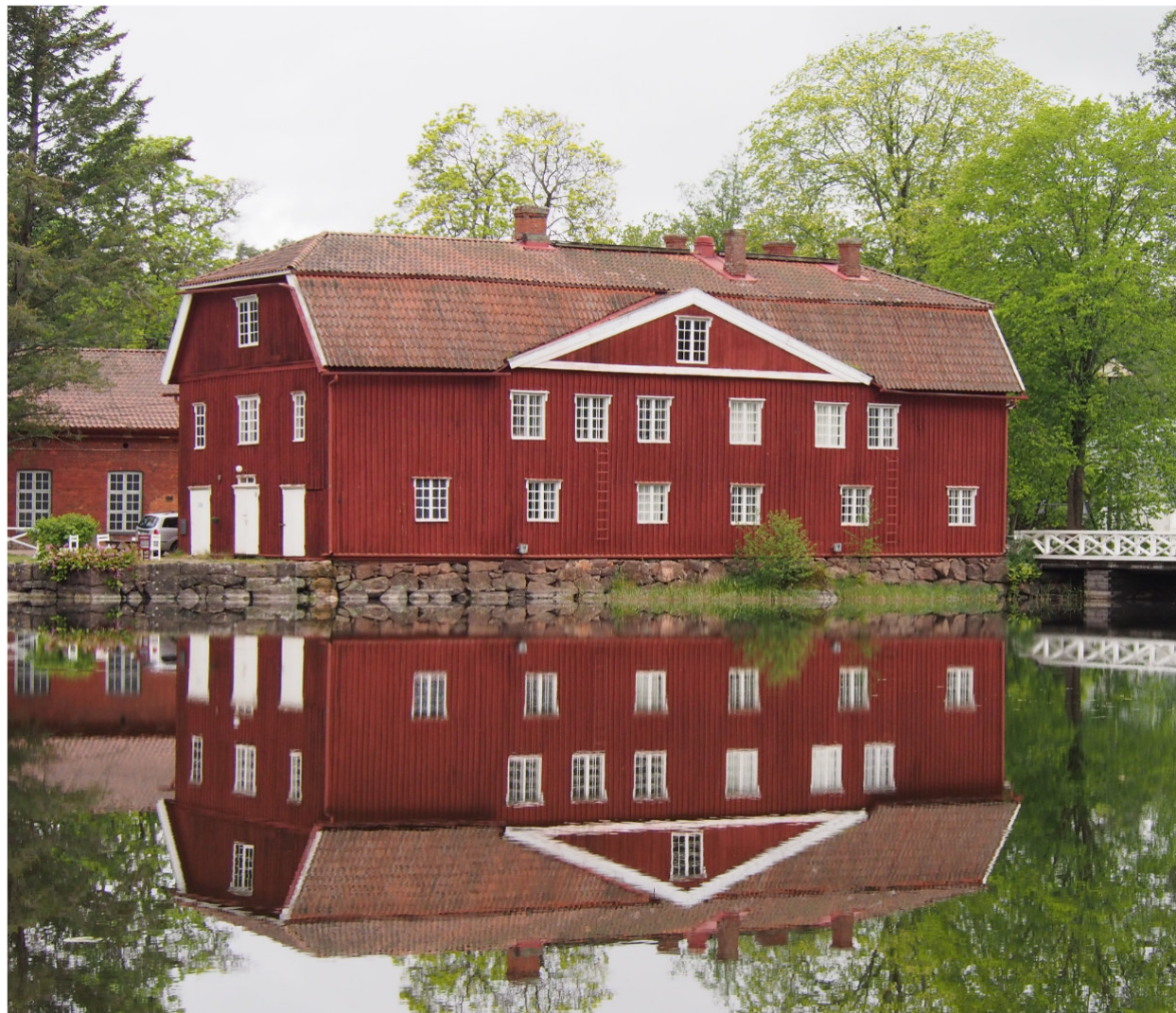
Kuva 10. Armonlinnalla on vähemmän valkoisia listoituksia kuin muilla punaisilla puurakennuksilla.
