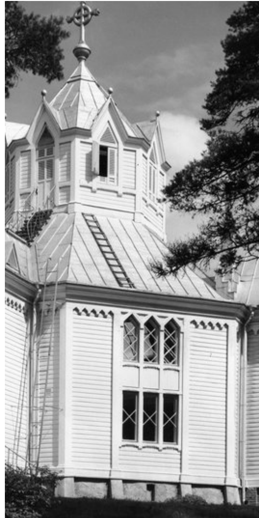
Kuva 21. Ruukin kirkon uusi julkisivuverhous.
