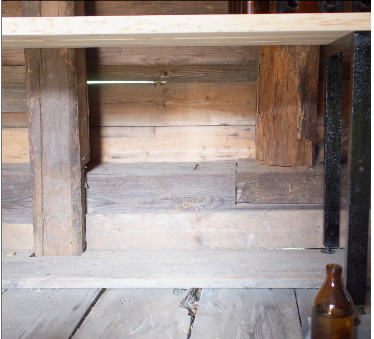
Kuva 24. Rungon pystyrakenteet liittyvät alapohjarakenteisiin monin eri tavoin.
