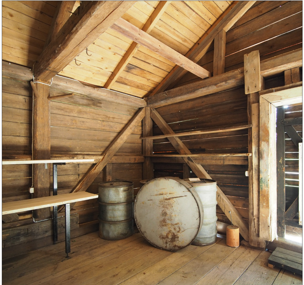
Kuva 21. Aitan koilliskulma. Runko on jäykistetty vertikaalituilla. Oven vuorilaudoitus on tehty myös sisäpuolelle. Valkoisessa maalipinnassa on myös sinisiä jälkiä.
