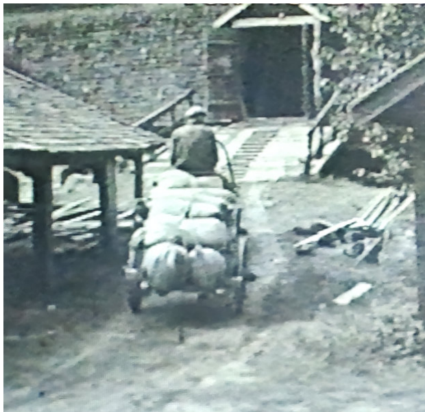
Kuva 6b, Maasilta tiilikuivaamoon.
