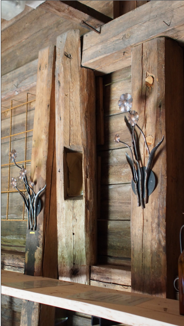
Kuva 23. Pohjoisseinän rakenteeseen kuuluu hirsikappale, jossa on samanlainen reikä kuin pohjoisfasadissa. Sen tarkoitus ei selvinnyt tutkimuksessa.
