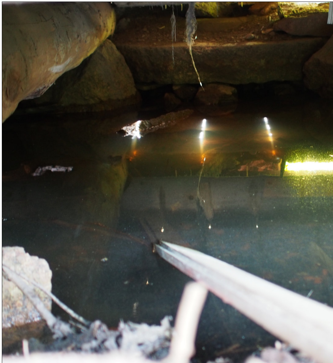
Kuva 20. Näkymä aitan alle pohjoisfasadin puolelta. Vedessä on erilaisia puurakenteen osia. Osa perustuskivistä on lohkottu huolella.
