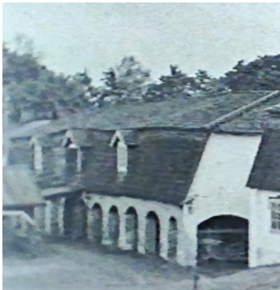
Kuva 6a, Tiilikuivaamo arkadikaarineen.
