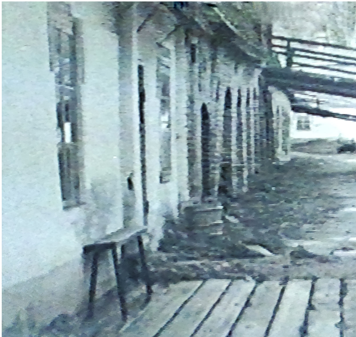
Kuva 14, Hetki Trifonoffine lokuvasta. Näkymä pohjoiseen Vaasanlinnan edestä. Seinärakenne vääntyilee korsvirkkeelle tyypillisesti. Sitä on selkeästi ryitetty korjata fölarilla, mutta mahdollisesti tuloksetta.
