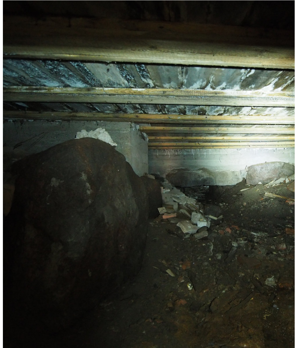
Kuva 50. Alapohjassa on pieni ryömintävara. Maapohjaan on sekoittunut tiilenpaloja.
