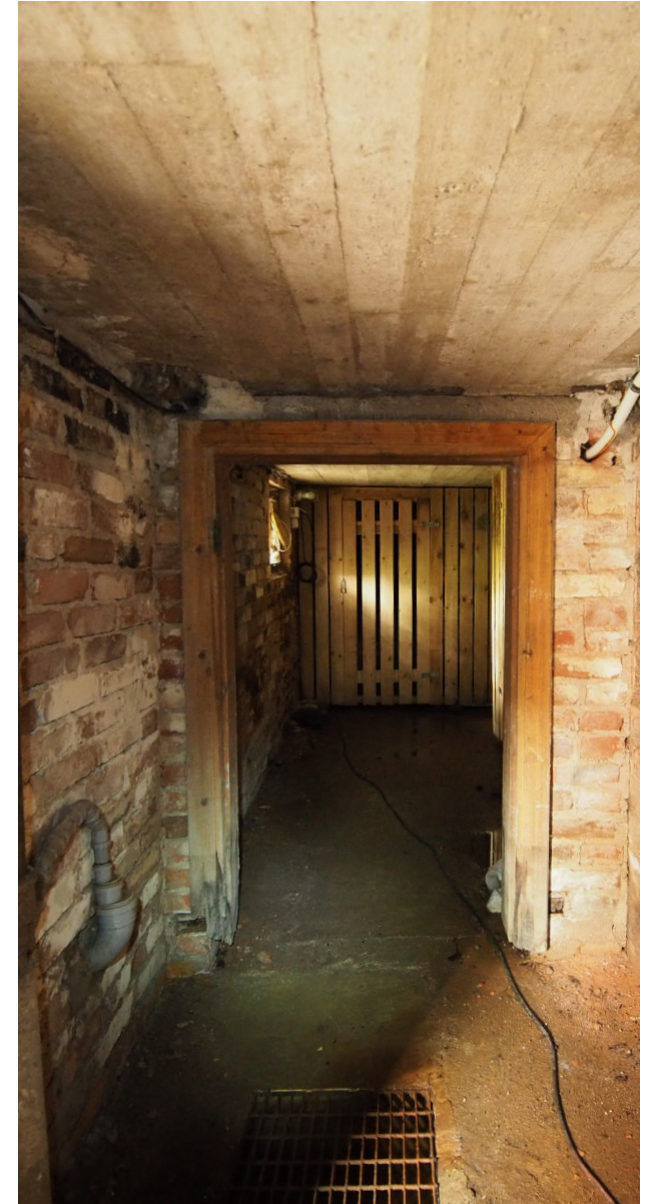
Kuva 48. Kellari länteen. Etualalla viemäri hulevedelle.
