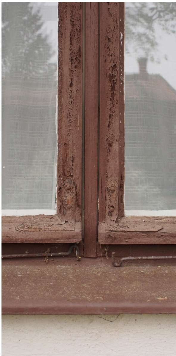
Kuva 55. Puitteet on kasattu kulmaraudoilla.
