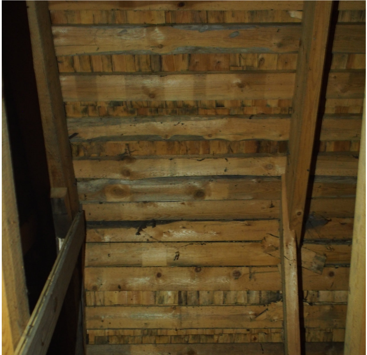
Kuva 45. Näkymä ullakon kattoluukusta katon harjakohdasta. Pääret näkyvät laudoituksen takana.
