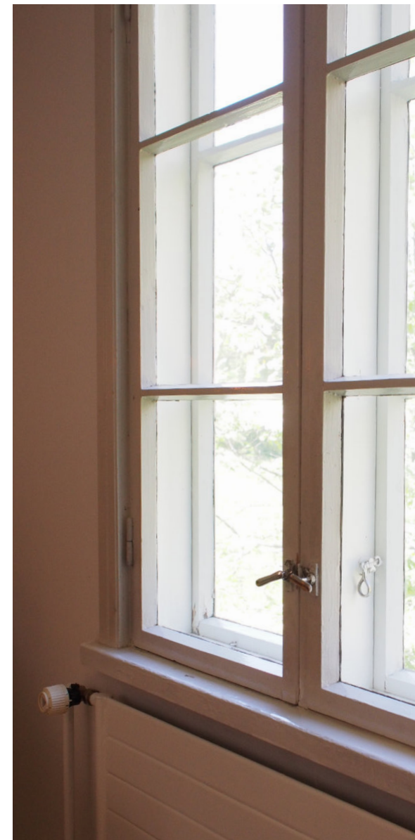
Kuva 56. Sisemmät ikkunat lukitaan säpeillä. Ulomissa on sormihaat.
