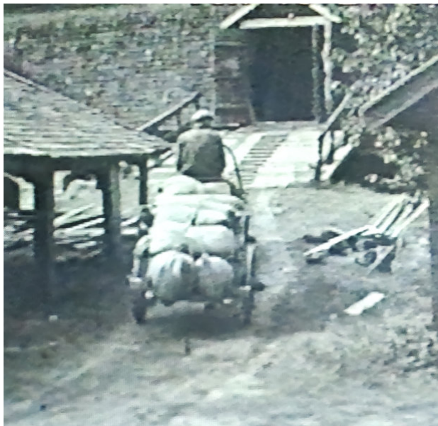
Kuva 7b, Maasilta tiilikuivaamoon.
