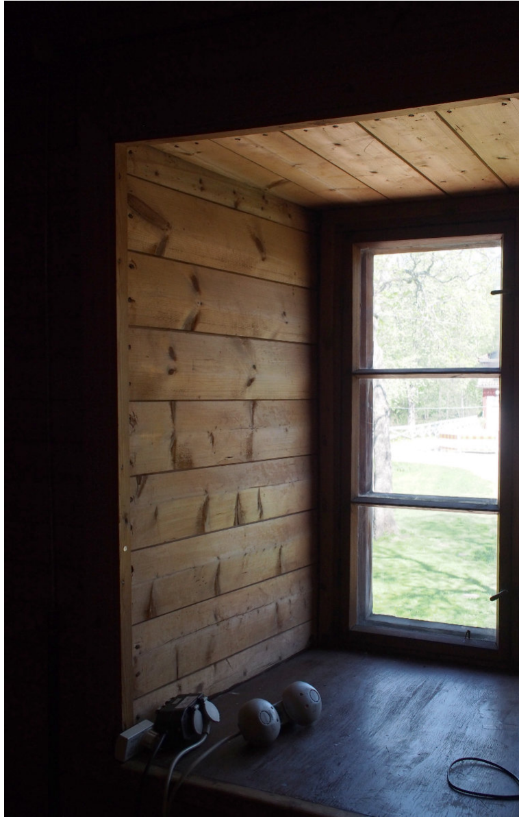
Kuva 57. Mansardissa istuvilla ikkunoilla on mittavat syvennykset. Tätä ullakon ikkunaa lukuun ottamatta ne on maalattu valoiksi.
