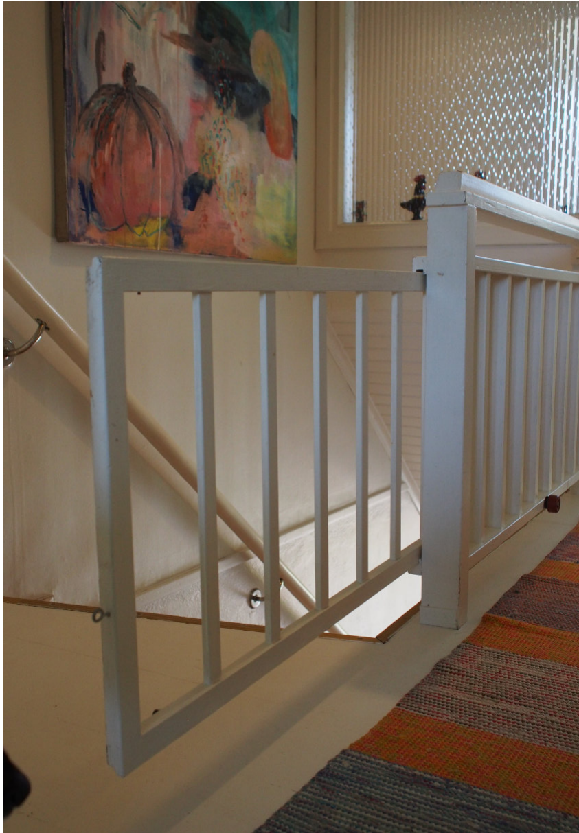
Kuva 75. Liukuportti kuuluu kaiteen rakenteeseen.
