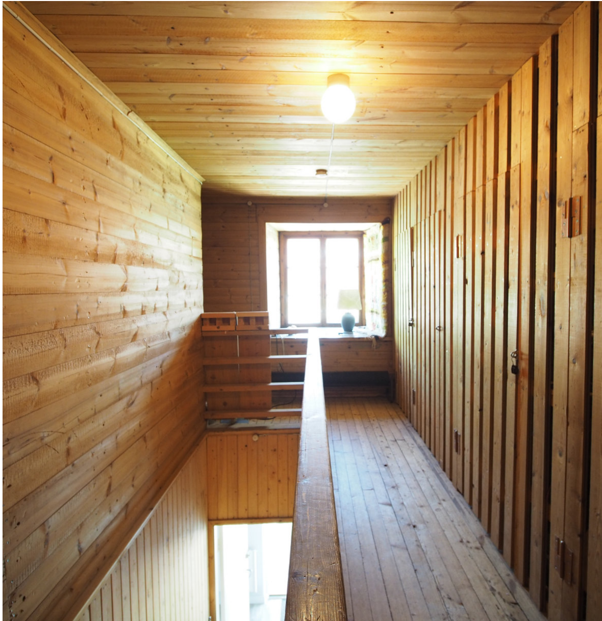
Kuva 72. Ullakko on kapea tila, jossa on nykyään asukkaiden varastoja.
