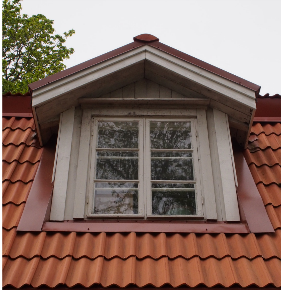
Kuva 58. Ullakkoikkuna ulkopuolelta. Ikkunalla on yksinkertaiset vuorilaudat, jotka on maalattu muun ikkunan tavoin valkoiseksi eroten muista Vaasanlinnan ikkunoista, jotka ovat ruskeita.
