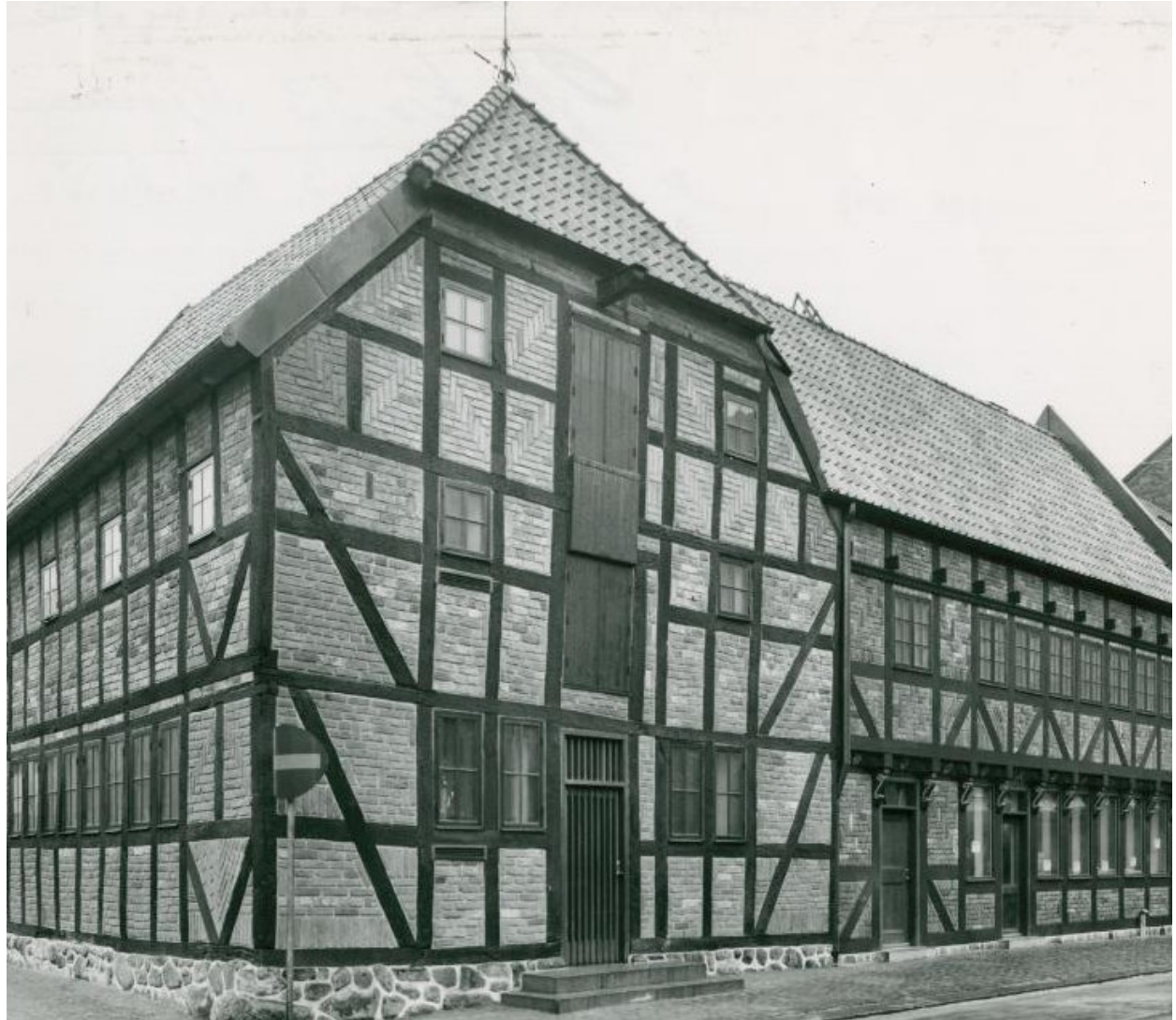
Kuva 4, Tiilitäytteinen korsvirkekaupunkitalo Malmössä Ruotissa. Kuva otettu vuonna 1964.
