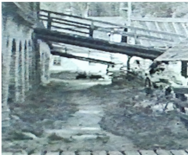
Kuvassa 7d, Näkymä panimon edestä kohti pohjoista, tiilikuivaamon maasilan alitse.
