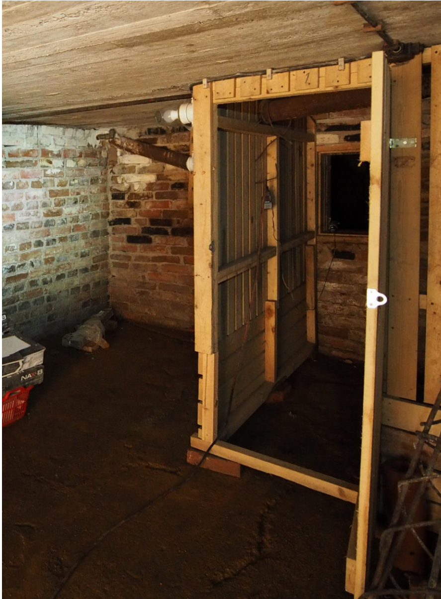
Kuva 49. Kellari luoteeseen. Taka-alalla luukku josta voi kurkistaa alapohjaan.
