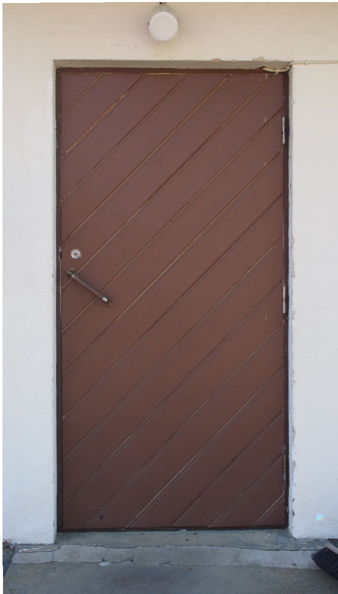
Kuva 51. Itäjulkisivun ovesta on vinopanelointi.
