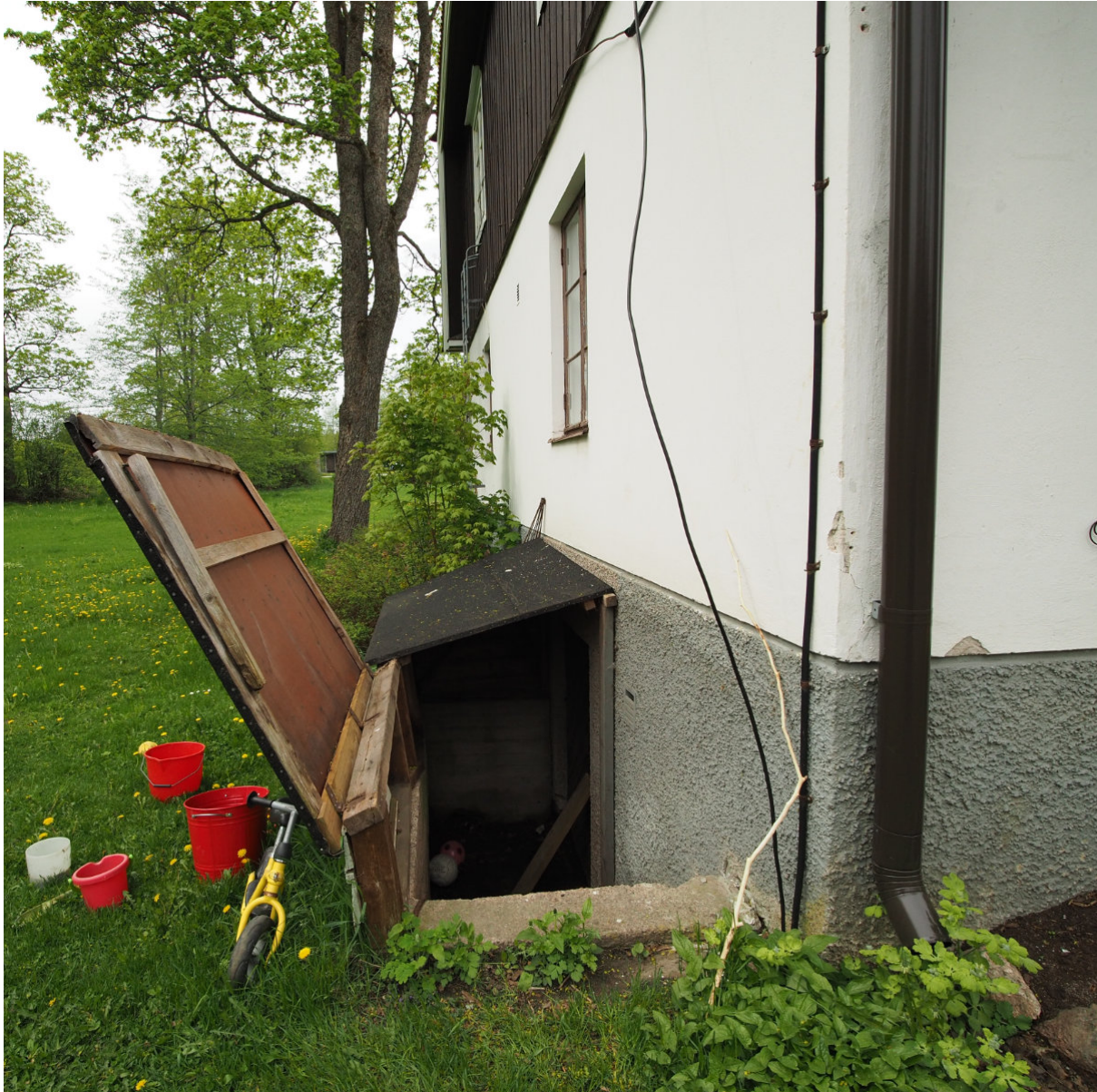
Kuva 47. Käynti kellariin rakennuksen eteläpäädyssä.
