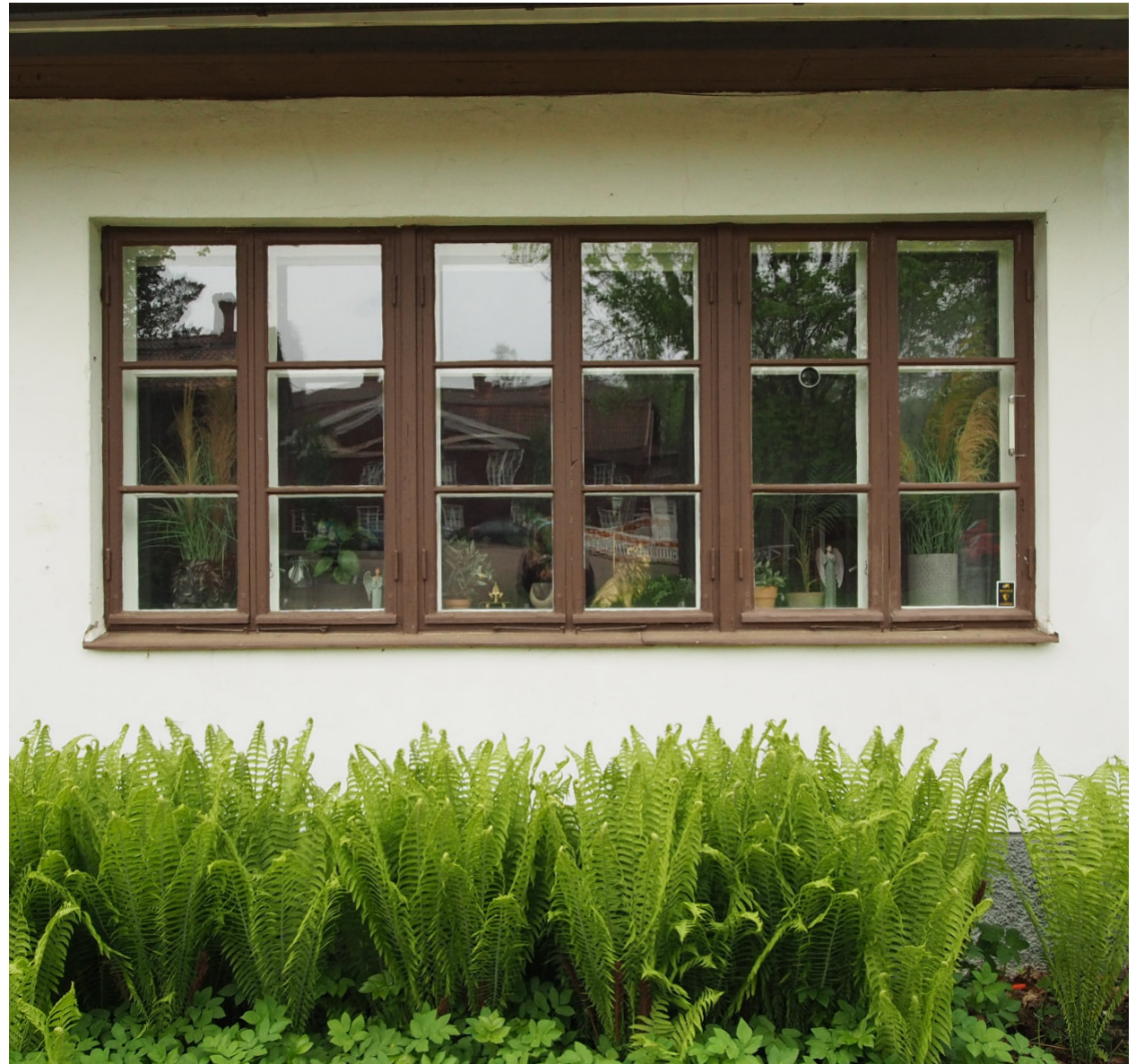
Kuva 53. Itäjulkisivun pohjoisempi maisemaikkuna on tehty asettamalla kaksipuitteisia ikkunoita rinnakkain.
