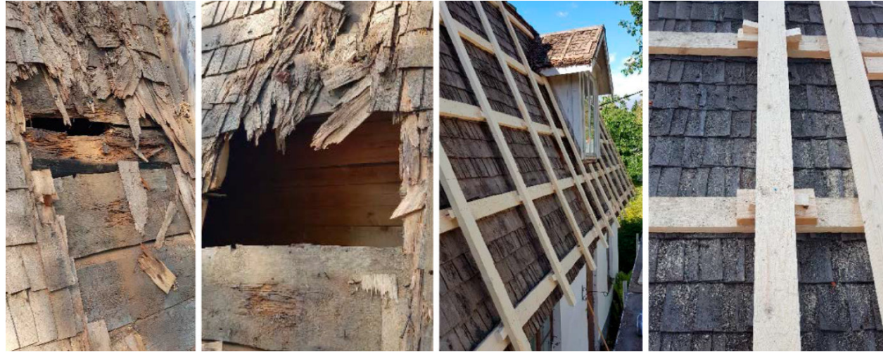
Kuva 33. Rakentaja-lehden kuvia pärekatteen jättämisestä uuden katteen alle.
