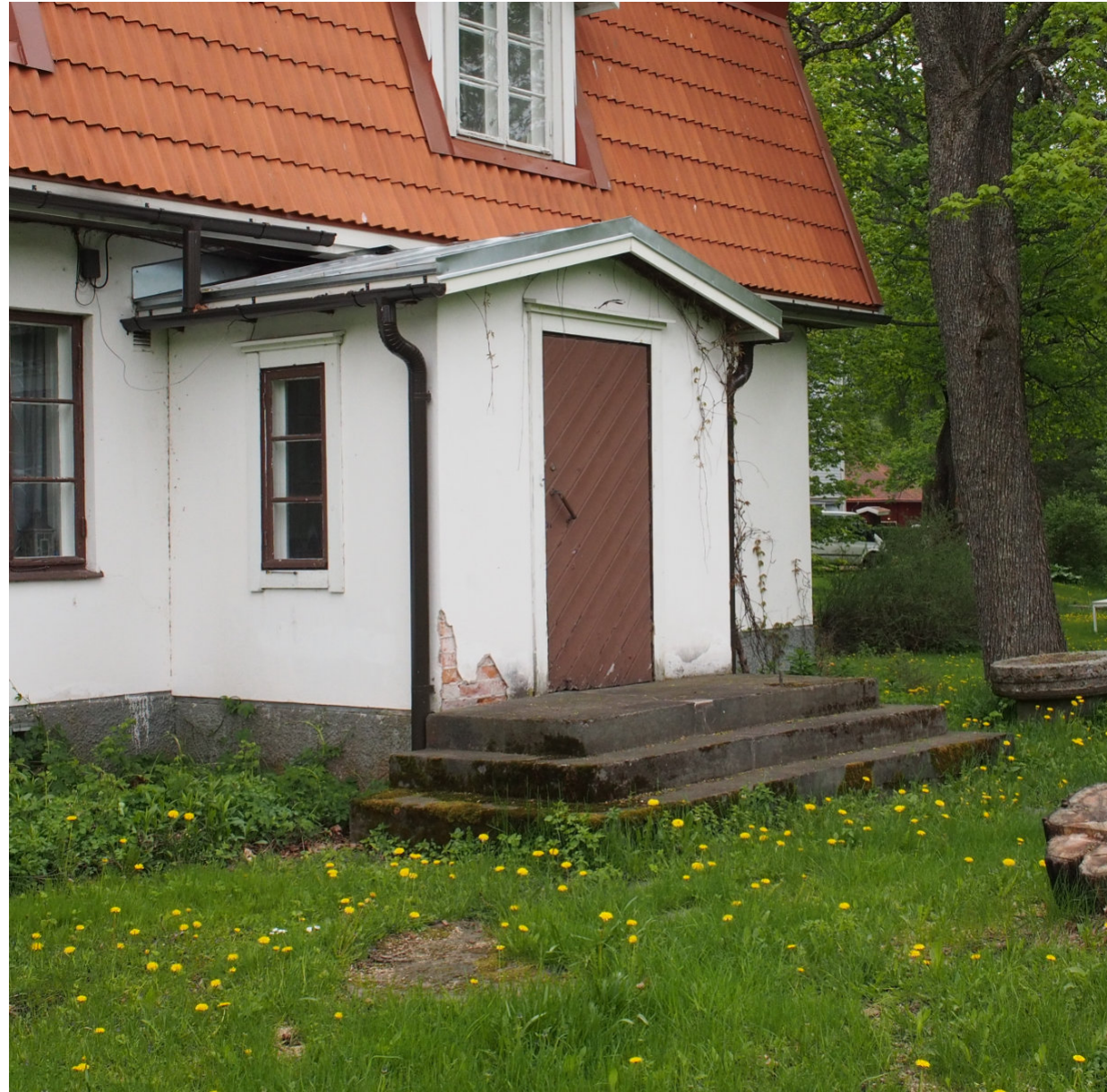
Kuva 64. Länsipuolelle tehty asuntoon 1 johtava veranta. Veranta on tiilirakenteinen.
