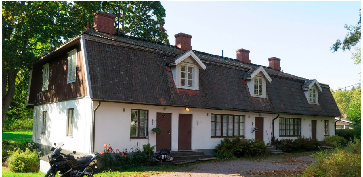
Kuva 34. Vaasanlinna ennen vuoden 2015 kattokorjausta.
