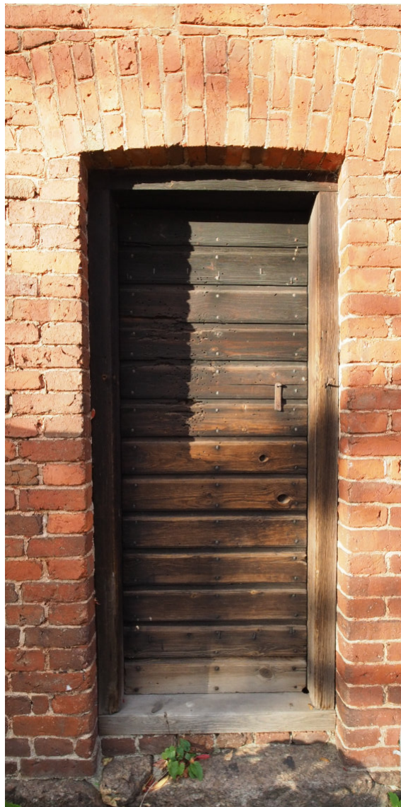
Kuva 61, Eteläjulkisivun sisäänkäynti. Oven kaikki helat ovat takorautaisia. Oviaukko on ainoastaan 77cm leveä. Ulkopuolen vedin puuttuu.
