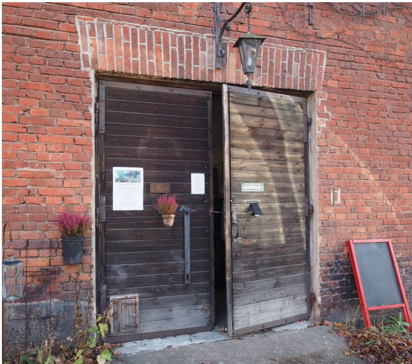
Kuva 63, Pohjoisfasadin 1950-60-luvulla laajennetut kaksoisovet. Oven laajennus näkyy selkeästi sen yläpuolelle tehtynä suorana tiilimuurauksena. Myös ovea kannattelevat saranat ovat tyypiltään 1950-luvun vaiheilla ruukissa käytetyt.
