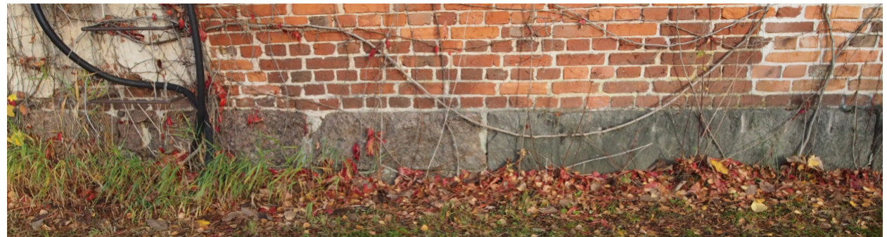
Kuva 42, Läntinen julkisivu, pohjoispääty. Kivijalan kivissä on eroa kohdalla, joka voisi kuulua vuoden 1846 pajan perustukselle (vasemmalla). Oikealla vuoden 1857 pajan perustus.
