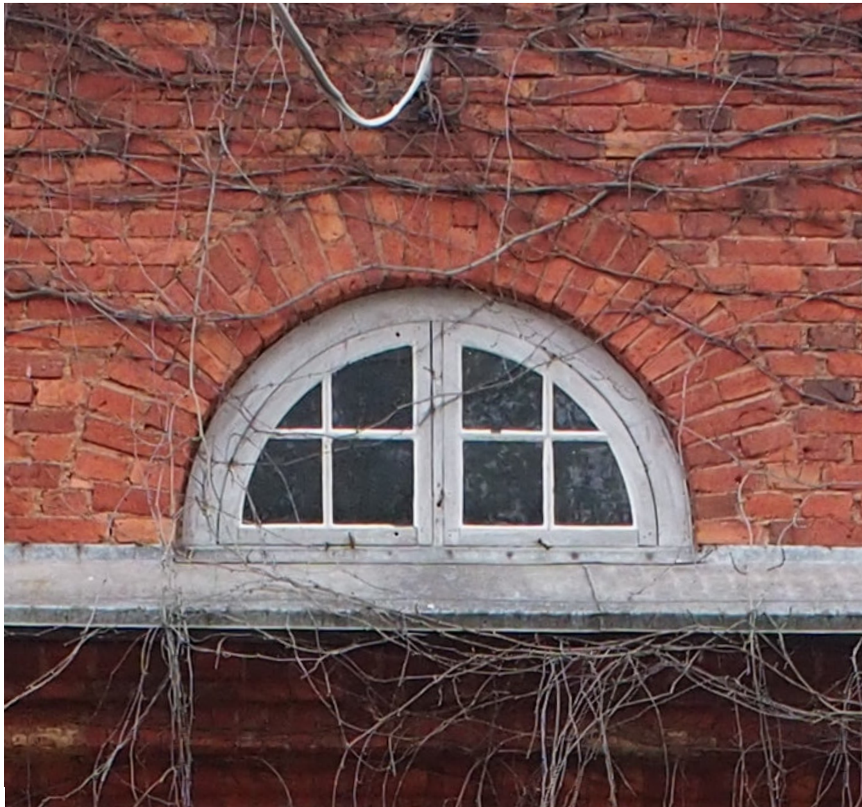
Kuva 56, Pohjoisjulkisivun ullakon puolikaari-ikkuna on kahdeksanruutuinen ja sillä on valkoiseksi maalatut puupuitteet, jotka on koottu puunauloin. Ikkunalla on yhden tiilen levyinen kevennyskaari.
