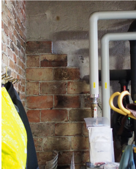
Kuva 53, Lämpökeskuksen eteläseinä. Kaariaukko on muurattu umpeen.
