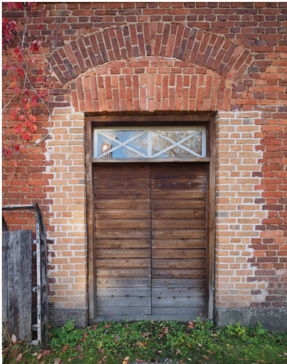
Kuva 67, Itäjulkisivun eteläinen sisäänkäynti, joka rekonstruoidiin 1990-luvun korjauksessa pohjoisen oven mallin mukaan. Aikaisemman oven leveys erottuu selkeästi korjausmuurauksen värissä.
