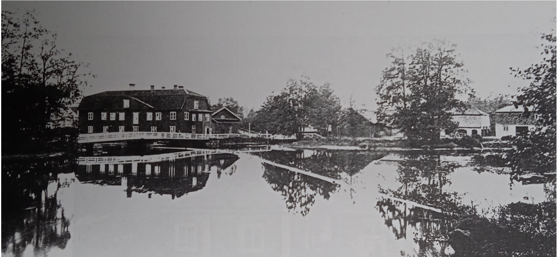
Liite 1. Näkymä tammen yli kohti länttä. Vasemmalla Armonlinna ja sen takana Yläpaja, jonka pohjoispäädyssä on vielä katos. Yläpajan takana näkyy pieni pala maasiltaa, joka johti Yläpajan länsipuolella sijainneeseen hiilivarastoon. Eniten oikealla Tallin eteläpääty ja sen vasemmalla puolella 1950-luvulla purettu tiilikuivaamo. Keskellä kuvaa oleva harjakattoinen rakennus liittyy 1950-luvulla purettuun tiiliruukkiin. MV/KYP, 29.11.1994, sivu 10.
