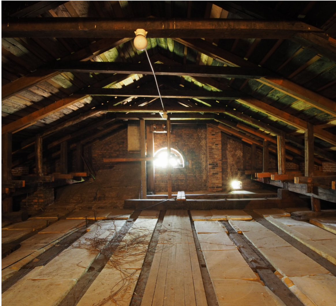
Kuva 36, Yläpajan ullakon pohjoispääty, naulapajan välipohja. Päädyssä näkyy vasemmalla smirgelihuoneen holvikaton muusta aroava tiilirakenne, johon itä-länsisuuntaiset vasat ilmeisesti nojaavat. Vasemmalla näkyvä muurirakenne saattaa olla vuoden 1846 alkuperäisen pajan tiilimuurausta tai vaihtoehtoisesti 1857 ulkoseinämaa ennen laajennusta. Kohta on poikkeuksellinen, sillä vesikattorakenne nojaa tässä suoraan tiilimuriin hirsitun sijaan. Kuvan pääty on 1860-70-luvun laajennuksesta. Vesikaton viimeinen kattotuoli uppoo päätytiiliseinänsä kokonaan.
