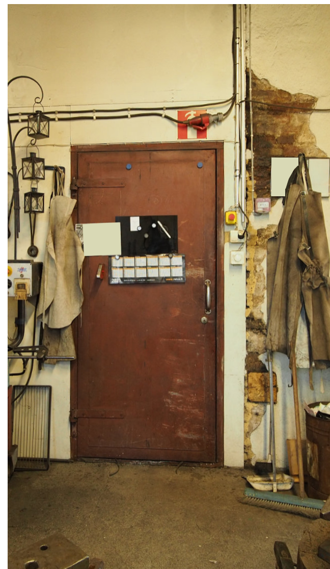
Kuva 66, Nykyisen korjauspajan ja lämpökeskuksen välinen palo-ovi on samanlainen kuin lämpökeskuksen ja varaston välinen ovi. Oven pielessä rakenteessa on erikoinen kohta, jossa 1846/1857 vuoden tiilimuuri kohtaa 1900-luvun uudisrakenteet.
