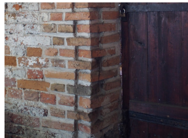
Kuva 39, Ovenpielen tiilimuuraus on palautettu ennalleen. Kuvassa itäjulkisivun eteläinen sisäänkäynti.
