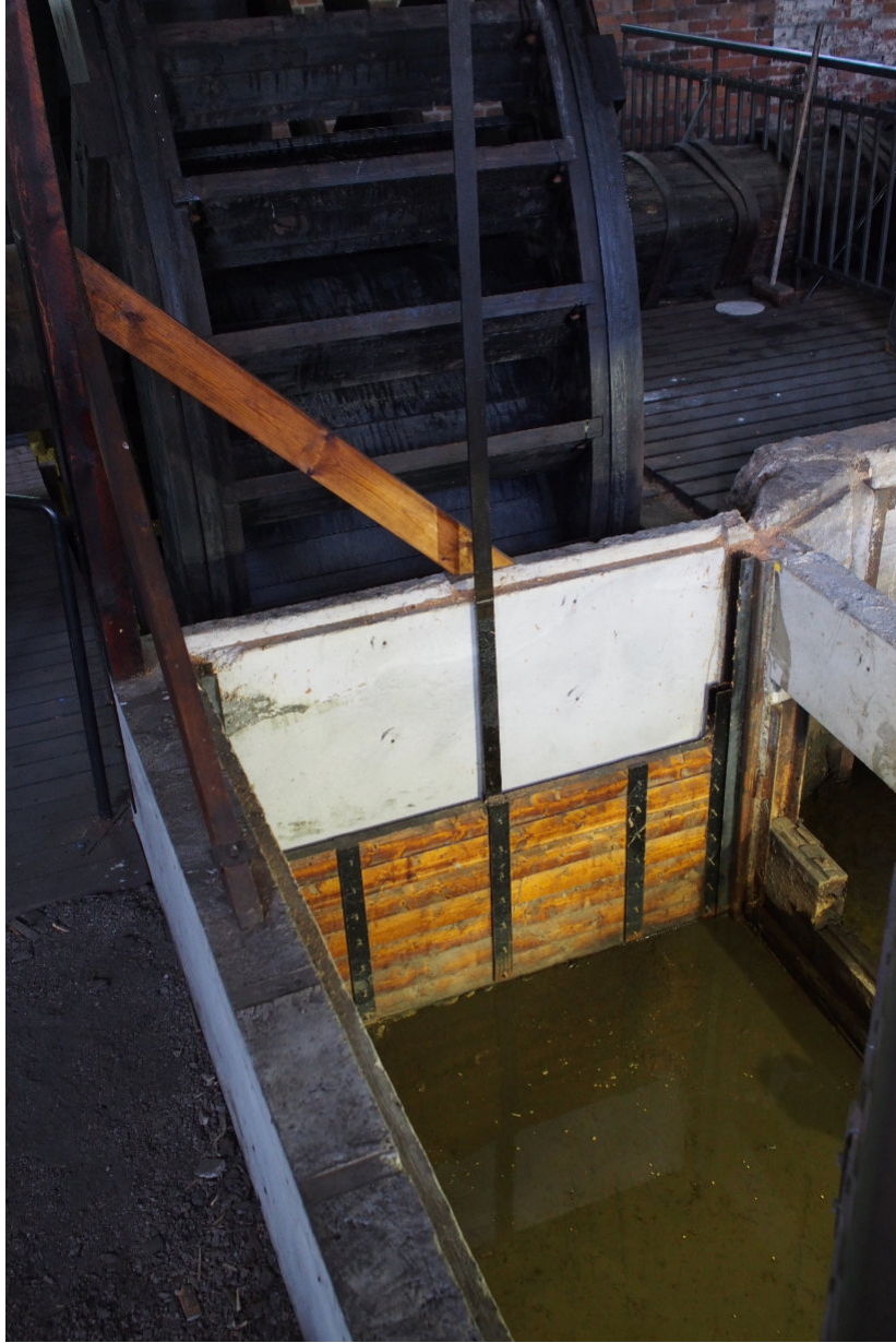
Kuva 45, Nippuvasarajin ränni, sulkuluukku vesipyörälle.
