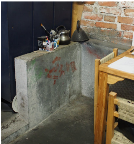
Kuva 54, Lämpökeskusta kiertää matala betoninen vanhan öljysäiliön kaukalo.
