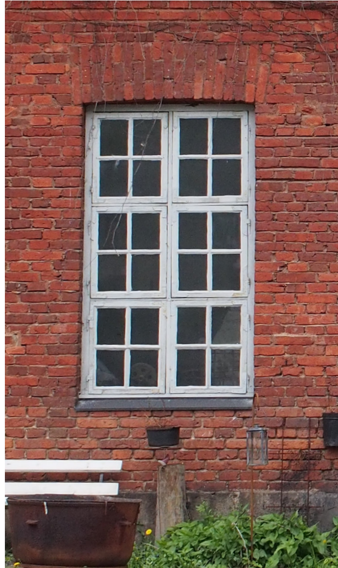
Kuva 58, Pohjoisjulkisivu, itäinen ikkuna (1860-70l). Ikkuna ei eroa rakenteeltaan muista Yläpajan 24-ruutuisista ikkunoista.
