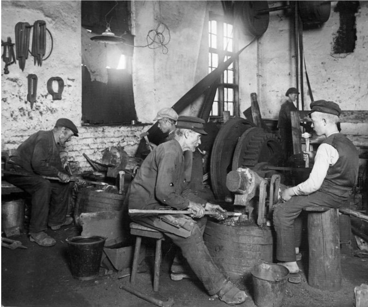
Kuva 14, 1900-luvun alku, naulapaja, kuva kohti etelää. Kaksi seppää apupoikineen takoo nauvoja. Valta-akseli näkyy pajan katossa ja siitä lähtevät hihnat liittyvät naulavasaroihin. Valvojan koppia ei ole vielä rakennettu, eikä pajojen välisessä seinässä ei ole vielä oviaukkoa. Sen sijaan seinän yläosassa on aukko, josta on mahdollisesti johdettu hihna nippuvasarapajan puolelle. Kuvassa Per Forsberg (apupoika), seppä Forsberg, taka-alalla seppäpoika Vikberg ja Yrjö Sulin sekä apupoika Väinö Forssten.
