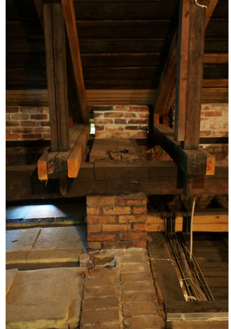
Kuva 37, Kattotuoli nojaa tiilimuurin myös itäpuolella yhdessä kohtaa, joka on aikaisemman tutkimuksen valossa säilynyt osa vuoden 1846 pajarakennetta. Kannattavan osan ja seinärakenteen tiilissä on eroa, joka voi viitata siihen, että muurausta jatkettiin vuonna 1857 tai 1860-70-luvulla kun kattorakennetta uudistettiin (-57) tai laajennettiin (60-70l).
