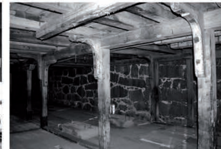
Alakerrassa näkyvät kivinen tukimuuri ja välipohjan jyrkeät puupalkistot
