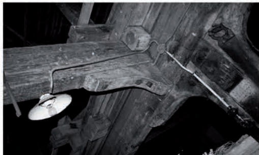
Juurakkokonsolien alla osa lampuista on säilynyt pintavetoineen, aika sahalla on pysähtynyt
