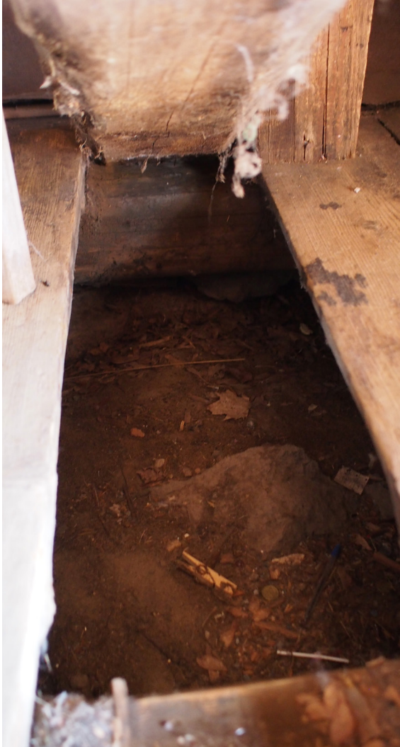
Kuva 36. Maapohja eteläisessä aitassa.
