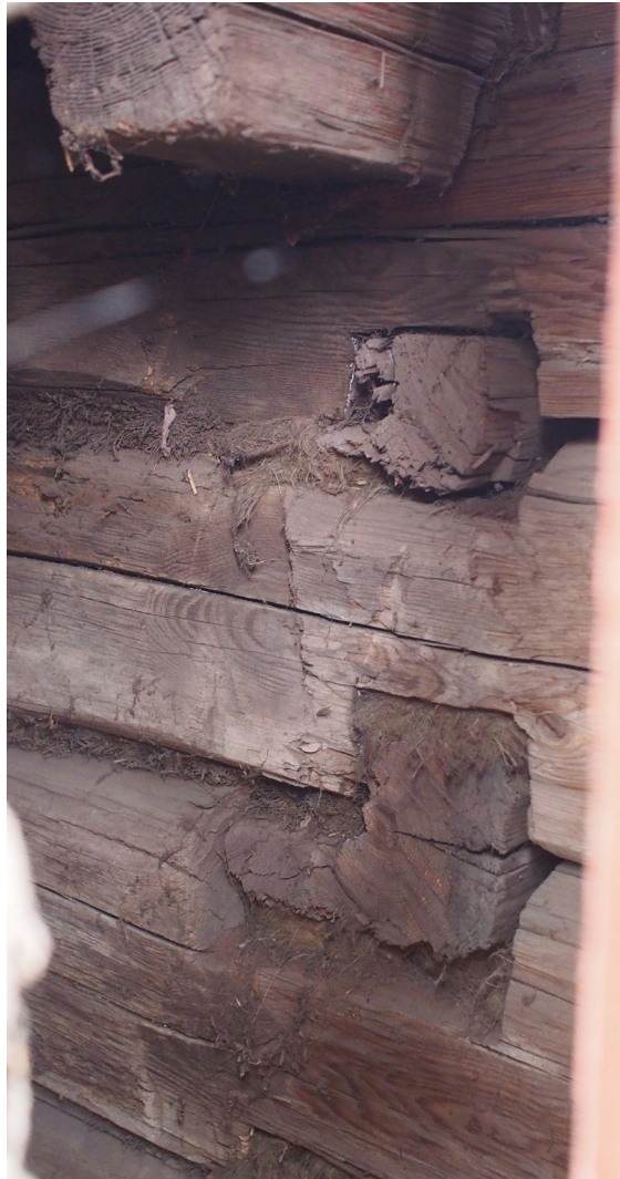
Kuva 91. Salvosten päät on katkaistu todella lyhyiksi. Katkaistu osuus on matalampi, kuin etelävälissä.
