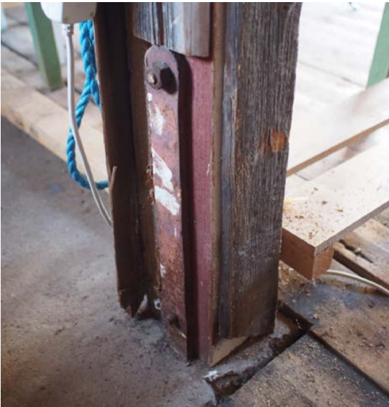
Kuva 77. (yllä). Tornin rakenne kulkee läpi välipohjan. Kuva 78 (alla). Tornin pilari betoniperustuksella.
