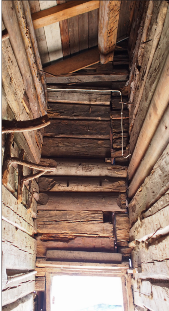
Kuva 39. Etelävälikön länsiseinä. Hirsikehikkojen päädyt liittyvät toisiinsa vaihtelevilla tavoilla. Seinissä näkyy erilaisia hirsityypppejä.
