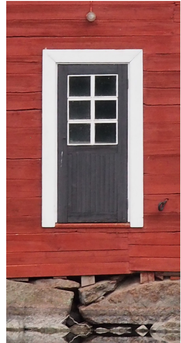
Kuva 55. Ovi idästä. Oven yläpuolella on lamppu, joka ei ole enää käytössä.
