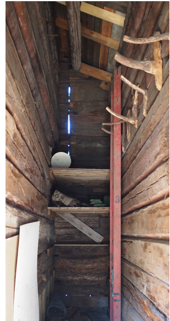
Kuva 87. Välikön päädyssä on kiintokalustehyölyjä. Vanhat paloaseman tikkaat roikkuvat seinällä.
