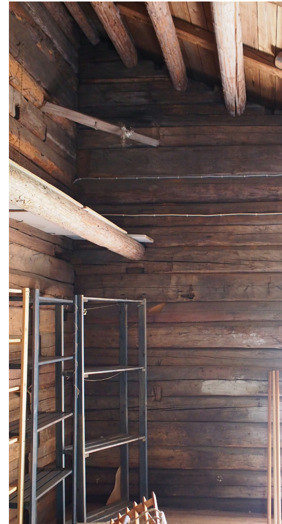
Kuva 94. Etelä- ja länsiseinän nurkassa on kulmatuki. Samalta kohtaa alempaa löytyy jälkiä vastaavanlaisesta tuesta.
