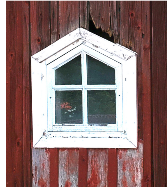
Kuva 46. Tornin ylin ikkuna länteen.
