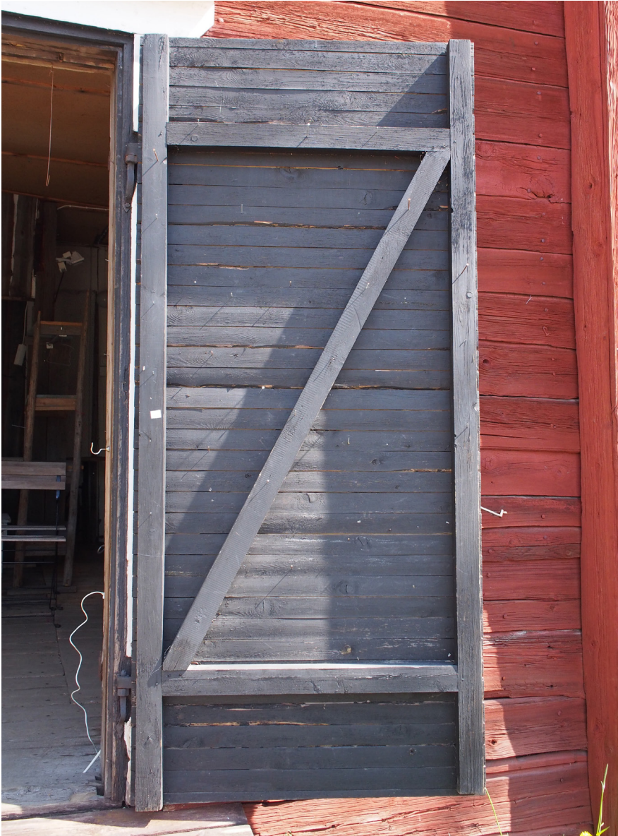
Kuva 56 (vas). Eteläisen puolen oven rakenne.
