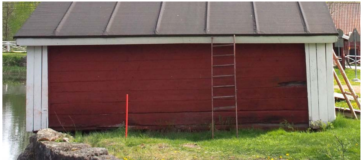
Kuva 41. (yllä). Eteläjulkisivussa on rimalautaverhous ja kiinnikkeet sahan toiminnan aikaisille tukinuittoseipäille. Kuva 42 (alla). Pohjoisjulkisivussa on vaakalautaverhous. Verhouksessa on paikoittain suuria lahovaurioita.
