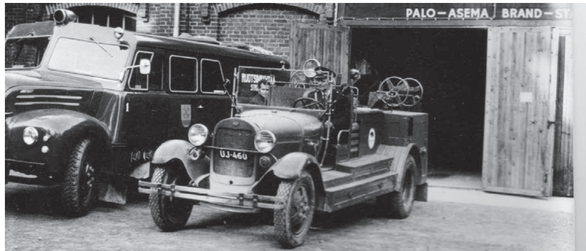
Kuva 24. Vanha makasiinissa palvellut paloauto 1960-luvulla alapajaan siirtyneen paloaseman edessä.
