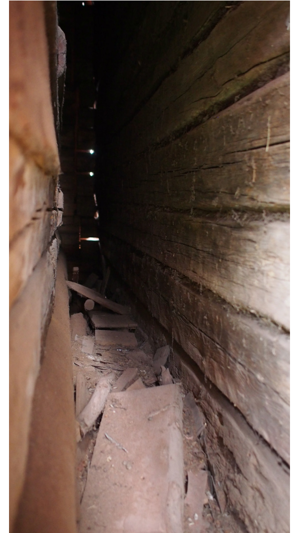
Kuva 92. Laudan rakosesta otettu kuva pohjoisväliköstä. Pohjalla on runsaasti vanhaa puutavaraa ja mahdollisesti rakennusjätettä.
