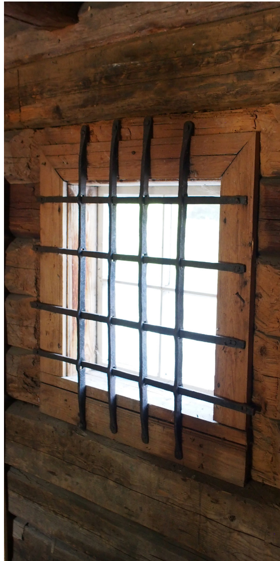
Kuva 51. Pohjoissiiven ikkunan takorautakalteri.
