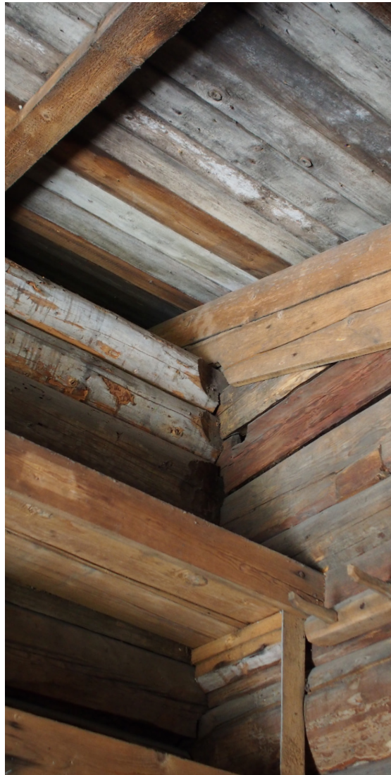
Kuva 82. Eteläsiiven pohjoisseinä ei ulotu vesikattoon. Kuvan alareunassa näkyy osa itsestään naulakkoa.
