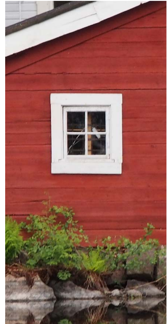
Kuva 52. Eteläsiiven ikkuna joelta.
