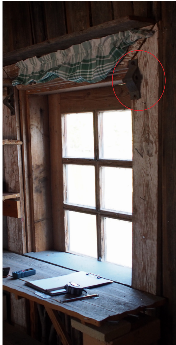
Kuva 54. Oven pielipuissa on yhä jäljellä letkurullan helat.
