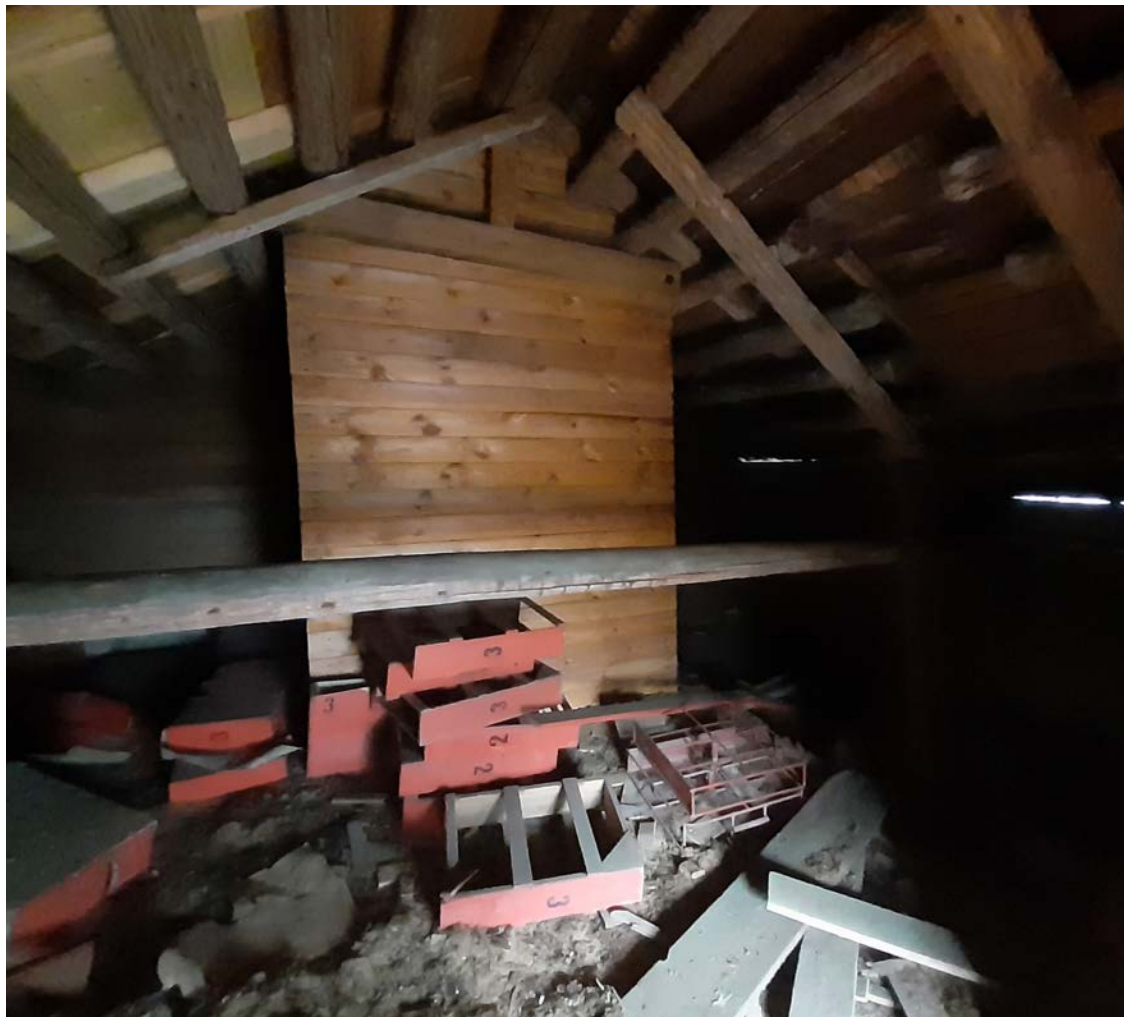
Kuva 71. Näkymä ullakolle ovelta. purun joukossa on erilaisia puun kappaleita sekä punaisia puisia letkujen säilöntälaatikoita. Tornin rakenne halkaisee tilan.
