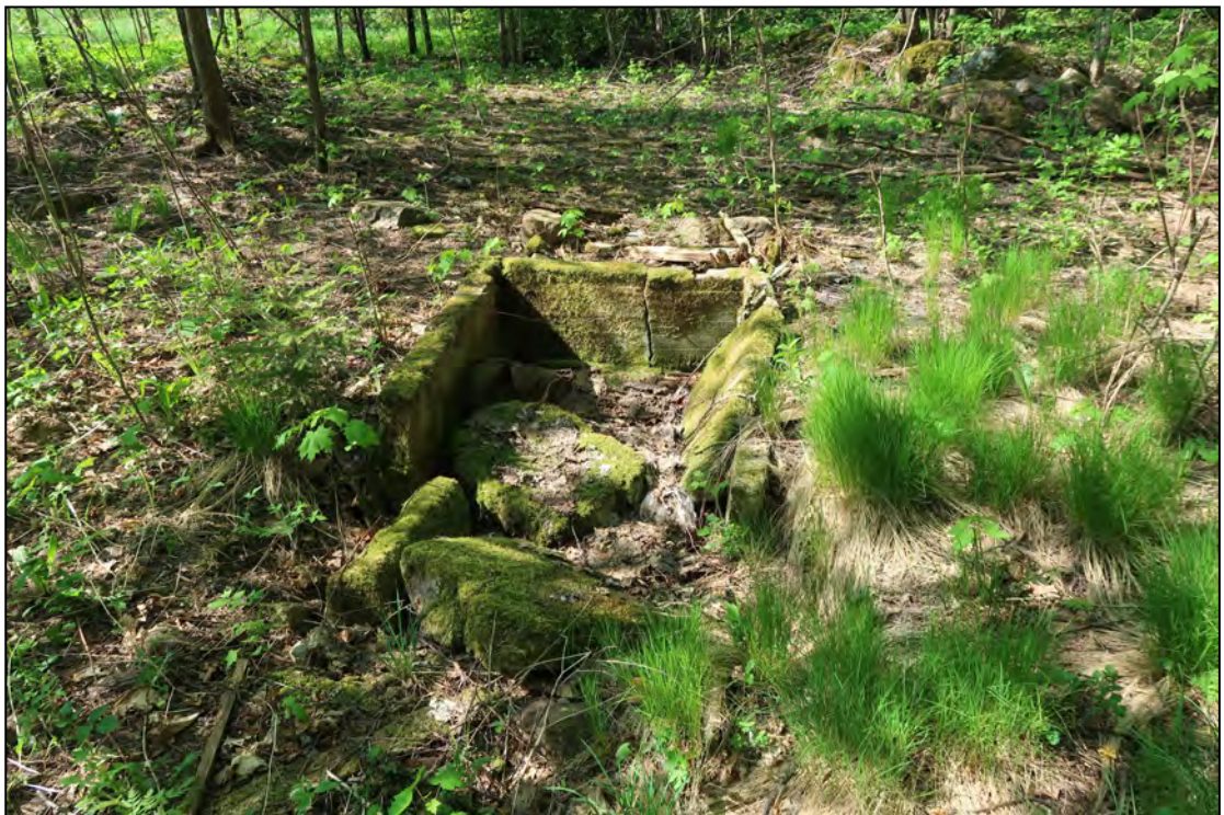
Kuva 9. Betonisokkeli rakennuksen 017 kohdalla. Kuva: Museovirasto AKDG5503:11. John Lagerstedt, 2018.
