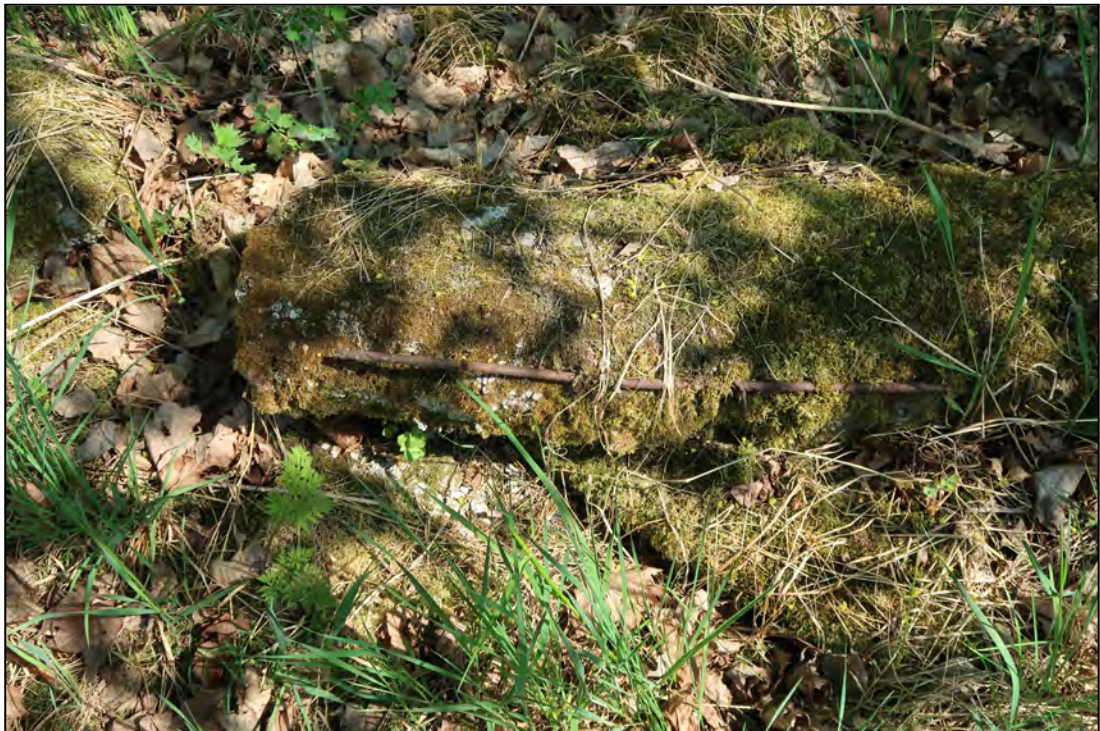
Kuva 8. Betonirauδοitus sokkelissa rakennuksen 014 kohdalla. Kuva: Museovirasto, AKDG5503:7. John Lagerstedt, 2018.
