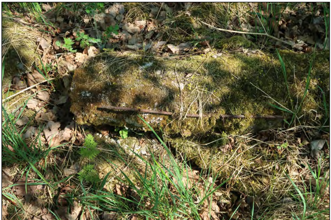
Bild 8. Betongförstärkningen i sockeln vid byggnad 014. Bild: Museiverket, AKDG5503:7. John Lagerstedt, 2018.
