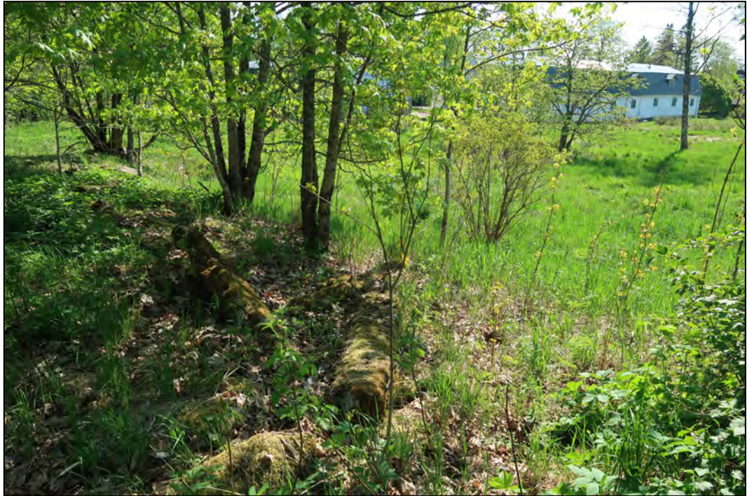
Bild 7. Betongsockel vid byggnad 014. Fotograferad mot öst. Bild: Museiverket, AKDG5503:6. John Lagerstedt, 2018.
