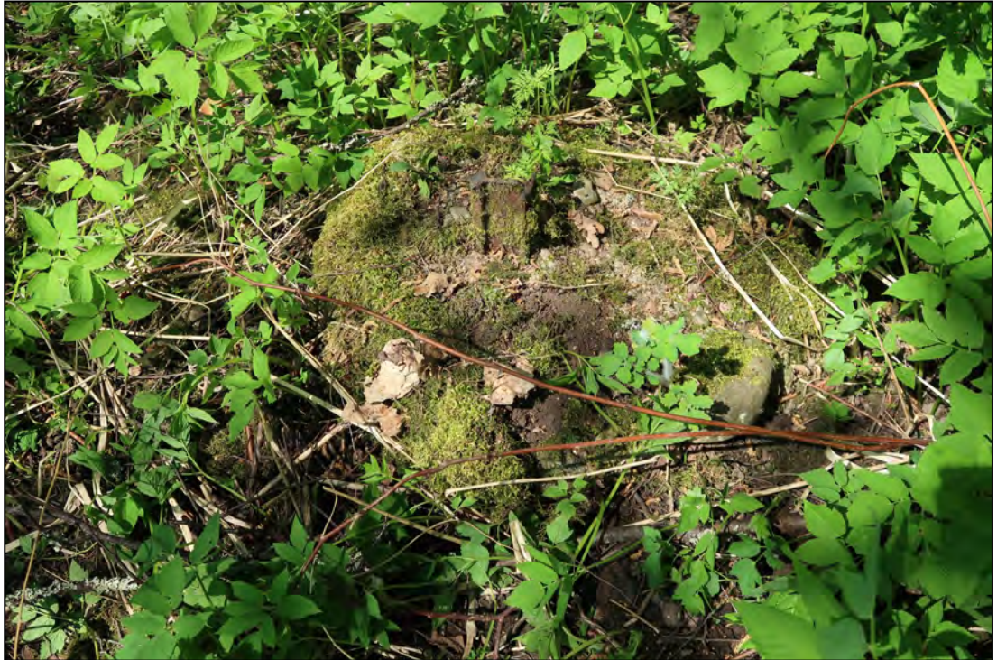
Bild 15. Räls till smalspårad järnväg gjuten upprätt på betongfundament vid vall 021. Bild: Museiverket AKDG5503:18. John Lagerstedt, 2018.
