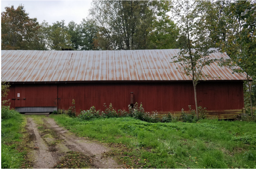
Kuva 20. Varaston pohjoisseinä. Maasto on eteläseinää ylempänä. Kulku varastoon käy liukuoven kautta.
