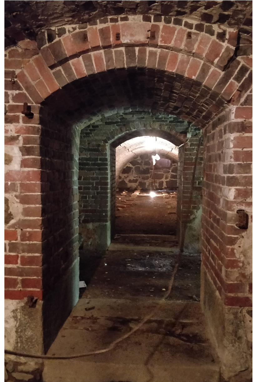
Kuva 40. Näkymä holvista 1 holviin 4. Kussakin holvissa on ollut ovi. Saranatapit ovat yhä paikallaan.
