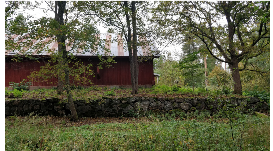
Kuva 17. Rakennuksen eteläjulkisivua kosken puolella. Tukimuuriksi ladot-tu kiviladonta on n. 1,5 m korkea.
