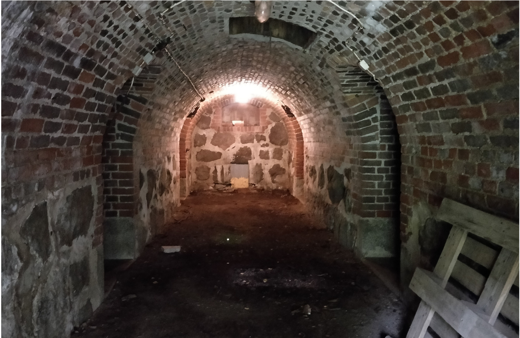
Kuva 32. Näkymä keskellä olevasta holvista, kellarin ovi jää selän taa. Katossa erottuu kookas hormi, joka jatkuu nykyisellään puuvaraston läpi katolle toimien ilmanvaihtohormina. Kuilu on toiminut myös hissikuiluna, josta tarvikkeita on voinut nostaa ja laskea. Tätä varten kuilussa on luukku varastotasolla. Molemmin puolin keskiholvია on kaksi kooltaan samanlaista, mutta eri syvyyistä holvia.
