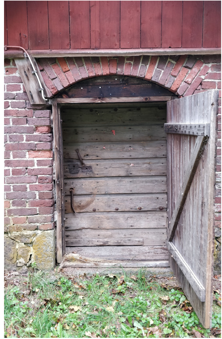
Kuva 31. Sisempi ovi on paksuista pontatuista vaakalankuista tehty, se avautuu sisäänpäin. Kahdella ovella on tavoitettu lämmöneristystä kellarin toimiessa maakellarina.
