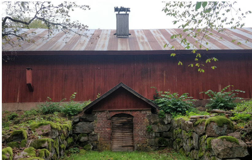
Kuva 16. Kulku kellariin on rakennuksen keskeltä harjakattoisesta siivestä. Katolla näkyy kookas kellarin katosta lähtevä hormi.
