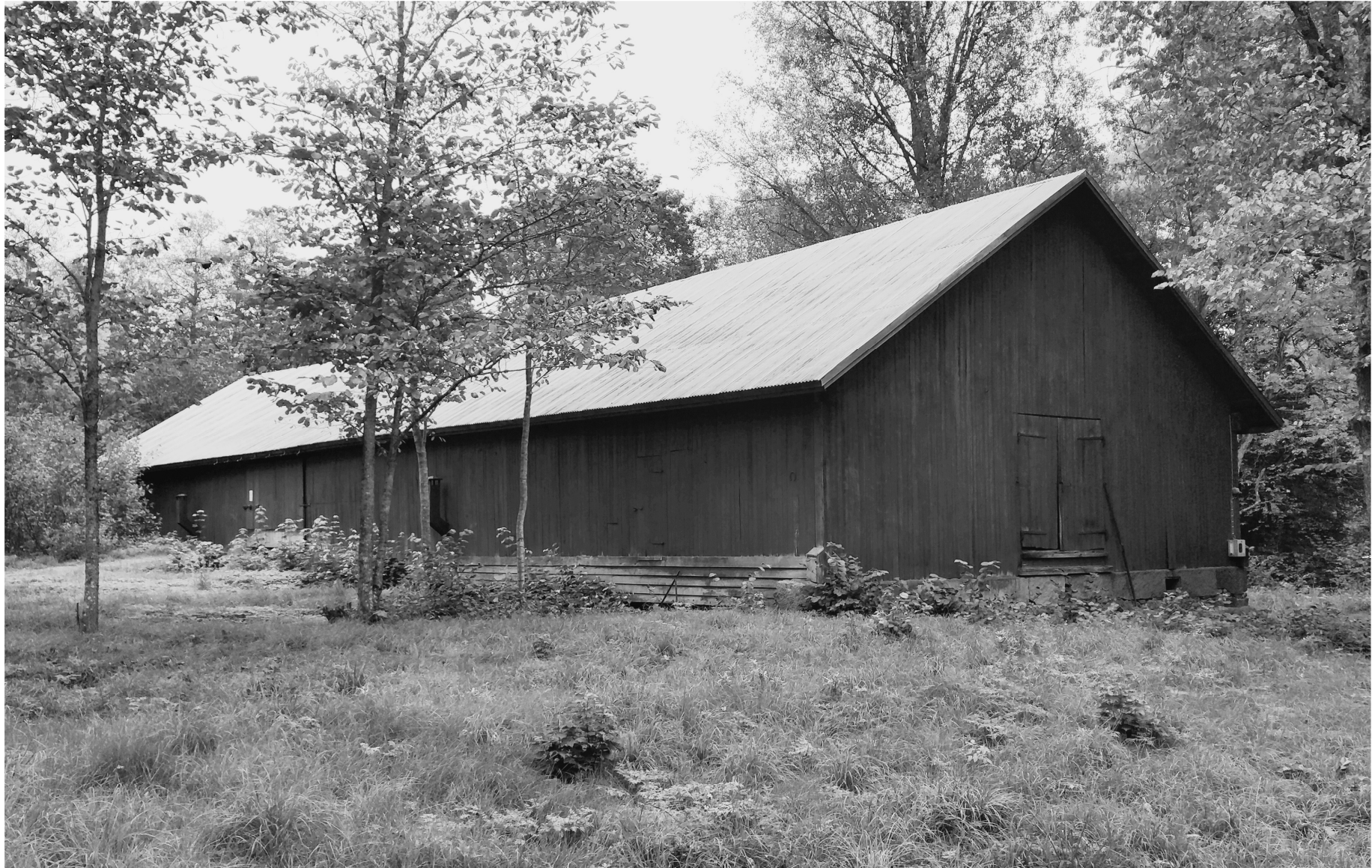
Norrahaan varasto, rakennushistoriallinen selvitys 14.12.2021
