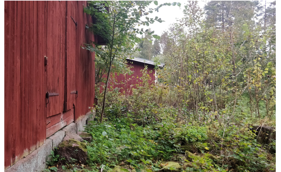
Kuva 29. Itäpäädyn edustalla näkyy perustus kivien jäänteitä kasvillisuuden seassa (oikealla). Takana näkyy pohjoispuolella olevan asuinrakennuksen myöhemmin tehty laajennus.
