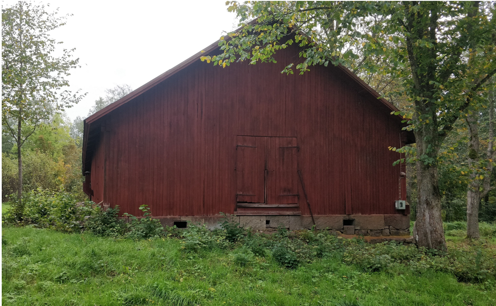
Kuva 24. Rakennuksen länsipäädyssä on pariovi. Sen edessä on ollut ramppi, jota tukenut vaakapalkki on edelleen paikallaan. Kiviperustukset ovat tältä kohdin vaaleammat. Kookkaiden kivien alla on ladottuna pienempiä kiviä. Maasto lienee ajateltu kartanon ympärillä tasaiseksi, jolloin pienemmät kivet olisivat jääneet maan alle piiloon.
