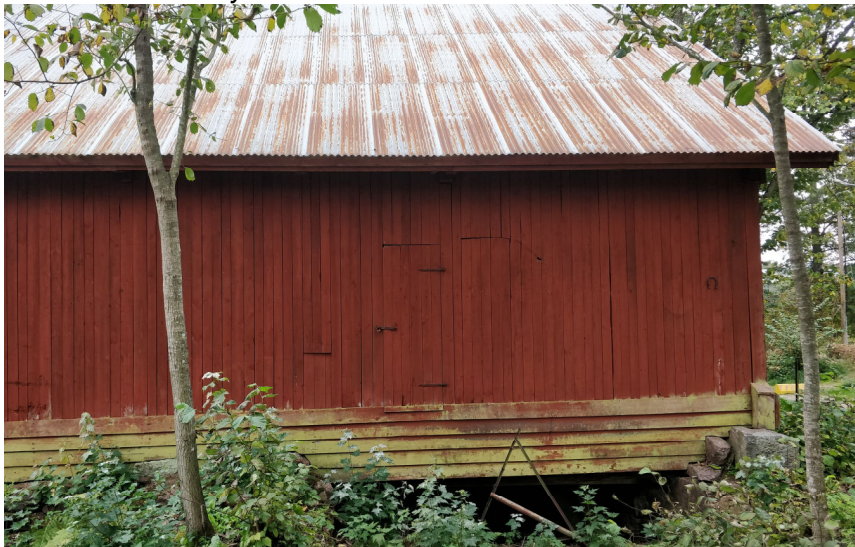
Kuva 21. Pohjoisjulkisivussa erottuu lautaovi ja sen vieressä toinen laudoitettu aukko. U-mallinen perustus on kääntynyt molemmissa päädyissä siiviksi. Nämä osat perustuksesta on purettu.
