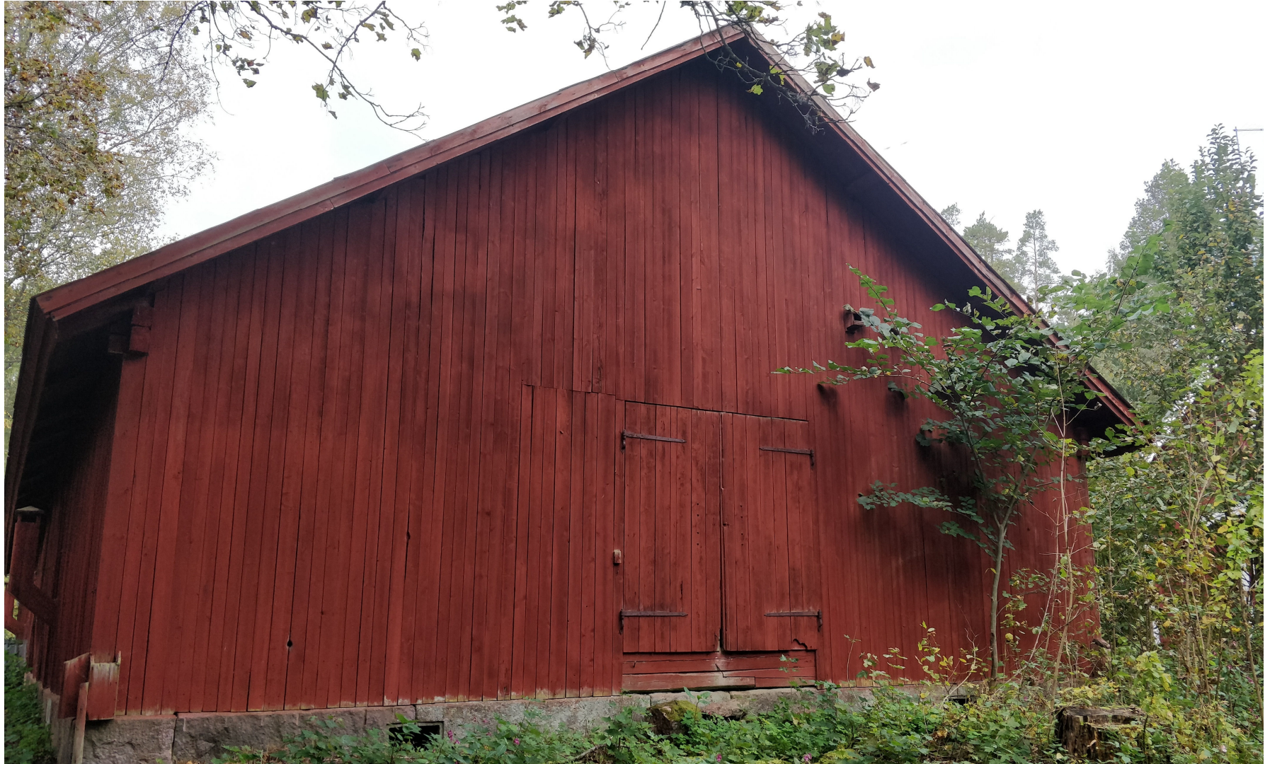
Kuva 25. Rakennuksen itäpäädyn pariovi. Molemmin puolin ovea olleista rakenteista on perustuskiviä jäljellä, julkisivusta ei erotu fragmentteja. Rakennus on maalattu viimeksi 1990-luvun lopulla punamullalla.
