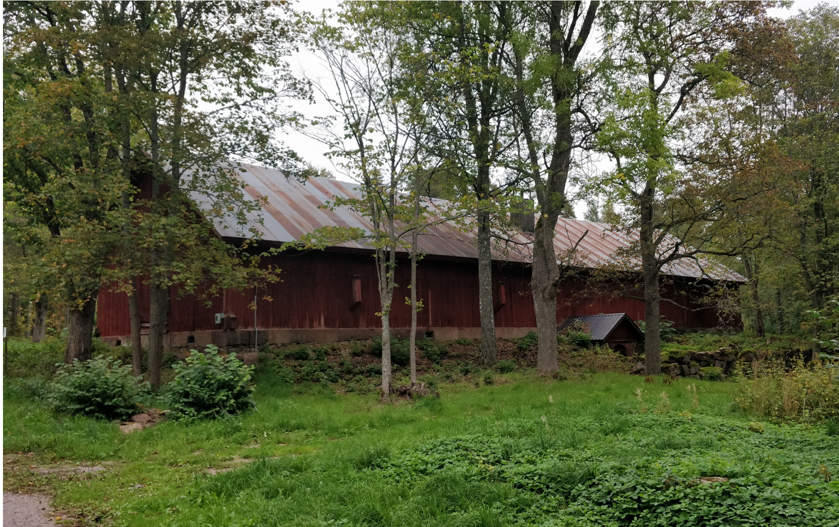
Kuva 14. Näkymä lounaasta. Näkyvillä kivijalkaa on metrin verran, se kätkee kuitenkin sisäänsä kokonaisen kellarikerroksen.
