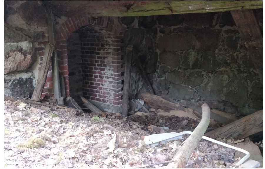
Kuva 22. Pohjoisjulkisivun länsipäädyn alustila. Holvin 2 päässä on ollut kulku toiseen kellaritilaan, joka on jatkunut siipenä pohjoispuolelle.
