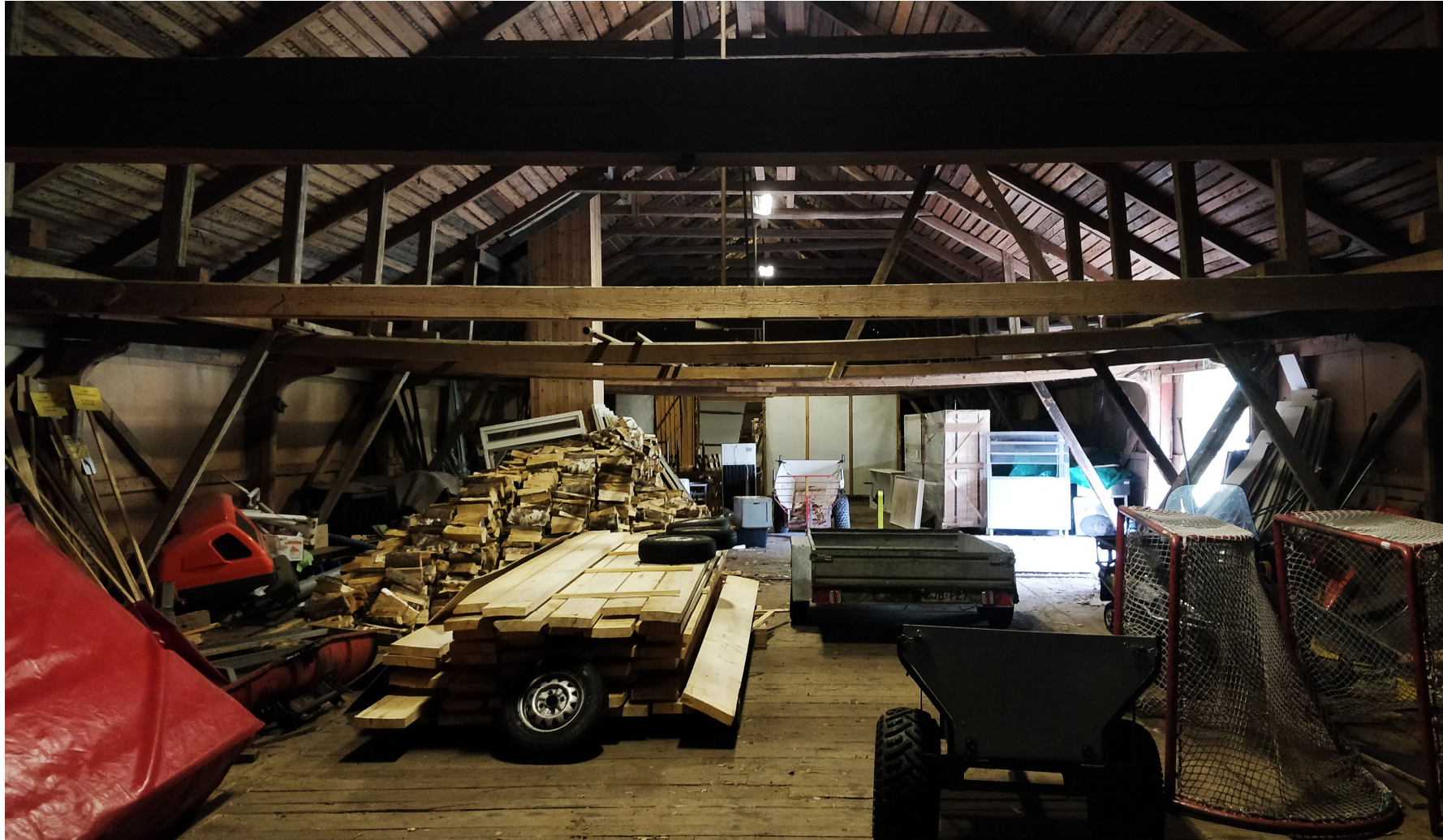
Kuva 41. Ensimmäisen kerroksen sisätillaa länteen päin kuvattuna. Kattotuolit ovat n. 4 m välein. Taaempaa vasemmalla näkyy kookas puinen pystyhormi, joka johtaa kellarin keskellä olevasta holvista vesikatolle. Rakennuksen seinät ovat pystylaudoitettuja. Seinien sisäpuolelle on myöhemmin asennettu kovalevy jolla on tavoiteltu parempaa sääsuojaa. Vanha pärekate näkyy kattolaudoituksen raoista.
