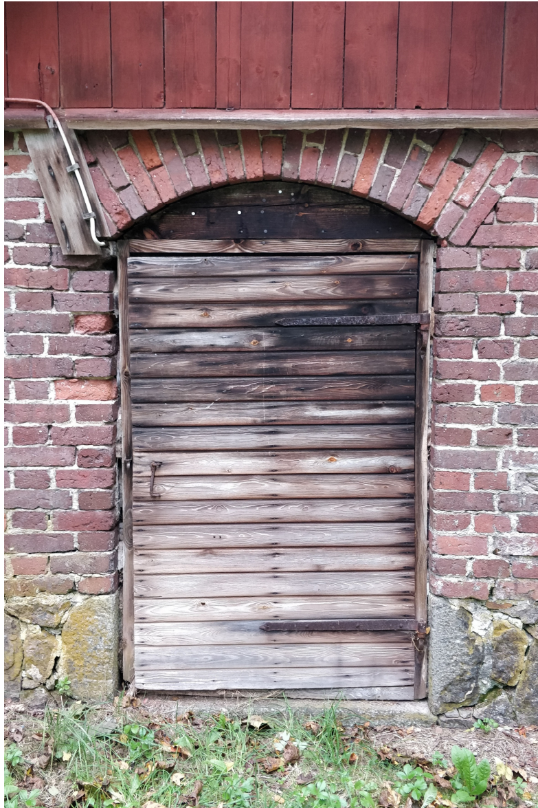
Kuva 30. Kellariin johtava ovi on vaakapaneloitu. Alla on paksut pystylankut.
