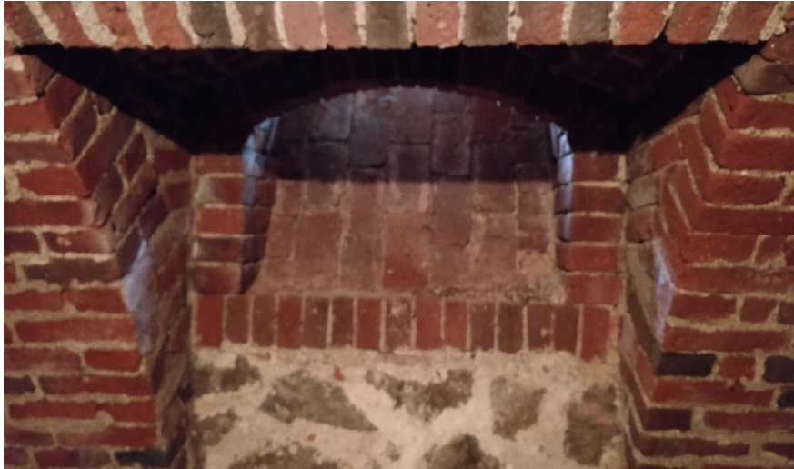
Kuva 38. Kivijalan tuuletusluukkuihin, "kissanluukkuihin" johtavat muuratut aukot on tehty huolellisesti.
