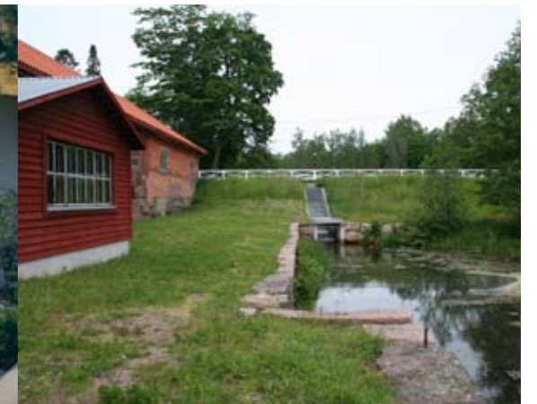
Veden voima ja liike eivät enää näy patoalueella.
