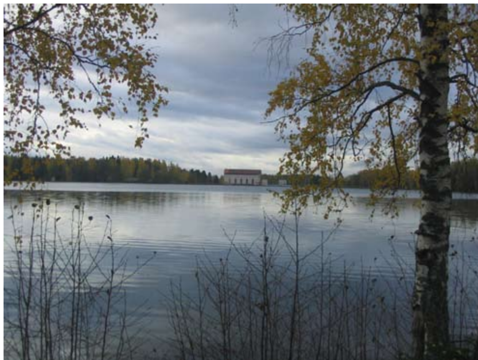
Ahvenkosken voimalaitos sijaitsee "temppelemäisesti" Kymijoen suulla.
