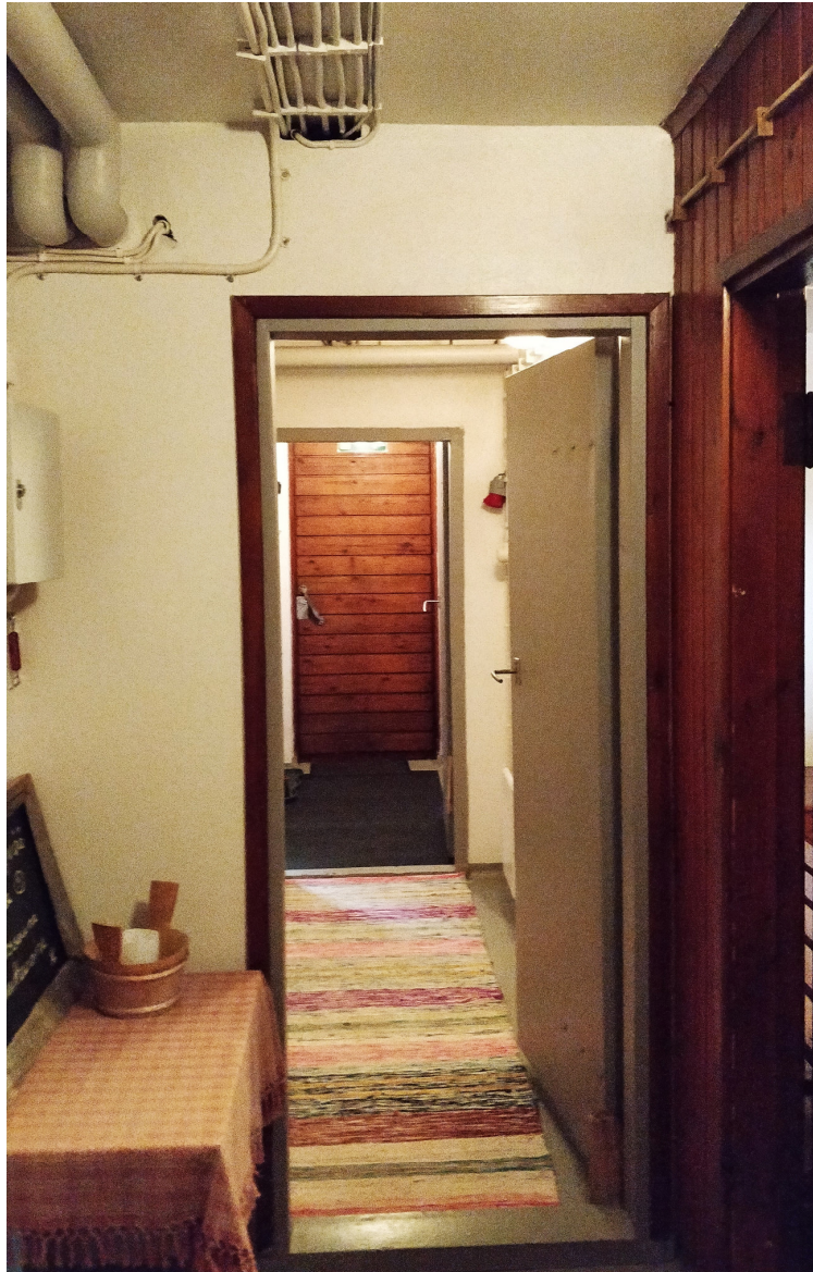
Kuva 34. Näkymä ulko-ovelle entisen kattilahuoneen läpi. Lähinnä oleva seinä on tehty käytävään jälkikäteen ja tila rakennettu palo-ovin omaksi palo-osastoksi. Oikealle jää isompi, kahdesta pukuhuoneesta yhdistetty pukuhuonetila.
