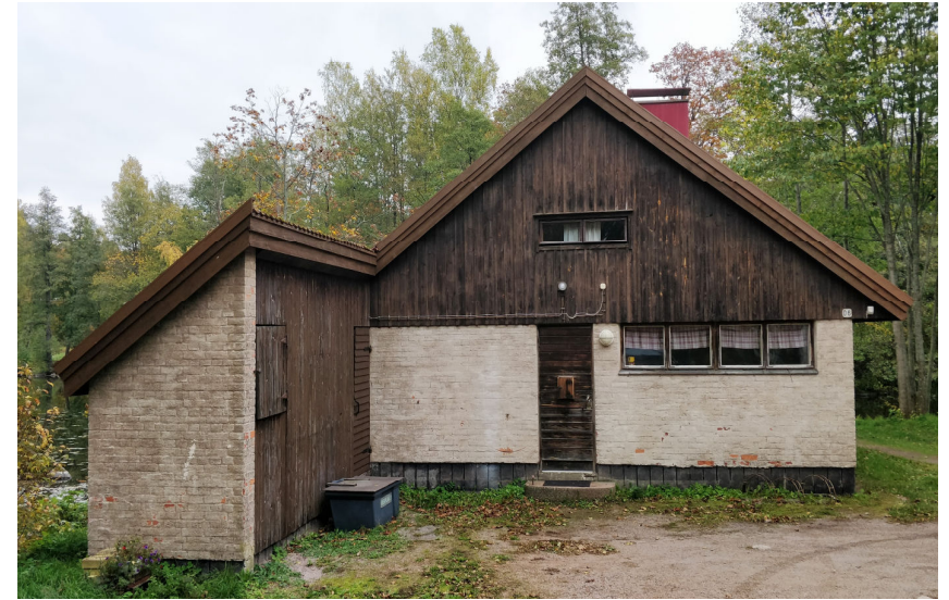
Kuva 14. Saunan länsipääty, vasemmalla halkovarasto.
