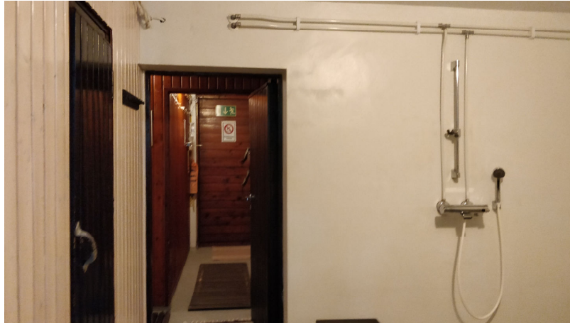
Kuva 36. Pesuhuoneen pinnat on uusittu. Tilasta on käynti käytävän kautta vilvoitteluun (edessä) tai vasemmalle saunaan. Saunan ja suihkun välinen seinä verhottu pystypaneelin, muissa seinissä on märkätilatapetti.
