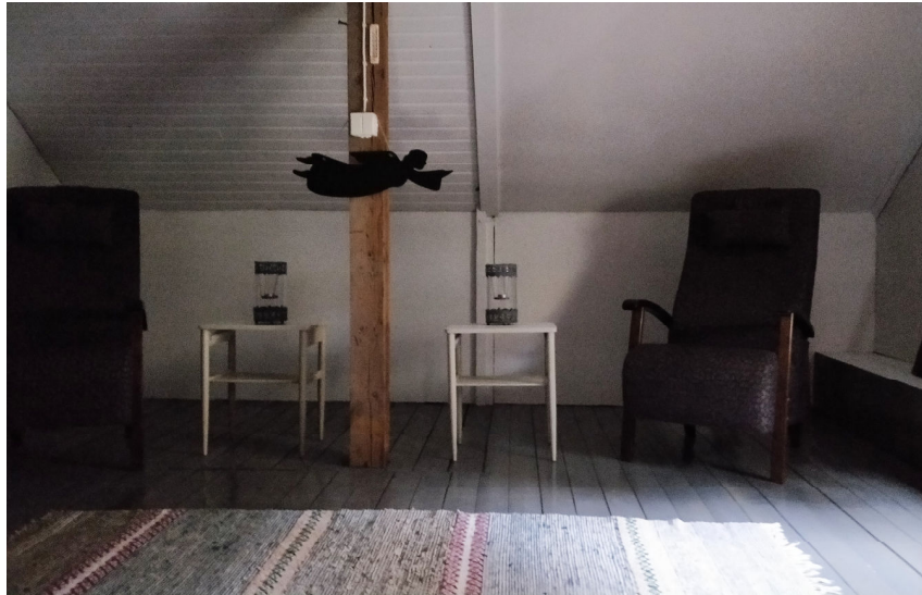
Kuva 43. Näkymä portaasta ullakolle. Osassa kattoa on panelointi, samassa kohtaa lattialaudassa jatkos. Eristetty tila on ilmeisesti aluksi ollut pienempi, sittemmin seinä on tältä osin purettu.
