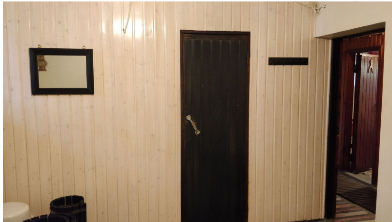
Kuva 37. Saunan ja pesutilan väliseinä. Oikealla avautuu näkymä suuremman pukuhuoneen ovelle.
