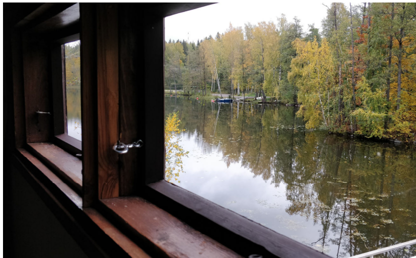
Kuva 48. Ullakon molemmissa päädyissä on ikkunat, jotka on puitteiden osalta kunnostettu. Ikkunat ovat kaksipuitteiset, sisäpuitteet ovat tässä irroitettu.
