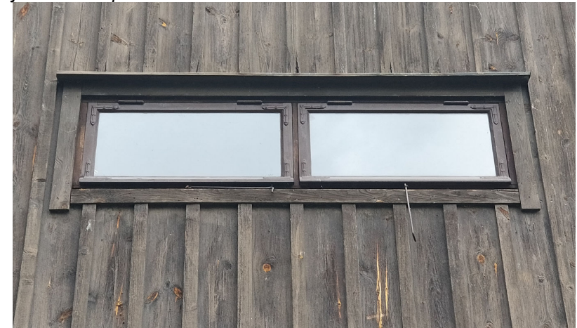
Kuva 25. Yläkerran ikkunat on kunnostettu 2010-luvulla. Muista ikkunoista poiketen maali on peittävä.
