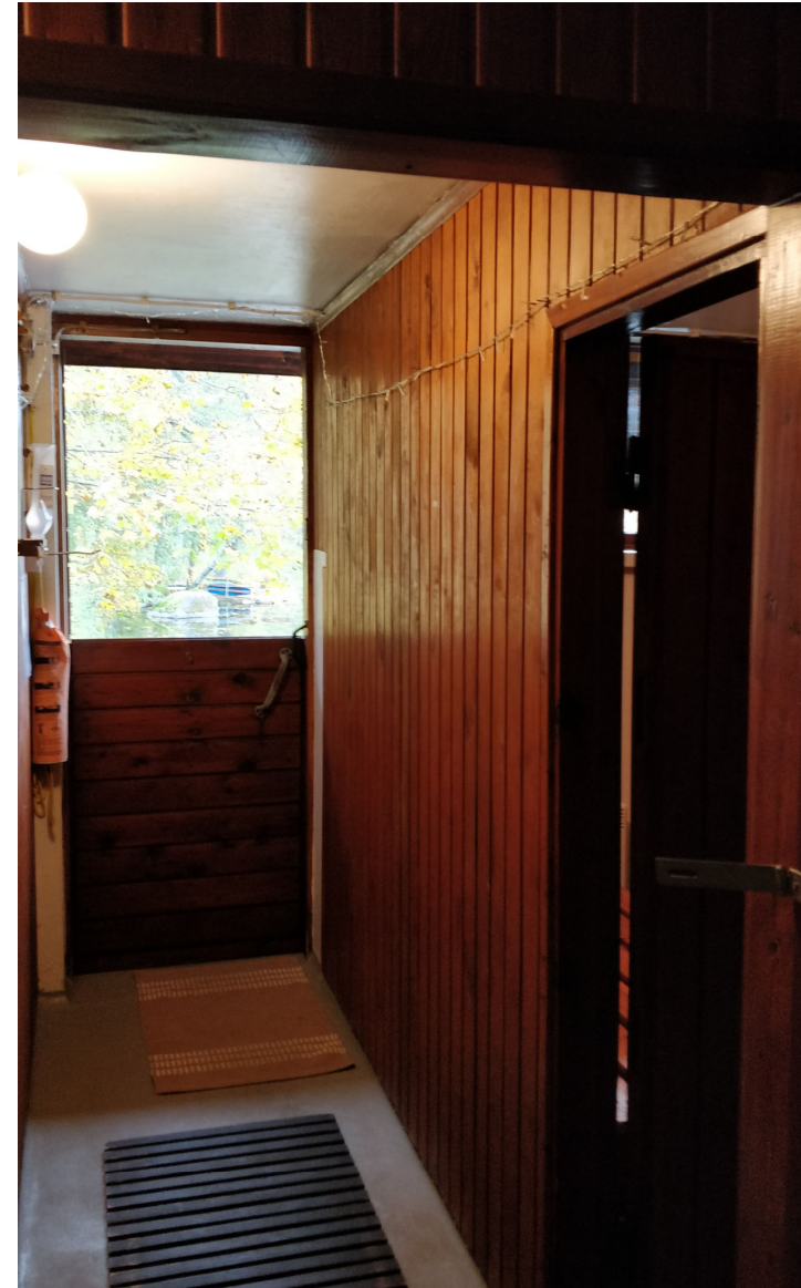
Kuva 35. Näkymä pesuhuoneen ovelta käytävään, joka johtaa vilvoitteluterassille. Oikealla oleva seinä on rakennettu myöhemmin erottamaan sen taakse jäävä pukutila. Seinän paneloinnin profiili on teräväreunainen, muualla on käytetty särmiltään pyöristettyä pystypaneelia.
