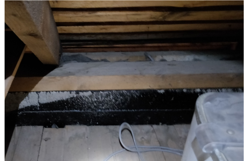
Kuva 49. Laipiossa on näkyvissä seinän yläosa ja sen päällä oleva kattorakenne. Välipohja on tehty teräsbetonista, joka lepää muraatun seinän päällä ja kääntyy reunoiltaan ylös.
