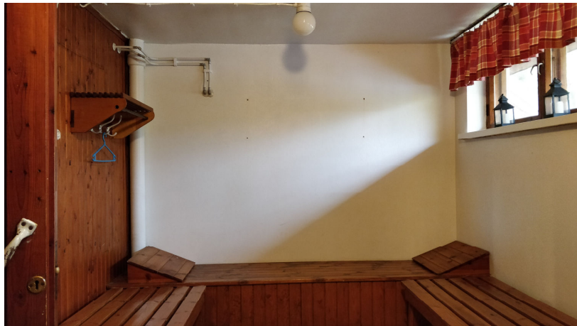
Kuva 31. Suuremman pukuhuoneen paikalla on alun perin ollut kaksi pienempää. Keskellä oleva väliseinä on poistettu ja penkit järjestetty uudelleen. Perällä oleva laveri on todennäköisesti muutoksen aikainen, penkit taas muutoksessa säilyneitä mutta siirrettyjä.
