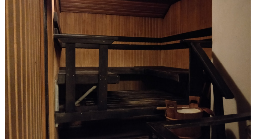
Kuva 38. Saunan perällä on alkuperäisten piirustusten mukaan ollut suorat lauteet. Nykyisellään lauteen ovat U-malliset ja käsitelty mustiksi. Seinien verhoilu on myös uusittu.
