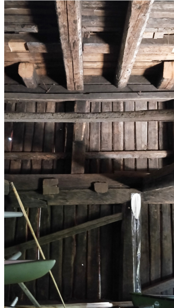
Kuva 31. Sisätilaa pitkää julkisivua kohden katsottuna. Toisen ja kolmannen kerroksen lattiapalkkeja on katkaistu julkisivun läheltä. Kolmannen kerroksen palkkien leikkauskohta on alemmaa kerrosta vaaleampi, joten ne ovat myöhemmin poikkaistu. Kattorakennetta tukeva pitkittäin kulkeva jalaspuu kolouksineen erottuu ylhäällä.
