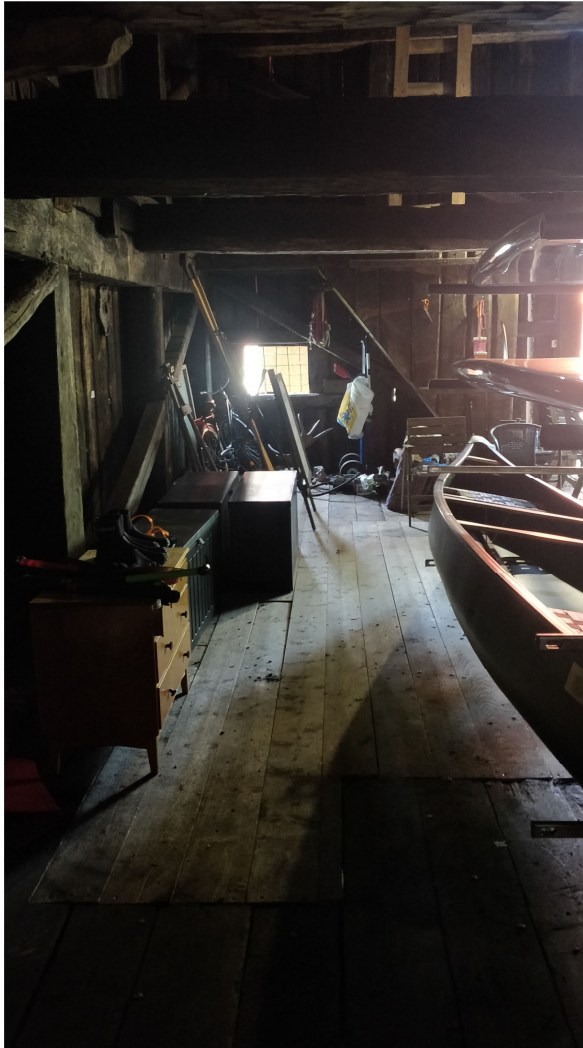
Kuva 30. Sisätila pohjoisseinusta porrasta kohti. Sen alla on kalterein peitetty "putkan" aukko. Uusitut lattialankut erottuvat vaaleampina.
