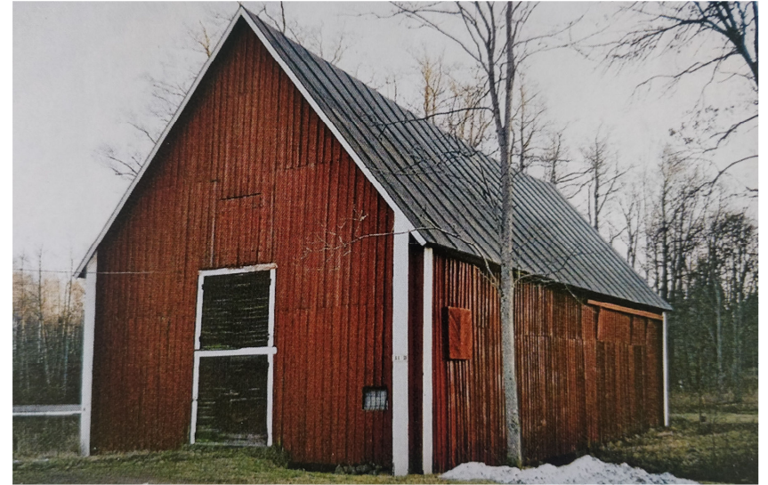
Kuva 16. 2000-luvun alkupuolella otetussa kuvassa rakennuksen harja on suoristunut ja julkisivut punamullattu. Neliömäinen paneloitu kenttä on kadonnut päädyistä.
