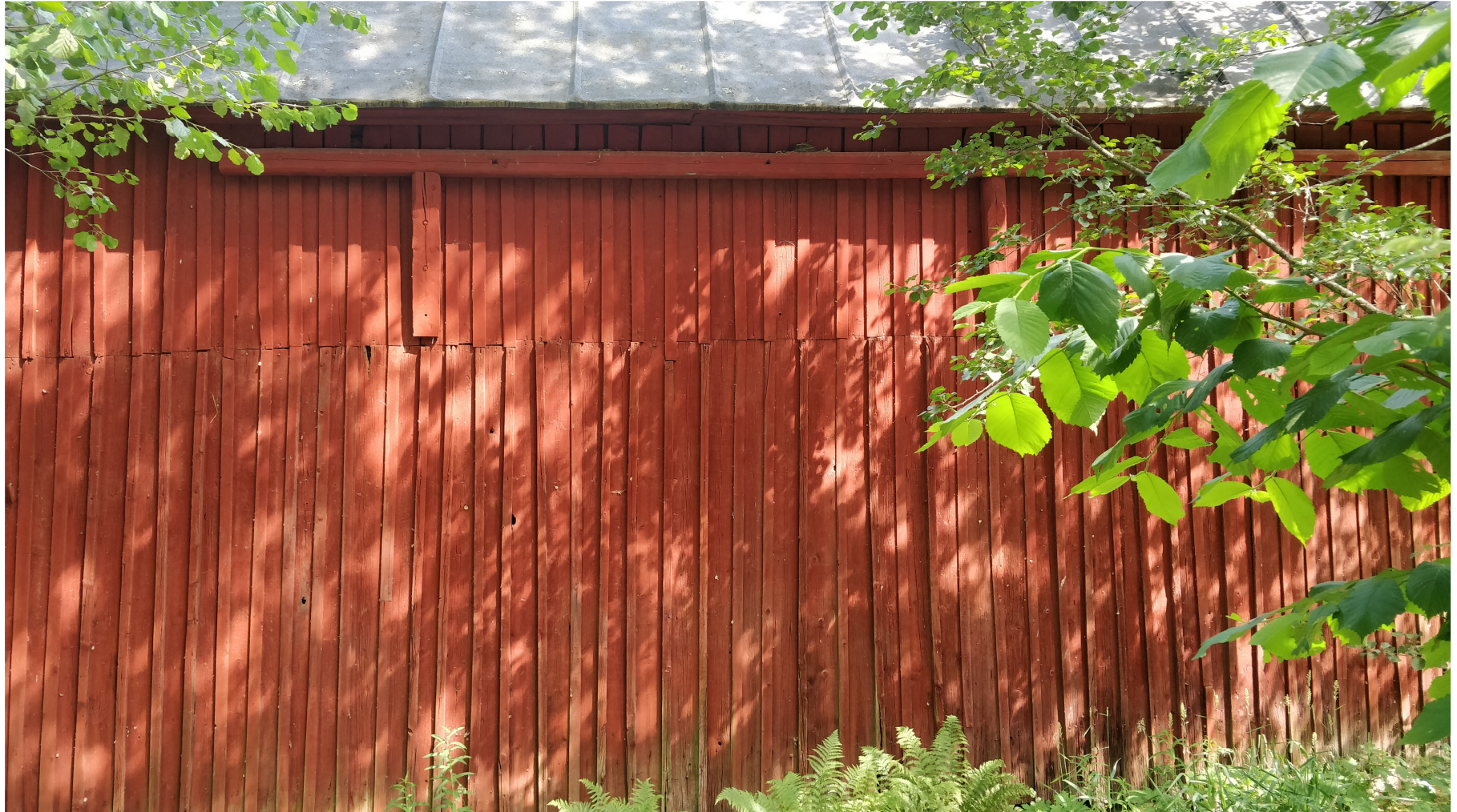
Kuva 24. Länsijulkisivun eteläpäässä on seinää vasten asennettu pitkä palkki, joka on jääne rakennuksen kyljessä olleesta katoksesta. Julkisivun laudoituksessa on eri levyisiä lautoja ja peiterimoja. Koska peiterimat eivät jatku palkin yläpuolelle, voi päätellä että ne on uusittu katoksen asentamisen yhteydessä tai sen jälkeen.
