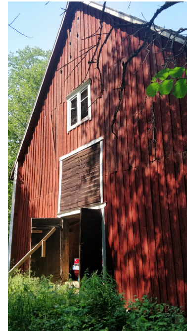
Kuva 22. Rakennuksen eteläpäädyssä on samanlaiset pariovet kuin pohjoispäädyssä. Näiden yläpuolella on rakennuksen ainoa ikkuna, jonka jaot ovat kadonneet.
