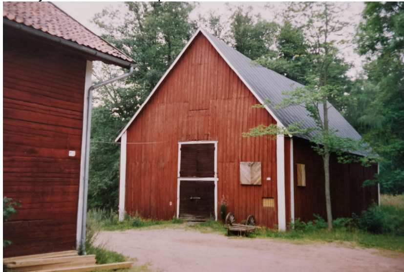
Kuva 15. 1980-90-luvun taitteessa otetussa kuvassa huopakate on uusittu, katto on edelleen notkolla ja päädyt kallistuneen sisäänpäin.
