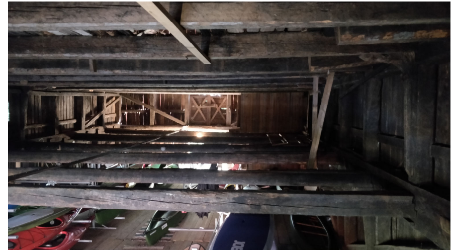
Kuva 29. Näkymä toisesta kerroksesta portaiden kohdalta. Välipohjien kannatinhirsistä alle puolet on paikoillaan.
