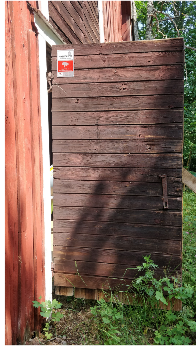
Kuva 26. Eteläpään parioven ulkopuoli, pystylankkujen päälle on asennettu vaakapanelointi sääsuojaksi.
