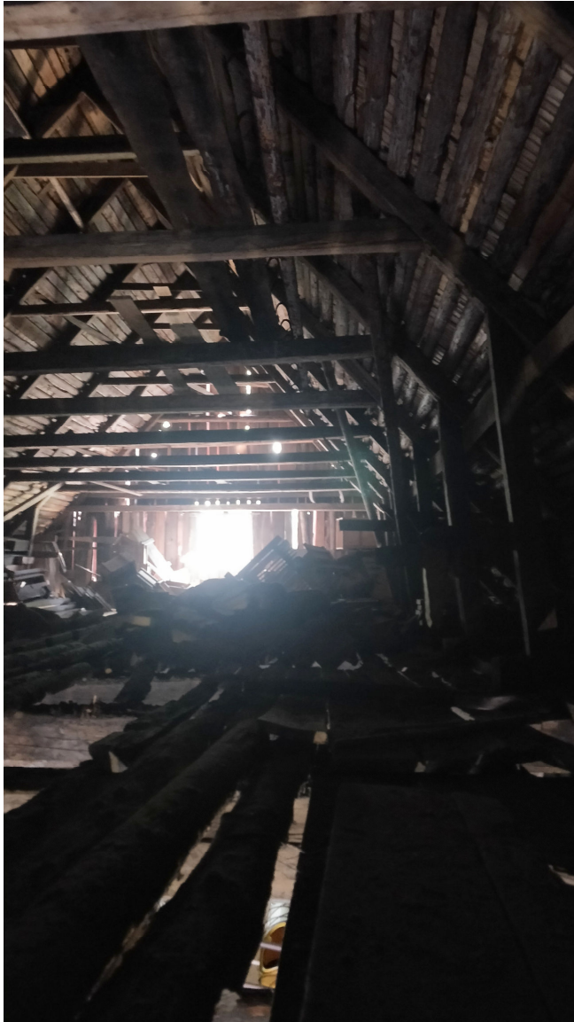
Kuva 32. Kuva kolmannesta varastotasosta eteläpäädyn ikkunaan kohden. Ruotsalaismalliset kattotuolit tukeutuvat julkisivun lisäksi pitkittäin kulkevaan jalaspuuhun. Vaakasuuntaisia palkkeja on kattotuolissa ylhäällä kolme.
