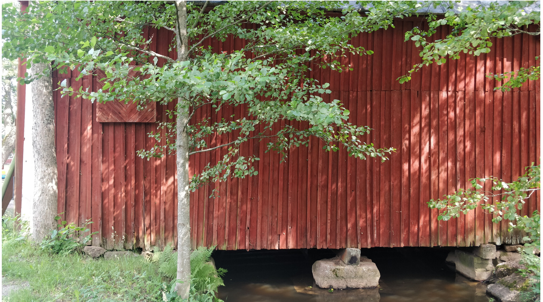
Kuva 23. Rakennuksen länsijulkisivua. Vinopaneloitu neliömäinen kenttä on asennettu julkisivulaudoituksen päälle. Vastaavanlainen on ollut myös pohjoispäädyssä. Niiden funktio ei ole selvinnyt.
