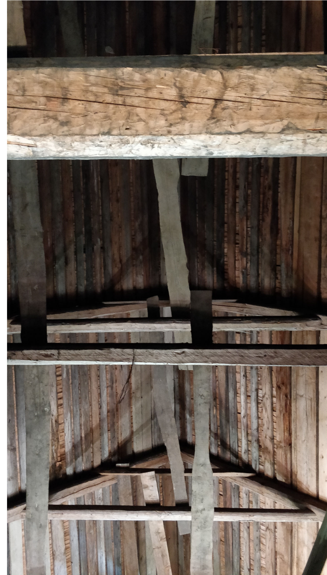
Kuva 33. Näkymä ylöspäin kattoa kohden. Huopakatteen alla oleva pärekate erottuu hyvin.
