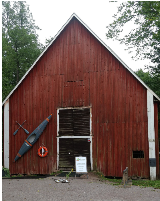
Kuva 21. Rakennuksen pohjoisjulkisivu. Kaksi pariovea on toiminut lastausaukkoina. Kolmas pienempi luukku on johtanut kolmannelle tasolle. Oikealla oleva aukko on peitetty kalterein.
