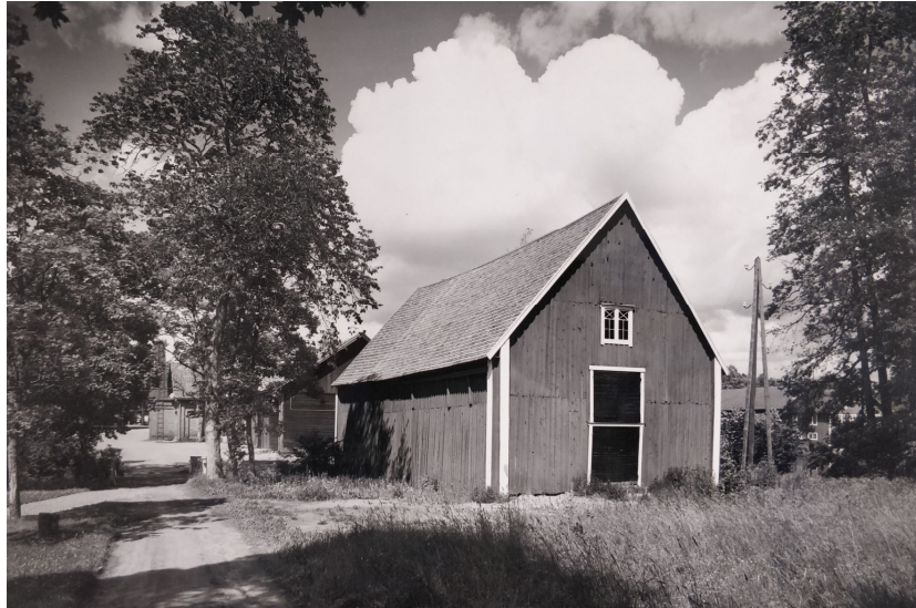
Kuva 14. Verkhus 1900-luvun puolivälin aikaan. Rakennuksessa on pärekatto. Katos on purettu, päädyn maalipinnassa näkyvä vaaleampana edelleen sen hahmo. Nykyisellään lahonneet ikkunajaot ovat tässä vielä paikoillaan.
