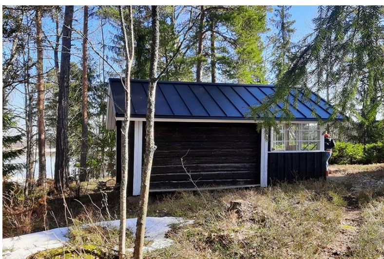
Bild 12. Lidret öster om stugan på byggplats 2.
