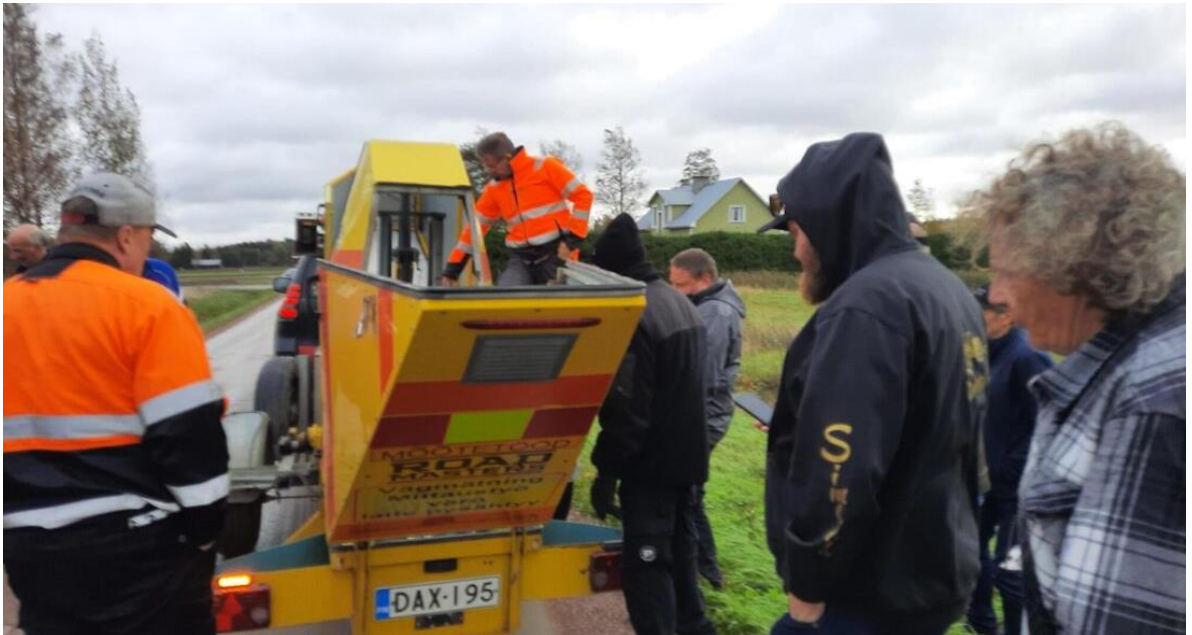
Kuva 3. Työnäytös; tien kantavuusmittaus Yksityistiet kuntoon päivällä Liljendalissa 12.10.2023
