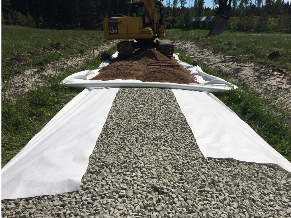
Kuva 2. Furunäs-Edön yksityistie kesä 2022; Rakenteen ja kuivatuksen parantaminen, tasausviivan korottaminen tulvakohteessa. Levitettiin n. 50 cm paksu kerros vaahtolasia ja laitettiin suodatinkankaan ”sisään”, päälle ajettiin soraa n. 20-30 cm. (kuva Kindstedt S.)
